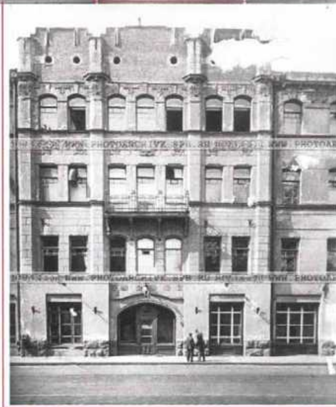
85. Каменноостровский пр., дом 10 лит. А 1 . Фотоснимок 1934 г.
