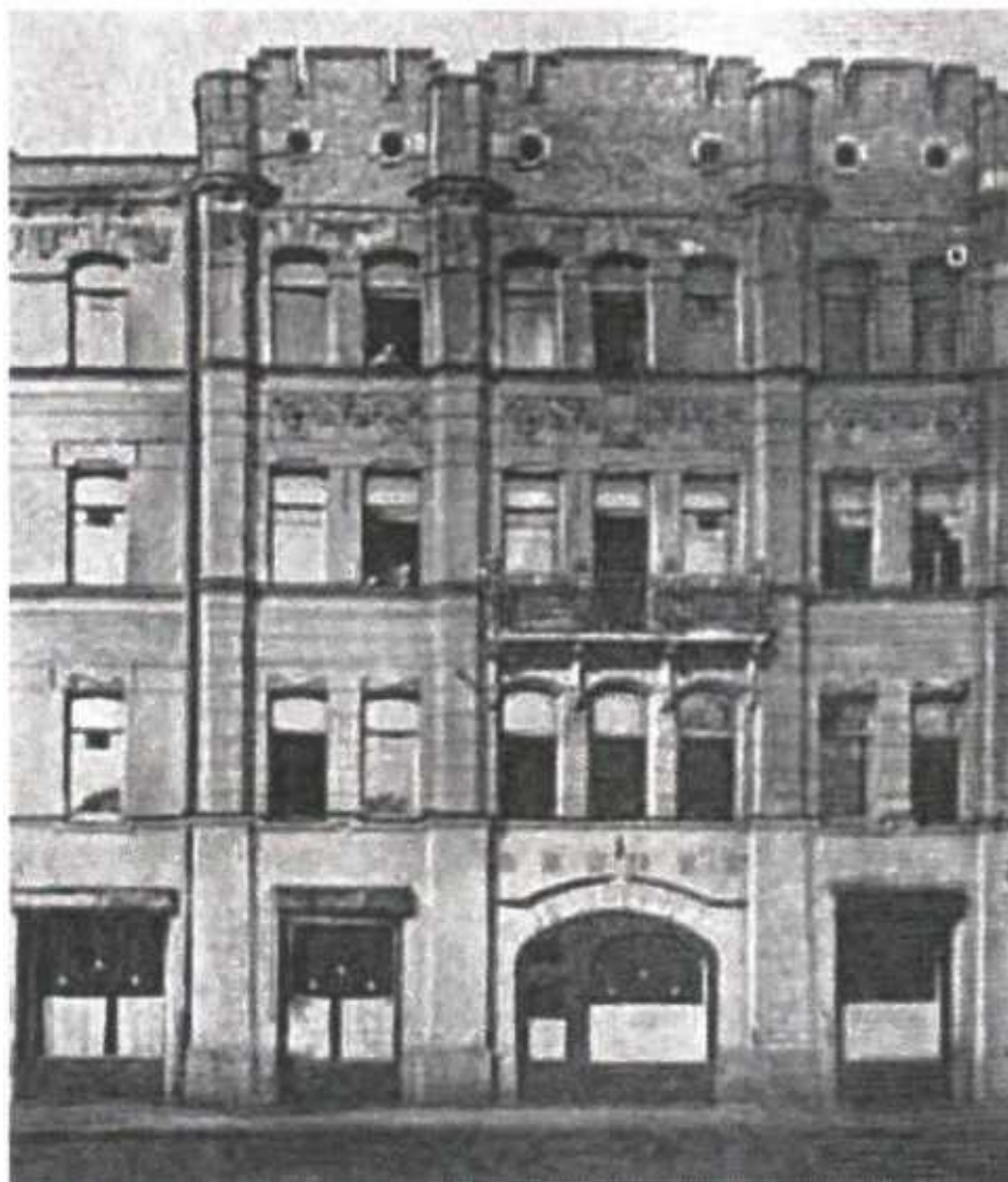
86. Каменноостровский пр., дом 12 лит. А 1 . Фотоснимок 1934 г.
