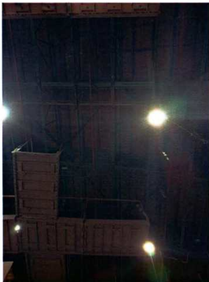
6. Объект культурного наследия, фрагмент (металлические фермы крыши западного объема (театр)) (фото от 19.08.2025).
