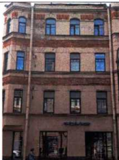
2. Фрагмент восточного фасада
