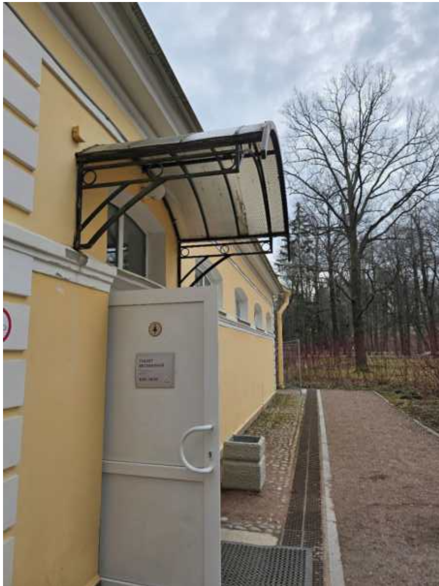
Фото 11. Фрагмент юго-западного фасада здания общественного туалета
