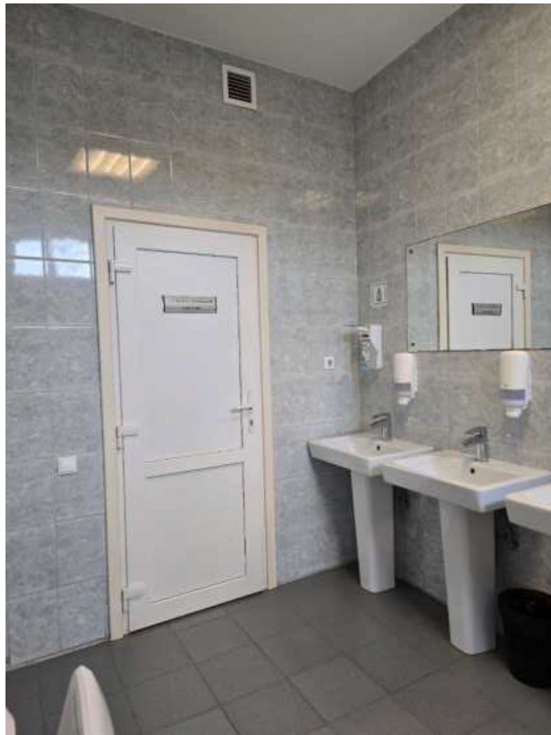
Фото 15. Фрагмент помещения общественного туалета
