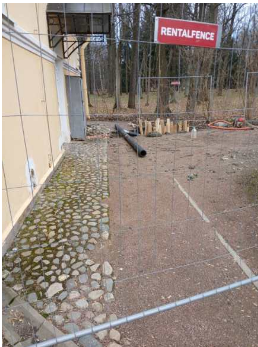
Фото 13. Фрагмент юго-восточного фасада здания общественного туалета, выполняются работы в части ремонта кабельной линии 0,4 кВ от существующей КР-0,4 кВ до общественного туалета (разрешение КГИОП от 23.01.2026 № 01-26-2895/25-0-1).
