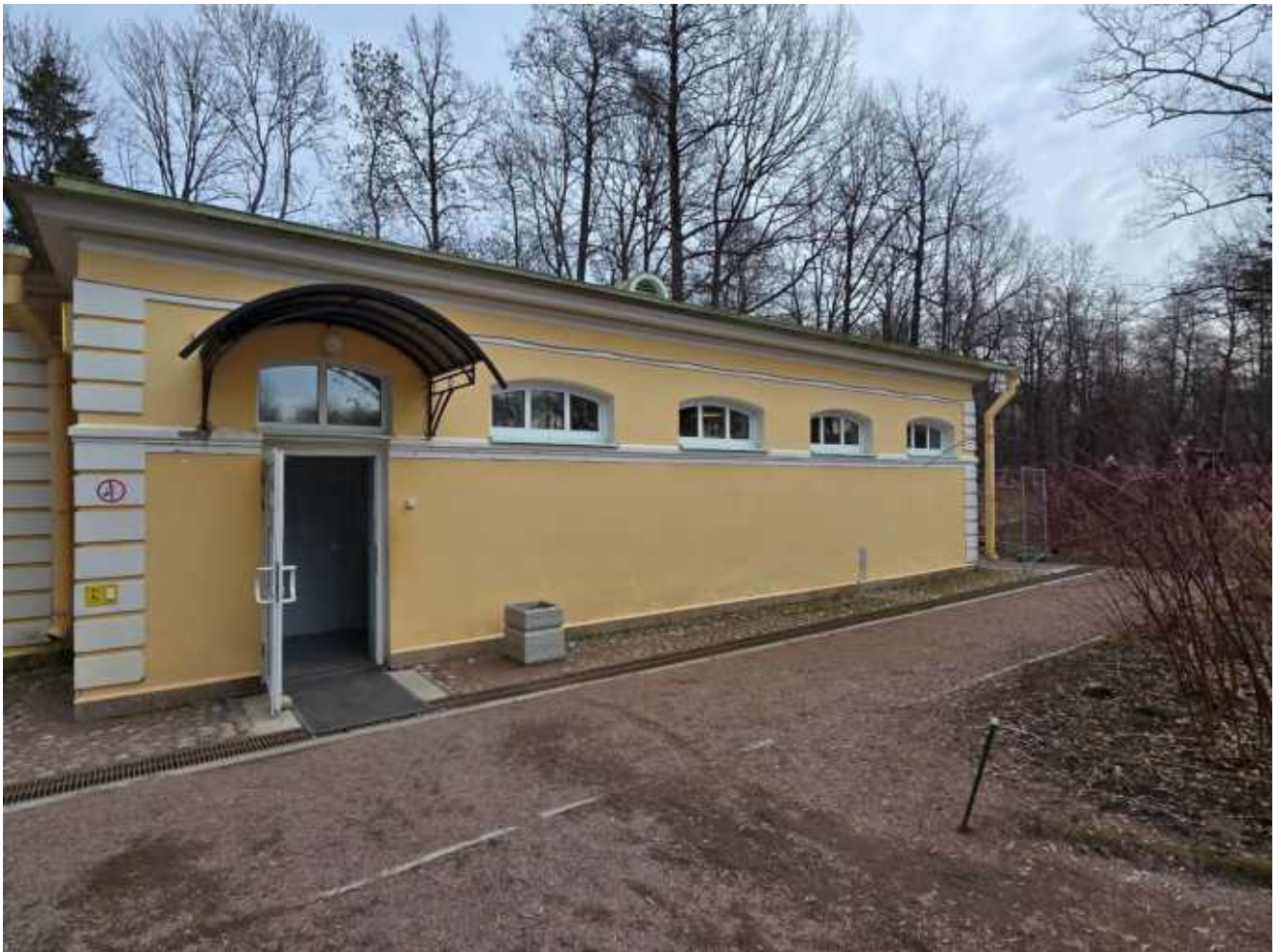
Фото 7. Юго-западный фасад здания общественного туалета
