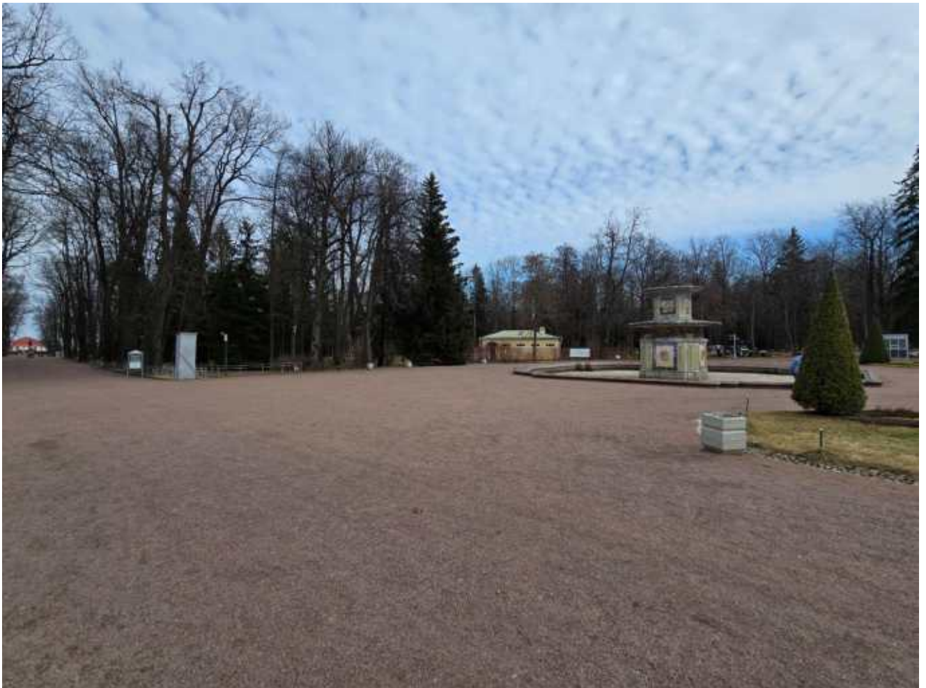
Фото 4. Общий вид на Монплези́рскую аллею, Римский фонтан (восточный), юго-западный фасад здания общественного туалета
