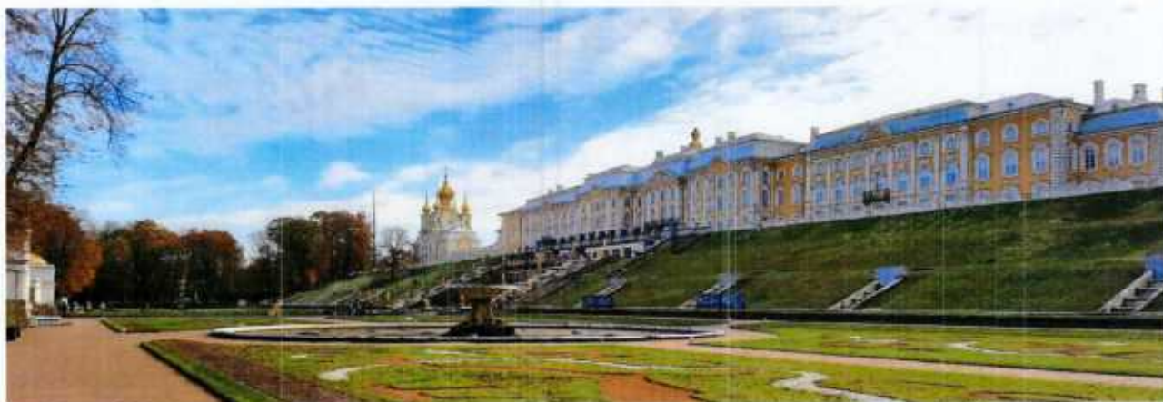
Фото 35. Фрагмент объекта культурного наследия – балюстрада на верхней террасе у ОКНФЗ «Большой дворец». Общий вид. Фото выполнено 27.10.2023.
