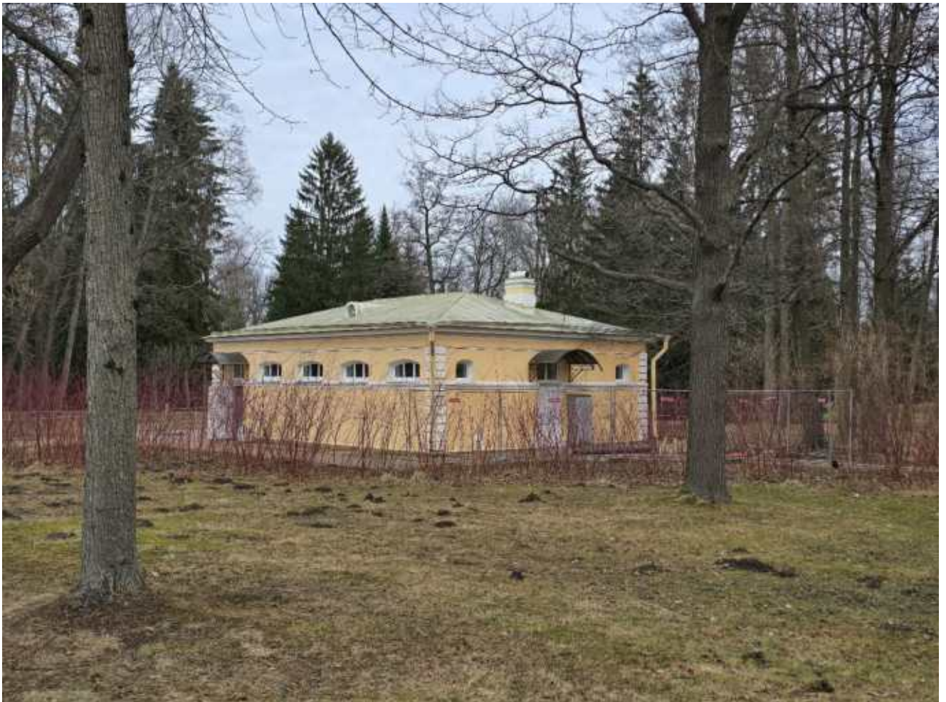
Фото 8. Общий вид на юго-западный и юго-восточный фасады здания общественного туалета
