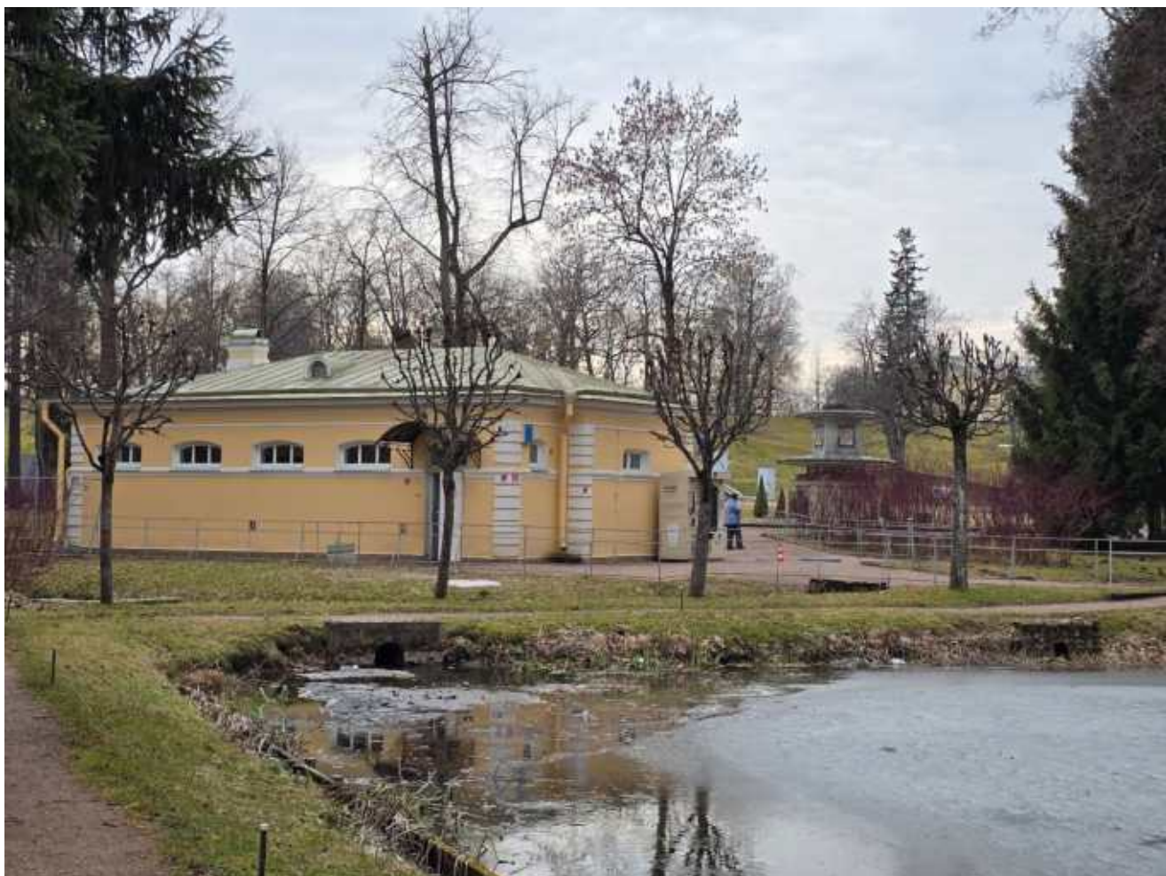
Фото 9. Общий вид на северо-восточный и северо-западный фасады здания общественного туалета от квадратного пруда, справа на заднем фоне Римский фонтан (восточный)
