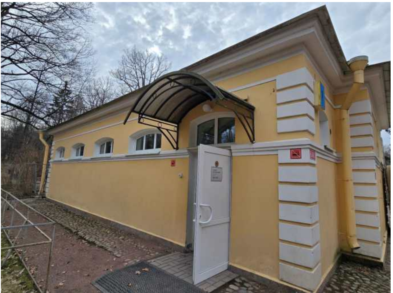
Фото 10. Северо-восточный фасад здания общественного туалета, фрагмент северо-западного фасада
