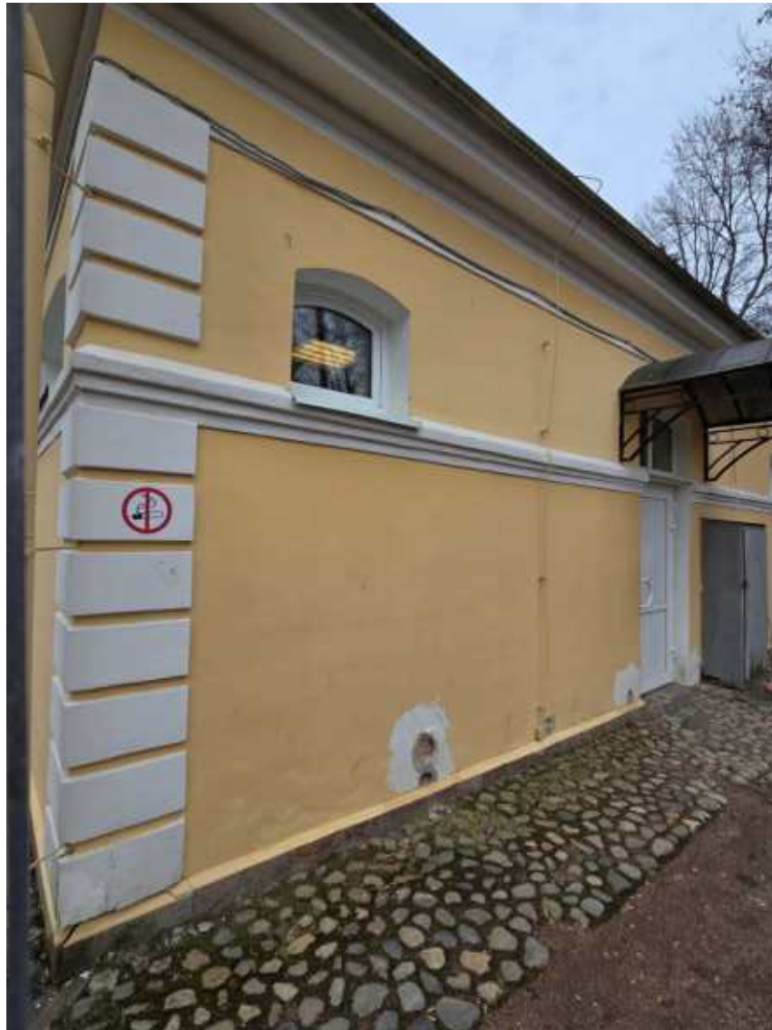
Фото 12. Фрагмент юго-восточного фасада здания общественного туалета
