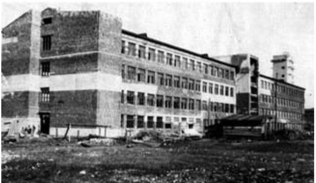
60. Учебный корпус в процессе строительства. 1934 г.
