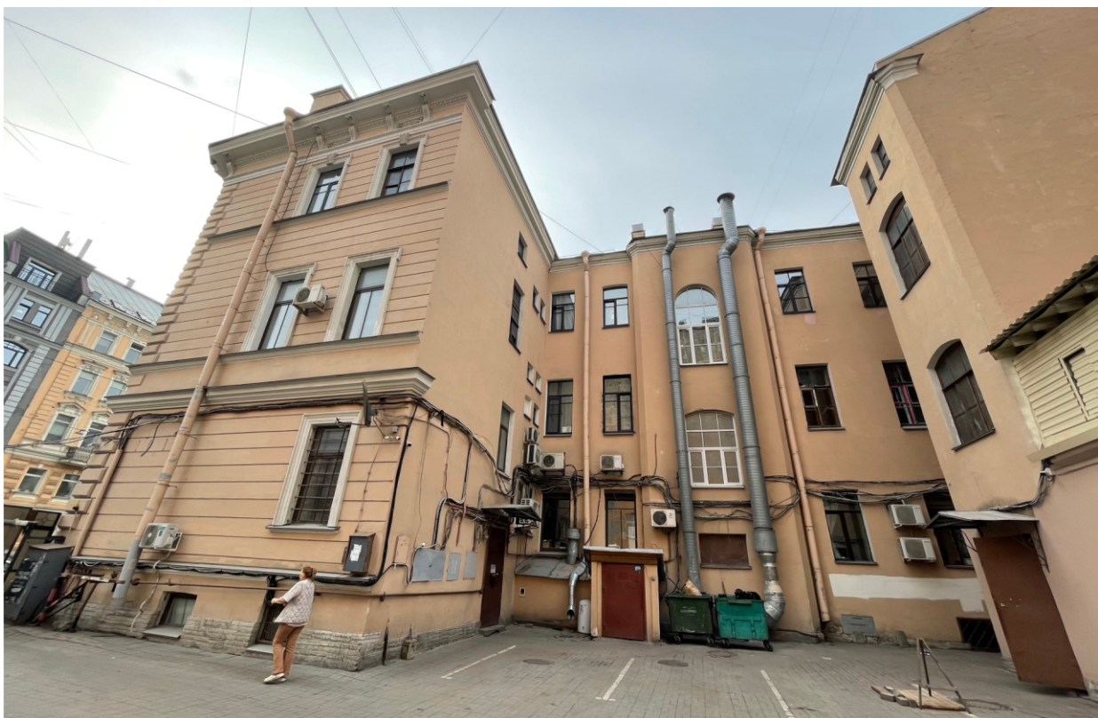
Фото.2 Выявленный объект культурного наследия «Дом М.А.Панова», Санкт-Петербург, Суворовский пр., 1/8, лит.А. Дворовые фасады, общий вид.
