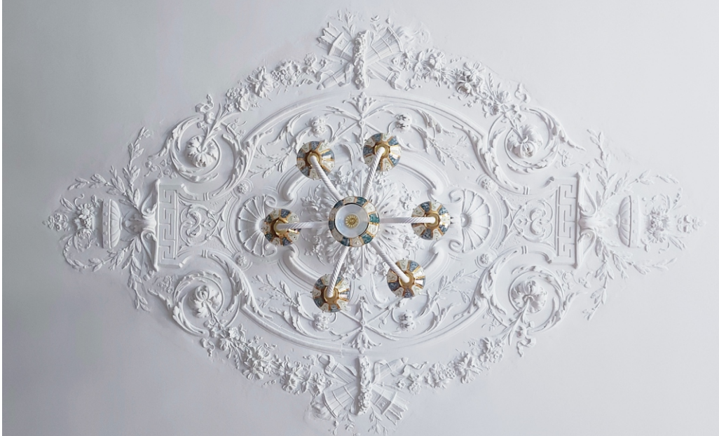
Фото 20. Выявленный объект культурного наследия «Дом М.А.Панова», Санкт-Петербург, Суворовский пр., 1/8, лит.А., квартира 3. Помещение 14 (по плану ПИБ). Плафон лепной.
