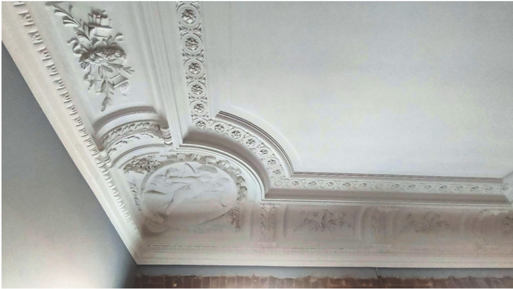
Фото 19. Выявленный объект культурного наследия «Дом М.А.Панова», Санкт-Петербург, Суворовский пр., 1/8, лит.А., квартира 3. Помещение 14 (по плану ПИБ). Падуга, фрагмент.
