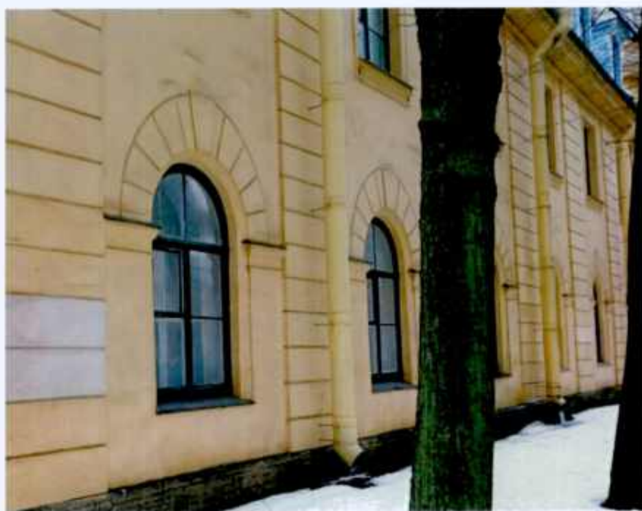
6. Фрагмент. Северный фасад объекта культурного наследия.
