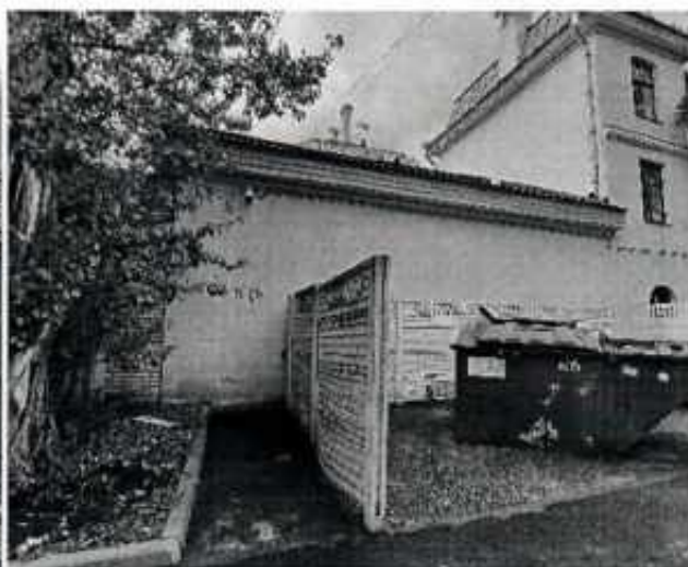
2. Фрагмент восточного фасада
