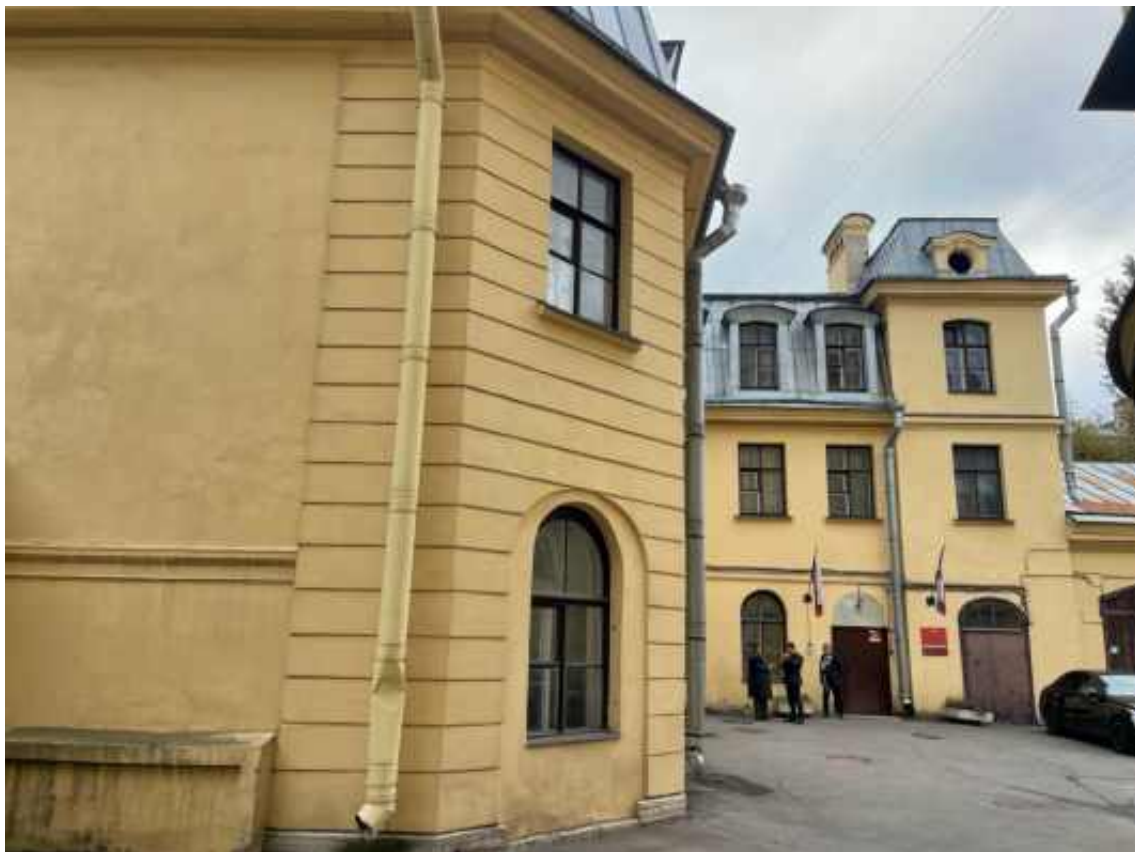
4. Вид на западные фасады со стороны двора
