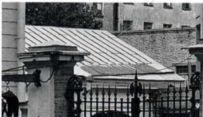
3. Фрагмент крыши здания
