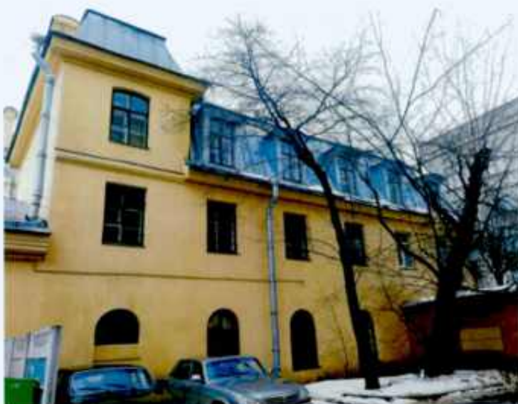
2. Общий вид. Восточный фасад объекта культурного наследия.
