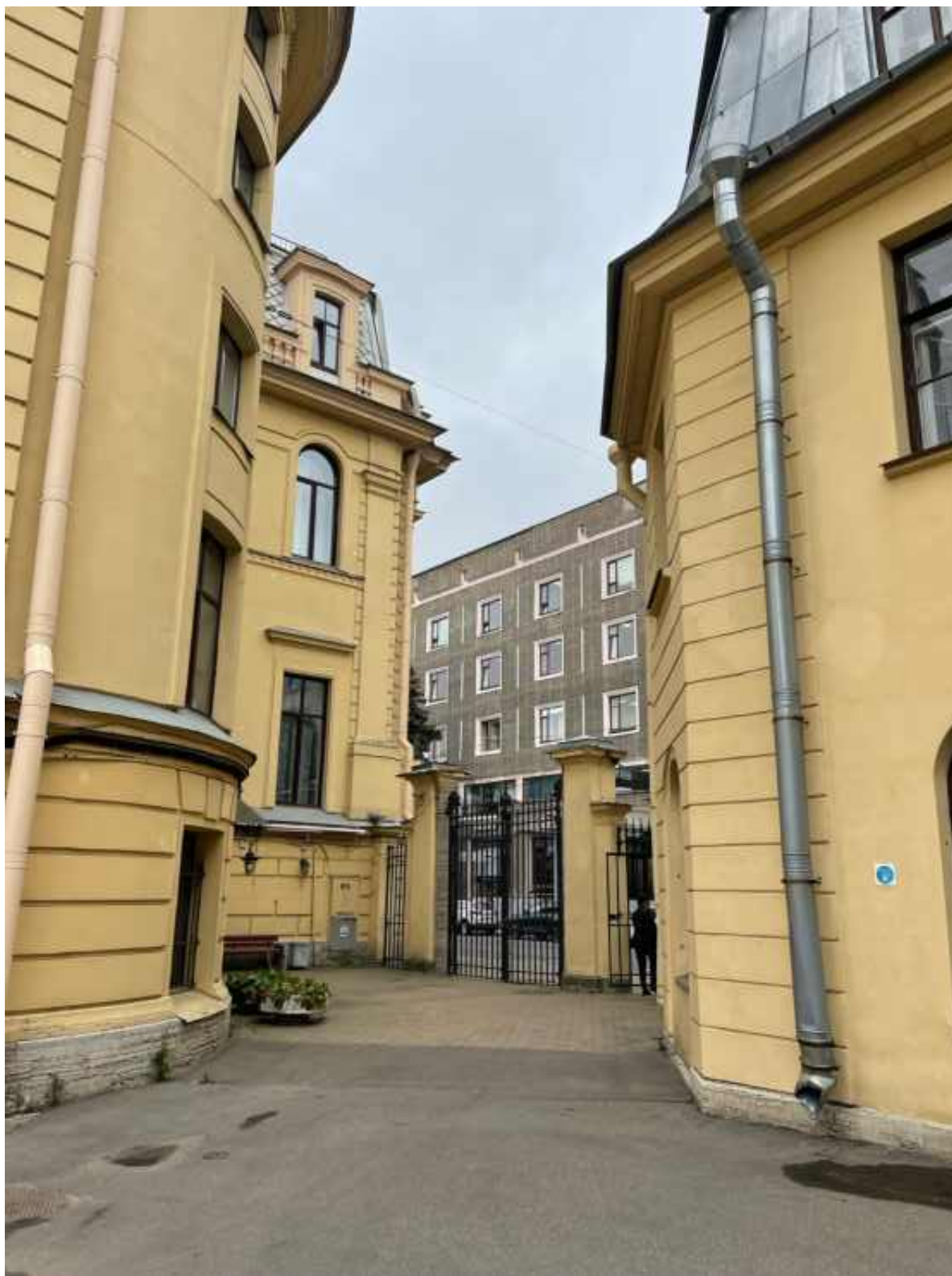
3. Вид на дворовые фасады и ворота
