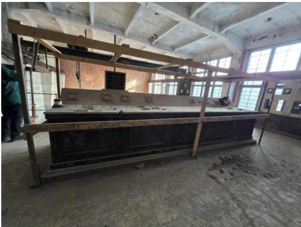
Фото 27. Объект культурного наследия регионального значения «ТЭЦ фабрики "Красное знамя"», Санкт-Петербург, улица Пионерская, дом 53, литера Ф. Турбинное отделение. Пульт управления: мраморная столешница, металлические фасады, профилированный бетонный цоколь.
