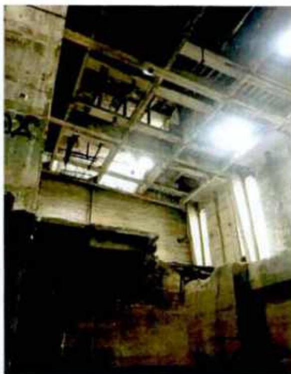
Фото 9. Бывш. котельный зал.
