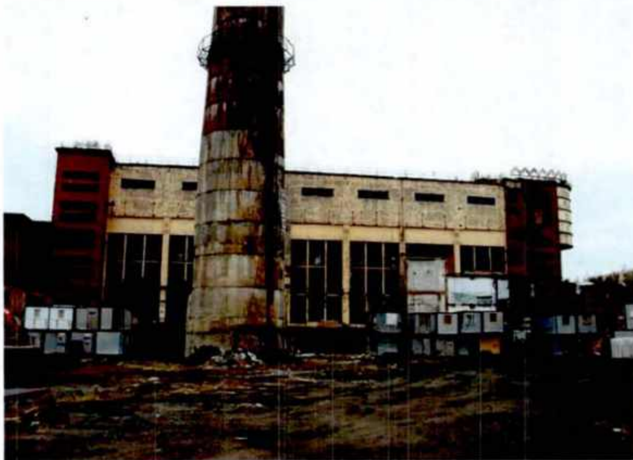
Фото 5. Фрагмент Северо-восточного фасада.
