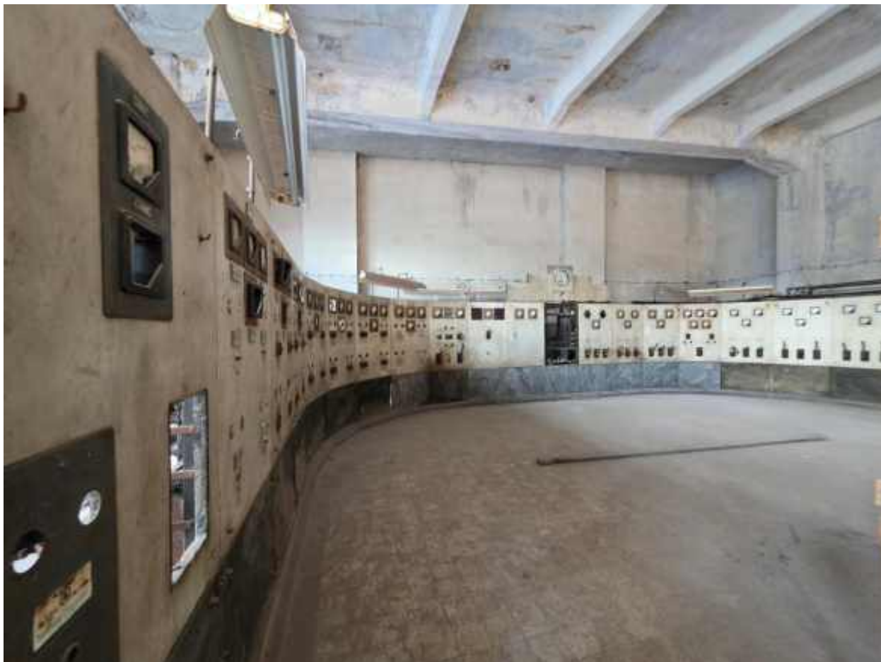
Фото 26. Объект культурного наследия регионального значения «ТЭЦ фабрики "Красное знамя"», Санкт-Петербург, улица Пионерская, дом 53, литера Ф. Турбинное отделение. Мраморные приборные панели, расположенные полукругом. Фрагмент.
