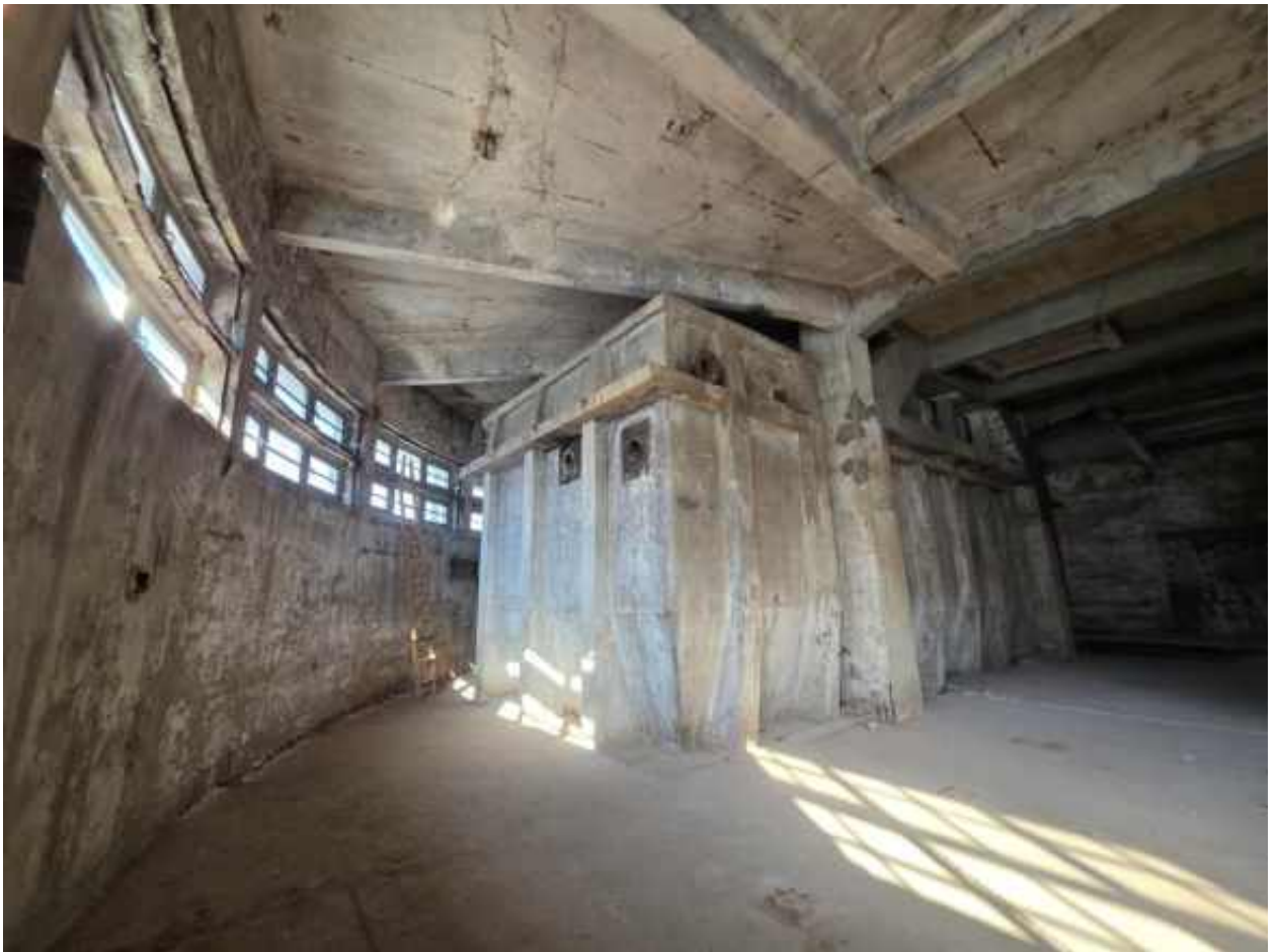
Фото 22. Объект культурного наследия регионального значения «ТЭЦ фабрики "Красное знамя"», Санкт-Петербург, улица Пионерская, дом 53, литера Ф. Отделение водоподготовки. Лучеобразно расходящиеся балки перекрытия крыши отделения.
