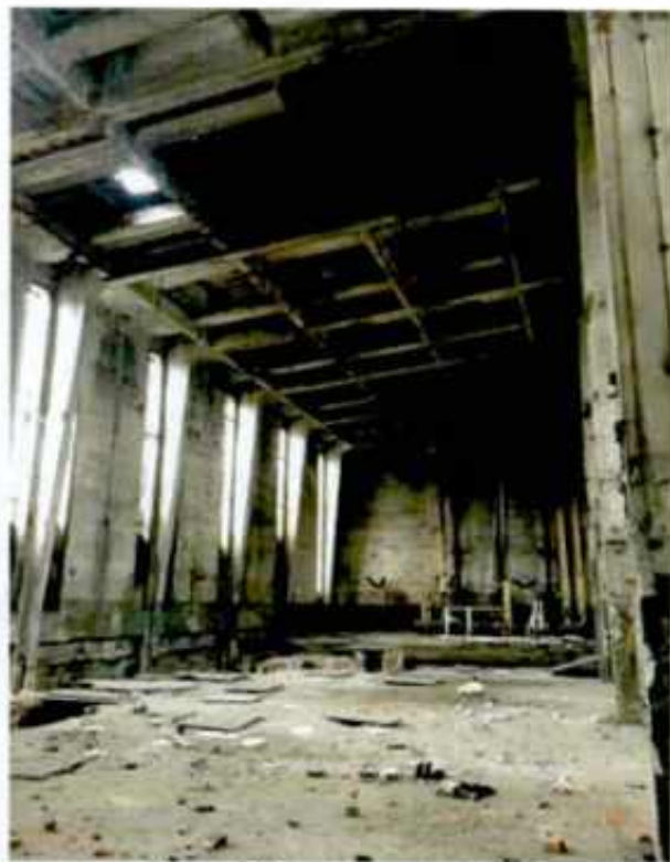
Фото 7. Бывш. котельный зал.
