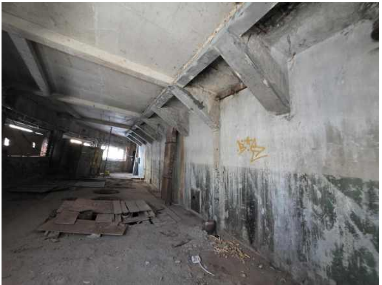
Фото 20. Объект культурного наследия регионального значения «ТЭЦ фабрики "Красное знамя"», Санкт-Петербург, улица Пионерская, дом 53, литера Ф. Отделение водоподготовки. Конструкции бака-отстойника в первом уровне отделения.
