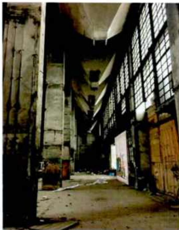
Фото 8. Бывш. котельный зал.
