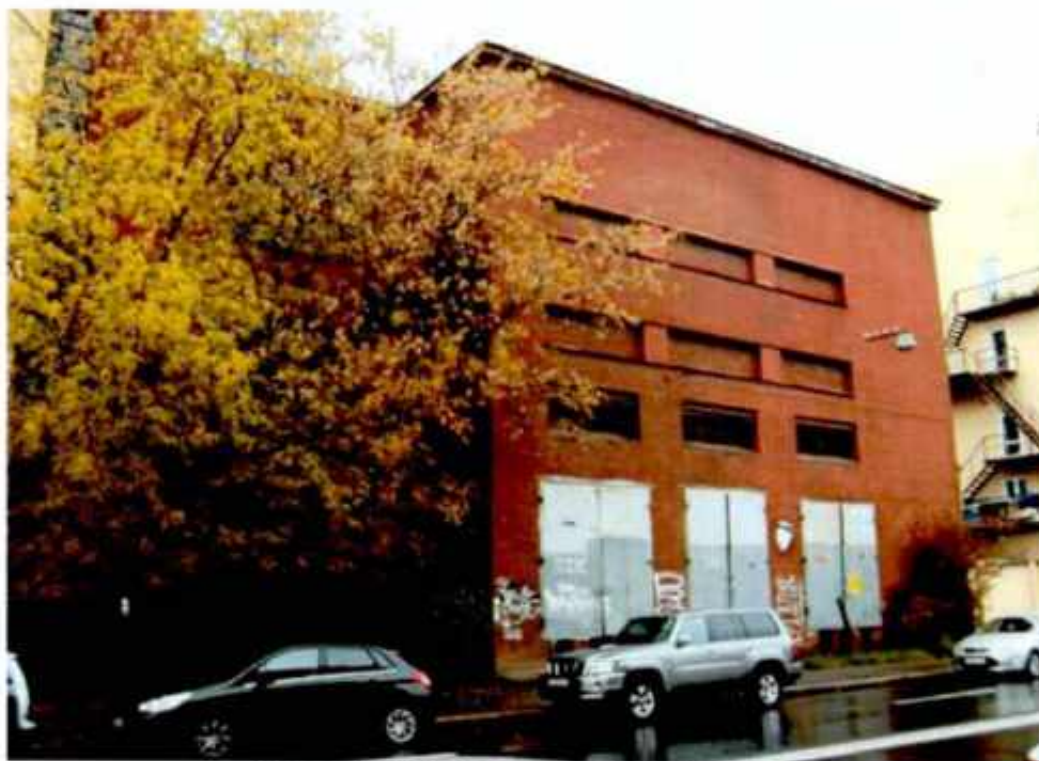
Фото 3. Фрагмент юго-западного фасада.
