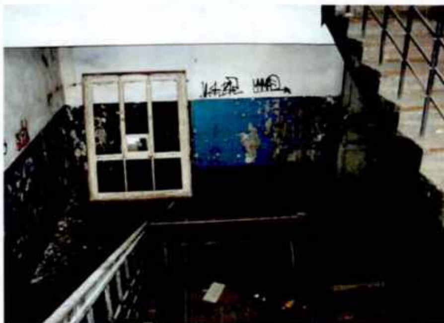
Фото 16. Центральная лестница в южной части здания.
