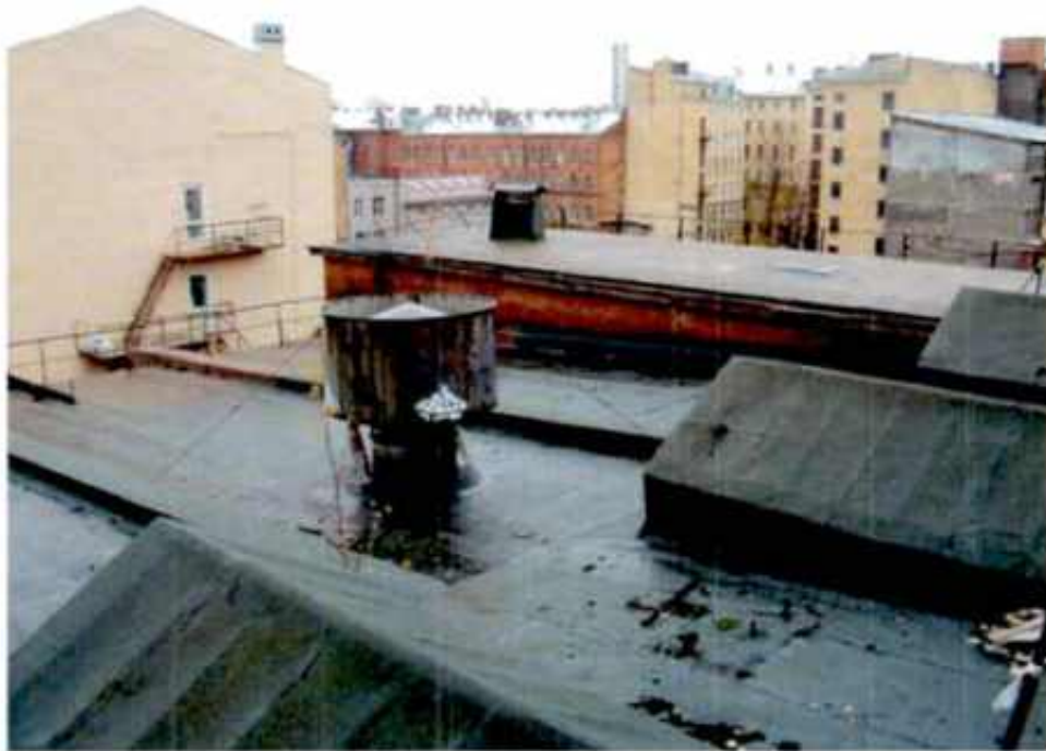
Фото 19. Кровля юго-восточной части здания.
