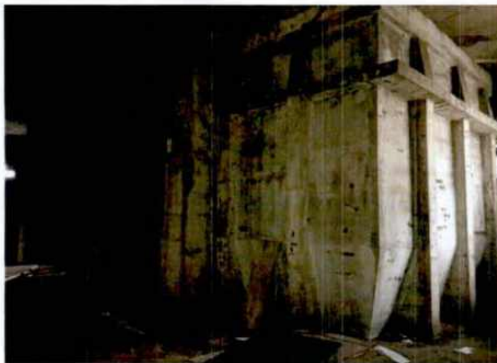
Фото 15. Железобетонный бак в бывш. отделение водоподготовки.
