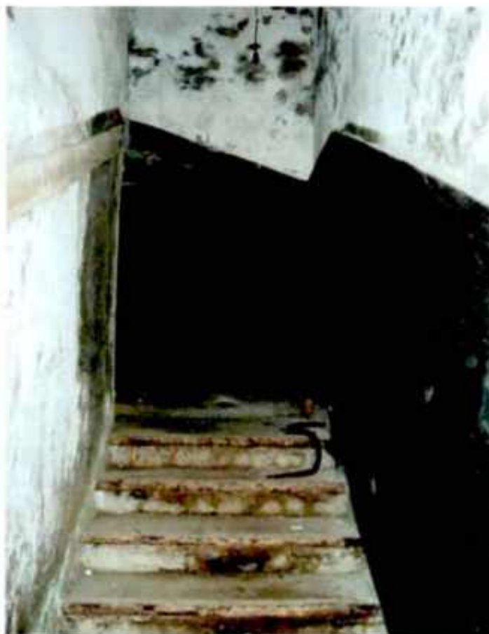
Фото 17. Лестница в северной части здания.
