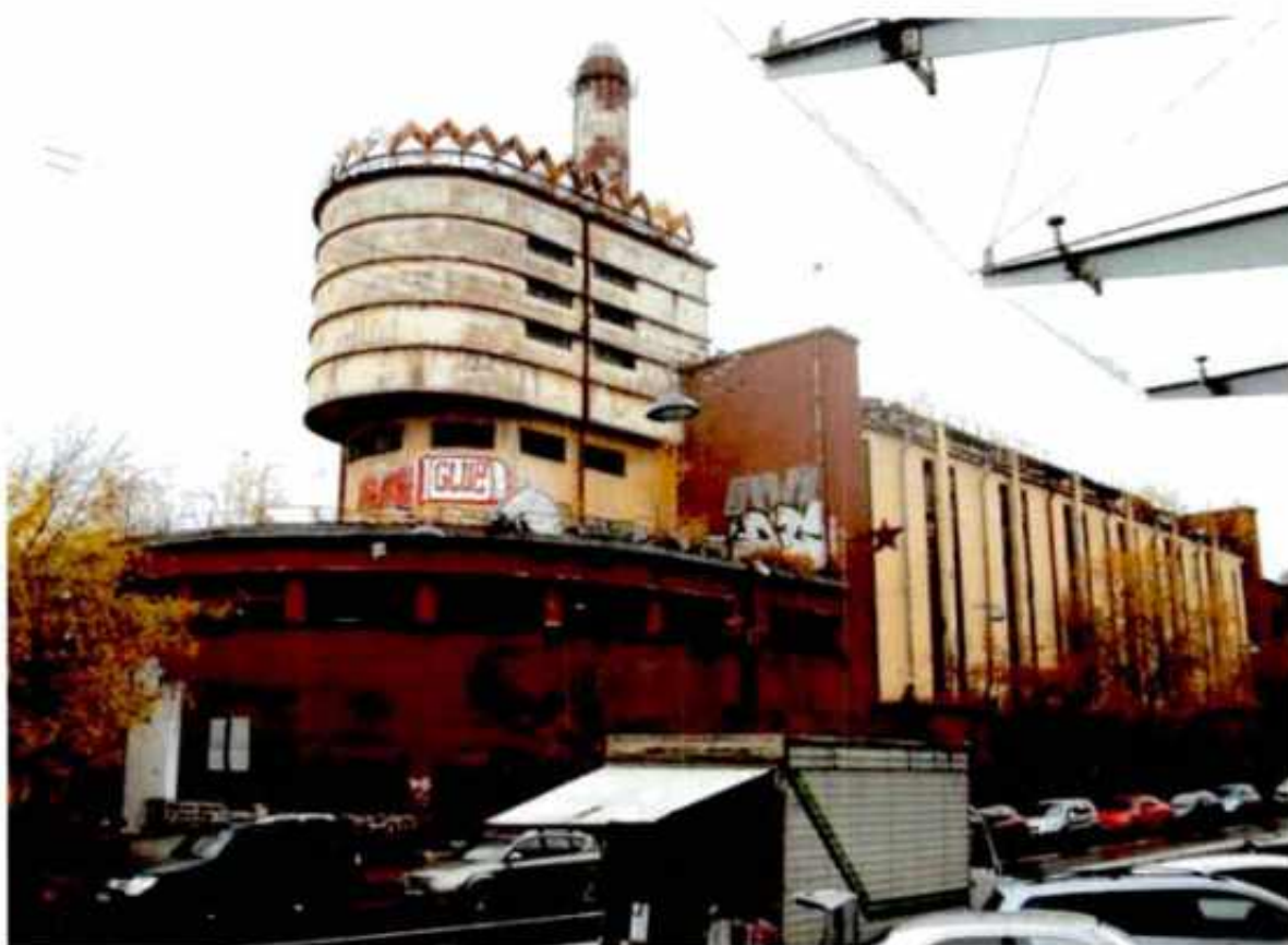
Фото 1. Полуциркульный северо-западный фасад и юго-западный фасад.
