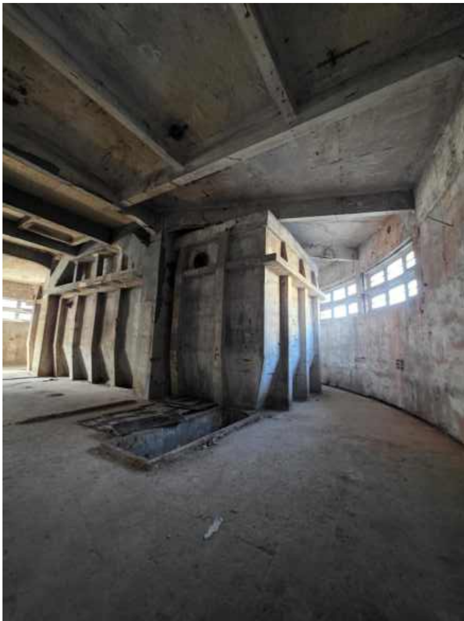
Фото 21. Объект культурного наследия регионального значения «ТЭЦ фабрики "Красное знамя"», Санкт-Петербург, улица Пионерская, дом 53, литера Ф. Отделение водоподготовки. Конструкции бака-отстойника во втором уровне отделения.
