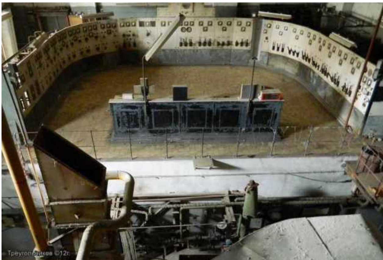
Илл.24 Пульт управления фидерного распределительного устройства. 2012. https://treugolnikov.livejournal.com/2071.html
