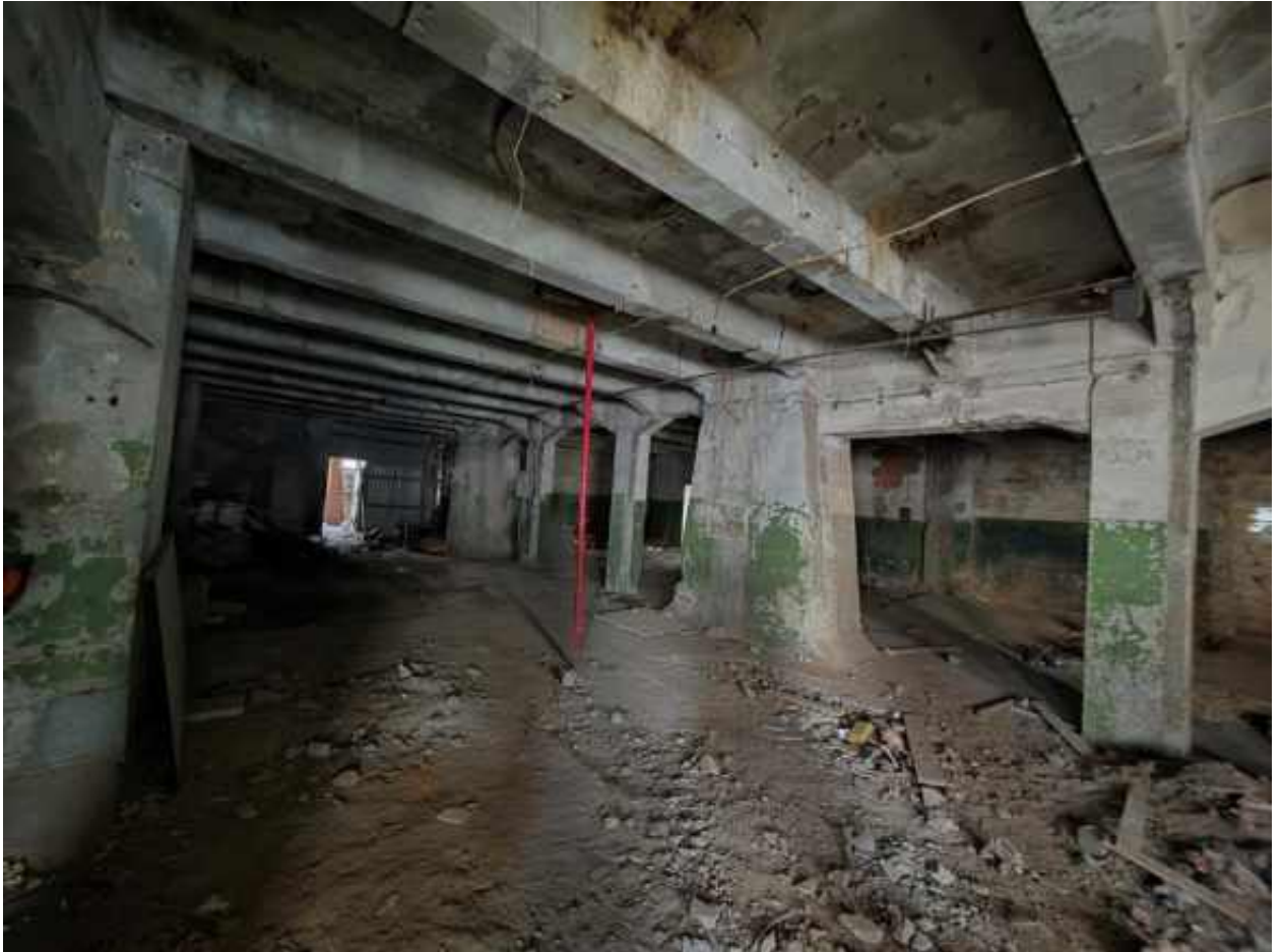
Фото 19. Объект культурного наследия регионального значения «ТЭЦ фабрики "Красное знамя"», Санкт-Петербург, улица Пионерская, дом 53, литера Ф. Отделение водоподготовки. Опорные пилоны водонапорной башни.
