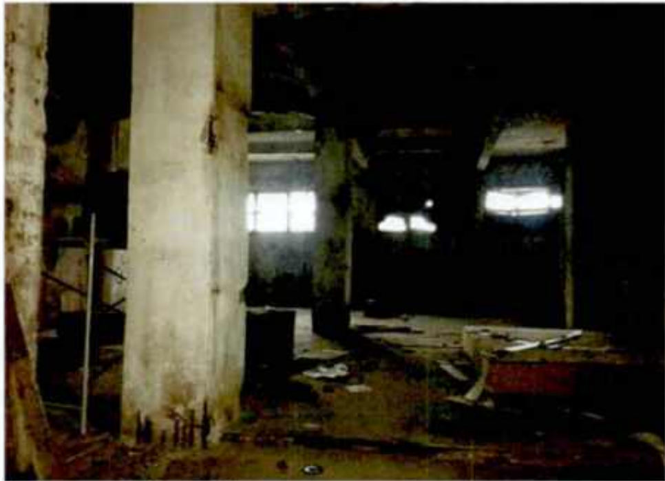
Фото 14. Бывш. отделение водоподготовки.
