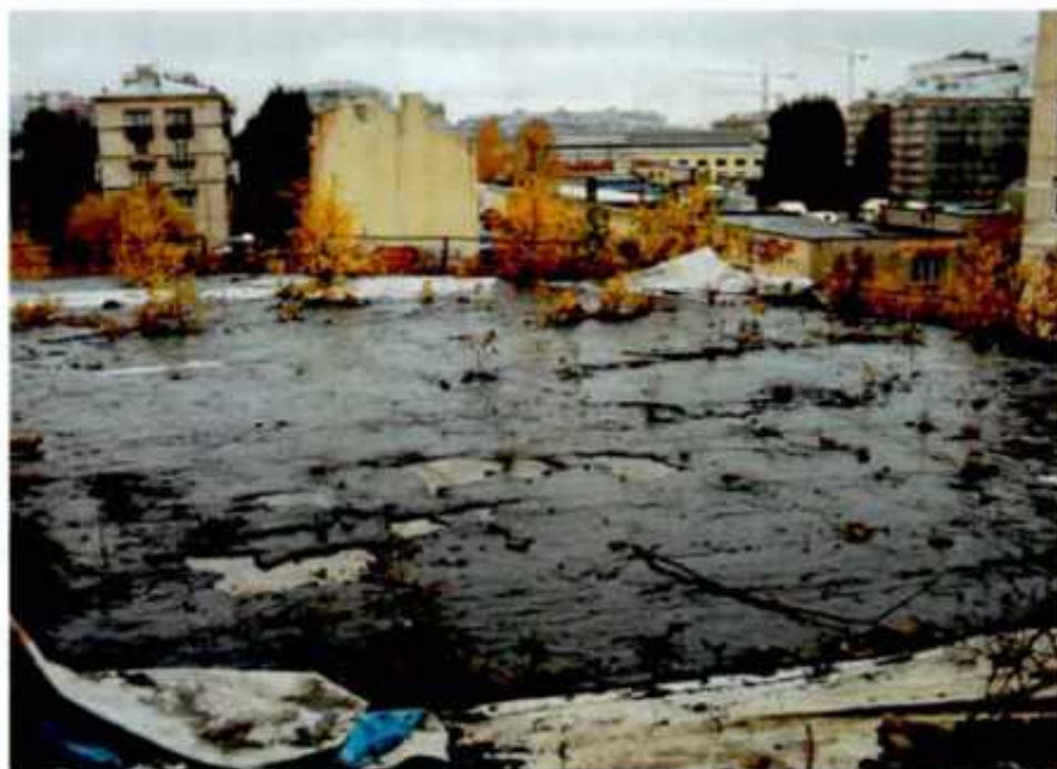
Фото 18. Кровля северо-западной части здания.
