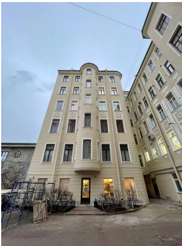
Фото 3. Фрагмент дворового фасада объекта культурного наследия регионального значения «Дом В.И. Кольшко»
