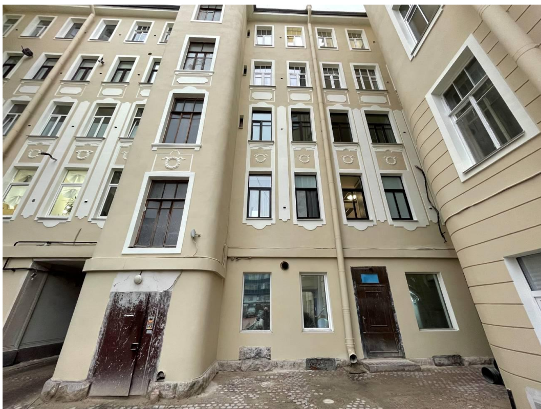
Фото 5. Фрагмент дворового фасада объекта культурного наследия регионального значения «Дом В.И. Кольшко»
