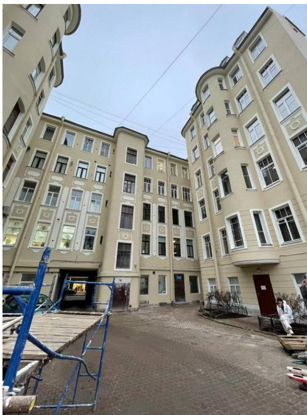
Фото 4. Фрагмент дворового фасада объекта культурного наследия регионального значения «Дом В.И. Кольшко»
