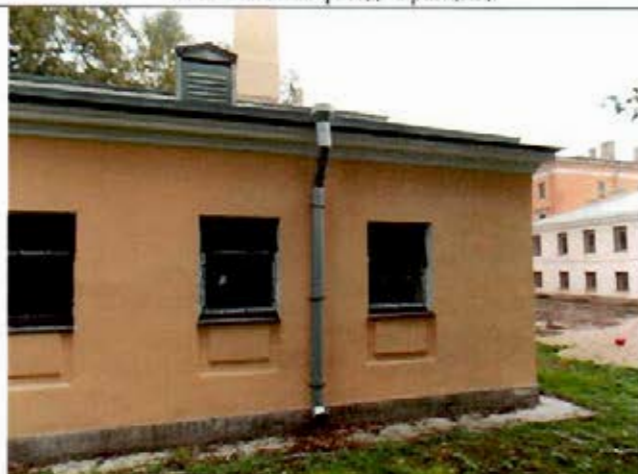
6. Западный фасад. Фрагмент.
