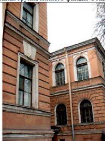
4. Восточный фасад. Фрагмент.
