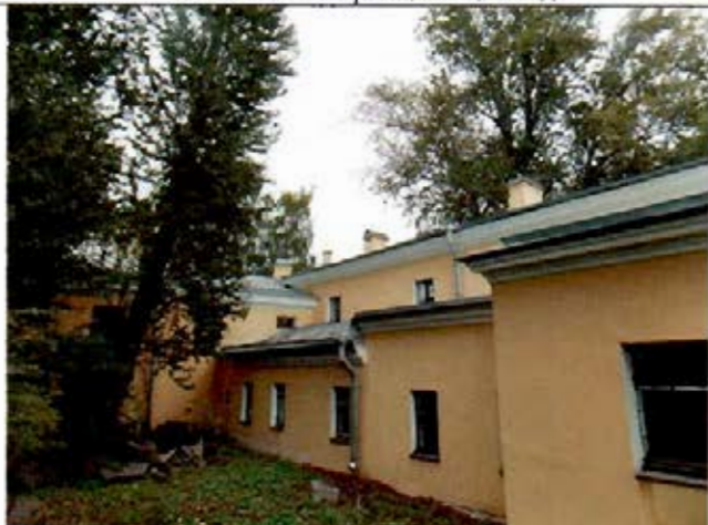
5. Западный фасад. Общий вид.
