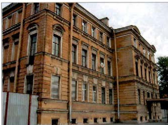
1. Южный фасад. Общий вид.
