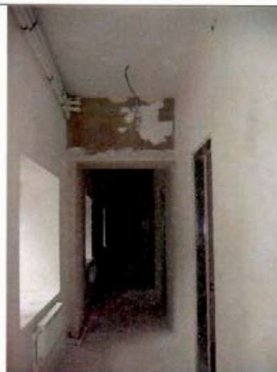
10. Коридор 2-го этажа. Общий вид.
