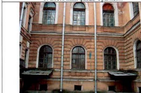
5. Восточный фасад. Фрагмент.
