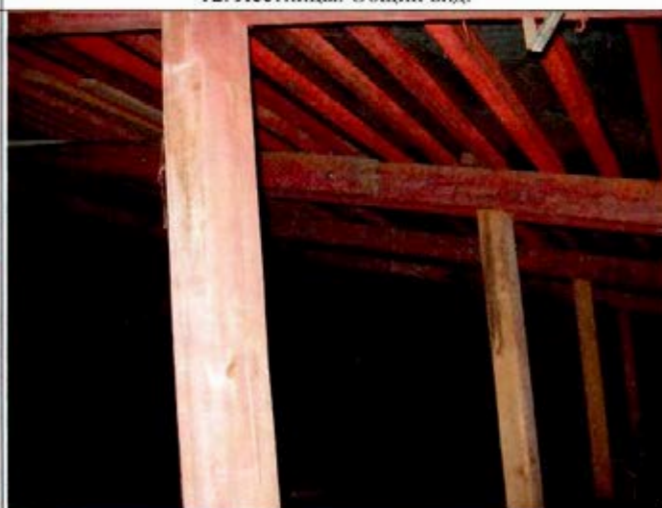
14. Конструкции крыши. Общий вид.
