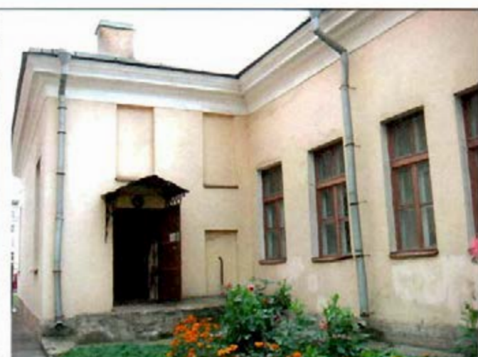
2. Фрагмент восточного фасада.
