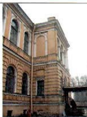
8. Северный фасад. Фрагмент.
