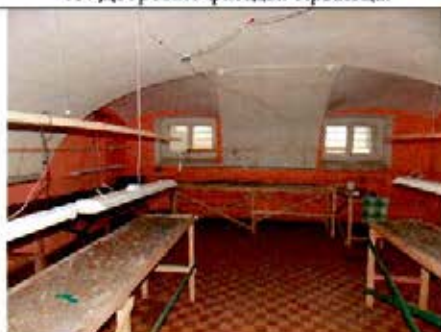
15. Помещение в уровне подвала. Общий вид.
