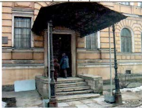
10. Входная группа северного фасада. Общий вид.
