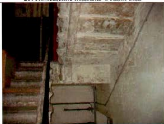
27. Лестница в западной части здания. Общий вид.
