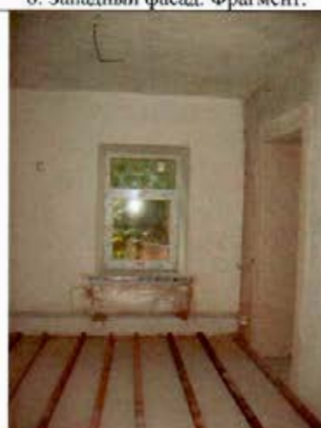
8. Помещение 1-го этажа. Общий вид.
