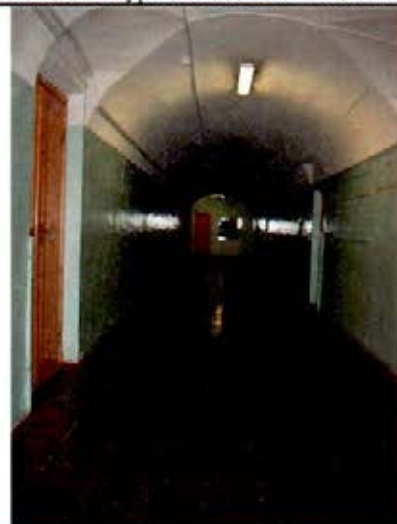
17. Коридор 1-го этажа. Общий вид.
