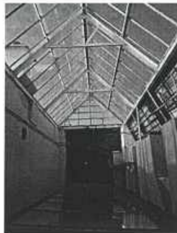
Фото 10. Фрагмент светового фонаря
