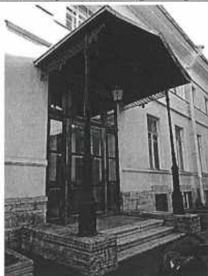
Фото 8. Фрагмент дворового фасада. Входная группа
