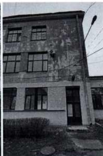
Фрагмент юго-западного фасада
