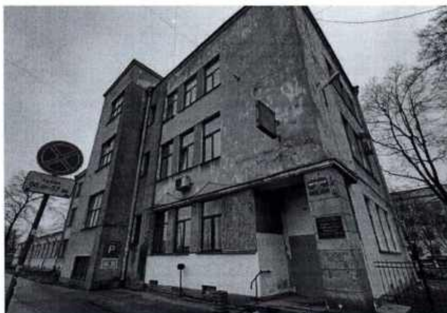
Фрагмент северо-восточного фасада
