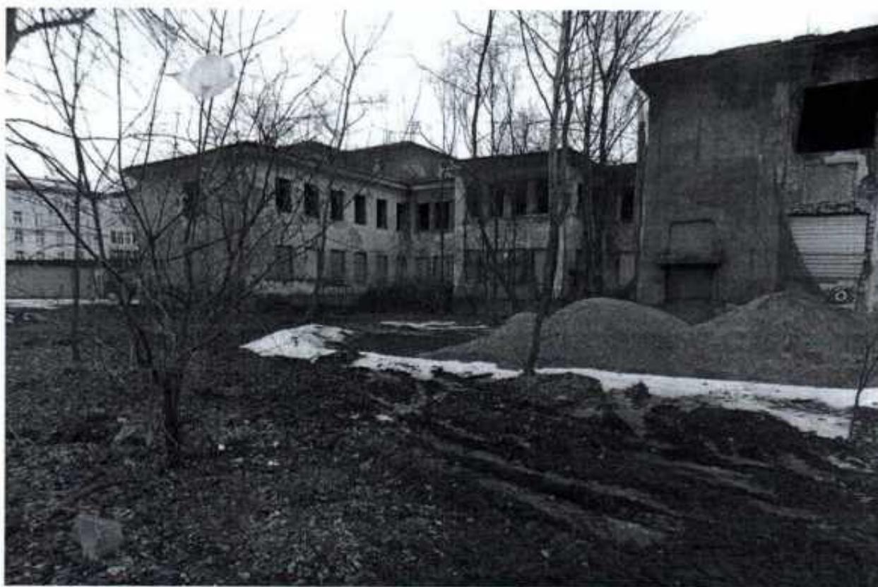
Территория объекта культурного наследия, фрагмент (северо-западная часть)
