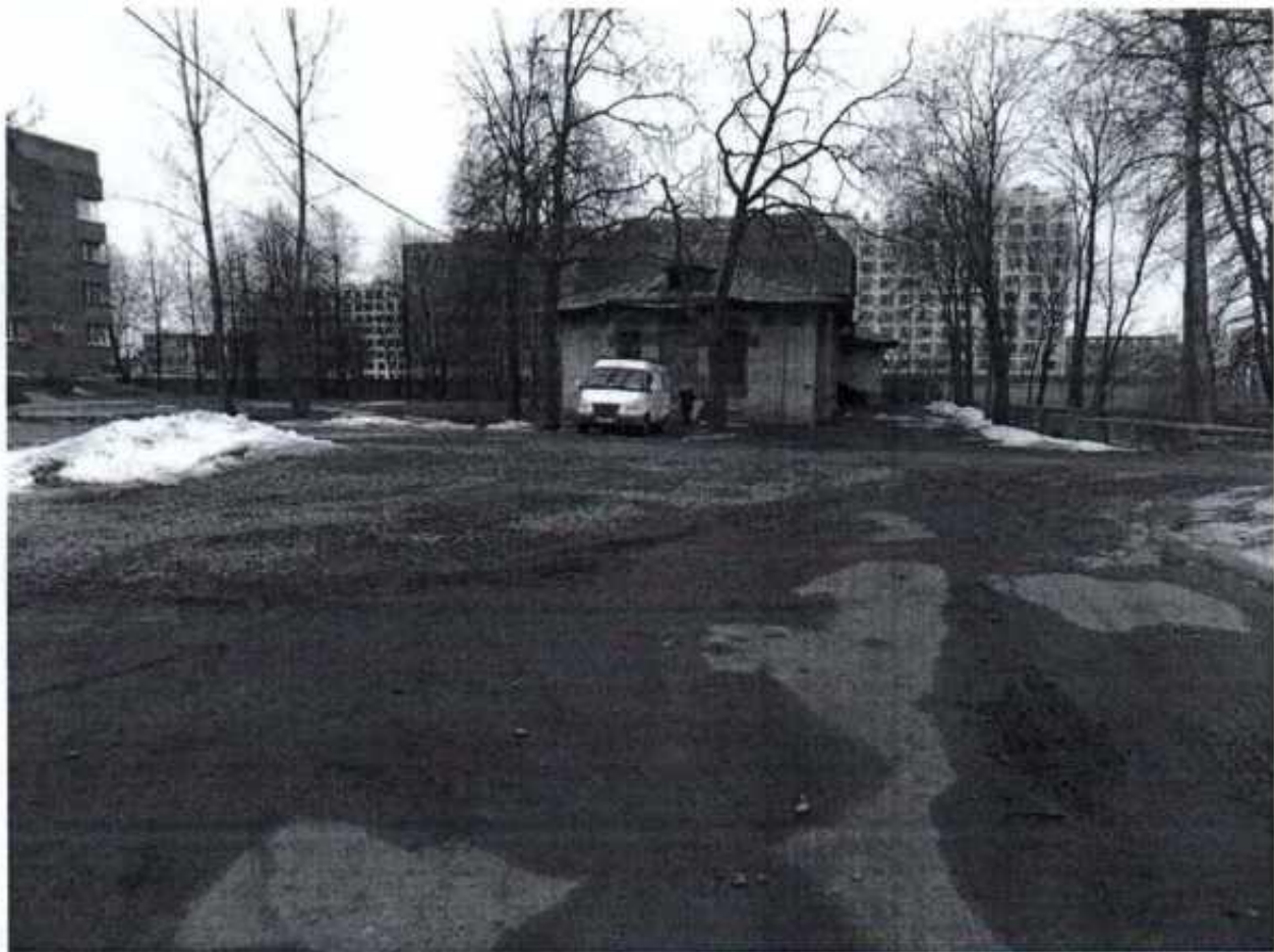
Территория объекта культурного наследия, фрагмент (южная часть)
