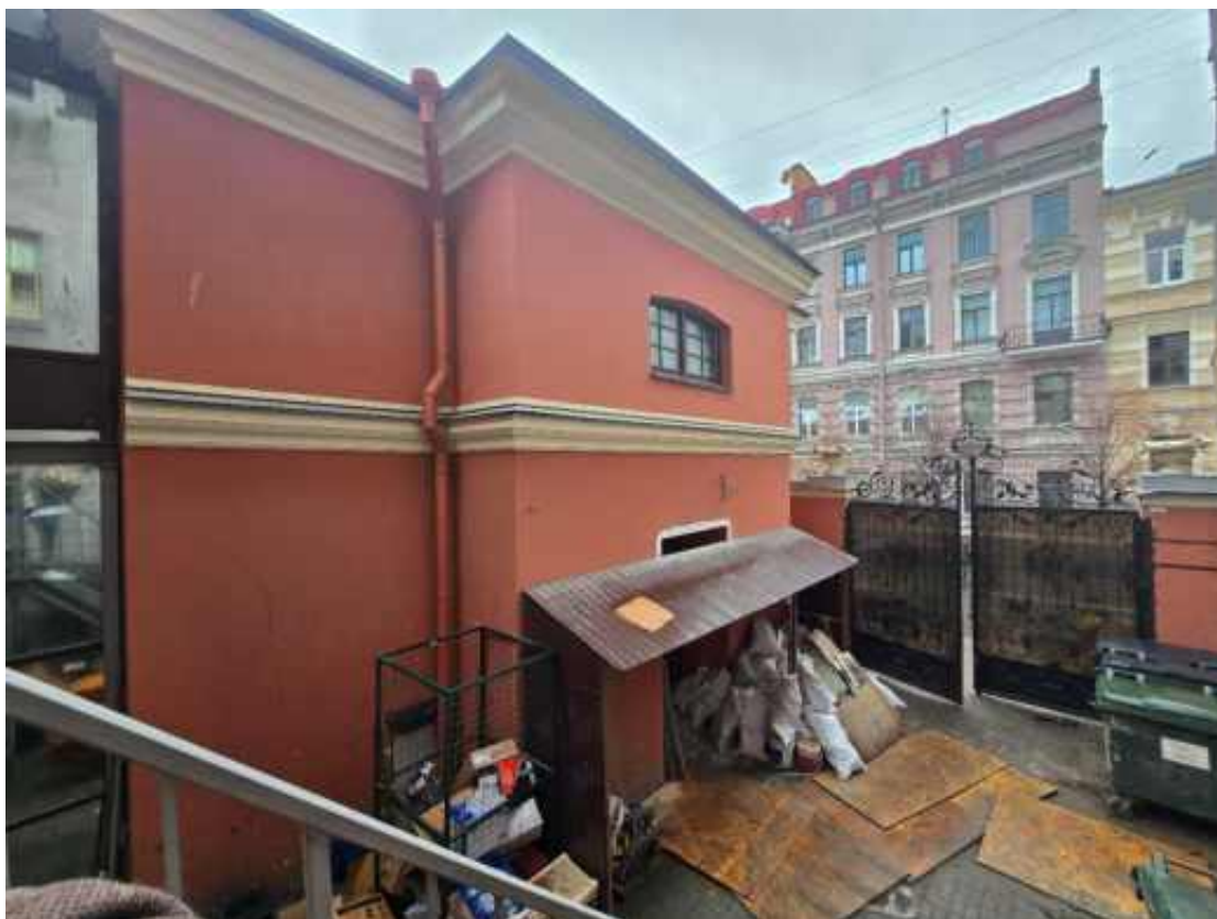
Фото 3. Северо-восточный дворовый фасад хозяйственного двора.
