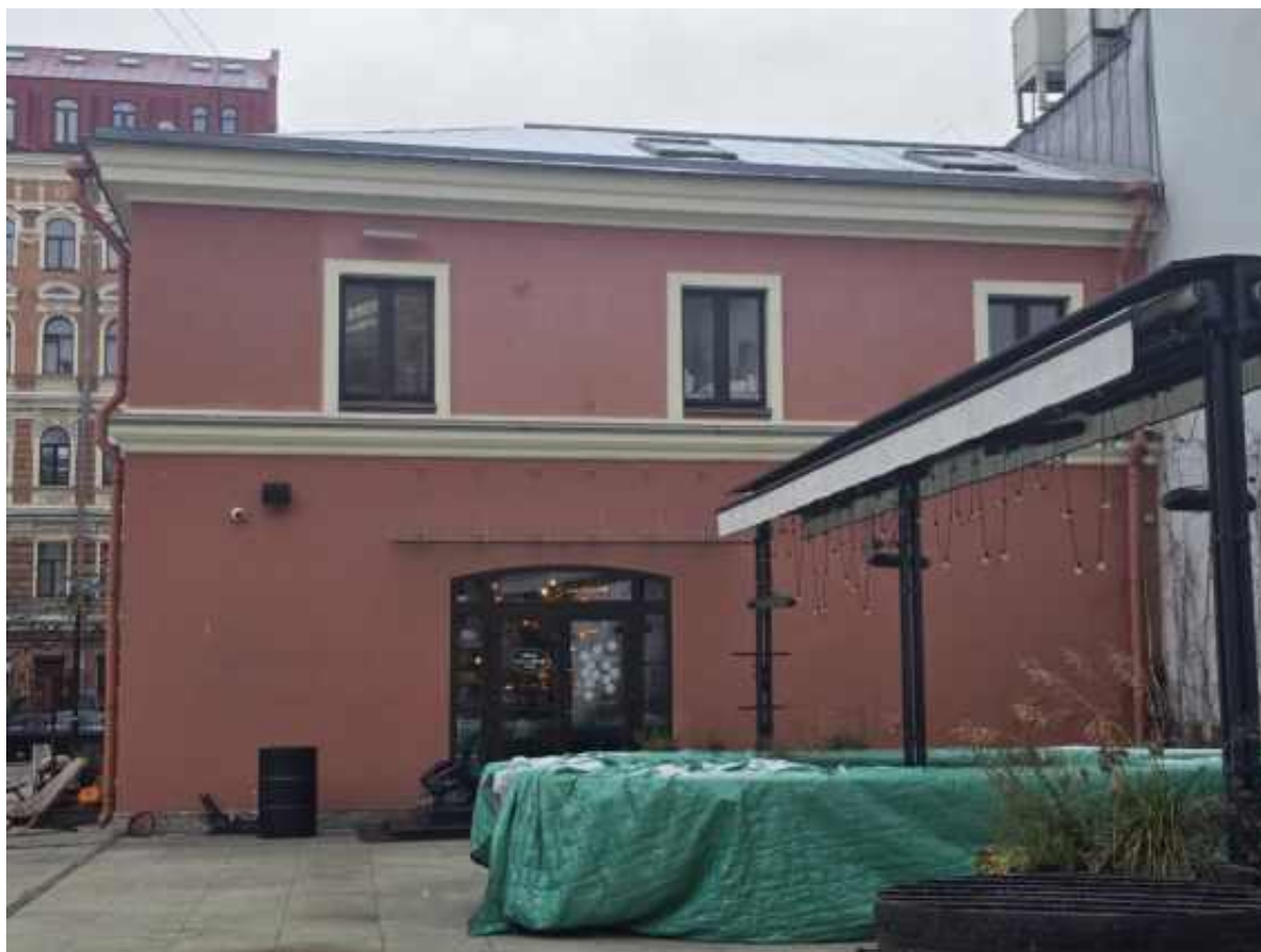
Фото 9. Южный торцевой фасад.
