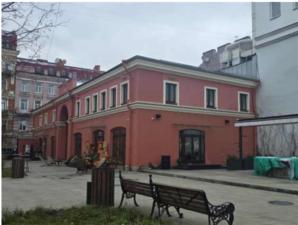
Фото 11. Юго-западный дворовый фасад.
