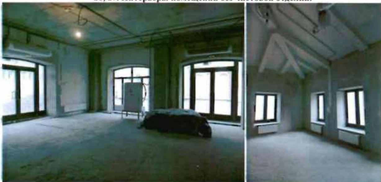
26, 27. Интерьеры помещений без чистовой отделки.
