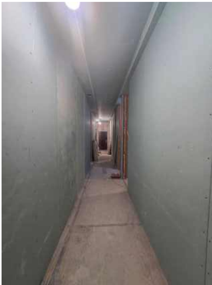
Фото 41. 1 этаж, коридор в северо-восточной части здания.
