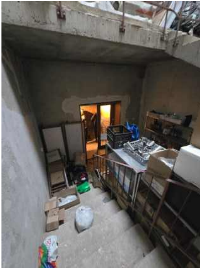
Фото 27. 1 этаж, лестница в южной части здания, помещение 110.
