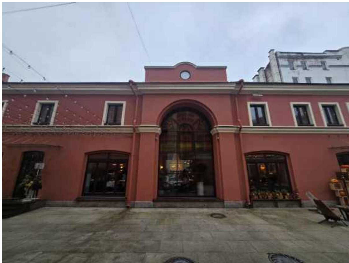
Фото 7. Арочный проем западного дворового фасада.
