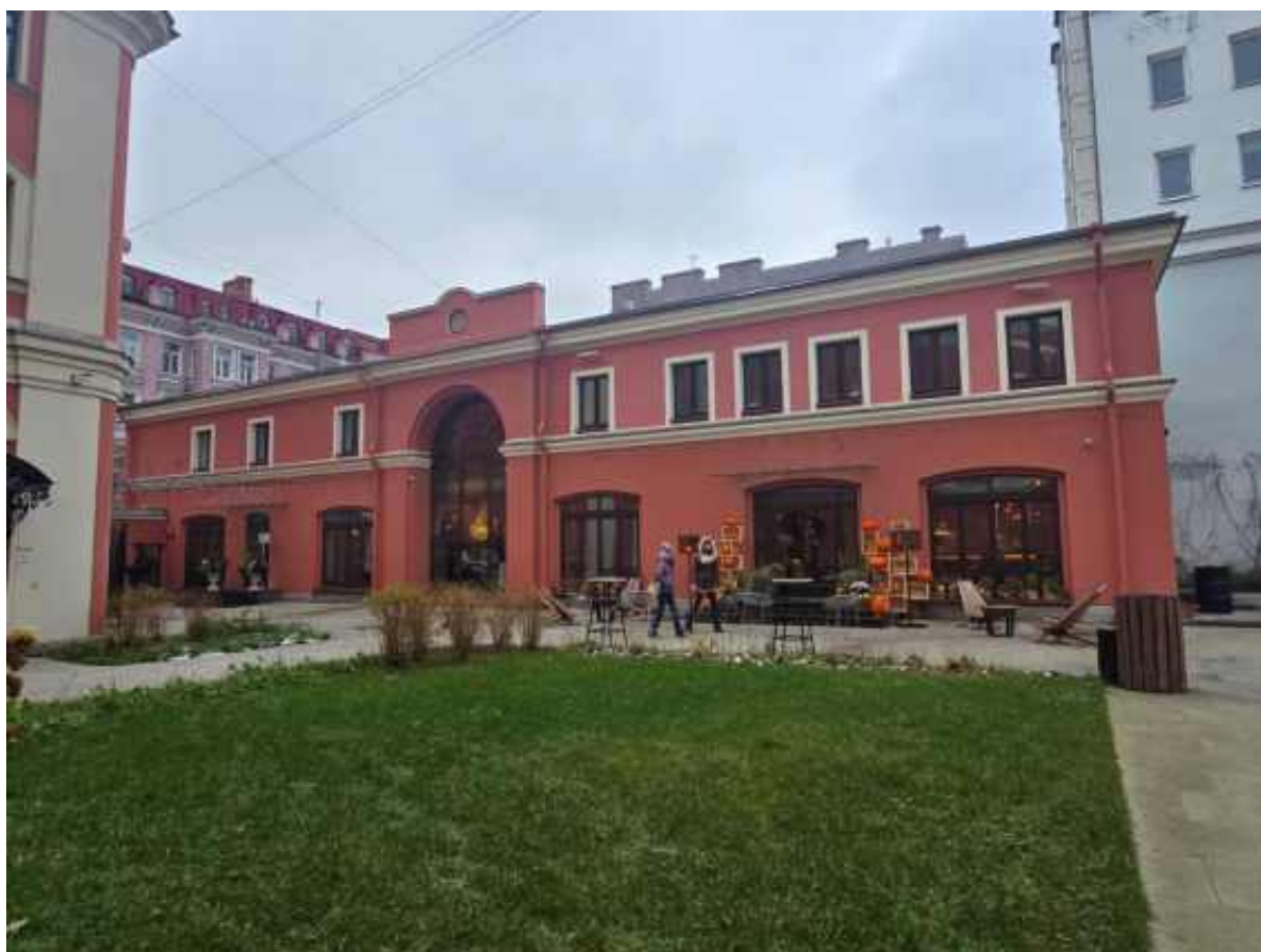
Фото 8. Западный дворовый фасад.
