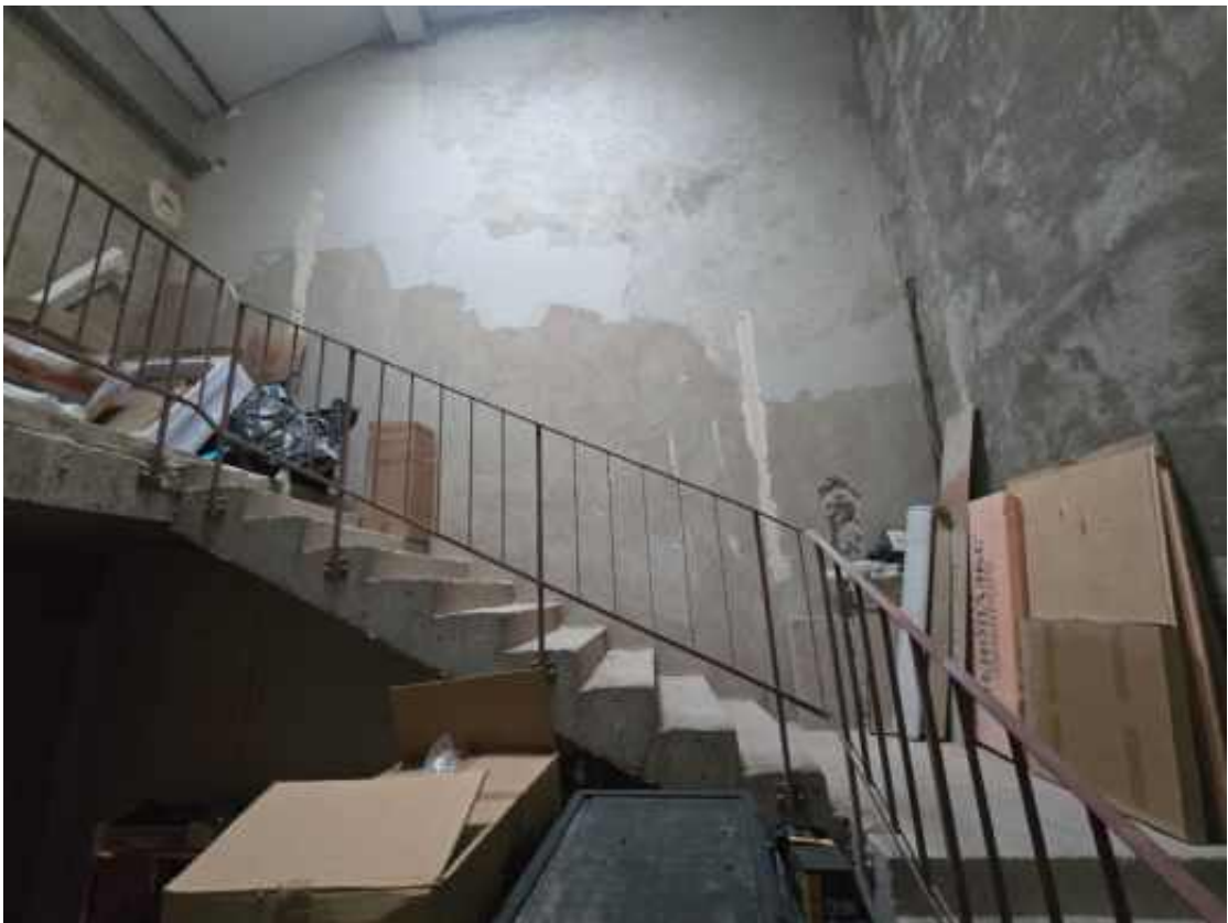
Фото 26. 1 этаж, лестница в южной части здания, помещение 110.
