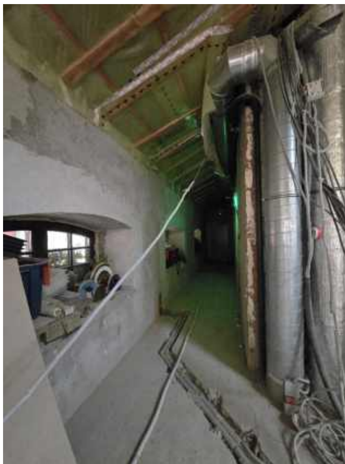
Фото 16. 2 этаж, коридор, южная часть здания.
