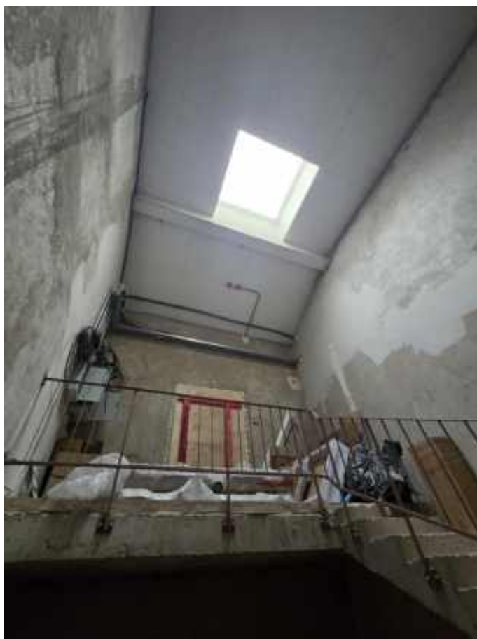
Фото 20. 2 этаж, лестница в южной части здания.
