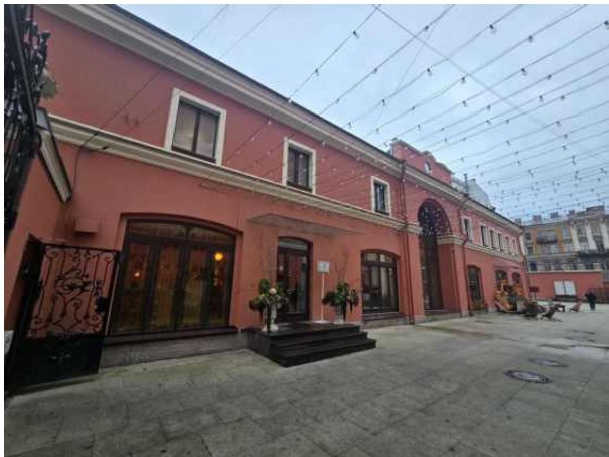
Фото 6. Западный дворовый фасад.
