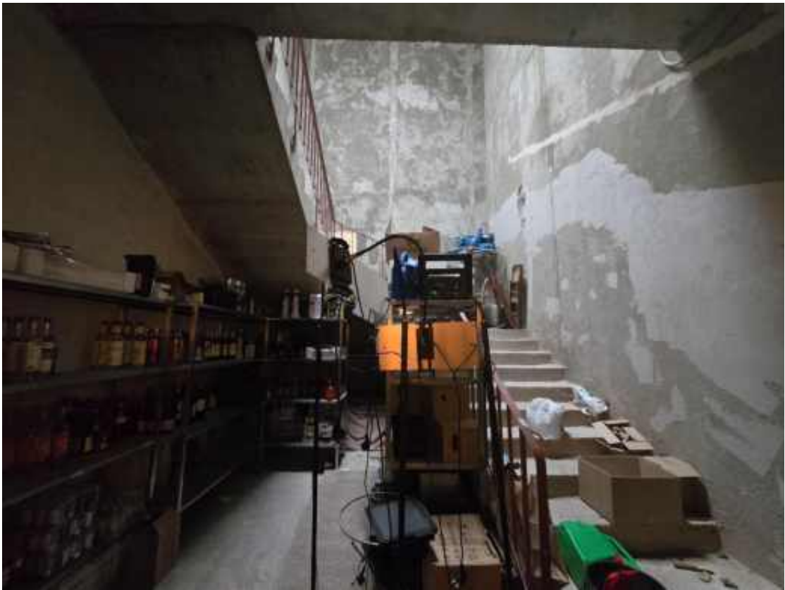
Фото 25. 1 этаж, лестница в южной части здания, помещение 110.
