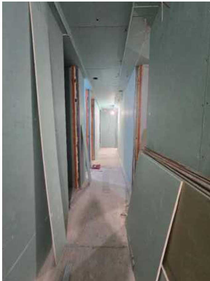
Фото 34. 1 этаж, коридор в северо-восточной части здания.
