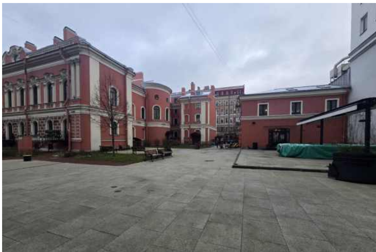
Фото 10. Южный торцевой фасад.
