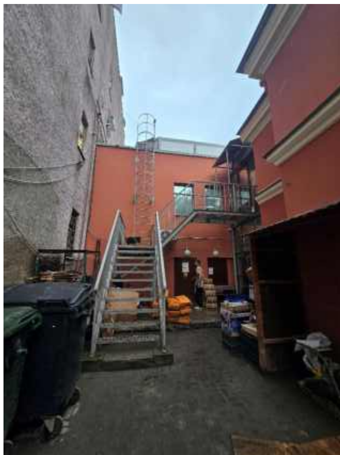
Фото 5. Северо-восточный дворовый фасад хозяйственного двора.
