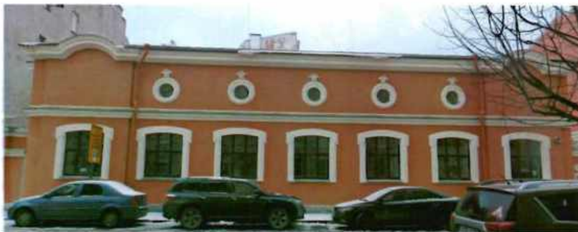
23. Общий вид Флигеля со стороны внутреннего двора.
