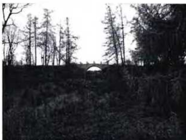
Мост-плотина. Вид от Нижней дороги. Фотография, 2015
