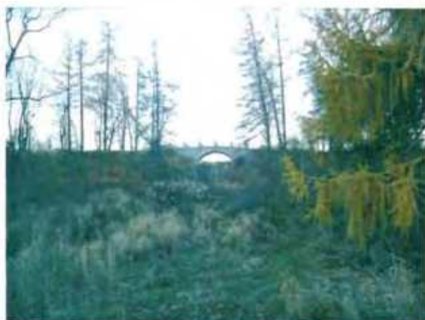
Мост-плотина. Вид от Нижней дороги. Фотография. 2015
