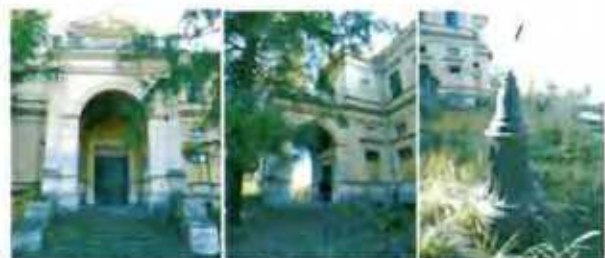
Главный подъезд Большого дворца. Тумба фонаря. Фотография, 2015
