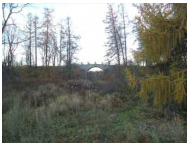
Мост-плотина. Вид от Нижней дороги. Фотография. 2015
