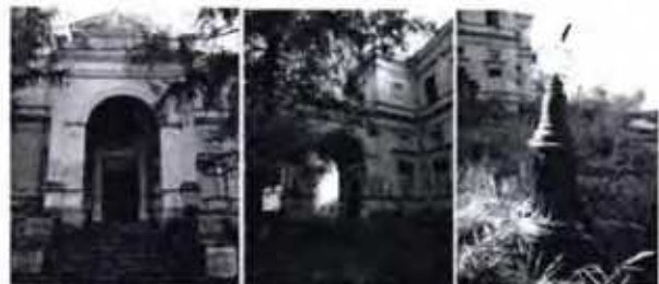
Главный подъезд Большого дворца. Тумба фонаря. Фотография. 2013
