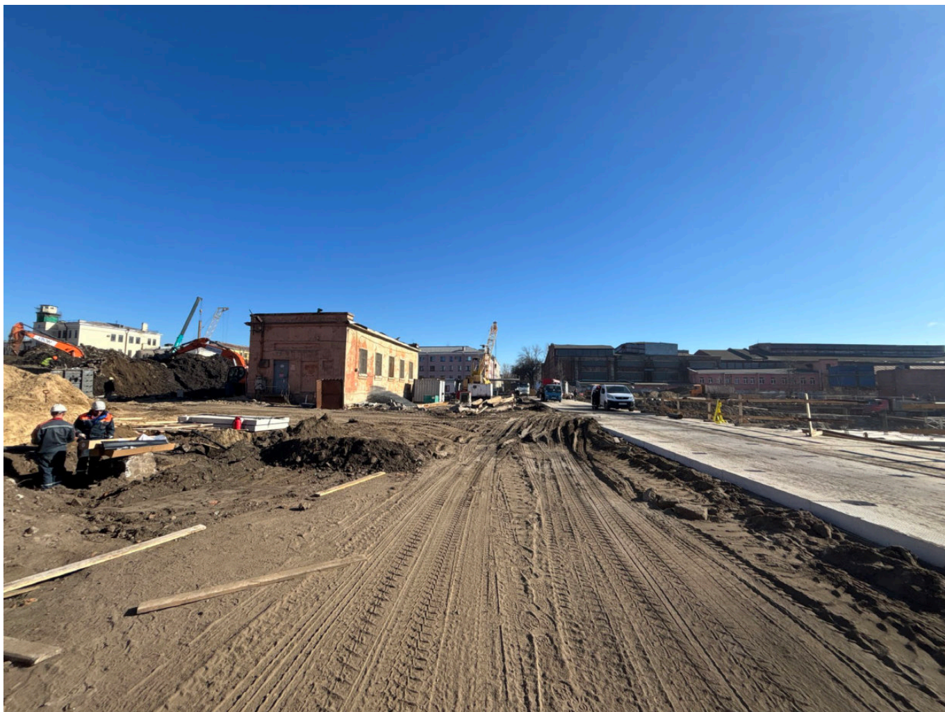
Фото 14. Берма между котлованами 1 и 2 этапов строительства объекта «Многоквартирный дом (дома) со встроенными помещениями и встроенно-пристроенными подземными гаражами по адресу: г. Санкт-Петербург, ул. Перевозная, д. 1, лит. Б, кадастровый номер земельного участка 78:32:0001005:7, г. Санкт-Петербург, ул. Перевозная, д. 1, лит. В, кадастровый номер земельного участка 78:32:0001005:6». Общий вид с юга.
