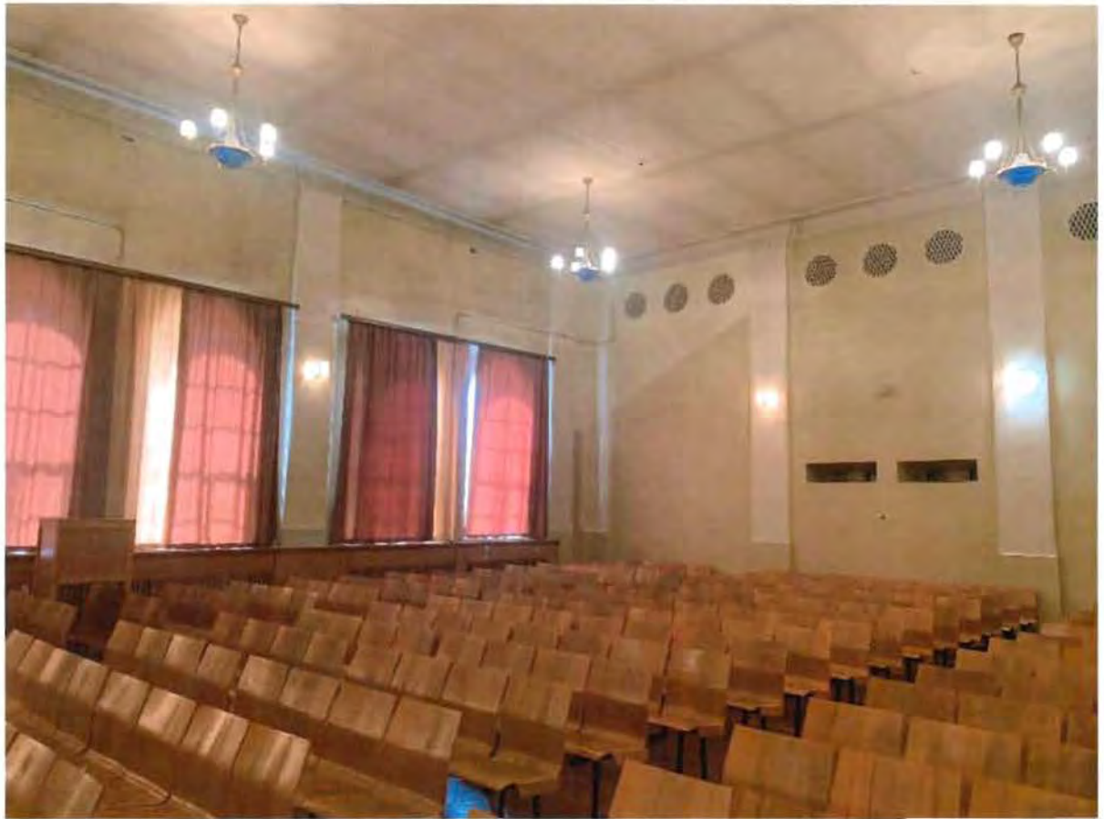
8. Пом. 74-Н. Лепной декор. Вентиляционные решетки.
