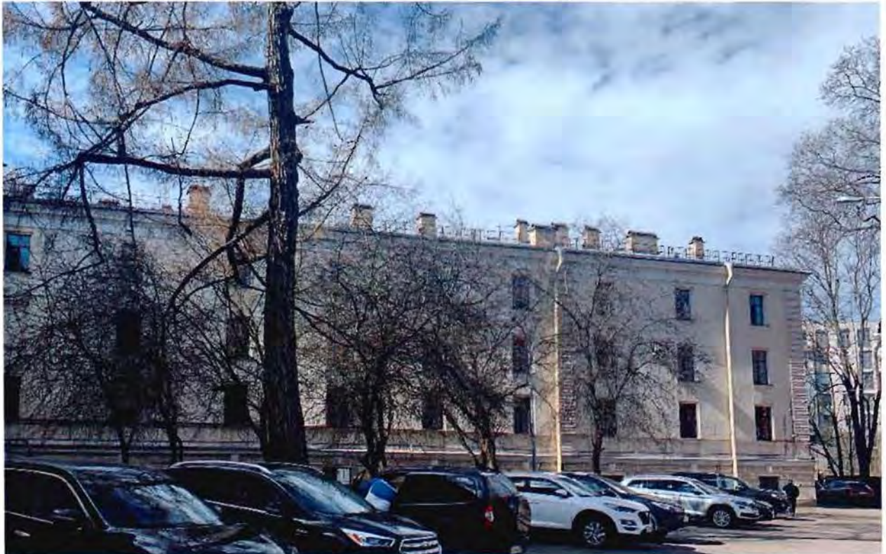
4. Северо-восточный фасад северной части объекта культурного наследия.
