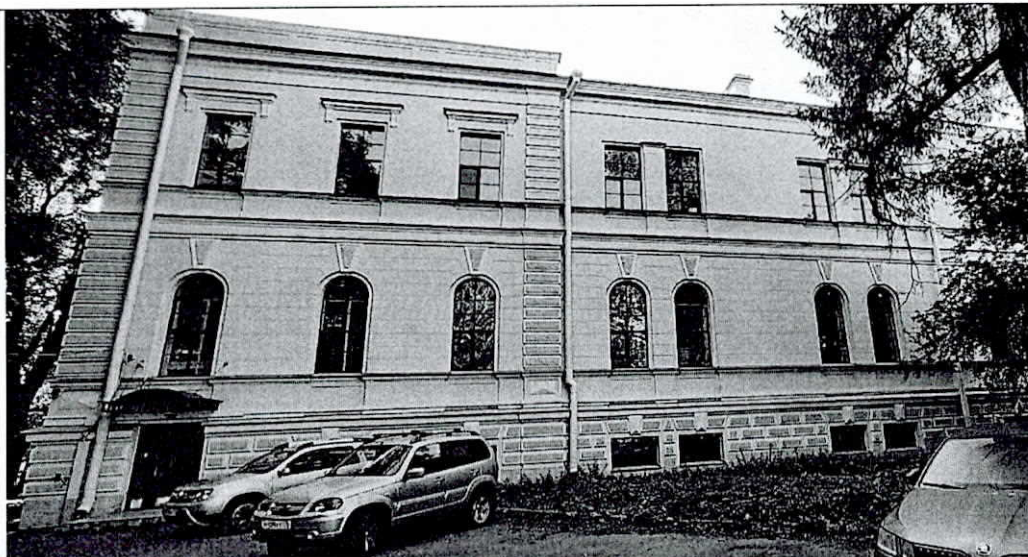
Фото 3. Фрагмент дворового фасада
