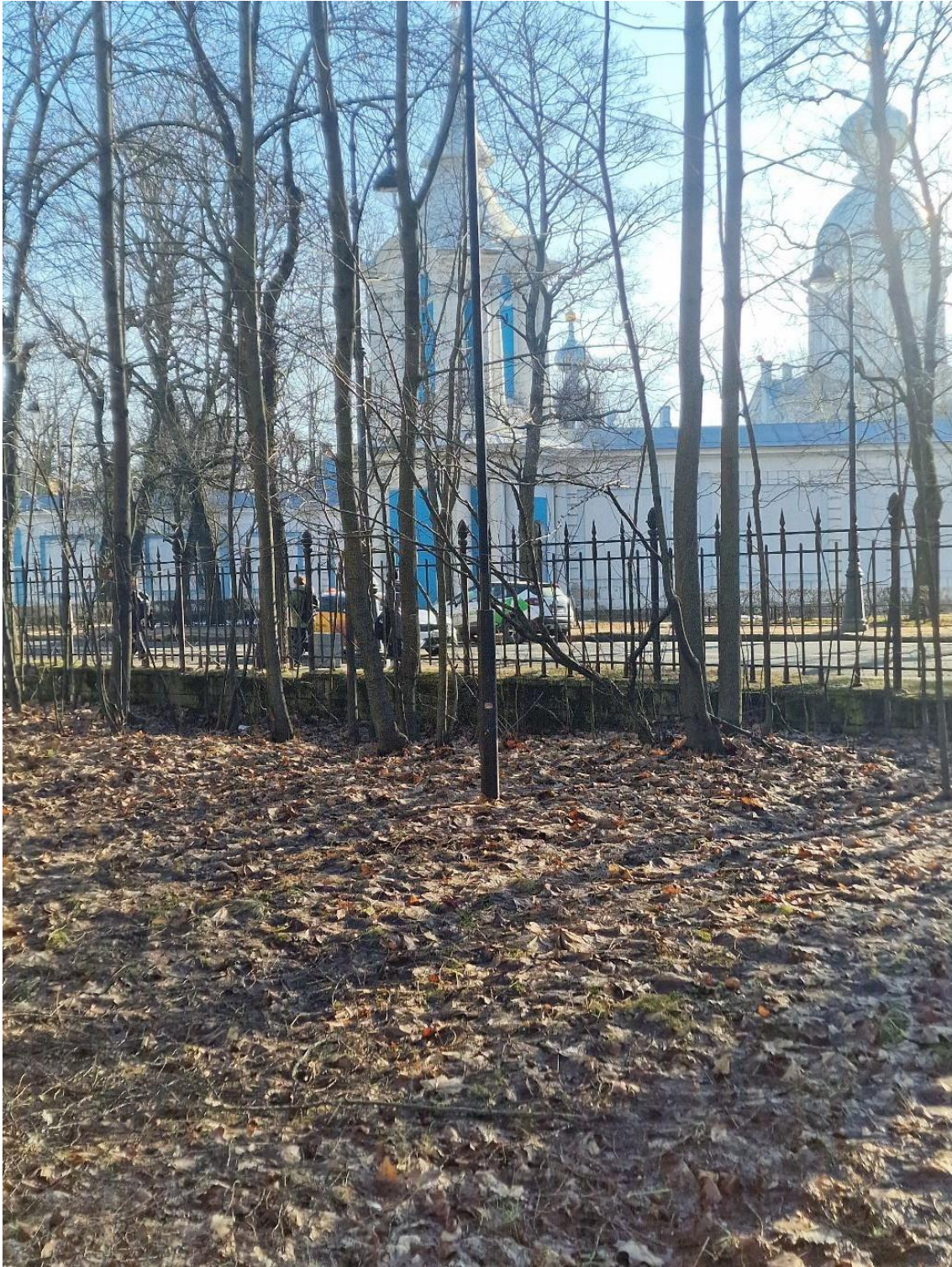
5. Объект культурного наследия регионального значения «Металлическая ограда», входящий в состав объекта культурного наследия регионального значения «Здание богадельни в память совершеннолетия цесаревича Николая Александровича (с металлической оградой)». Фрагмент ограды по улице Смольного.
