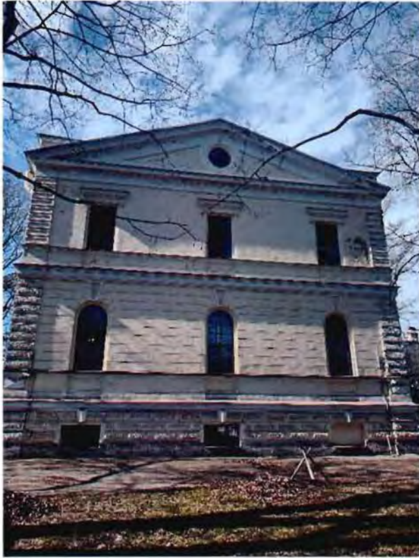
2. Вид на северо-восточный фасад объекта культурного наследия.
