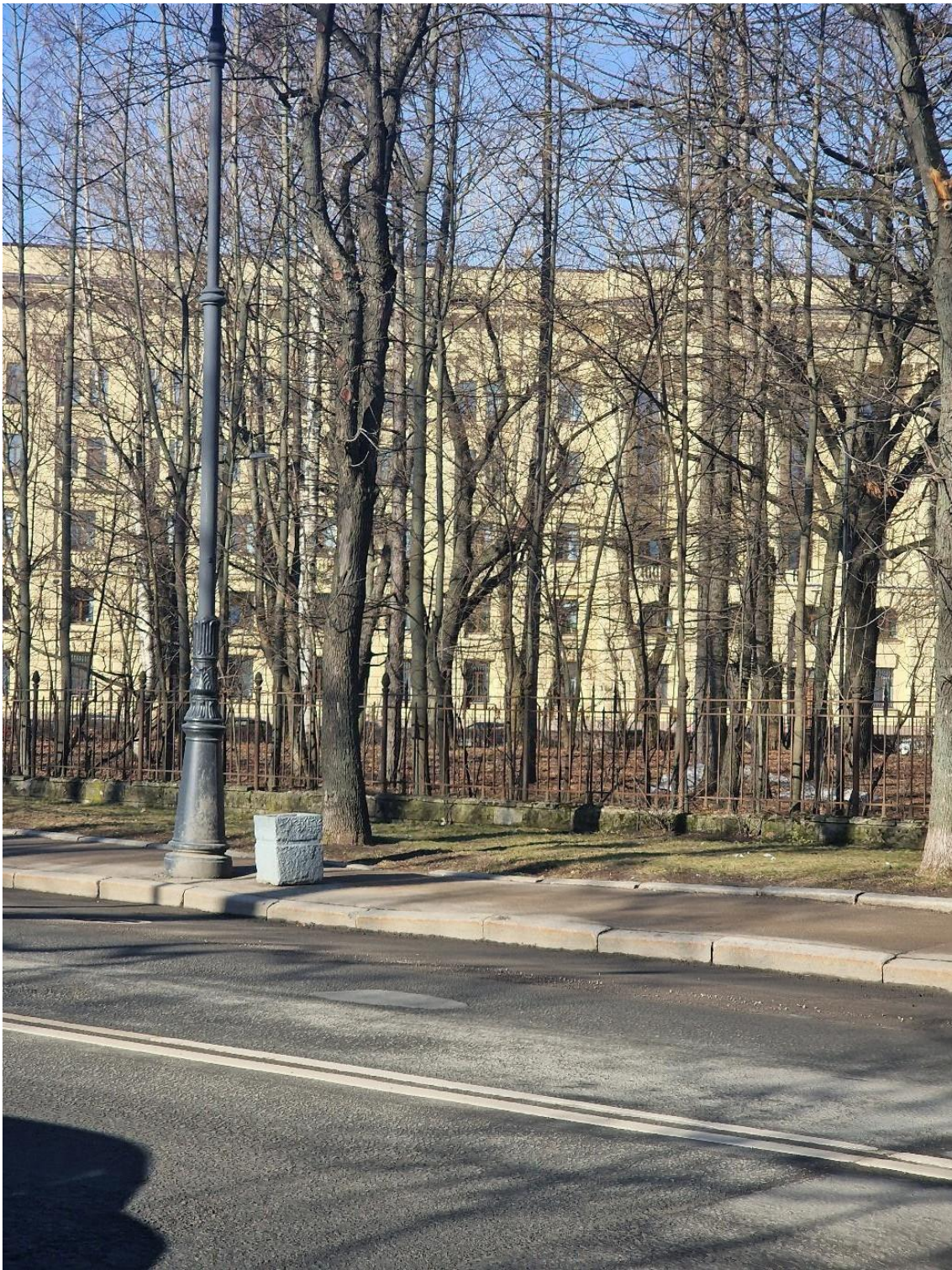
9. Объект культурного наследия регионального значения «Металлическая ограда», входящий в состав объекта культурного наследия регионального значения «Здание богадельни в память совершеннолетия цесаревича Николая Александровича (с металлической оградой)». Фрагмент ограды по улице Смольного.
