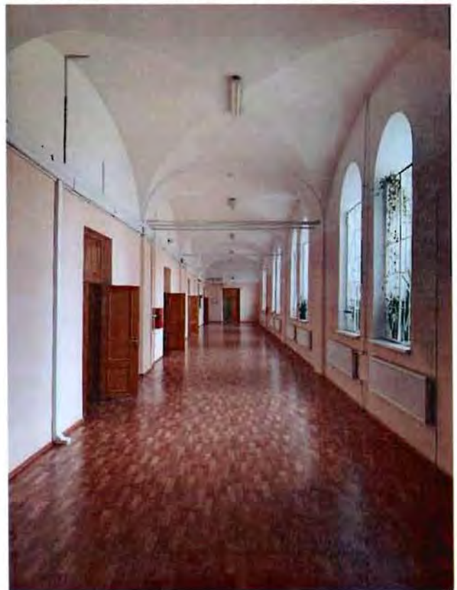
7. Коридор 1-го этажа. Своды с распалубками.
