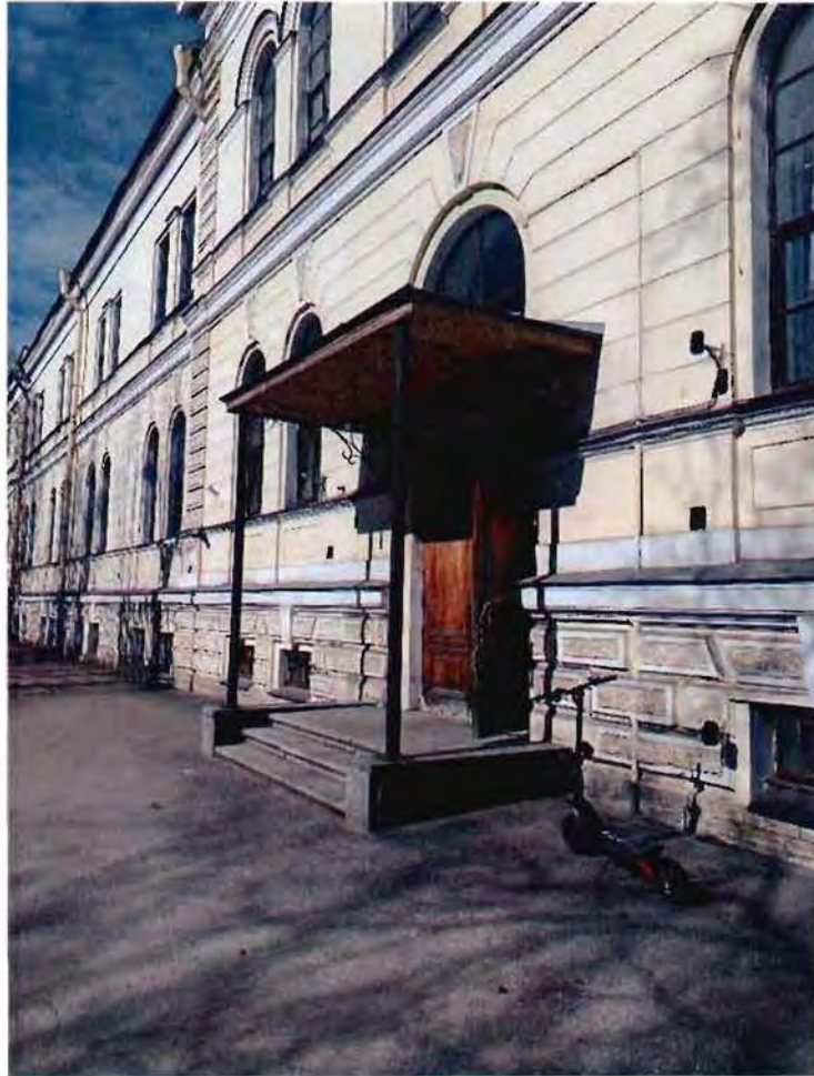
5. Юго-восточный фасад объекта культурного наследия. Входной портал.
