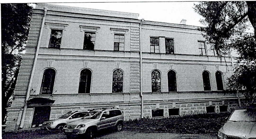
Фото 3. Фрагмент дворового фасада
