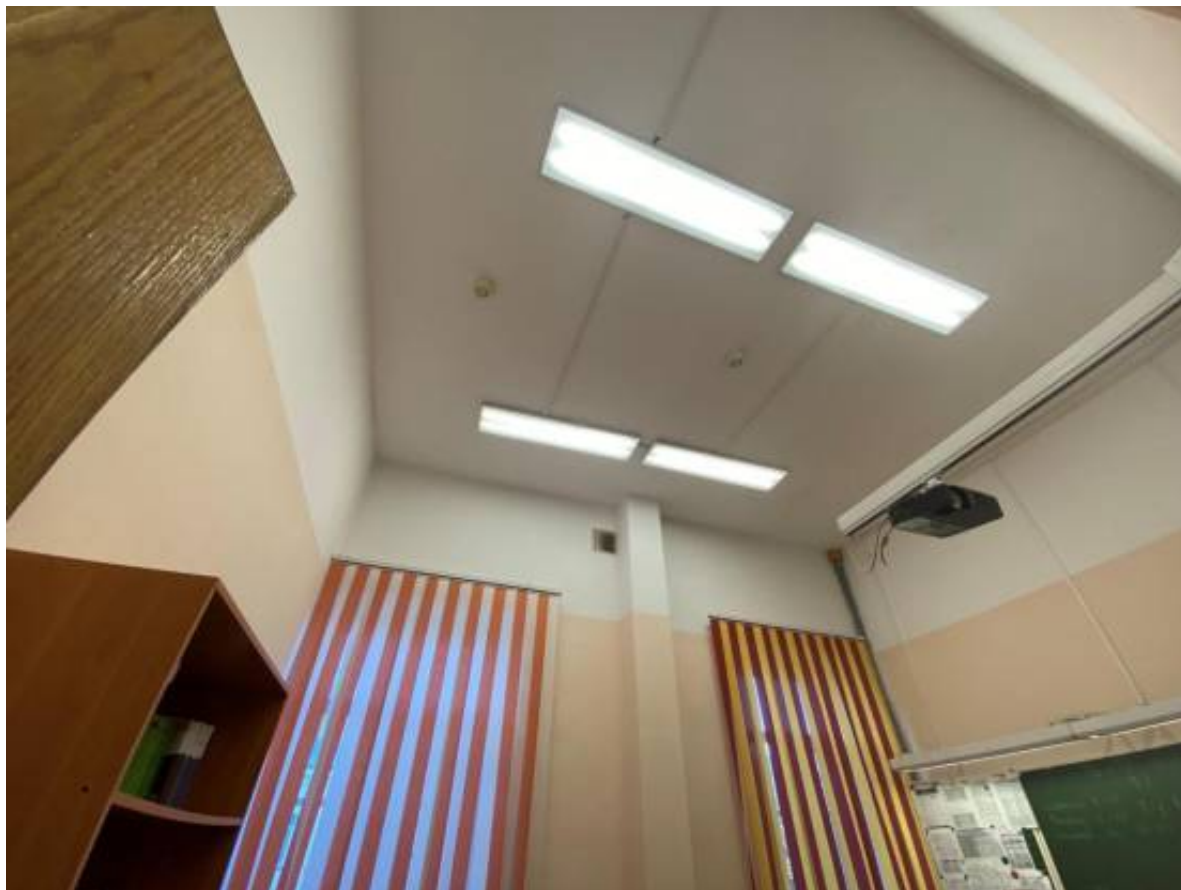
Фото 49. Помещения 3-го этажа.
