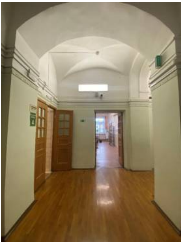
Фото 22. Помещения 1-го этажа.
