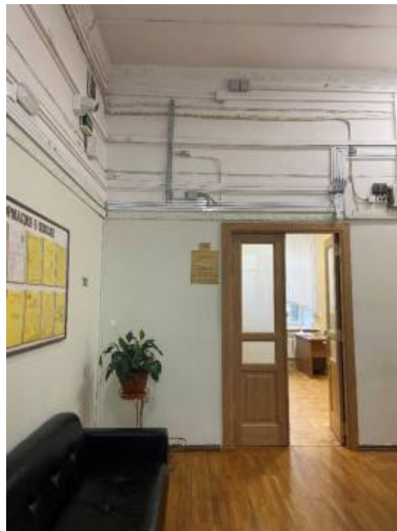
Фото 6. Помещения 1-го этажа.
