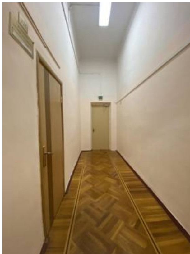
Фото 51. Помещения 3-го этажа.
