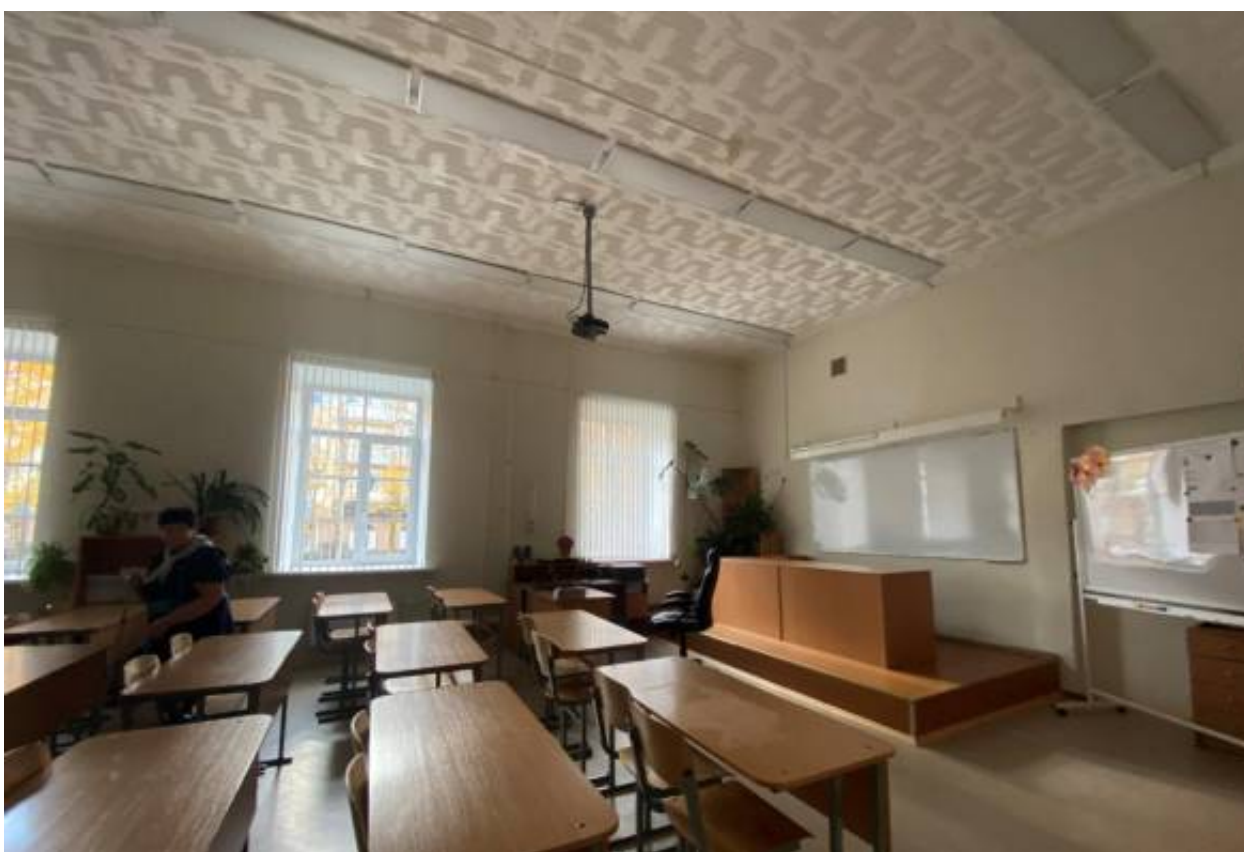
Фото 21. Помещения 1-го этажа.
