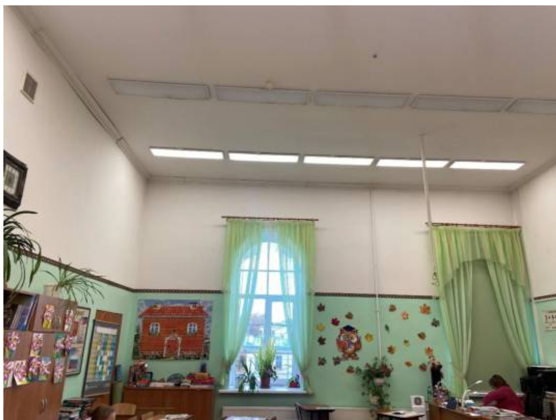
Фото 28. Помещения 2-го этажа.
