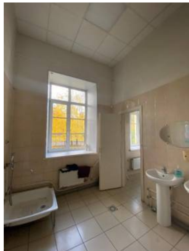
Фото 12. Помещения 1-го этажа.
