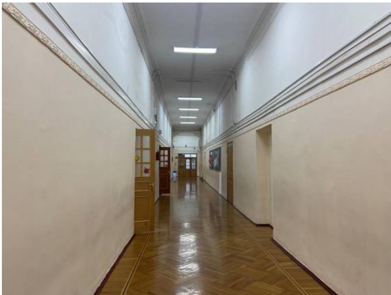
Фото 33. Помещения 2-го этажа.
