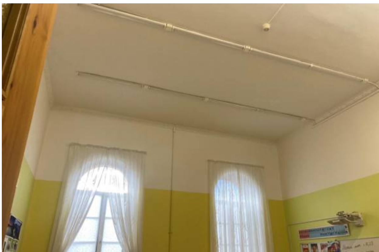
Фото 34. Помещения 2-го этажа.
