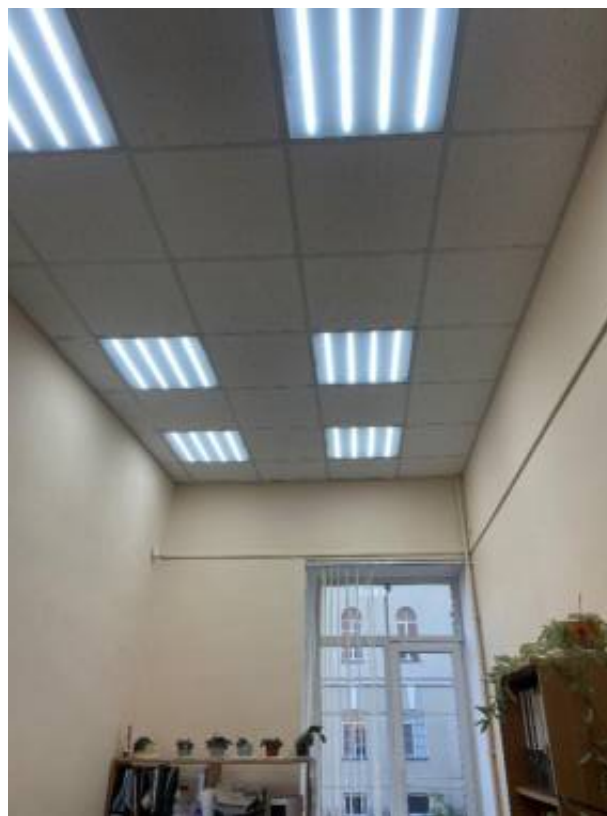
Фото 10. Помещения 1-го этажа.
