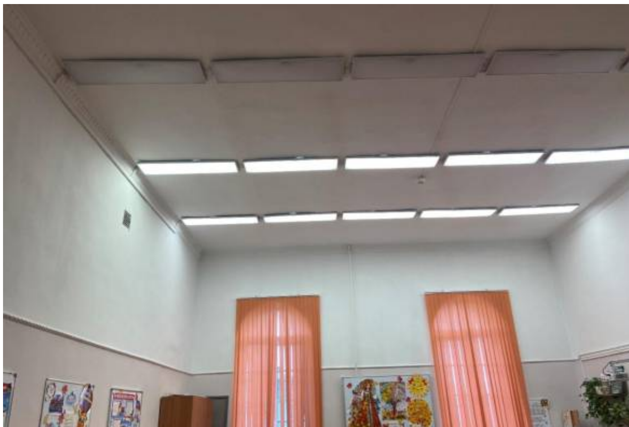
Фото 30. Помещения 2-го этажа.
