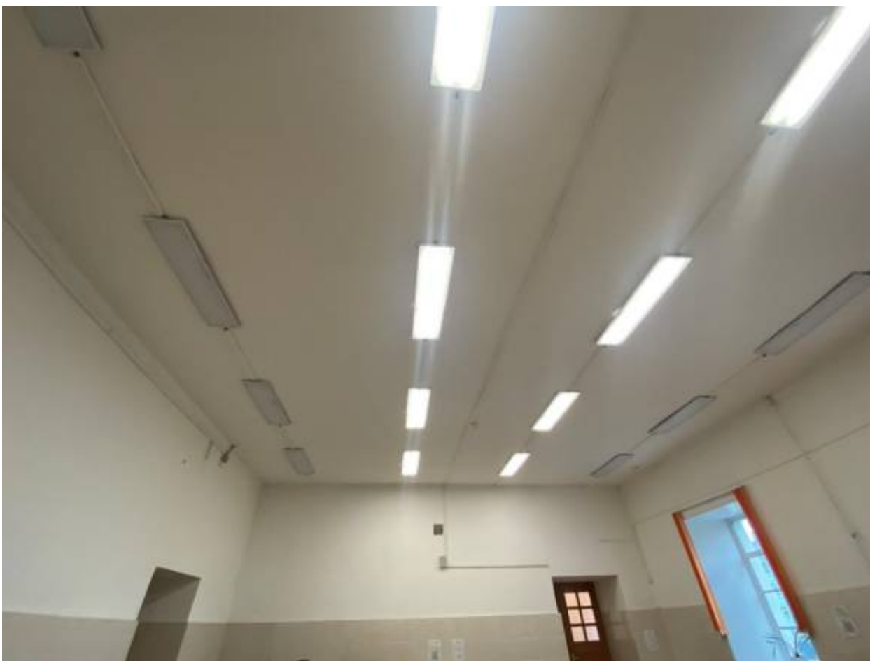
Фото 24. Помещения 1-го этажа.
