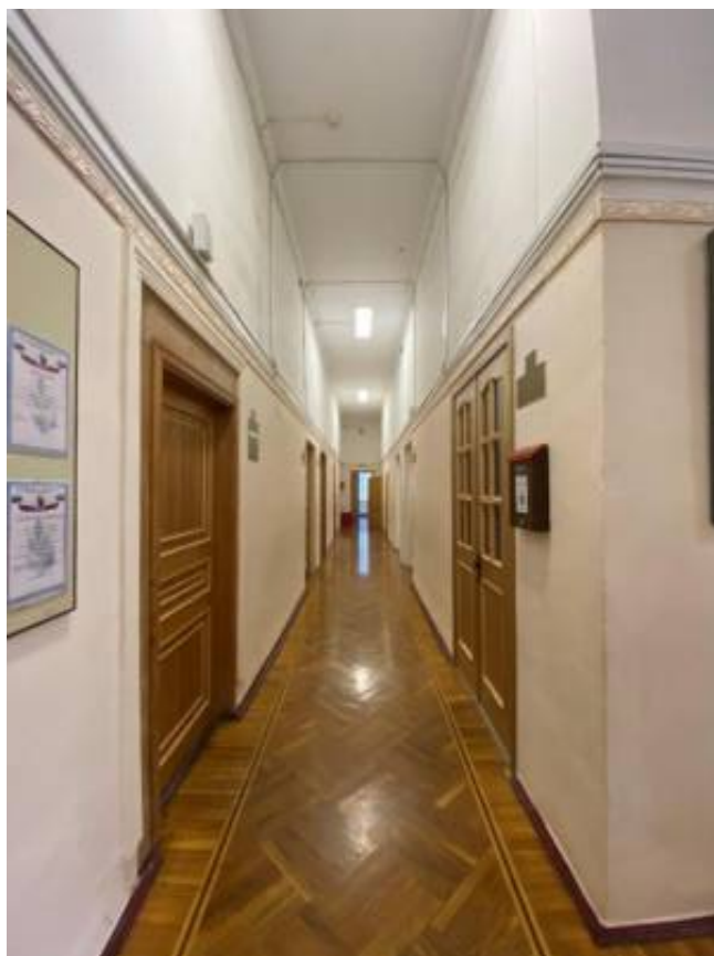
Фото 36. Помещения 2-го этажа.
