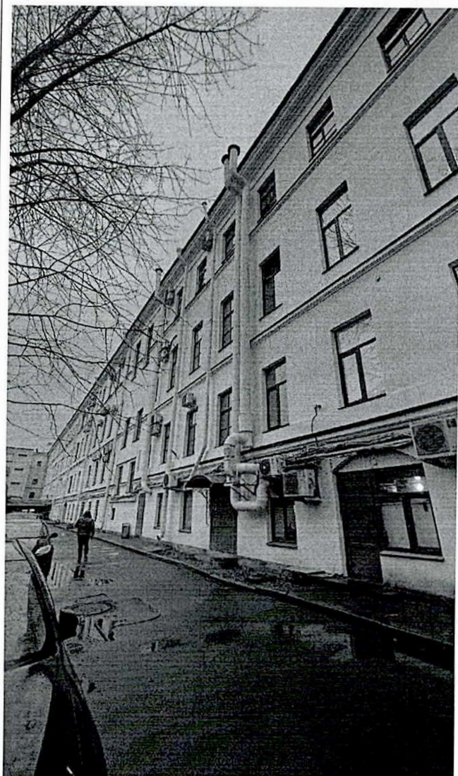
8. Фрагмент дворового фасада. Наружные блоки системы кондиционирования- 1 этаж помещения 21-Н, 23-Н в количестве 4 штук, в уровне 2-го этажа в границах помещений 39-Н, 40-Н в количестве 8 штук, в уровне 3-го этажа в границах квартиры 53, 53-Н, 55-Н в количестве 11 штук, в уровне 4-го этажа в границах помещений 72-Н, 74-Н, 75-Н в количестве 12 штук. Три вертикальных воздухопроводов из помещений 21-Н, 23-Н
