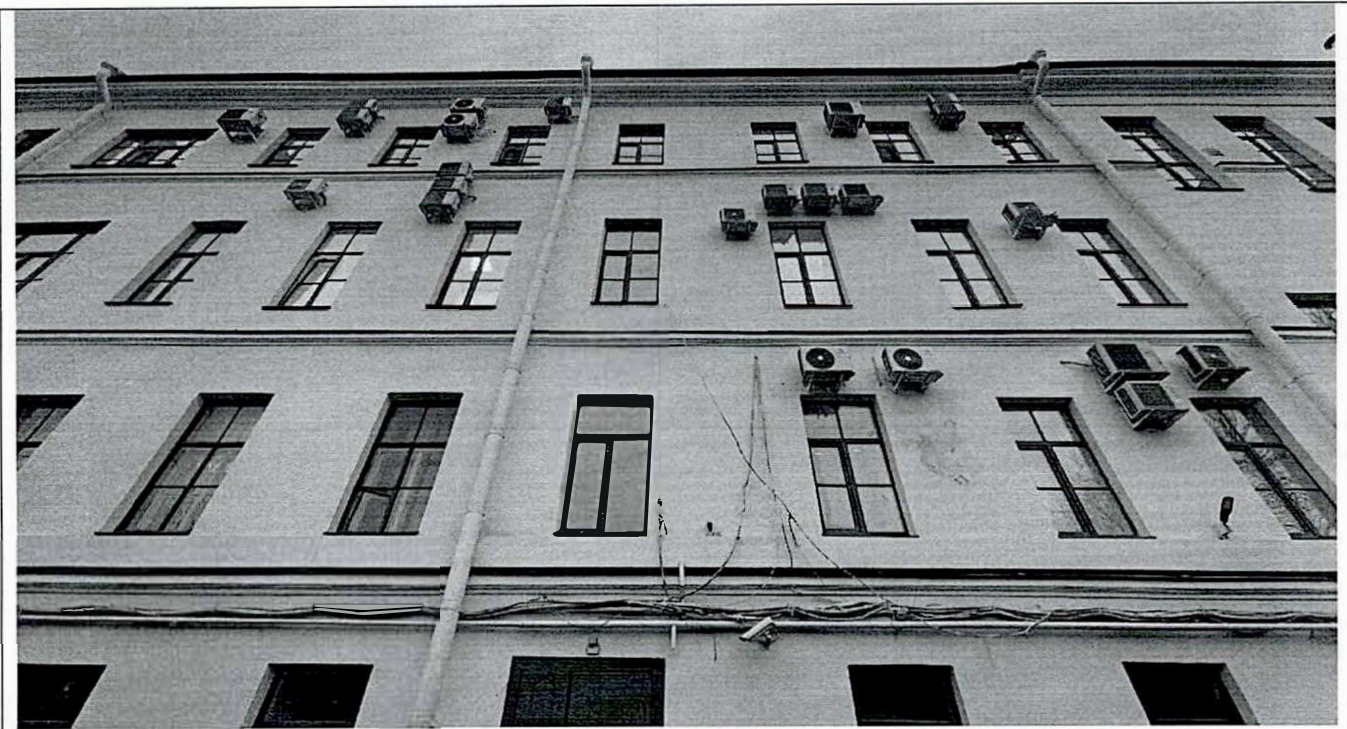
9. Фрагмент дворового фасада. В уровне 2-го этажа в границах помещений 40-Н в количестве 5 штук, в уровне 3-го этажа в границах помещений 52-Н, 53-Н, 55-Н в количестве 9 штук, в уровне 4-го этажа в границах помещений 74-Н, 75-Н в количестве 9 штук. Наружная камера видеонаблюдения справа от входа на лестничную клетку 10 (ЛК10). локальная деструкция окрасочного слоя под наружным блоком системы кондиционирования в границах помещения 40-Н.
