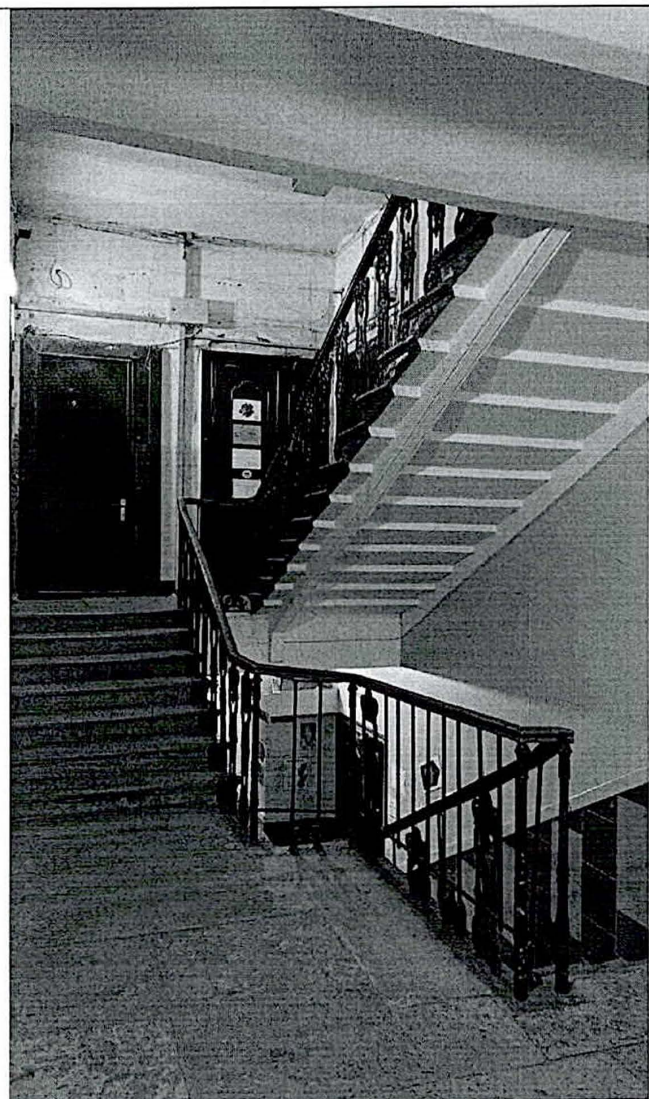
12. Фрагмент лестничной клетки 3 (ЛК 3). Часть фигурного ограждения заменена на вертикальные прутья, ступени облицованы керамической плиткой, стены защиты современными панелями.
