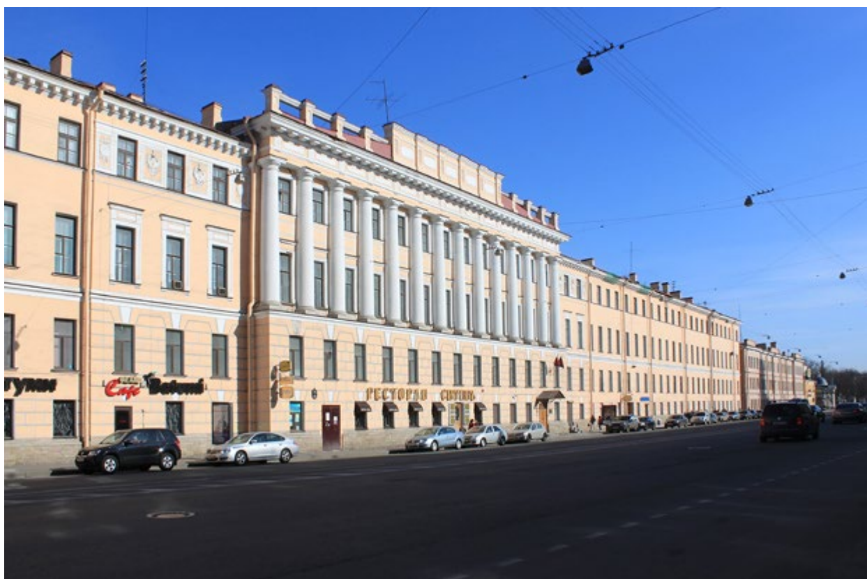
Илл. 15. 2011 г. Измайловский пр., д. 2. Лицевой фасад
