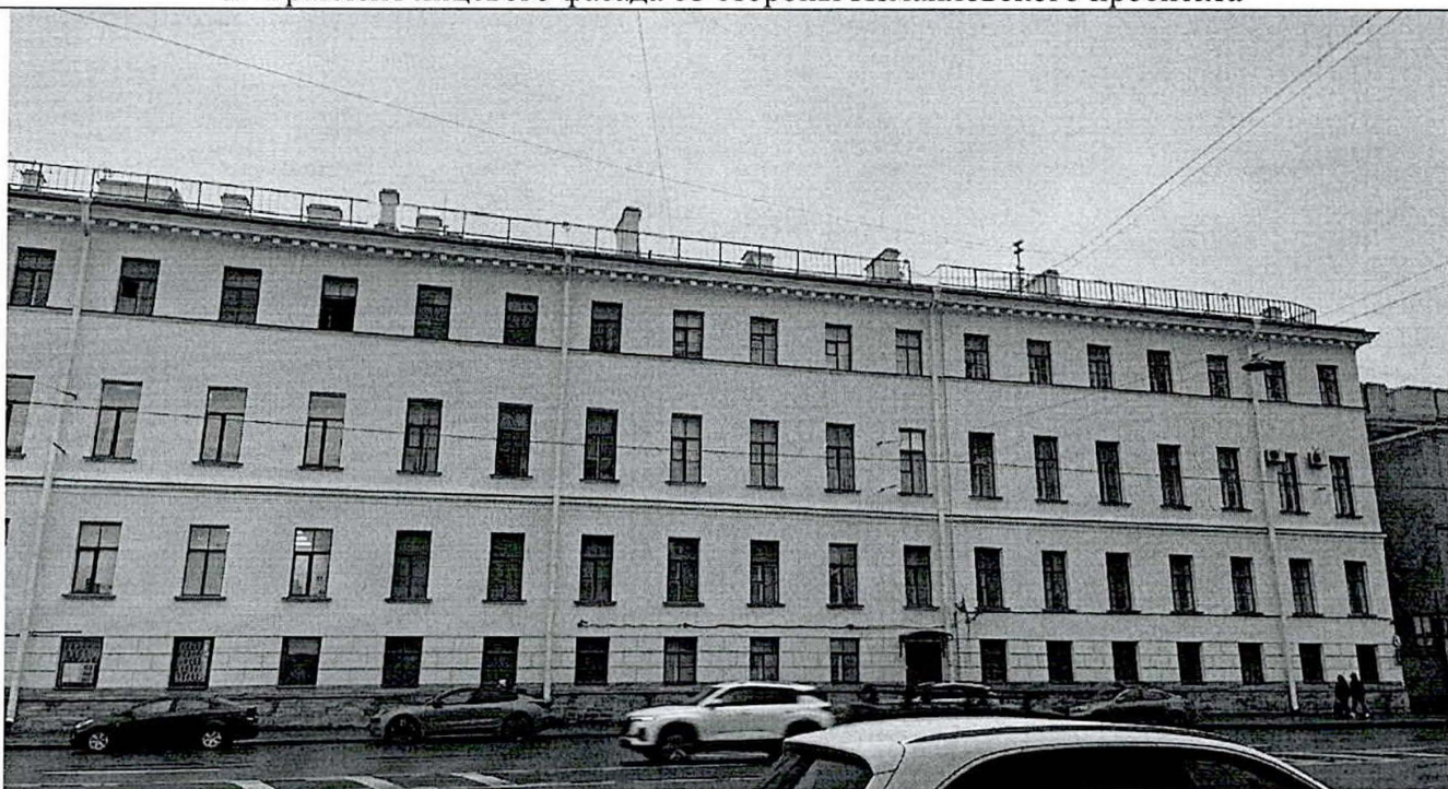
4. Фрагмент лицевого фасада со стороны Измайловского проспекта. На лицевом фасаде зафиксировано наличие наружных блоков системы кондиционирования в уровне 3-го этажа в границах помещения 6-Н в количестве 2 штук.
