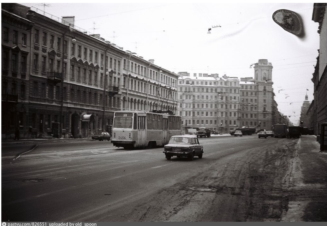
Илл. 13. 1988 г. Измайловский пр., д. 2. Фрагмент лицевого фасада (справа)
