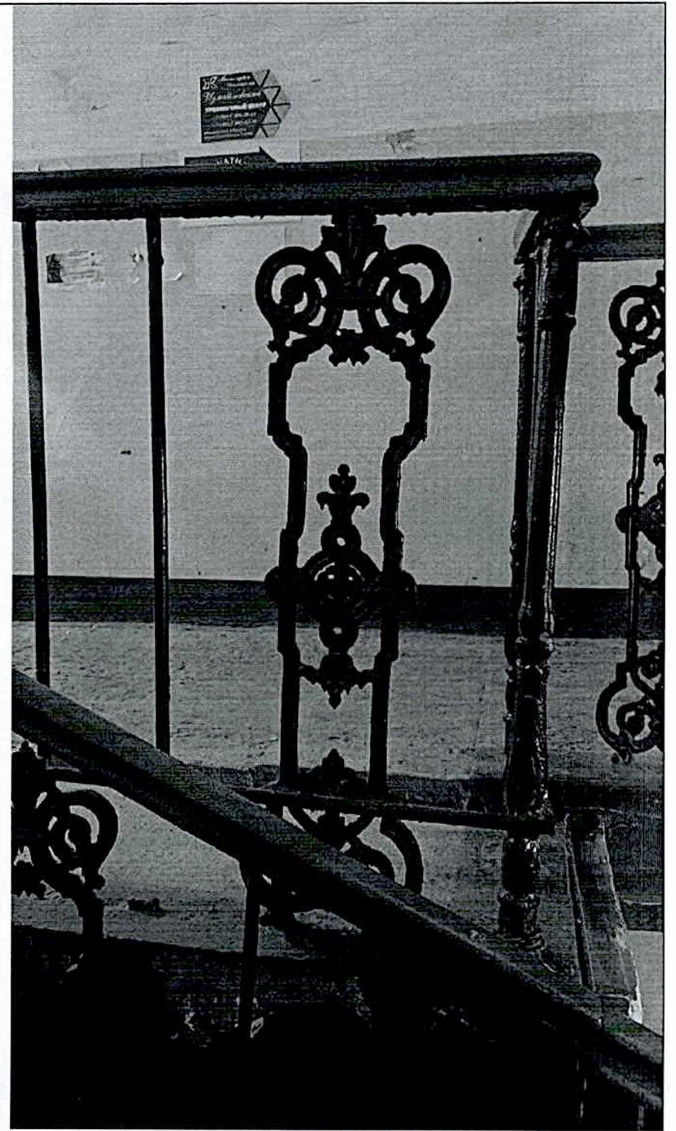
14. Фрагмент лестничной клетки 3 (ЛК 3). Часть фигурного ограждения заменена на вертикальные прутья, ступени облицованы керамической плиткой, стены защиты современными панелями.
