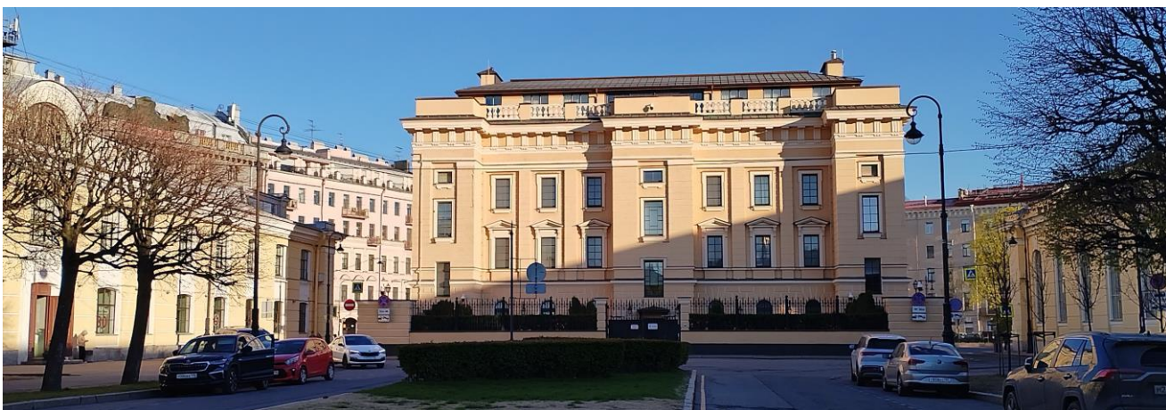
Илл. 4. СПб, Манежная площадь, дом 4, (б. Дом офицерского корпуса ЕИВ конвоя, 1908 г., в центре) и строения в границах территории объекта культурного наследия федерального значения «Михайловский (Инженерный) замок», объекты культурного наследия федерального значения «Манеж Михайловский» (экзерциргауз, справа) и «Конюшни» (слева). Вид с севера
