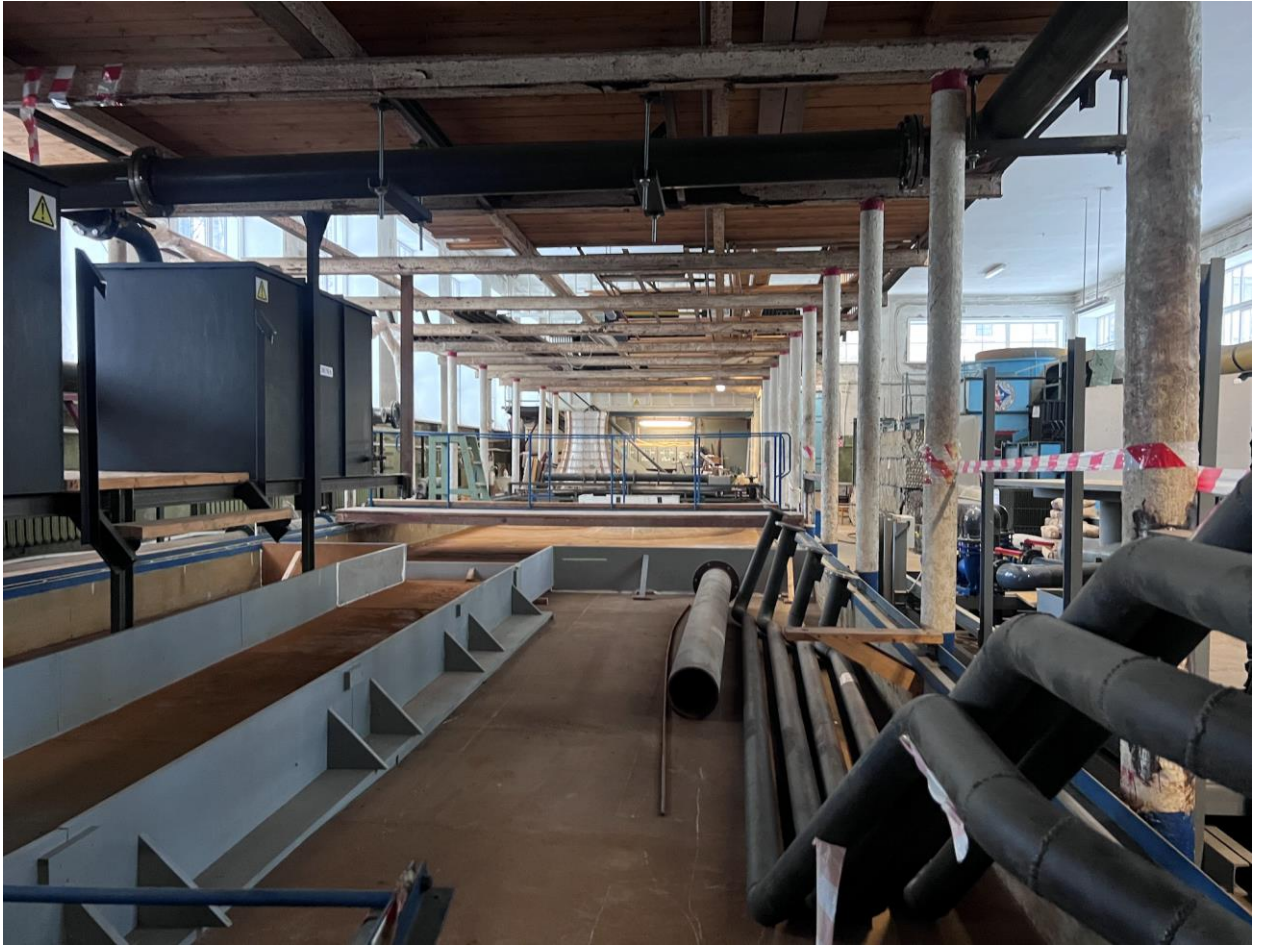
Фото 11. Объект культурного наследия регионального значения «Гидротехнический институт им. Б.Е. Веденеева (лицевой корпус с примыкающими дворовыми флигелями)», расположенный по адресу: г. Санкт Петербург, ул. Гжатская, д. 21, литера А. Помещение № 57. Фрагмент. Съёмка 27.04.2026 г.
