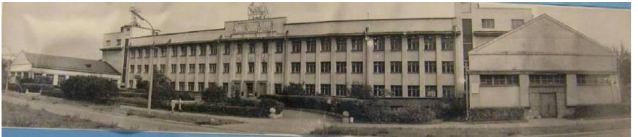
34. ВНИИГ им. Веденеева. Лицевой корпус. Фото 1971 г. По материалам музея ОАО ВНИИГ им. Б.Е. Веденеева
