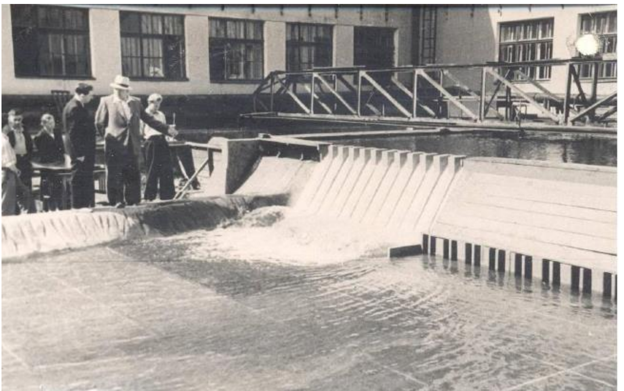
53. Проверка работы братской ГЭС по модели. Фото 1954-х гг. По материалам музея ОАО ВНИИГ им. Б.Е. Веденеева.
