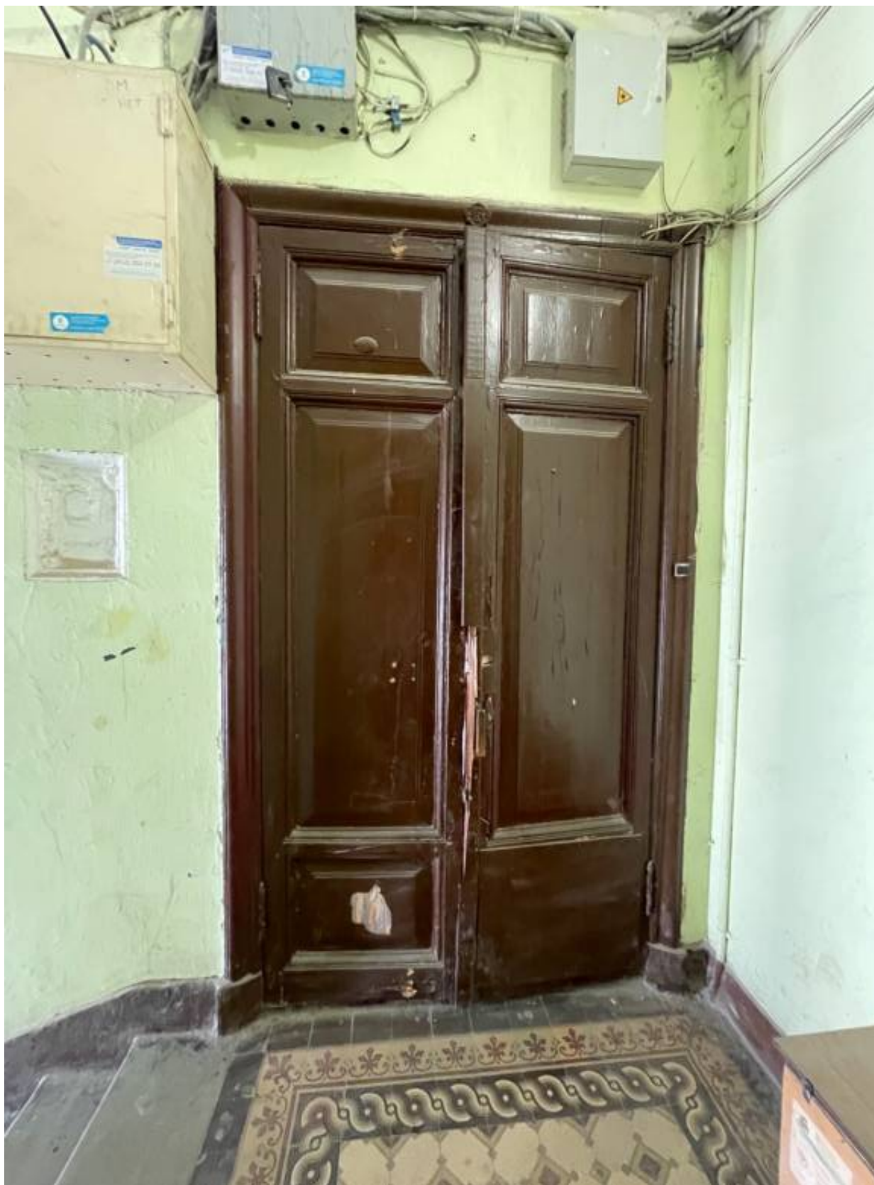
4. Общий вид входной двери со служебной лестницы.
