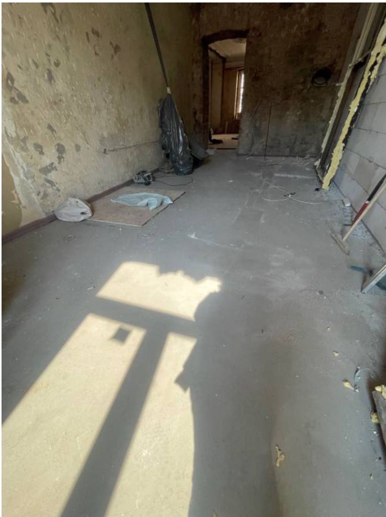
13. Балкон со стороны дворового фасада.
