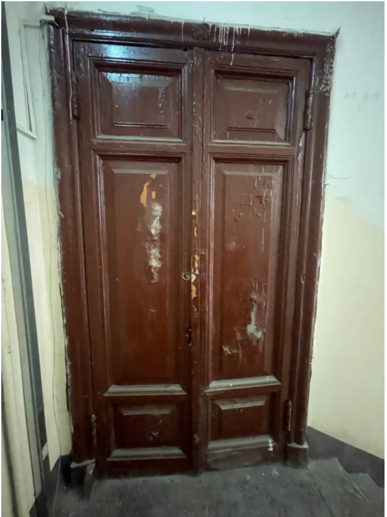
3. Общий вид входной двери со служебной лестницы.
