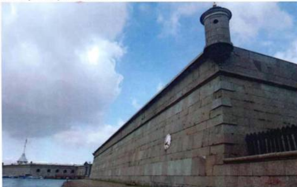
2. Эскарповый фасад. Вид с юга.
