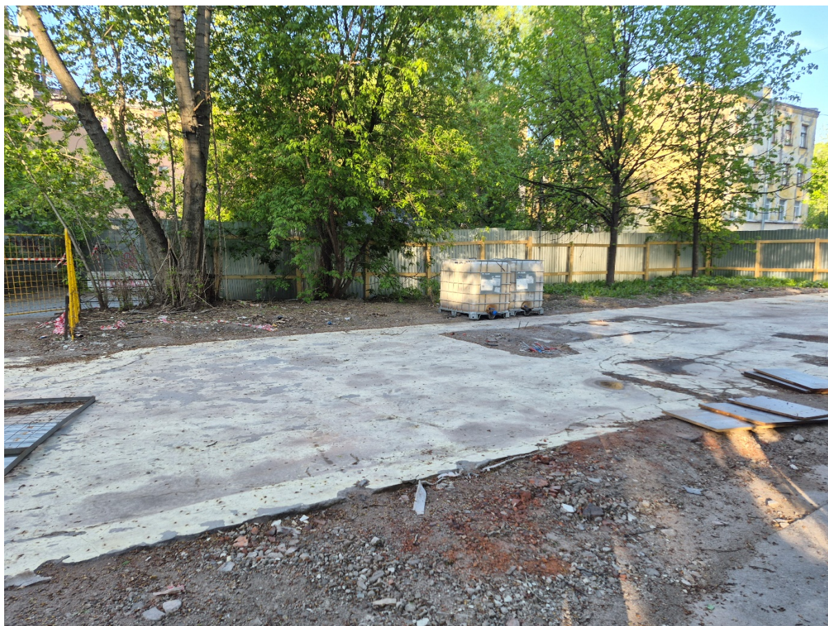
Рис. 23. Земельный участок под проектируемый Объект. Фотофиксация, май 2026 г. Вид на юго-восток.
