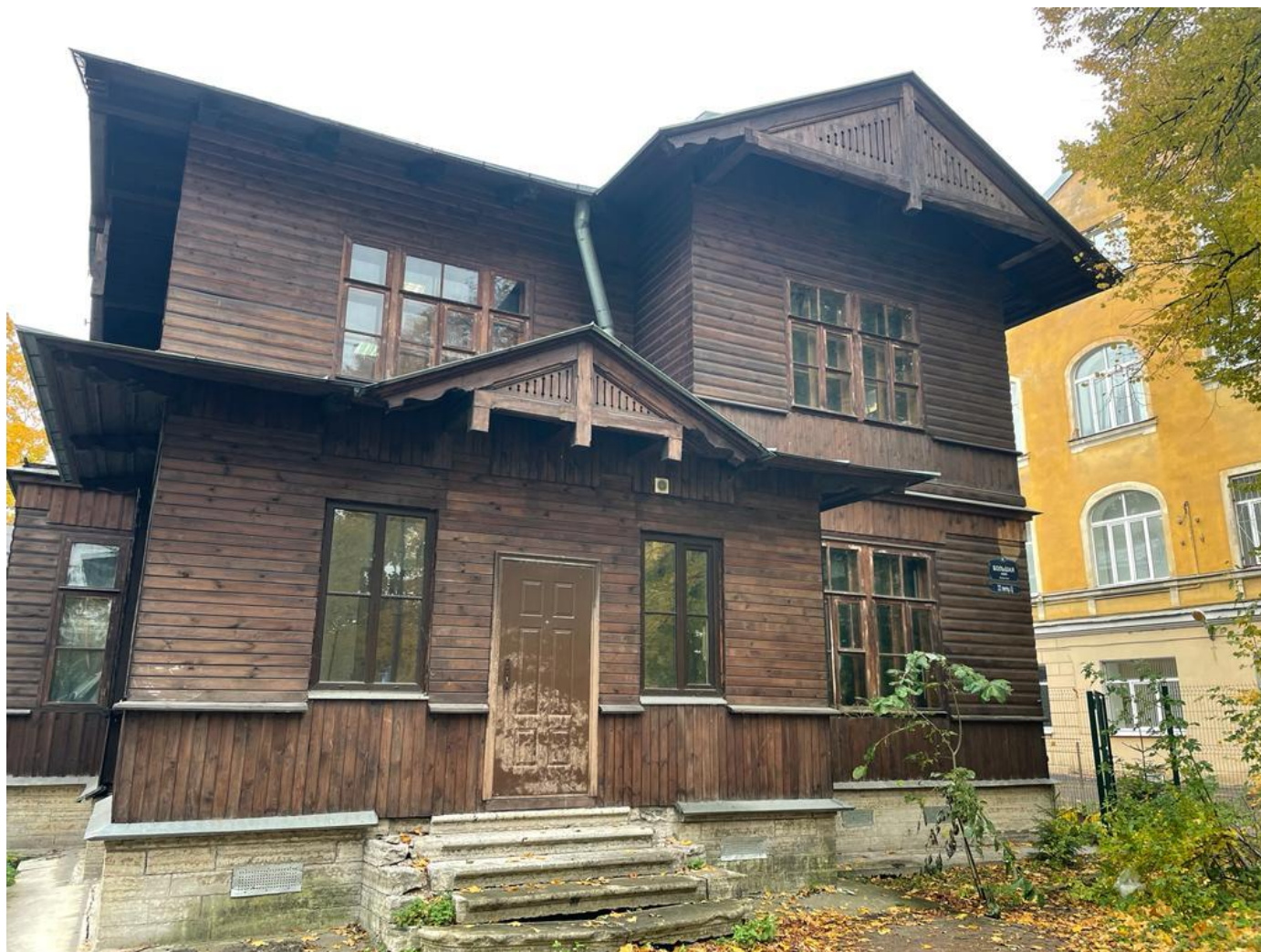
Фото № 1. Объект культурного наследия регионального значения «Жилой дом с участком парка и оградой», расположенный по адресу: г. Санкт-Петербург, ул. Большая аллея, д. 22, лит. «Ц». Фото Прокофьева М. Ф. (15.09.2025 г.)
