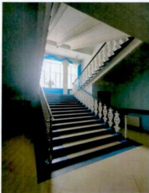
8. Центральная лестница, 1 этаж.
