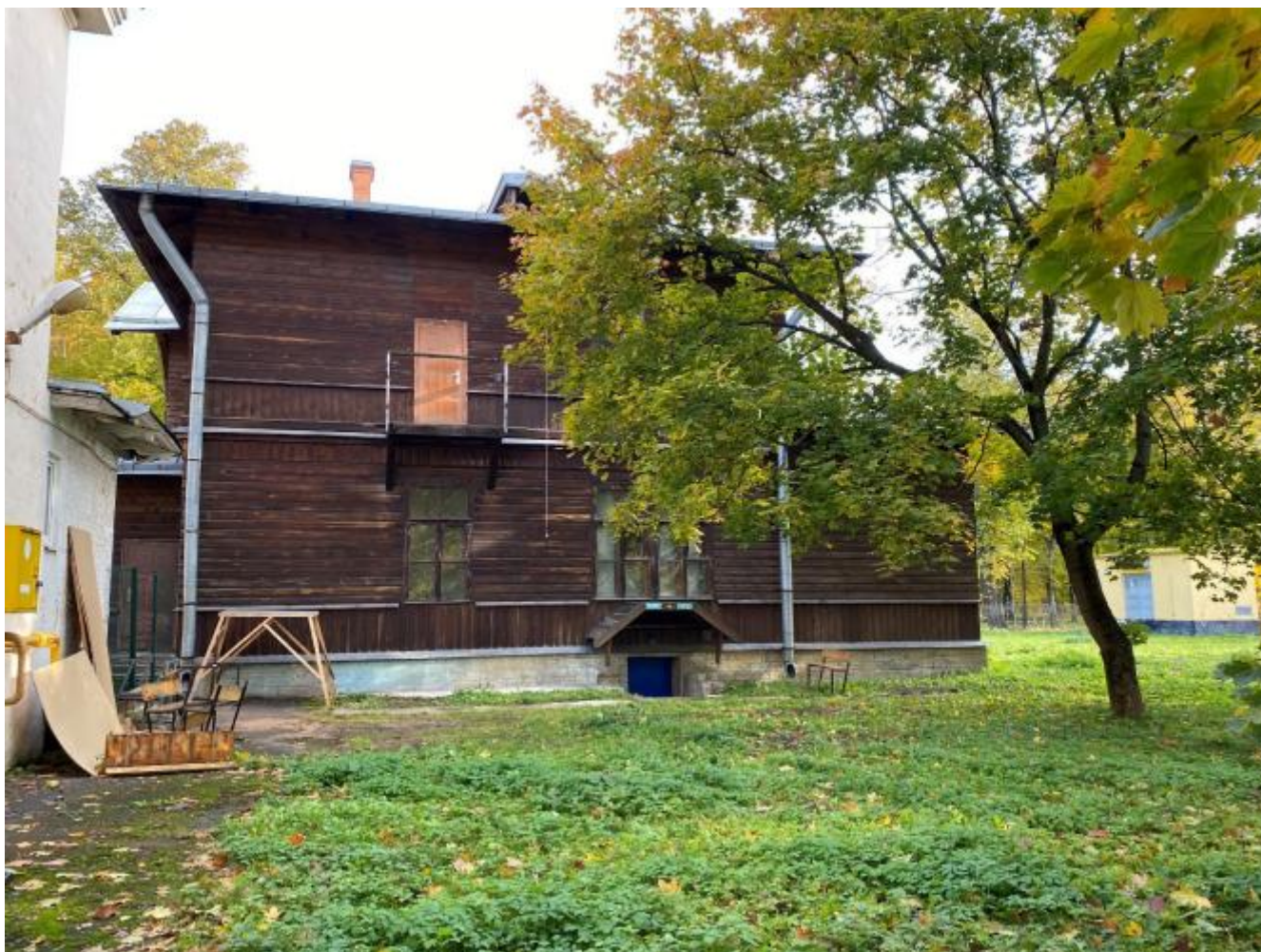
Фото № 2. Объект культурного наследия регионального значения «Жилой дом с участком парка и оградой», расположенный по адресу: г. Санкт-Петербург, ул. Большая аллея, д. 22, лит. «Ц». Фото Прокофьева М. Ф. (15.09.2025 г.)
