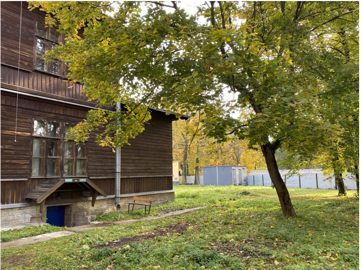
Фото № 3. Объект культурного наследия регионального значения «Жилой дом с участком парка и оградой», расположенный по адресу: г. Санкт-Петербург, ул. Большая аллея, д. 22, лит. «Ц». Фото Прокофьева М. Ф. (15.09.2025 г.)
