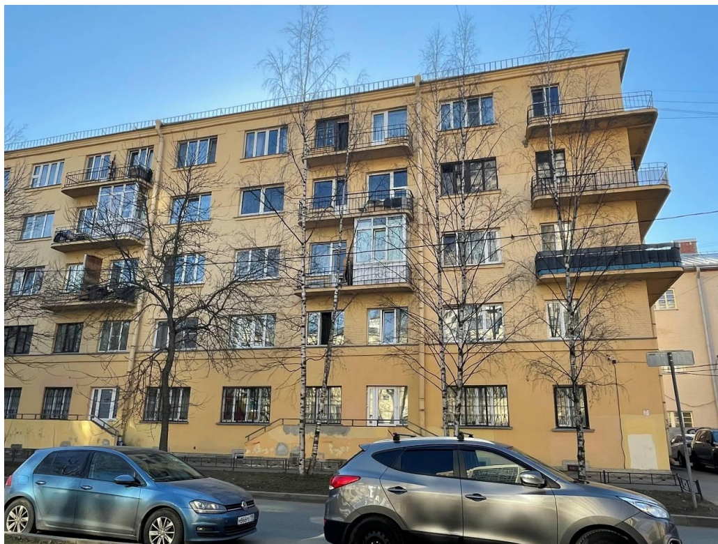
Фото 5. Фрагмент лицевого фасада объекта культурного наследия регионального значения «Жилой корпус», входящего в состав объекта культурного наследия регионального значения «Городок текстильщиков (жилой комплекс)»
