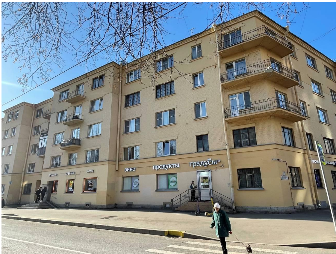
Фото 3. Фрагмент лицевого фасада объекта культурного наследия регионального значения «Жилой корпус», входящего в состав объекта культурного наследия регионального значения «Городок текстильщиков (жилой комплекс)»
