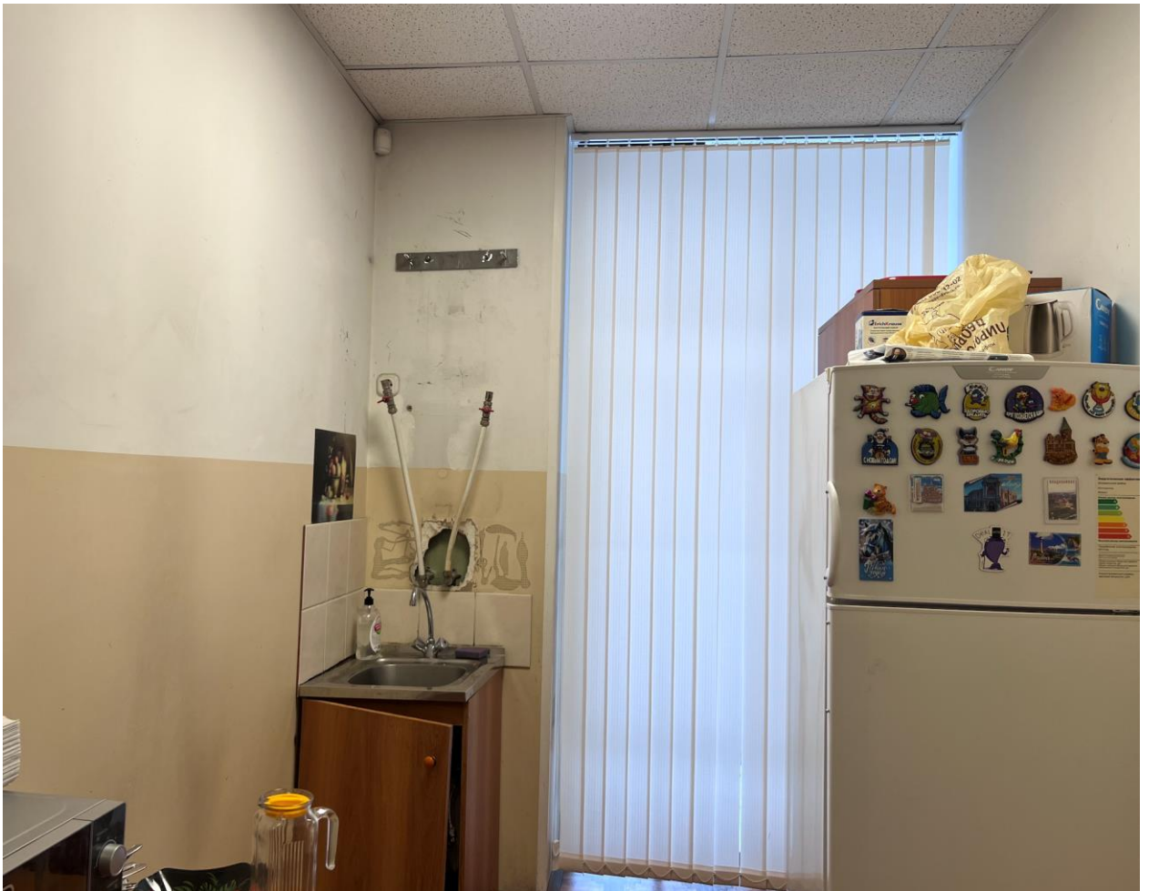
Фото 26. Объект культурного наследия регионального значения «Гидротехнический институт им. Б.Е. Веденеева (лицевой корпус с примыкающими дворовыми флигелями)», расположенный по адресу: Санкт-Петербург, Гжатская д. 21, лит. А. Помещение 182. Съёмка 01.04.2026 г.
