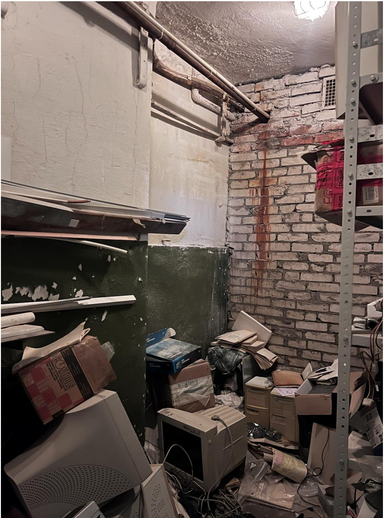
Фото 15. Объект культурного наследия регионального значения «Гидротехнический институт им. Б.Е. Веденеева (лицевой корпус с примыкающими дворовыми флигелями)», расположенный по адресу: Санкт-Петербург, Гжатская д. 21, лит. А. Помещение 145. Съёмка 01.04.2026 г.
