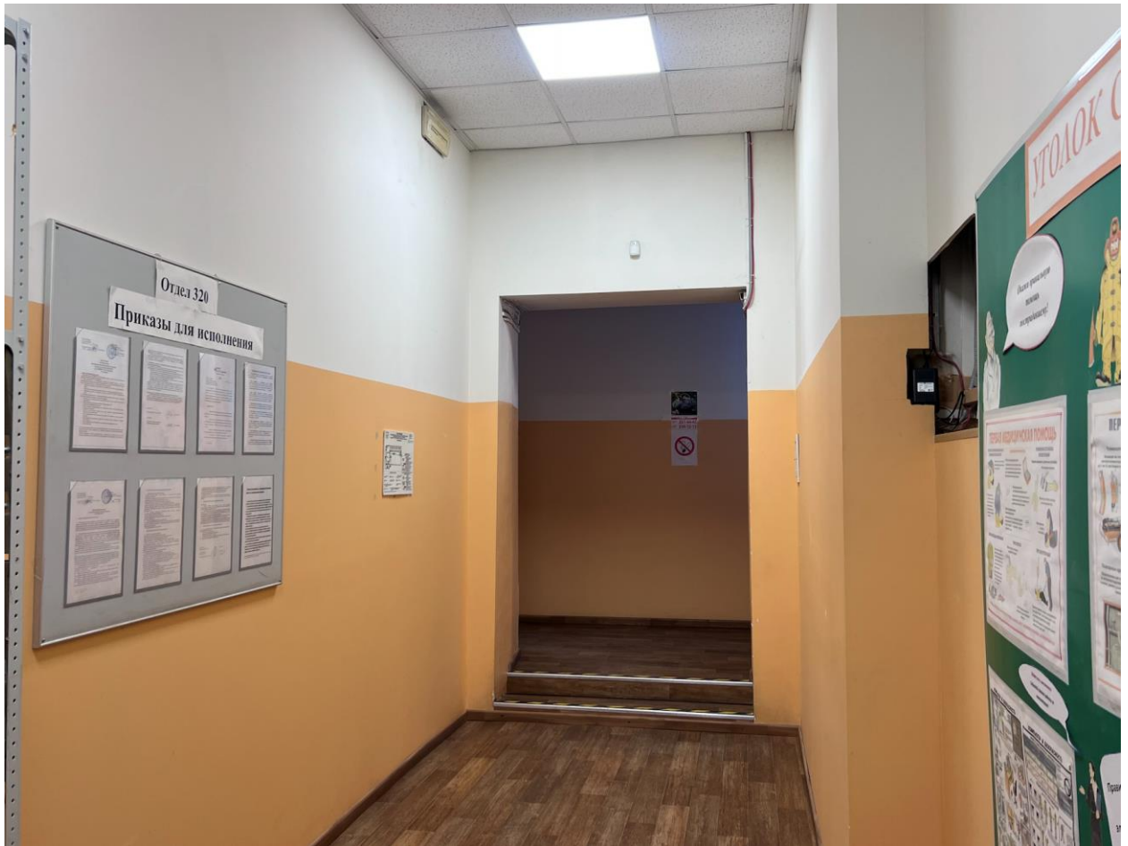
Фото 3. Объект культурного наследия регионального значения «Гидротехнический институт им. Б.Е. Веденеева (лицевой корпус с примыкающими дворовыми флигелями)», расположенный по адресу: Санкт-Петербург, Гжатская д. 21, лит. А. Помещение 180. Съёмка 01.04.2026 г.
