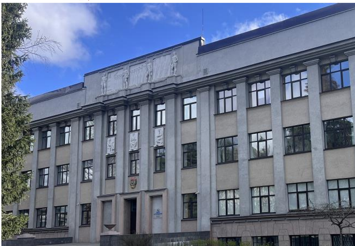
Фото 1. Объект культурного наследия регионального значения «Гидротехнический институт им. Б.Е. Веденеева (лицевой корпус с примыкающими дворовыми флигелями)», расположенный по адресу: Санкт-Петербург, Гжатская д. 21, лит. А. Лицевой фасад. Фрагмент. Съёмка 01.04.2026 г.
