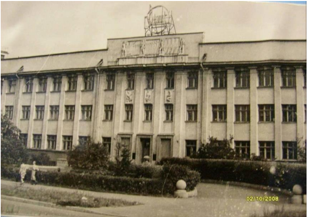
35. ВНИИГ им. Веденева. Лицевой корпус. Фото 1960-х.гг. По материалам музея ОАО ВНИИГ им. Б.Е. Веденева
