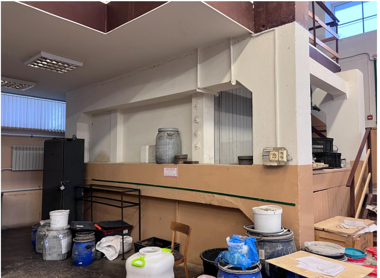
Фото 7. Объект культурного наследия регионального значения «Гидротехнический институт им. Б.Е. Веденеева (лицевой корпус с примыкающими дворовыми флигелями)», расположенный по адресу: Санкт-Петербург, Гжатская д. 21, лит. А. Помещение 143. Съёмка 01.04.2026 г.
