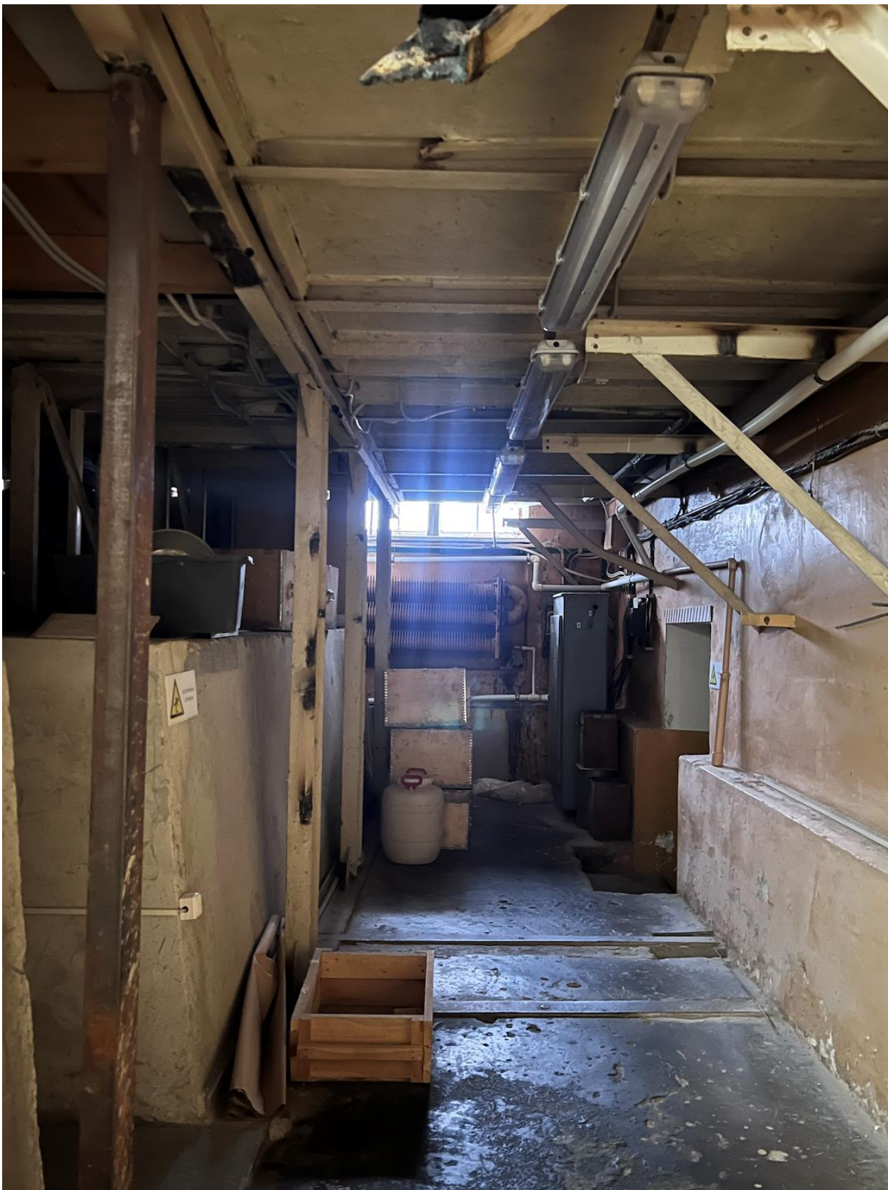
Фото 12. Объект культурного наследия регионального значения «Гидротехнический институт им. Б.Е. Веденеева (лицевой корпус с примыкающими дворовыми флигелями)», расположенный по адресу: Санкт-Петербург, Гжатская д. 21, лит. А. Помещение 143. Съёмка 01.04.2026 г.
