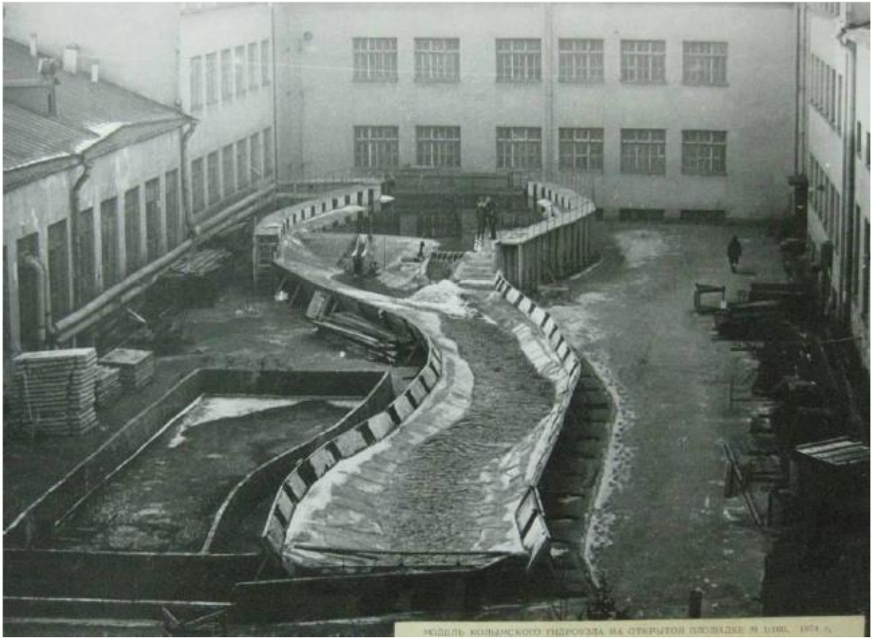
56. Проверка работы братской ГЭС по модели. Фото 1954-х гг. По материалам музея ОАО ВНИИГ им. Б.Е. Веденеева.
