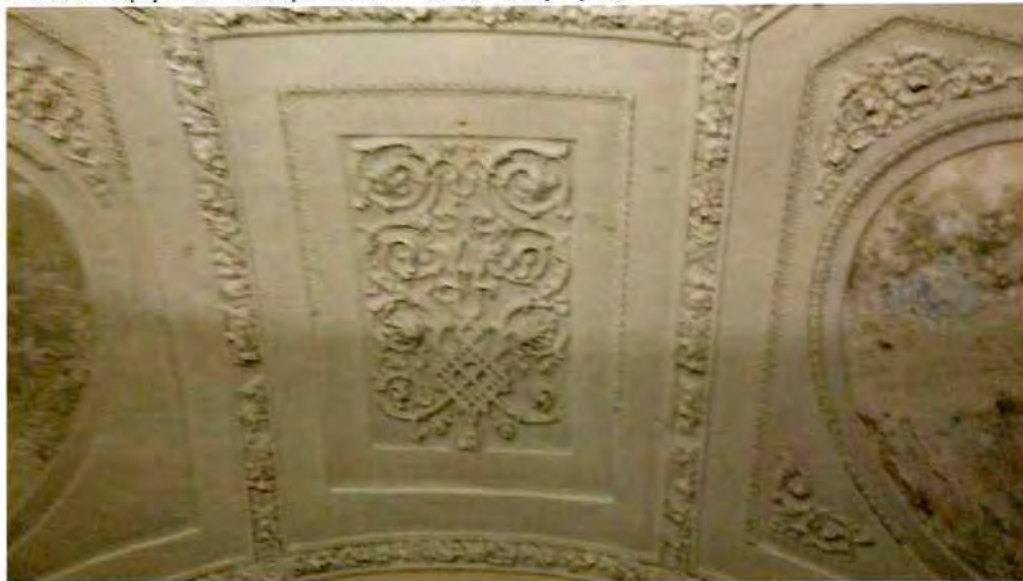
7. Лепное оформление исторического сводчатого перекрытия.
