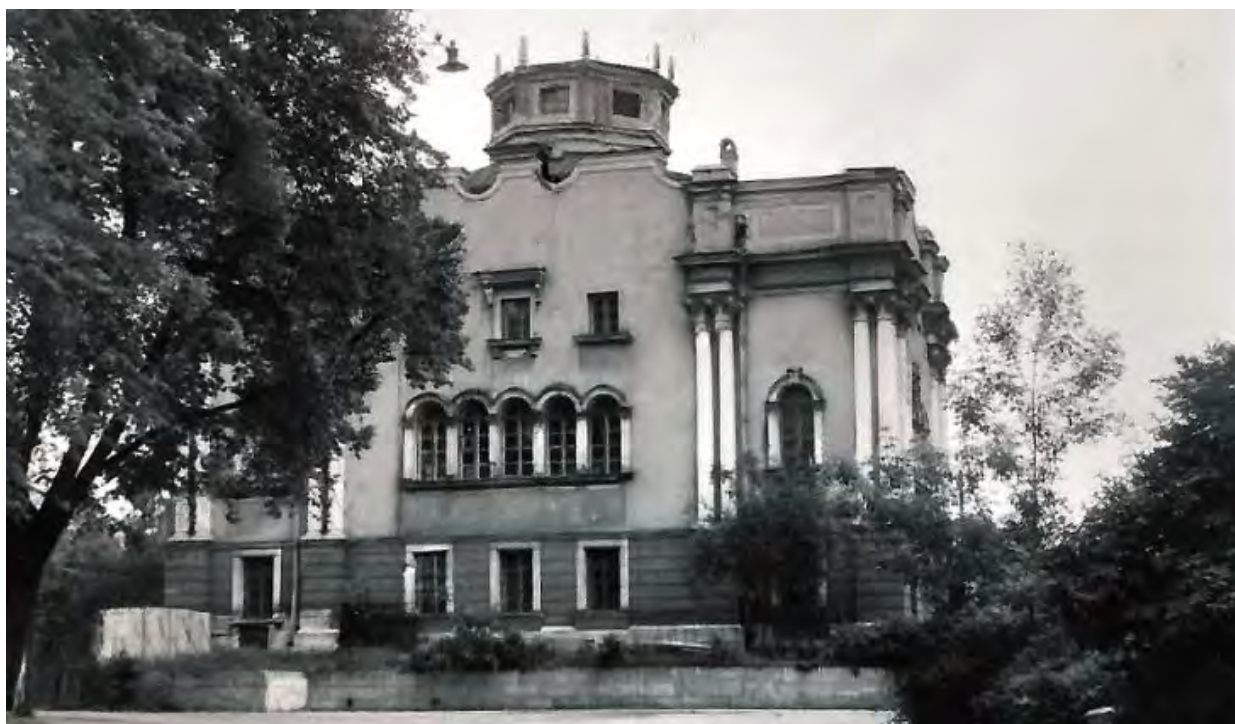
Илл.10. Фото 1976 г. Здание лаборатории электроакустики СПбГЭТУ "ЛЭТИ". Retro View of Mankind's Habitat [Электронный ресурс]. Режим доступа: https://pastvu.com/ .
