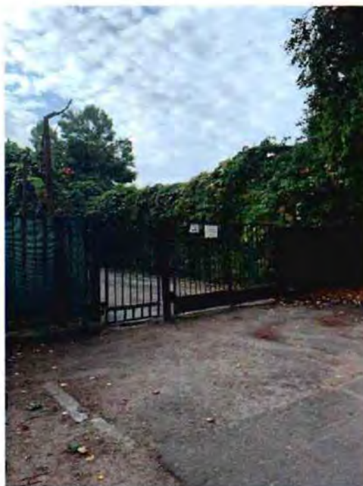
29. Фрагмент ограды объекта культурного наследия с северной стороны (фото от 13.09.2023).
