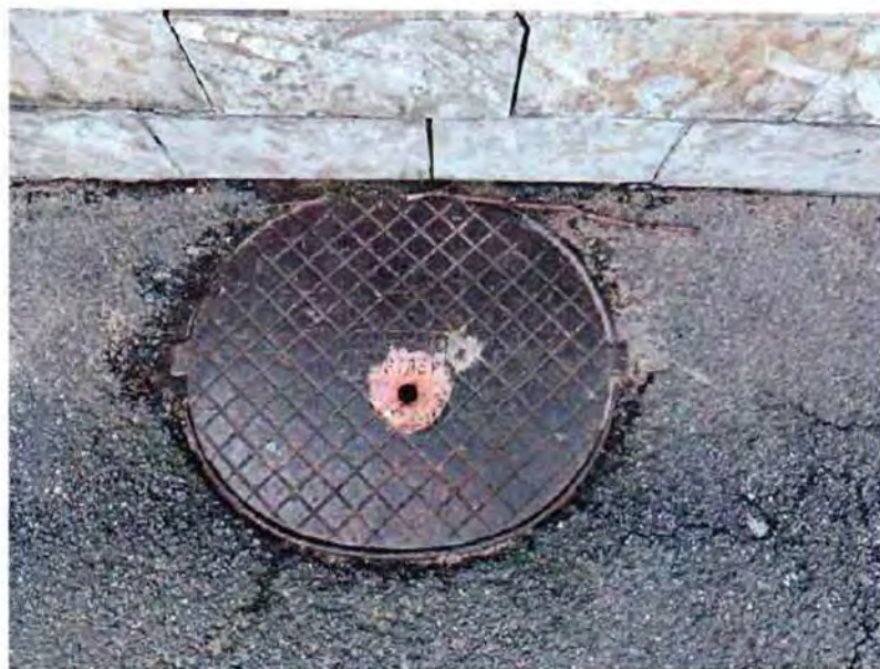
24. Крышка канализационного колодца в западной части объекта культурного наследия (фото от 25.08.2023).
