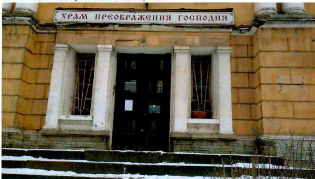
8. Вход в здание со стороны юго-западного фасада.
