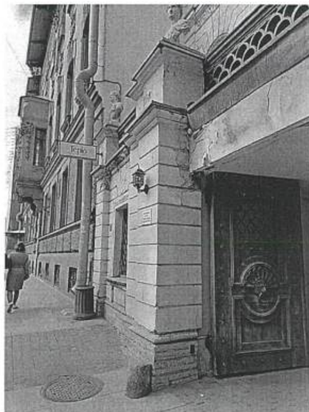
5. Фрагмент восточного фасада объекта культурного наследия, металлические дверные заполнения
