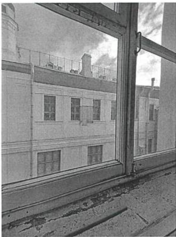
10. Профилированные венчающие карнизы закрыты строительной сеткой
