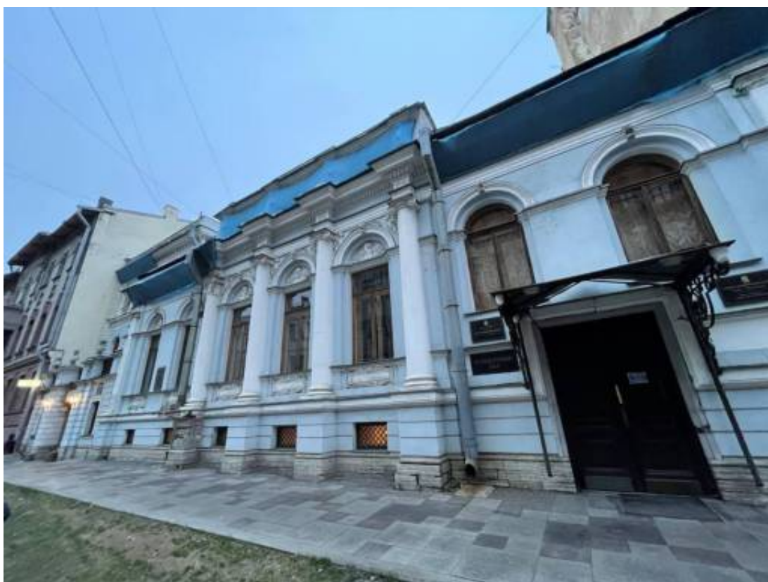
Фото 2. Лицевой фасад объекта культурного наследия федерального значения «Дом Демидова П.Н. (Гагариной В.Ф.)»
