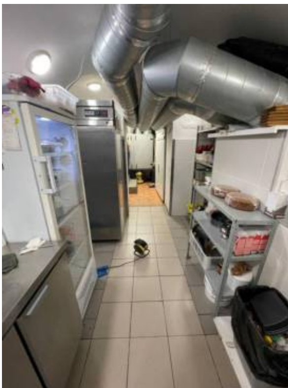
Фото 37. Интерьер пом. 2-Н объекта культурного наследия федерального значения «Дом Демидова П.Н. (Гагариной В.Ф.)»
