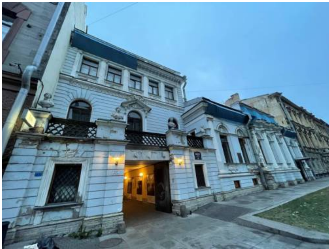
Фото 1. Лицевой фасад объекта культурного наследия федерального значения «Дом Демидова П.Н. (Гагариной В.Ф.)»
