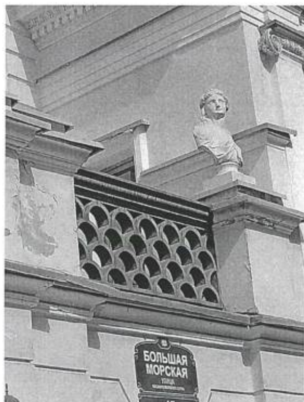
4. Восточный лицевой фасад объекта культурного наследия
