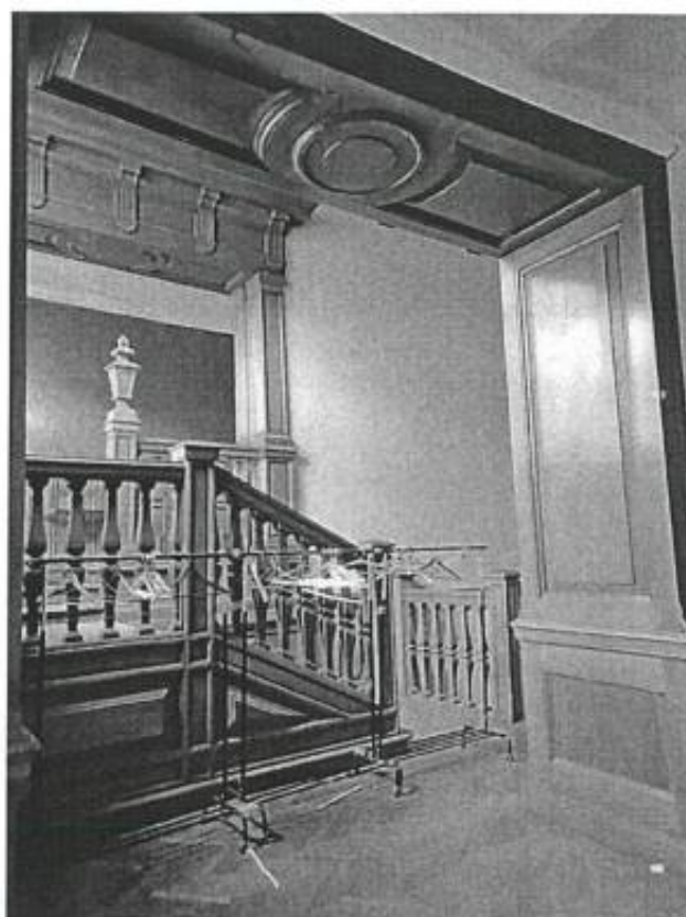
23. Проем оформленный деревянными филенками
