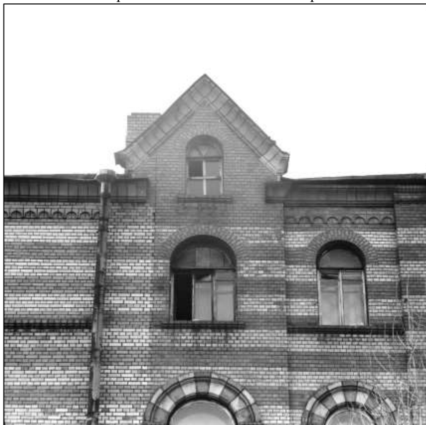
27. Восточная часть фасада. Видна граница разновременных объемов. Фотография 1990г. Архив Иоанновского монастыря.
