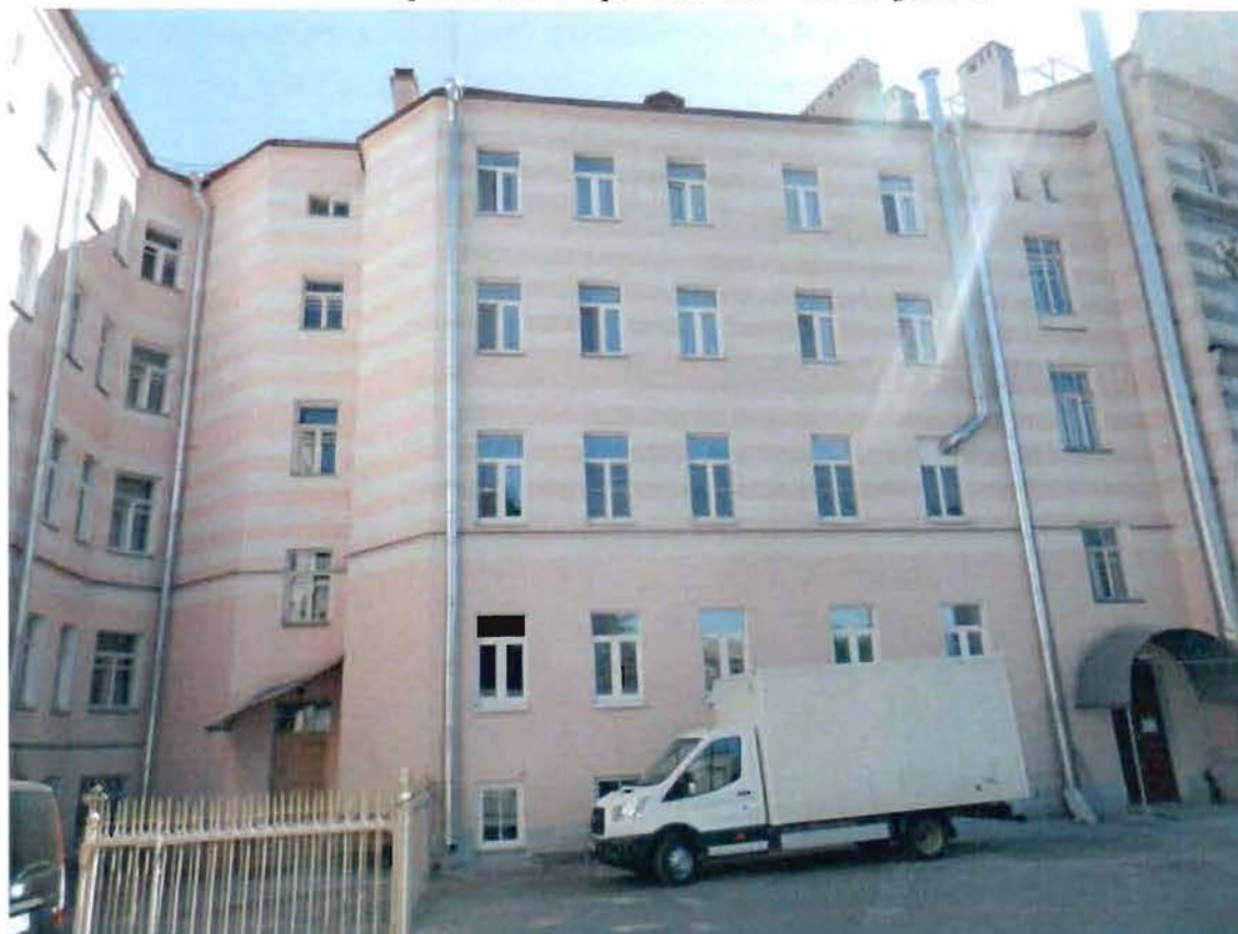
7. Фрагмент северо-западной части фасада
