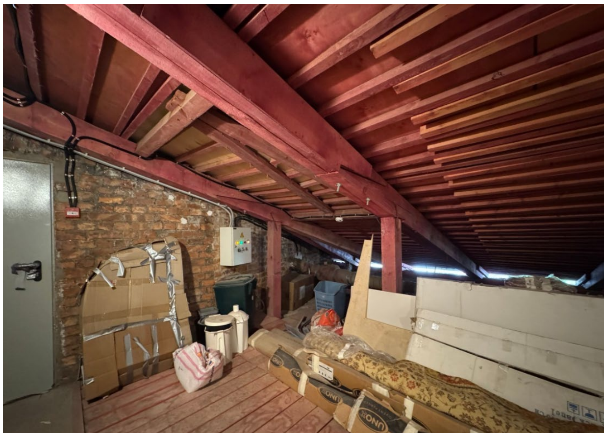
19. Объект культурного наследия регионального значения «Иоанновский монастырь с часовней, садом и оградой», расположенного по адресу: Санкт-Петербург, набережная реки Карповки, дом 45, литеры А, Д (наб. р. Карповки, 45). Общий вид стропильной системы крыши. Дата фотофиксации: 22.05.2026
