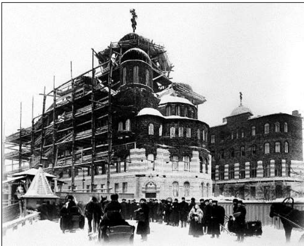
15. Иоанновский первоклассный женский монастырь (наб.р.Карповки,45). Строительство церкви Двенадцати апостолов. Фото К.Буллы.1998г.(?) СПб ЦГА КФД . Шифр Е 705
