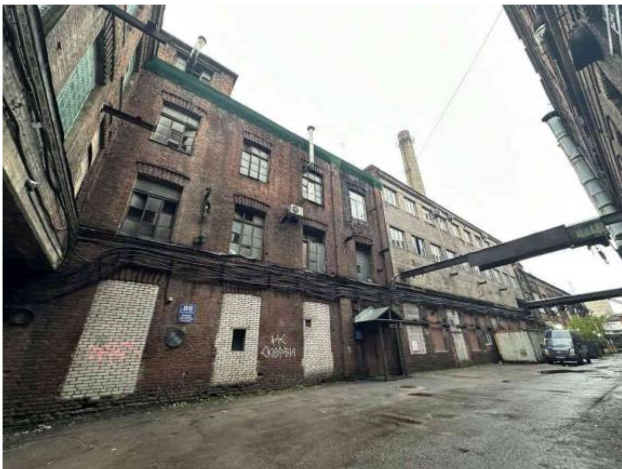
Фото 8. Общий вид здания
