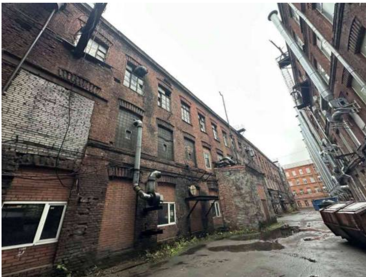
Фото 22. Общий вид здания.
