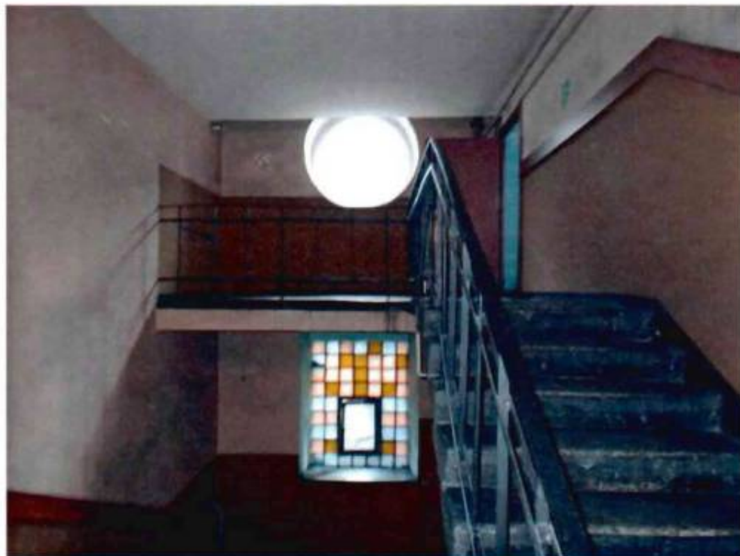
12. Лестница 2ЛК объекта культурного наследия
