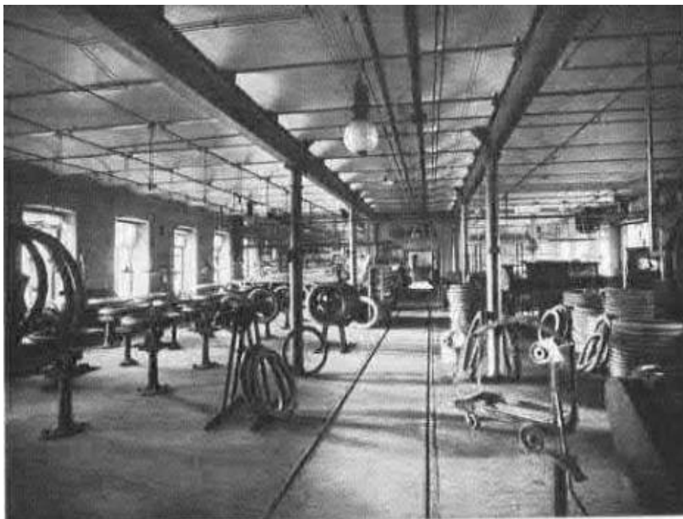
Мастерская для изготовления пневматических шин для автомобилей, экипажей и велосипедов. Альбом в память пятидесятилетия существования товарищества Российско-Американской резиновой мануфактуры под фирмой «Треугольник» в Санкт-Петербурге. СПб., 1910.
