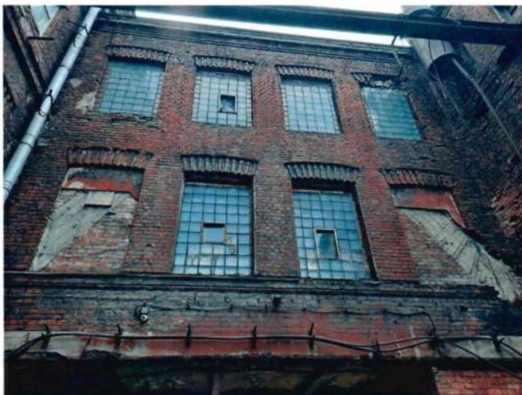
9. Северный фасад перехода-галереи со стороны западного фасада объекта культурного наследия
