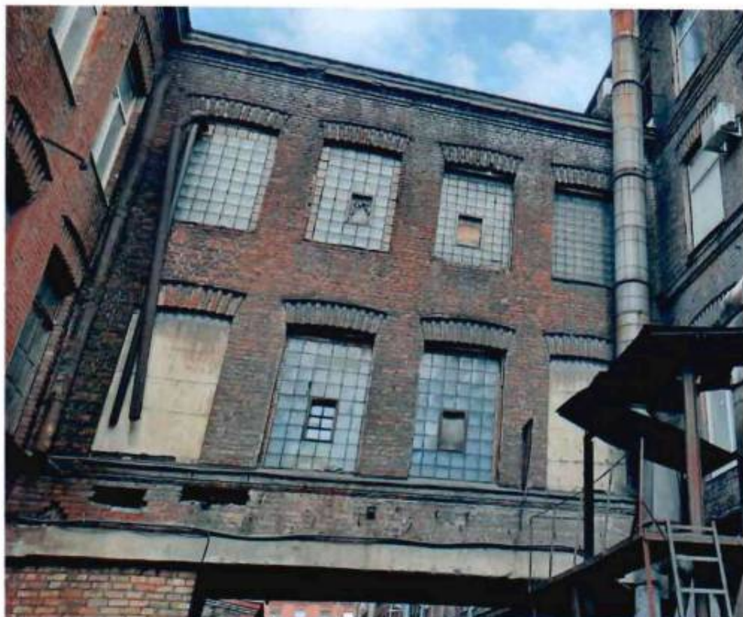
10. Южный фасад перехода-галереи со стороны западного фасада объекта культурного наследия
