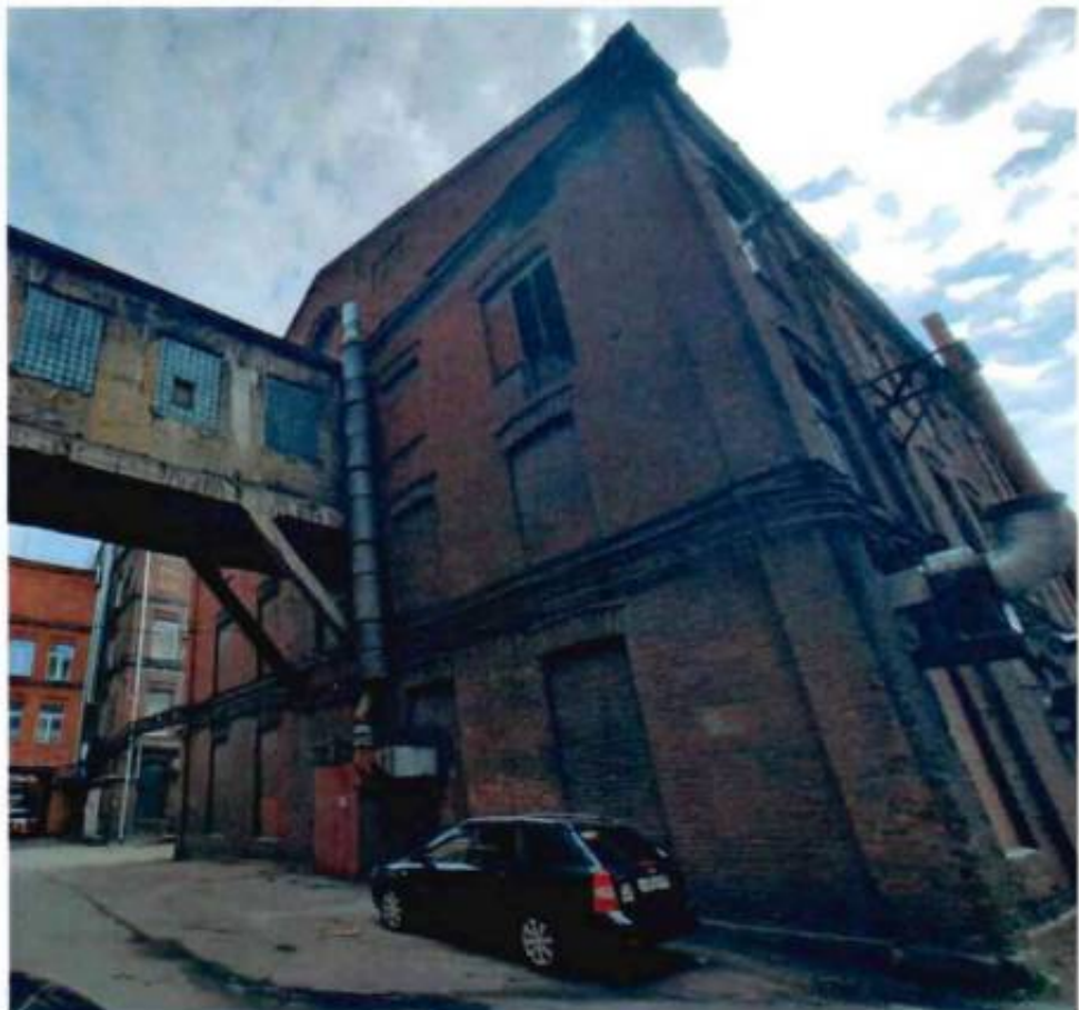
5. Общий вид на северный фасад объекта культурного наследия
