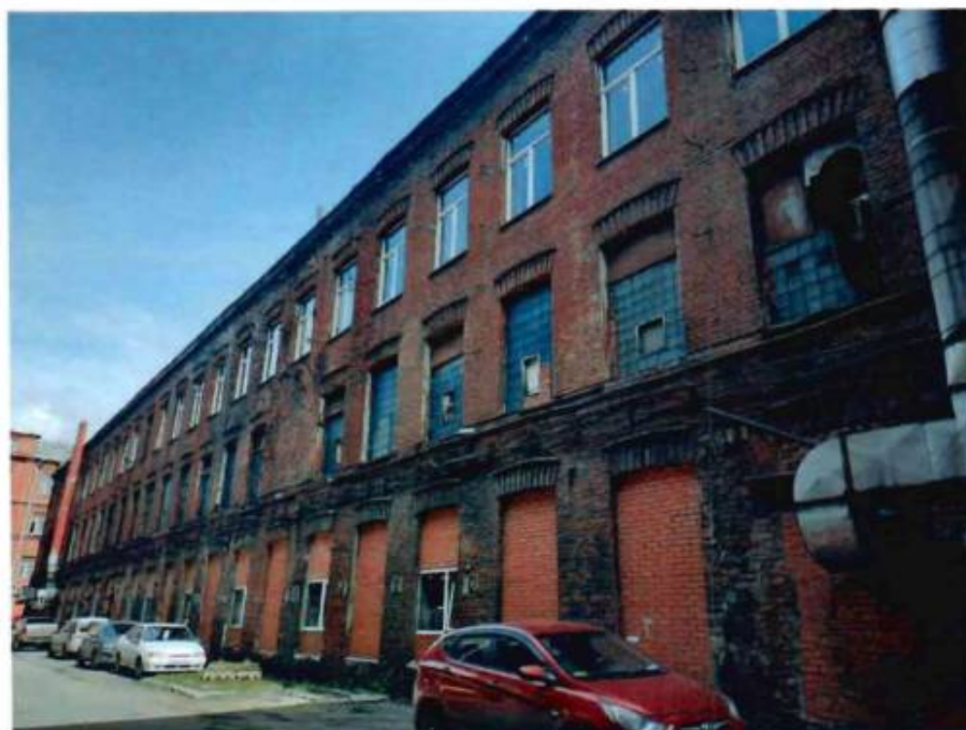
1. Фрагмент западного фасада объекта культурного наследия
