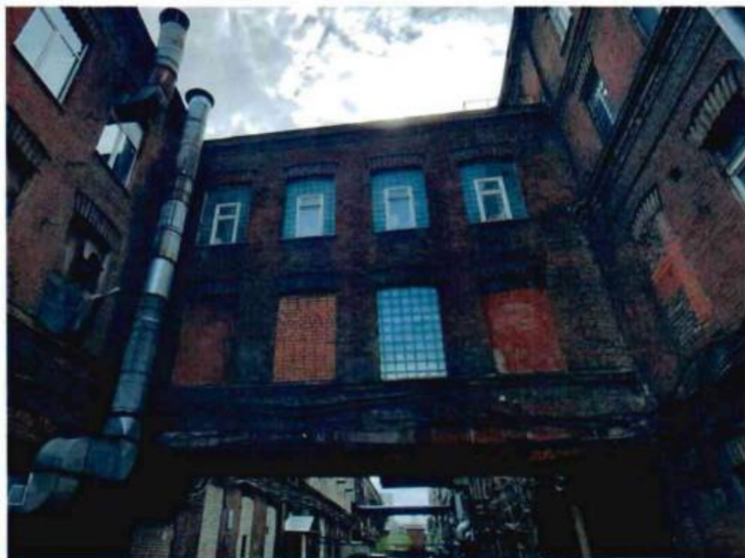
3. Северный фасад перехода-галереи со стороны западного фасада объекта культурного наследия
