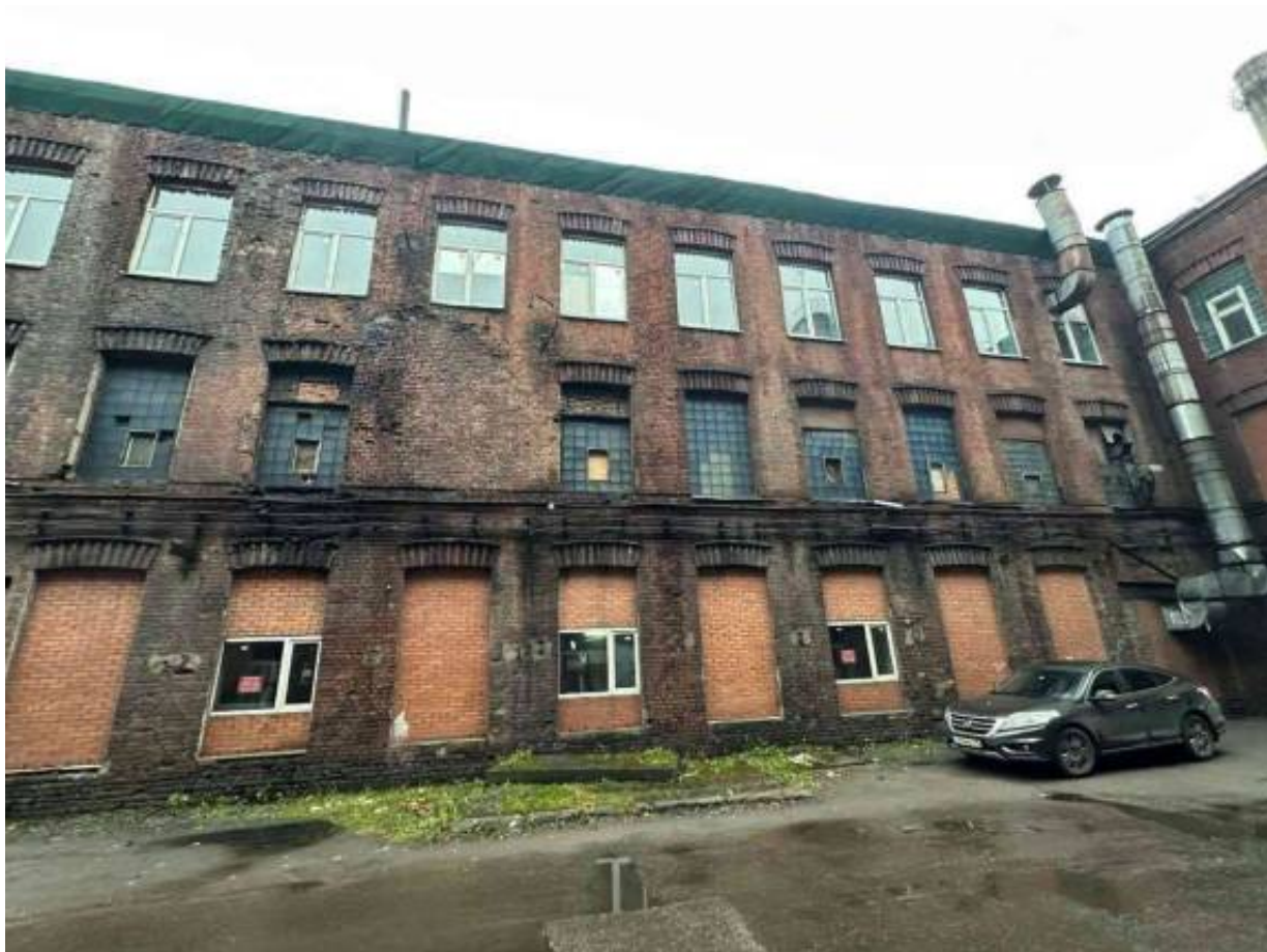
Фото 5. Общий вид здания
