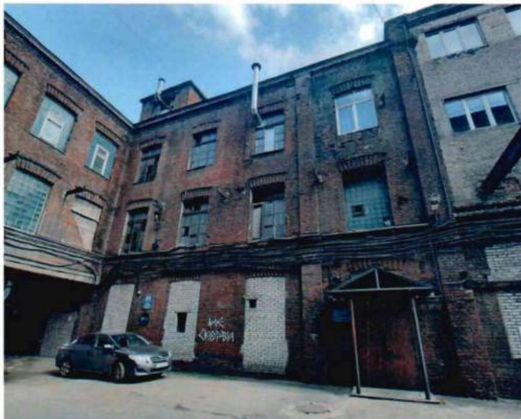
2. Фрагмент западного фасада объекта культурного наследия
