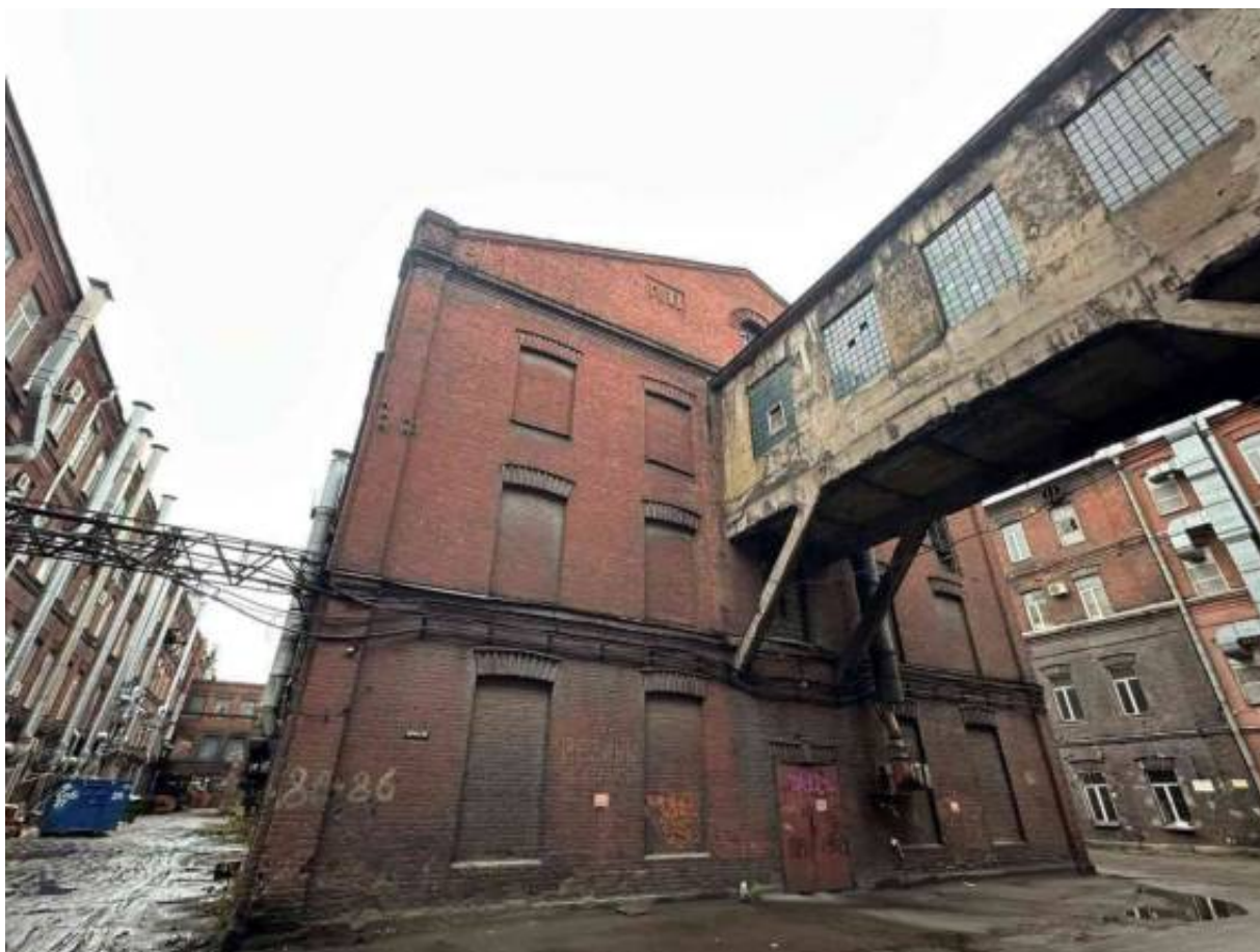
Фото 12. Общий вид здания.
