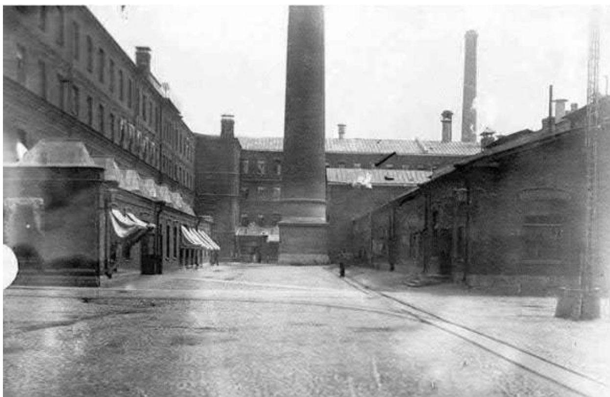
Илл. 15. 1910г. Альбом в память пятидесятилетия существования товарищества Российско-Американской резиновой мануфактуры под фирмою «Треугольник» в Санкт-Петербурге. СПб., 1910. Вид внутреннего фабричного двора. (совр. корпус 63 слева, 54 по центру на заднем плане, далее 58 и 59 – справа крайний)
