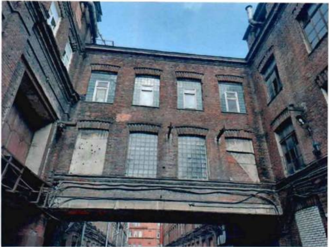
4. Южный фасад перехода-галереи со стороны западного фасада объекта культурного наследия
