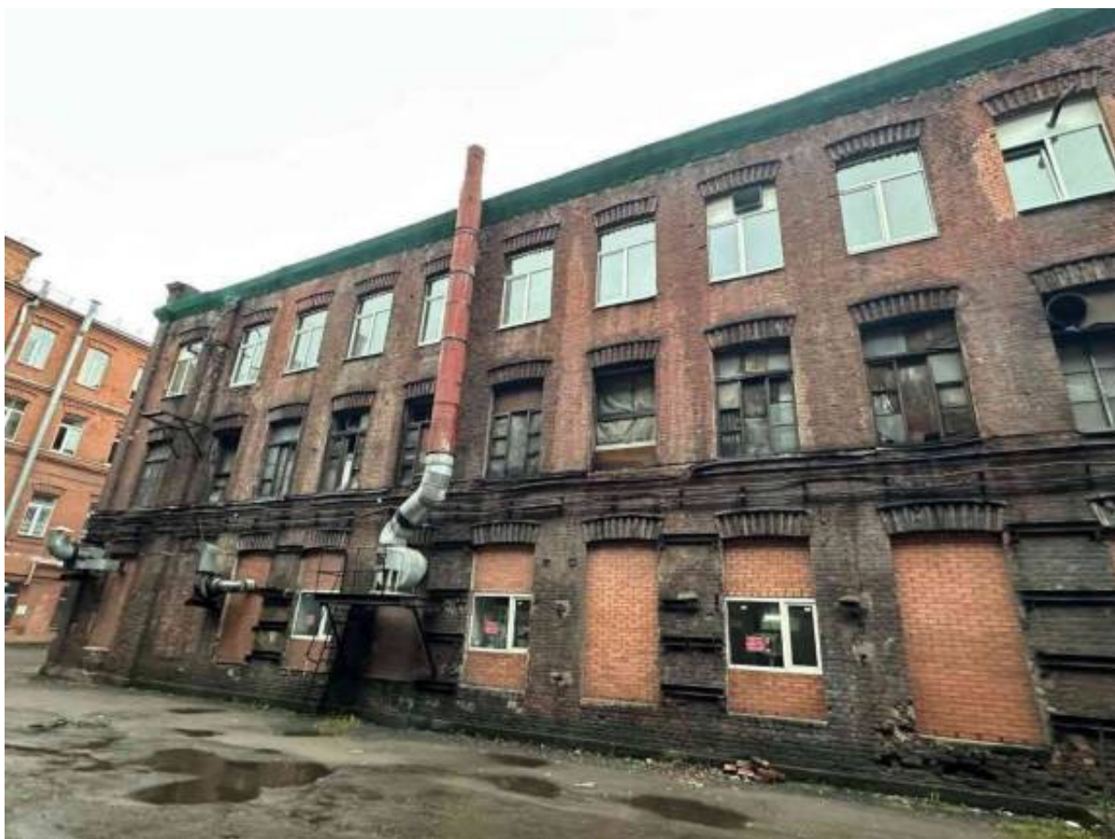
Фото 2. Общий вид здания
