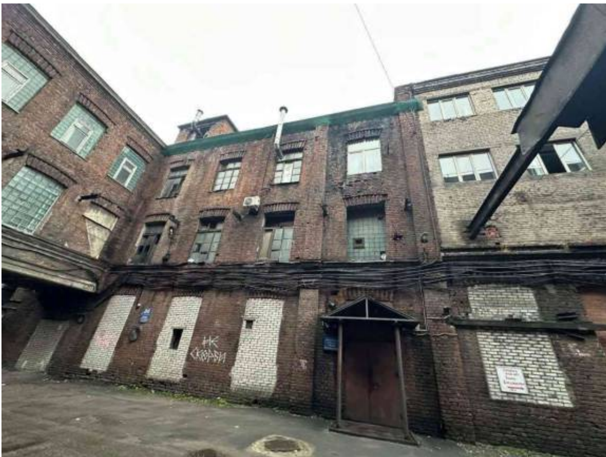
Фото 9. Общий вид здания.
