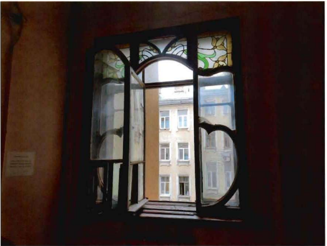
11. Интерьеры объекта культурного наследия. Помещения парадной лестницы 1ЛК
