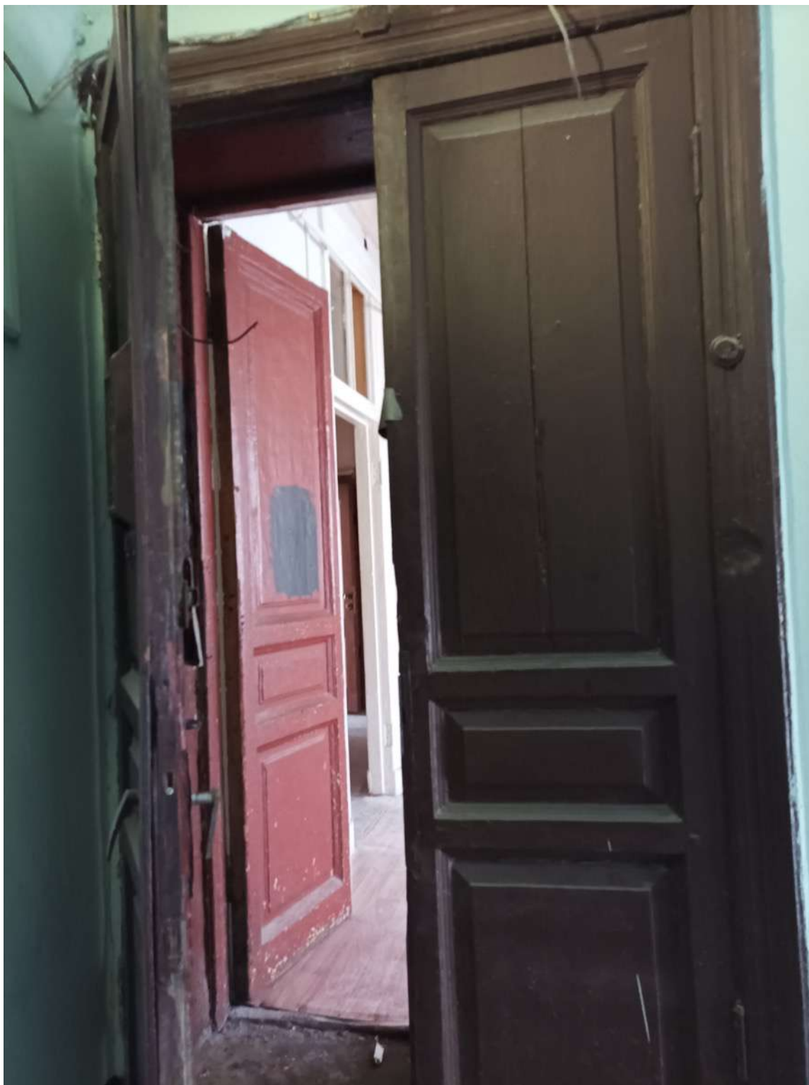
42. Дверь в квартиру №13
