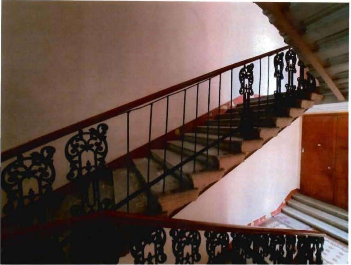
10. Интерьеры объекта культурного наследия. Помещения парадной лестницы 1ЛК
