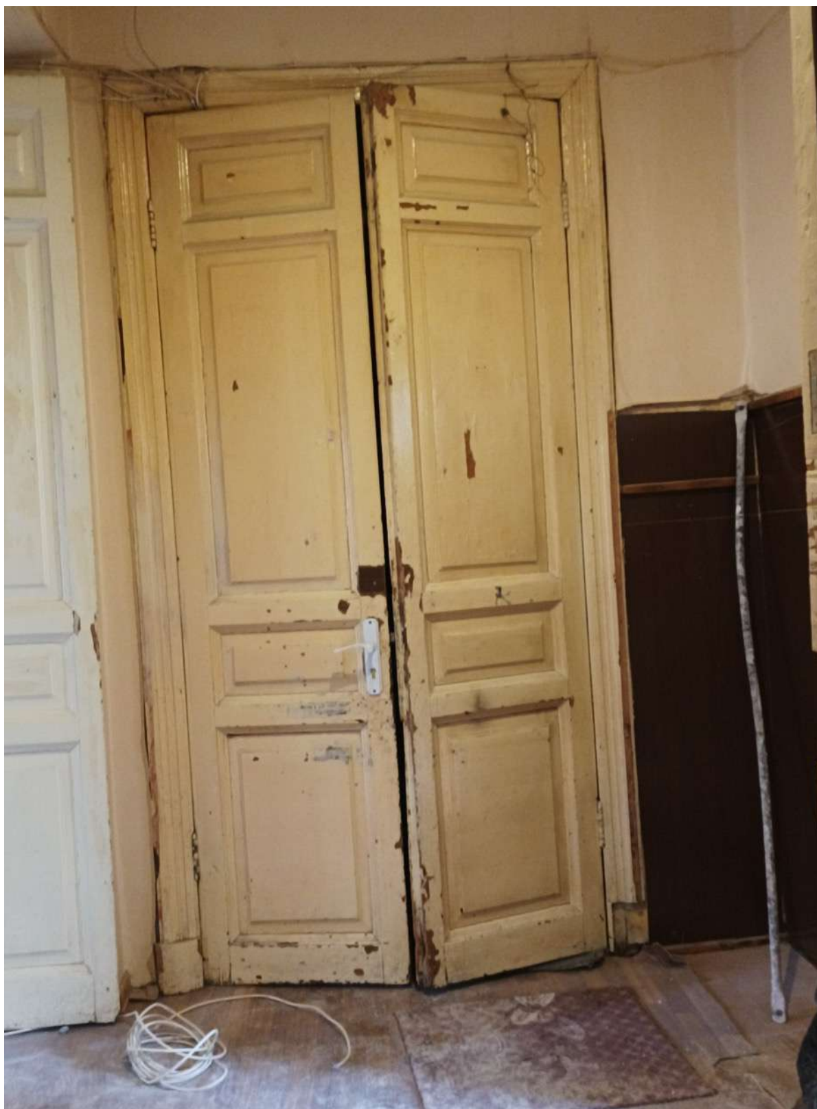
23. Дверь в квартиру №13
