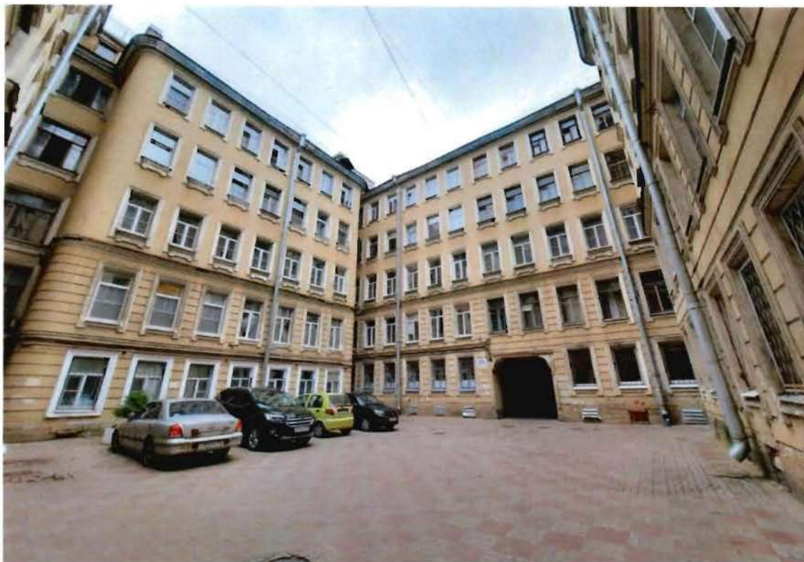
2. Общий вид на северный внутренний двор объекта культурного наследия (юго-восточный и юго-западный фасады)
