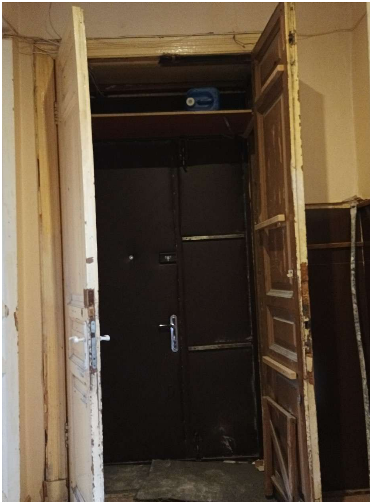
22. Дверь в квартиру №13
