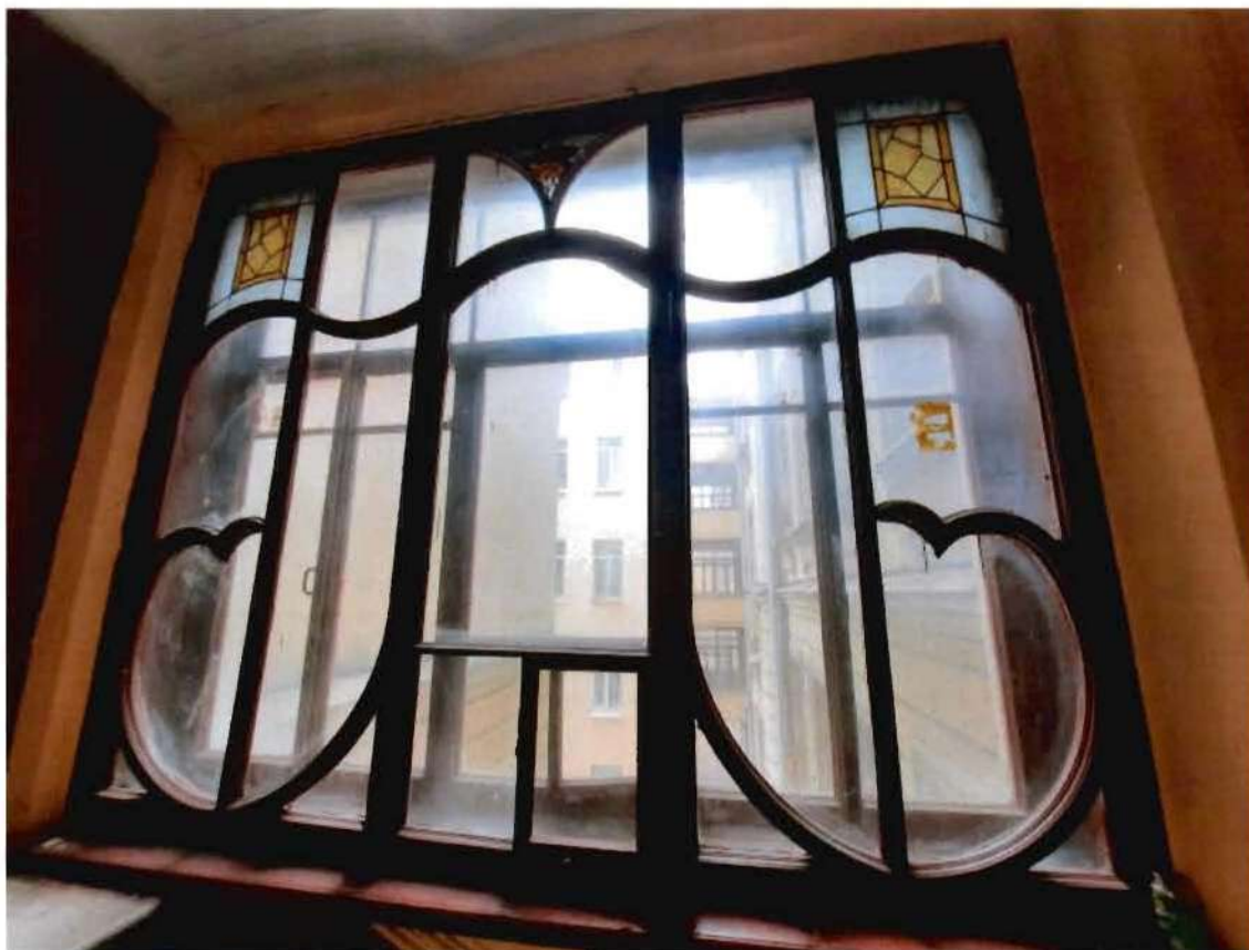
14. Интерьеры объекта культурного наследия. Помещения парадной лестницы 2ЛК
