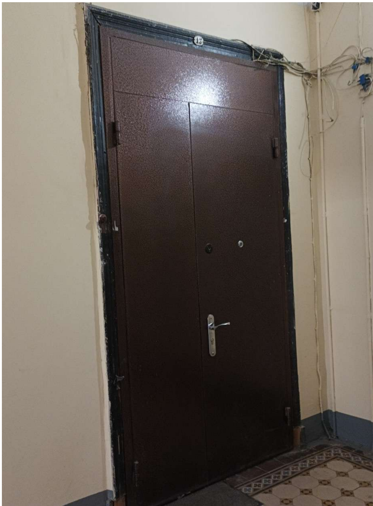
21. Дверь в квартиру №13
