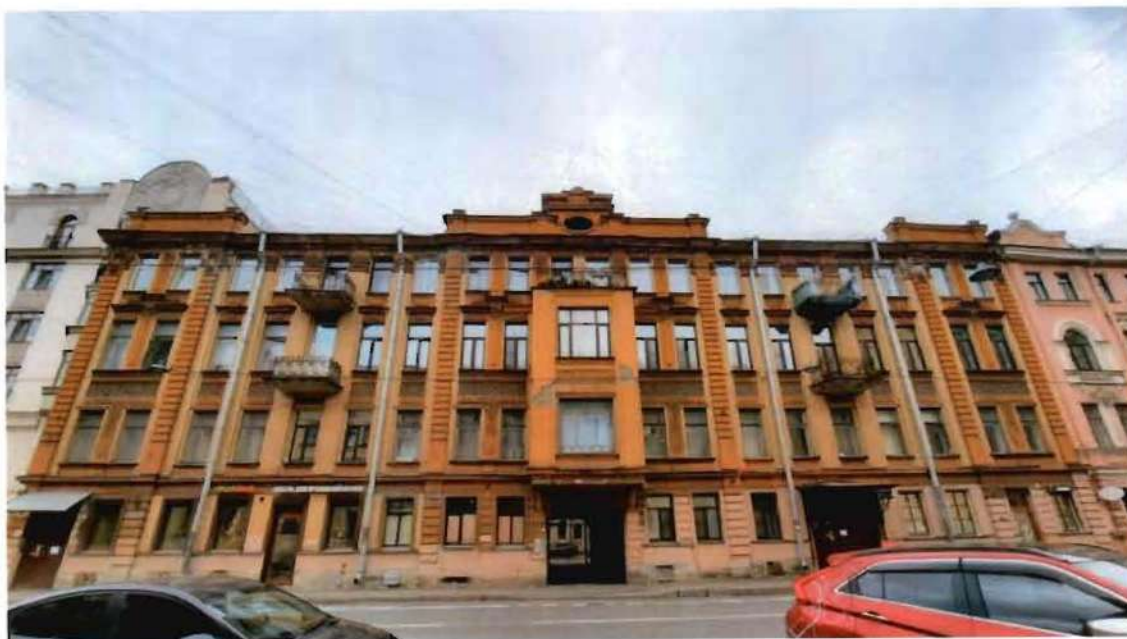
1. Общий вид на северо-восточный фасад объекта культурного наследия
