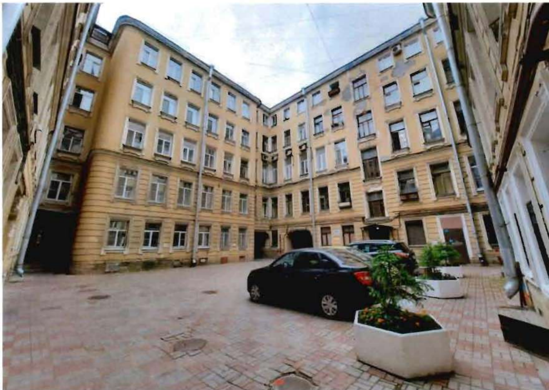
3. Общий вид на северный внутренний двор объекта культурного наследия (северо-восточный и северо-западный фасады)
