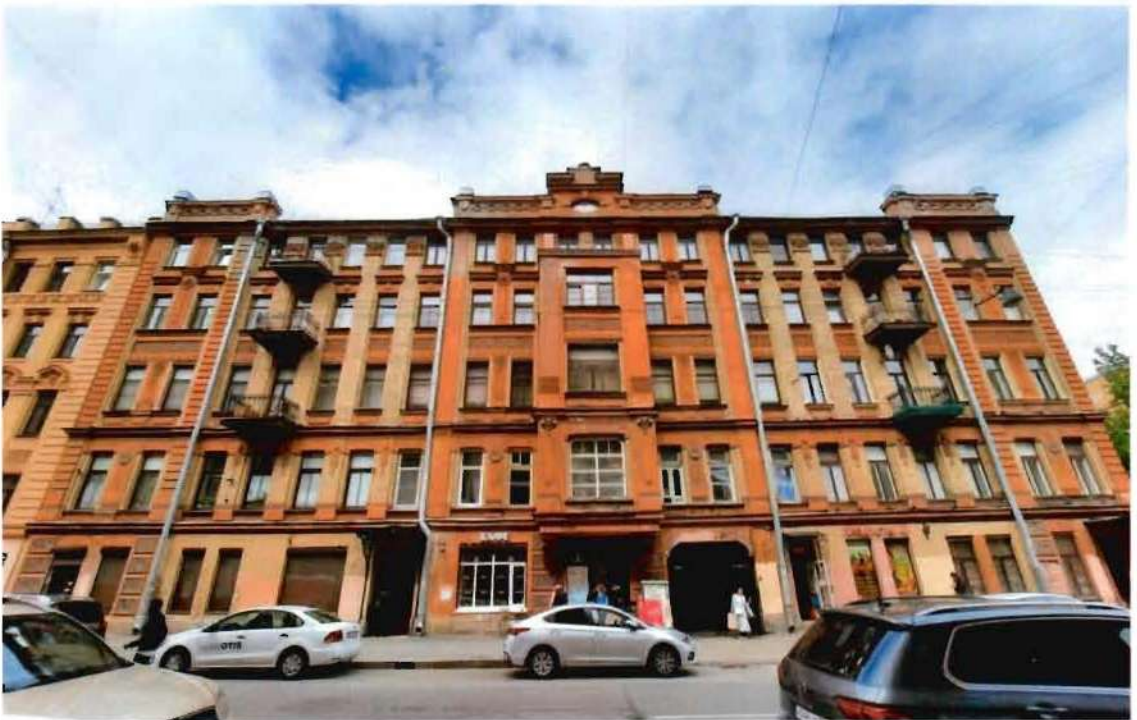
7. Общий вид на юго-западный фасад объекта культурного наследия
