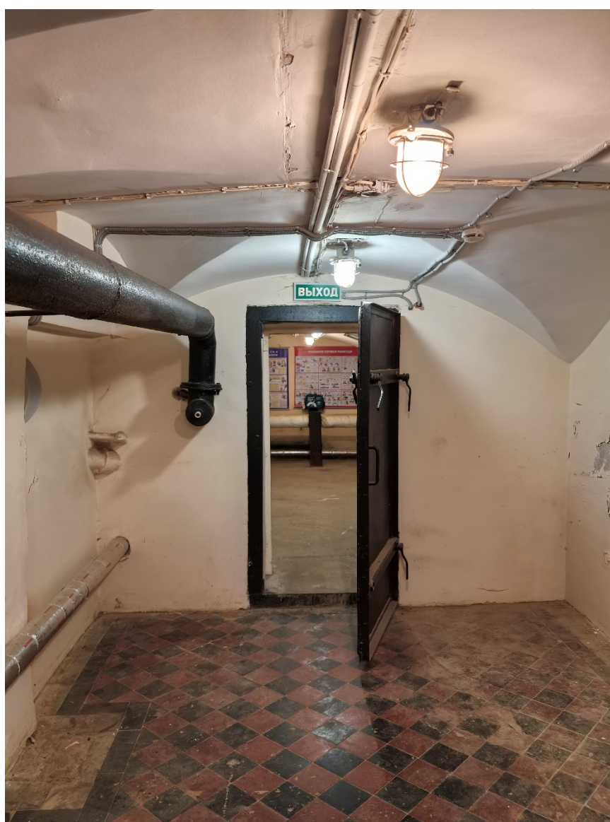
4. Объект культурного наследия федерального значения «Общество кредитное городское Санкт-Петербургское с дворовым флигелем», по адресу: Санкт-Петербург, пл. Островского, д. 7, лит. А (Островского пл., 7). Помещение подвала. Дата съемки: 20.03.2026г.
