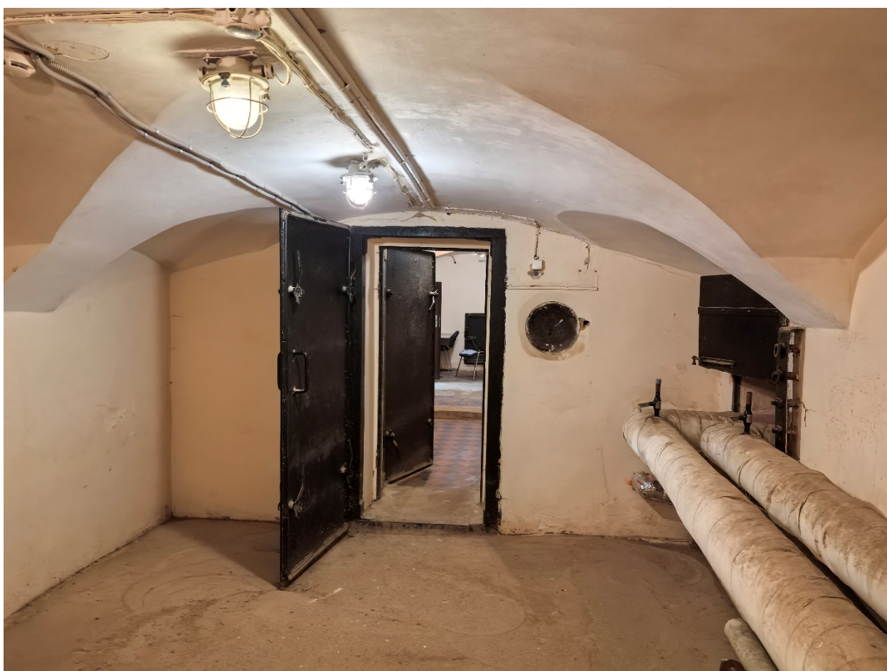
3. Объект культурного наследия федерального значения «Общество кредитное городское Санкт-Петербургское с дворовым флигелем», по адресу: Санкт-Петербург, пл. Островского, д. 7, лит. А (Островского пл., 7). Помещение подвала. Дата съемки: 20.03.2026г.
