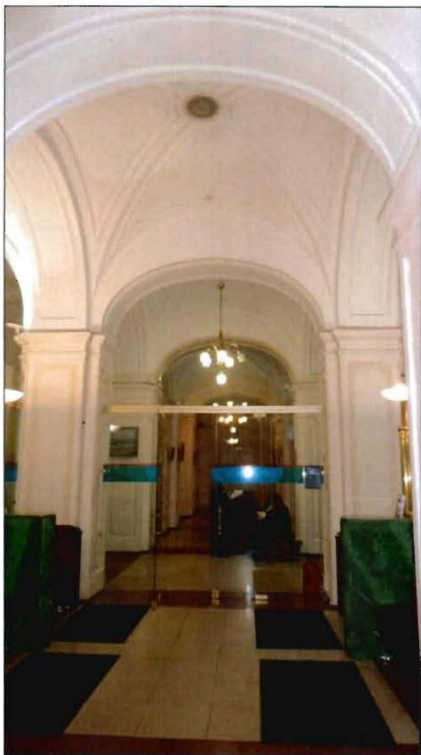
11. Своды в уровне второго этажа.
