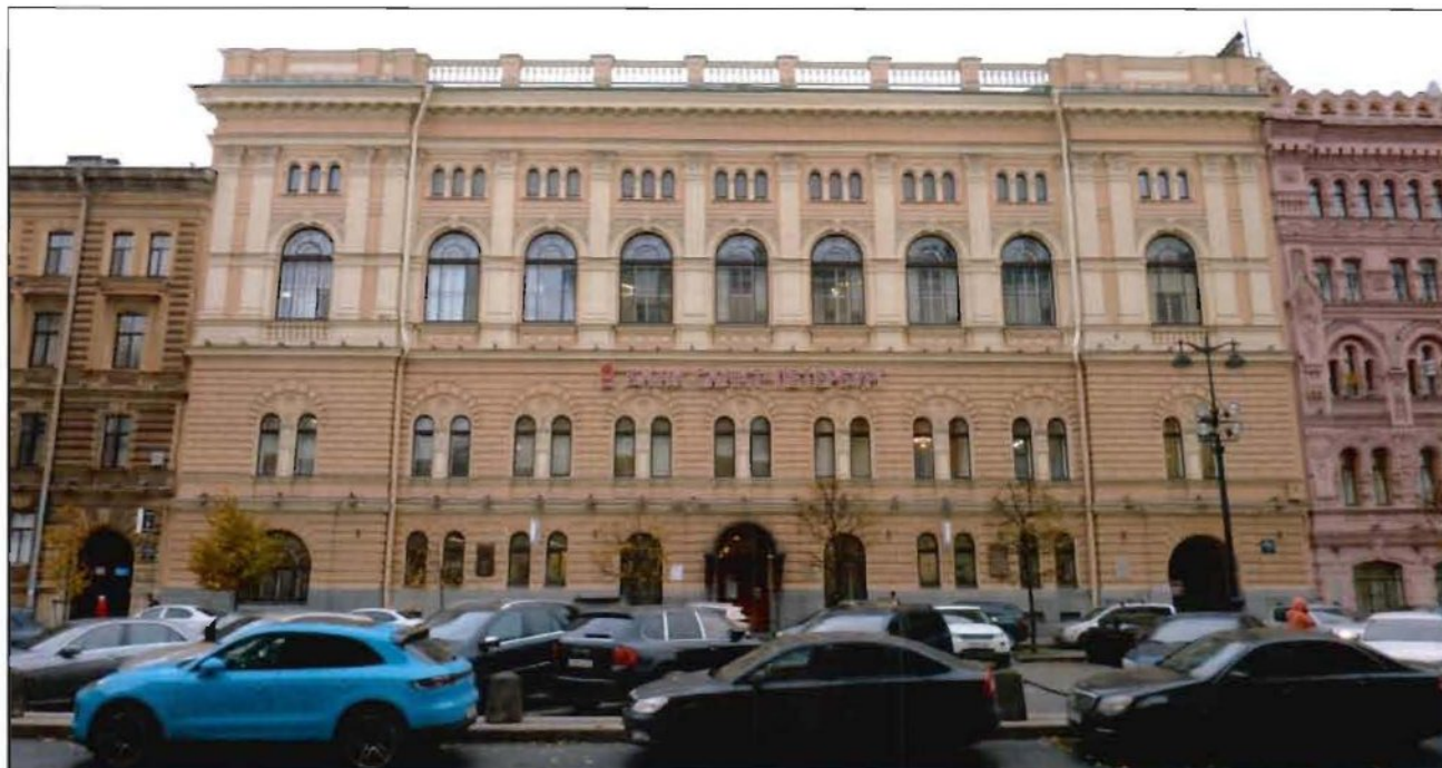
1. Общий вид с востока.
