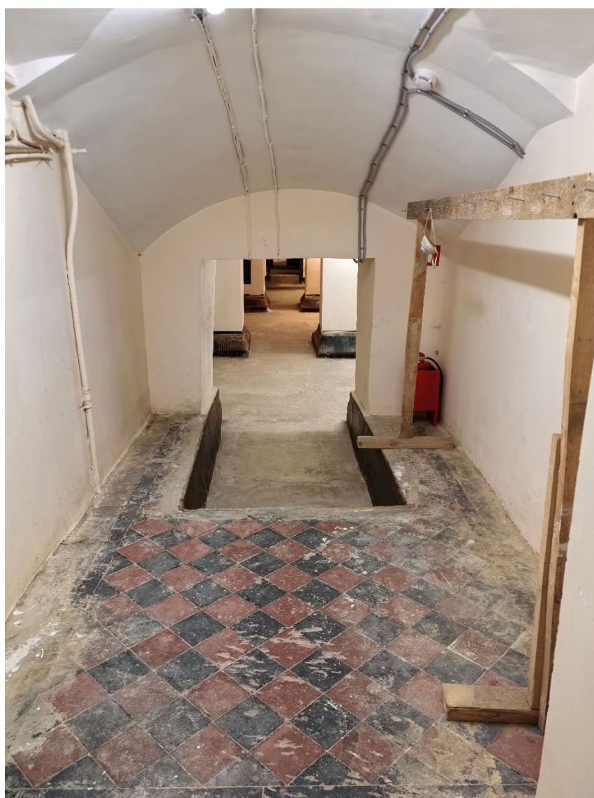
5. Объект культурного наследия федерального значения «Общество кредитное городское Санкт-Петербургское с дворовым флигелем», по адресу: Санкт-Петербург, пл. Островского, д. 7, лит. А (Островского пл., 7). Помещение подвала. Дата съемки: 20.03.2026г.
