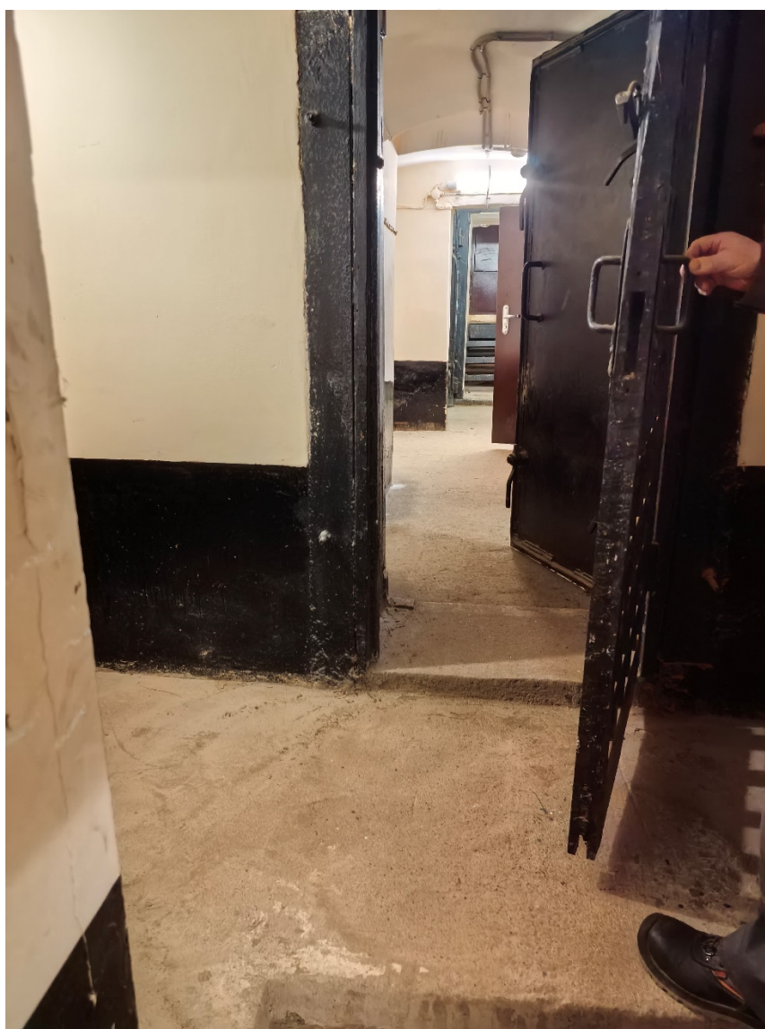
13. Объект культурного наследия федерального значения «Общество кредитное городское Санкт-Петербургское с дворовым флигелем», по адресу: Санкт-Петербург, пл. Островского, д. 7, лит. А (Островского пл., 7). Помещение подвала. Дата съемки: 20.03.2026г.
