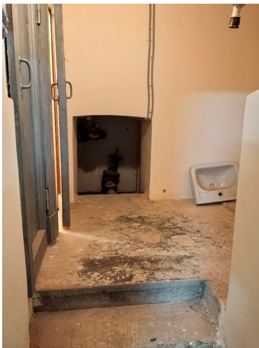
7. Объект культурного наследия федерального значения «Общество кредитное городское Санкт-Петербургское с дворовым флигелем», по адресу: Санкт-Петербург, пл. Островского, д. 7, лит. А (Островского пл., 7). Помещение санузла. Дата съемки: 20.03.2026г.
