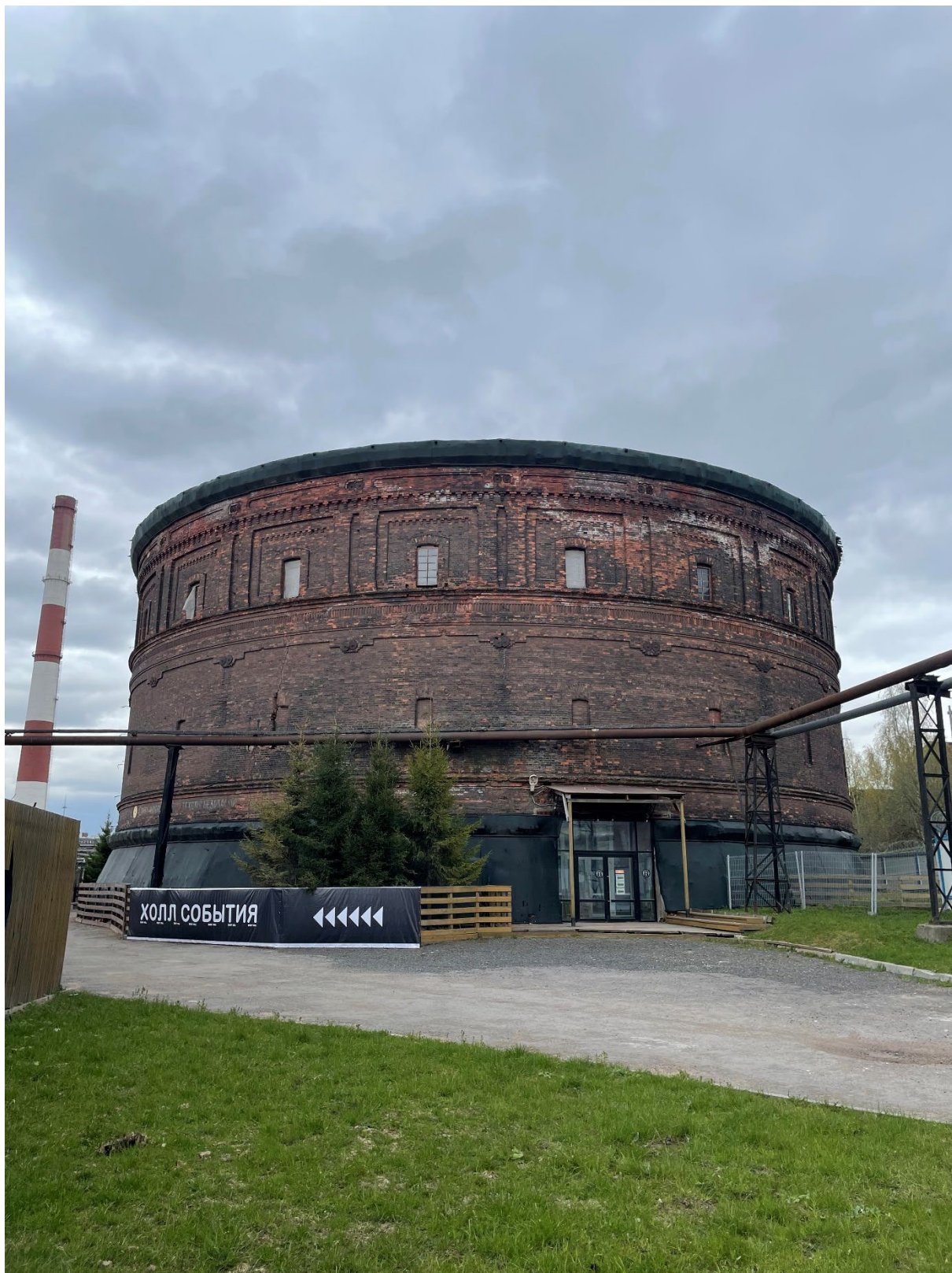
Фото 1. Общий вид на объект.
