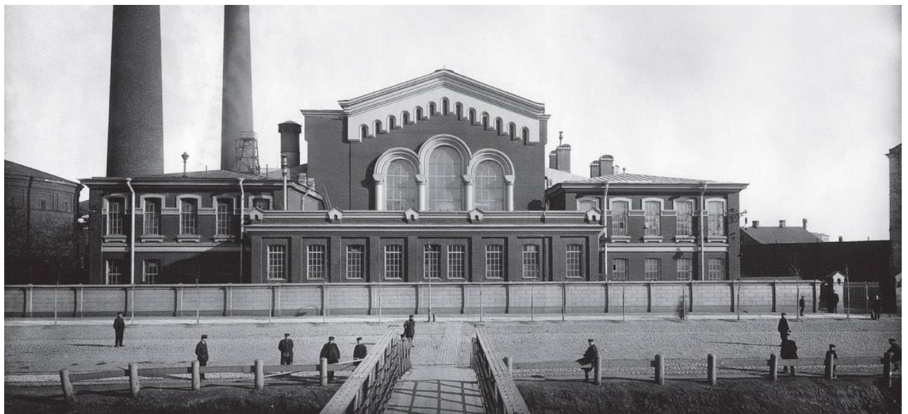
Рис. 28. Здание Центральной электрической станции «Общества электрического освещения 1886 г.» (1911), Россия, Санкт-Петербург, Адмиралтейский район, округ Семёновский. Вариант № 121759. Автор: ателье Буллы. Фото из книги: «Опережая время: фотолетопись энергетики Северо-Запада» / под ред. Н. И. Быстровой. — СПб.: Издательский дом «МедиаЛайн», 2015.
