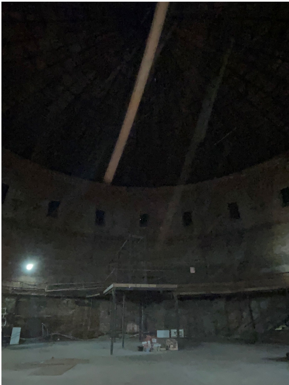
Фото 3. Общий вид на объект.
