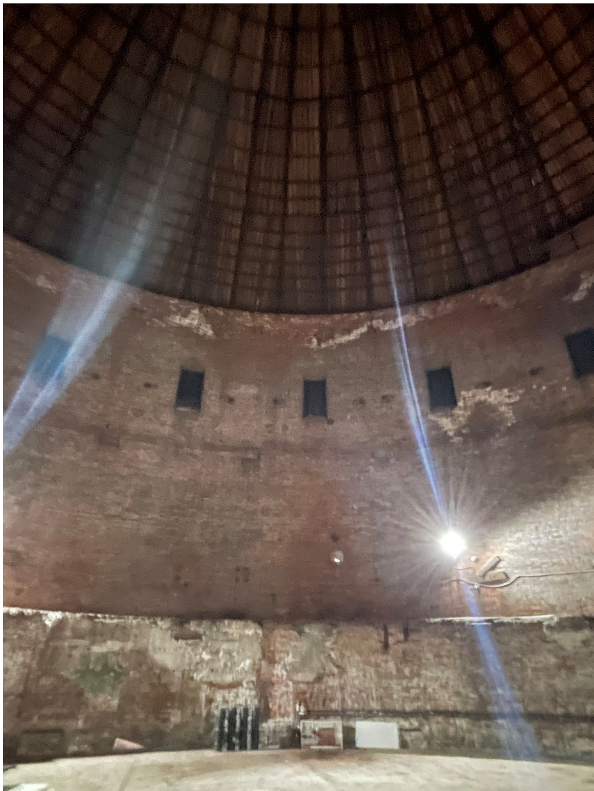
Фото 4. Общий вид на объект.
