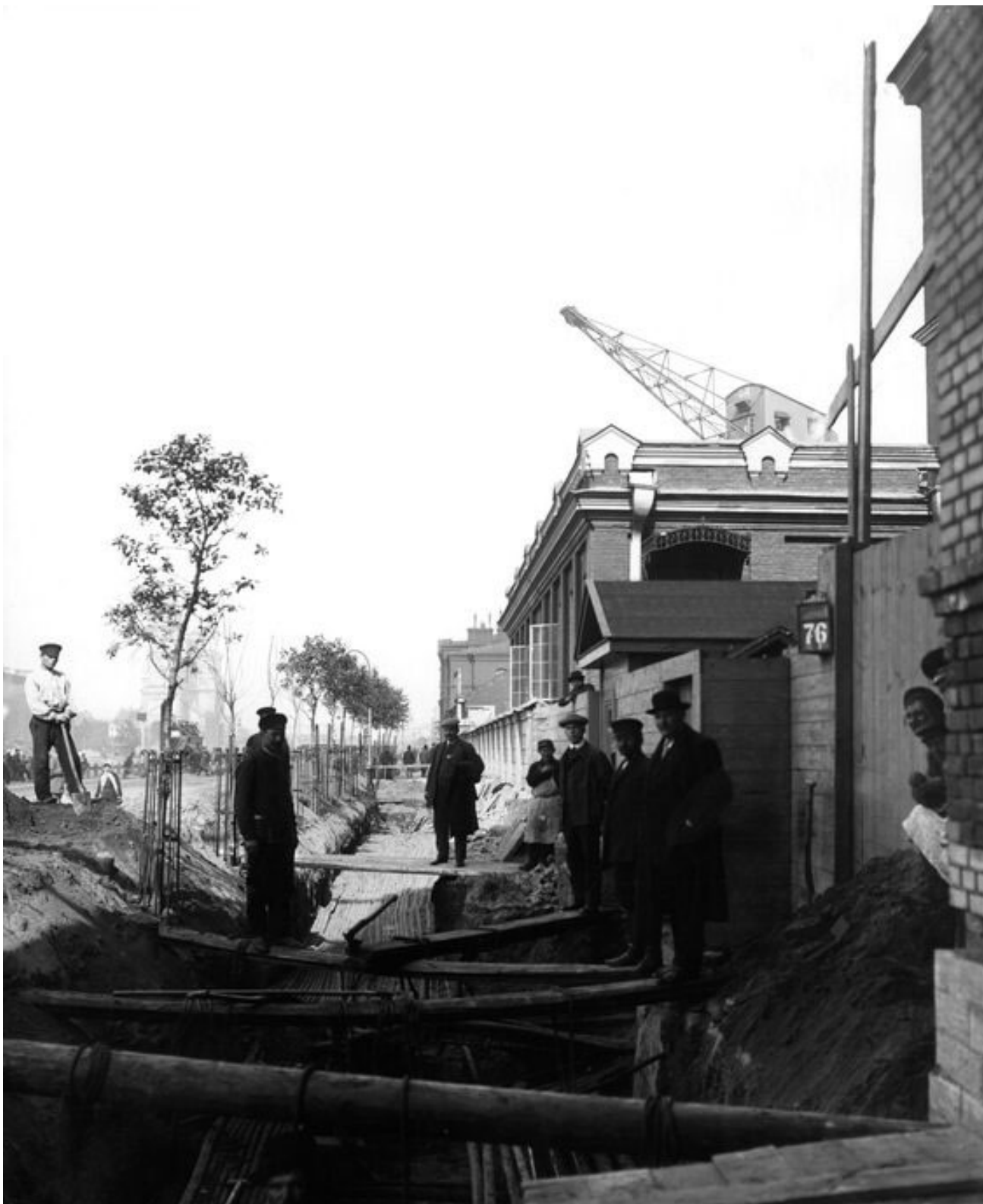
Рис. 26. Прокладка кабеля Центральной электростанции «Общества электрического освещения 1886 г.» (1908), Россия, Санкт-Петербург, Московский район СПб, округ Московская застава.
