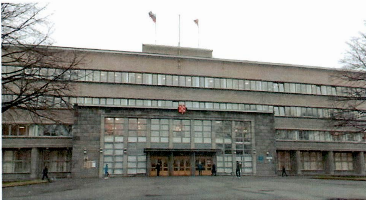
1. Лицевой фасад основного объема. Главный вход
