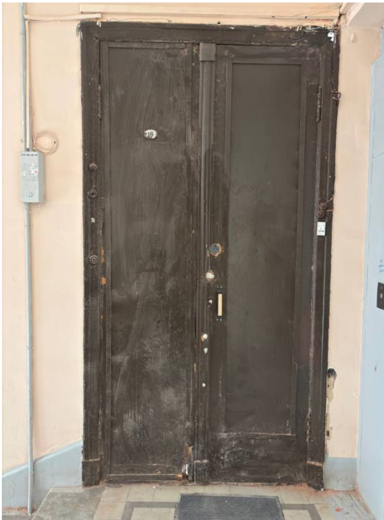
4. Общий вид входной двери в квартиру со стороны лестничной клетки 2ЛК.
