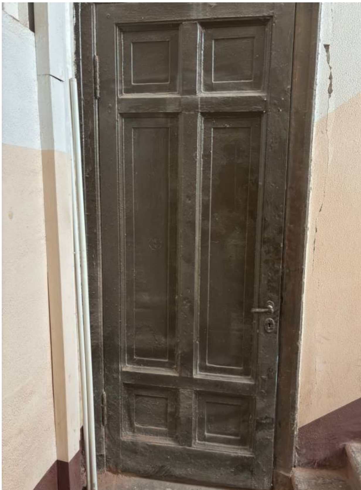
5. Общий вид входной двери в квартиру со стороны лестничной клетки 10ЛК.
