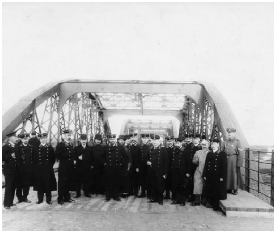
38. Группа служащих Министерства путей сообщения у стальных конструкций моста на станции «Фарфоровский пост». (Путепровод на 6 версте лит. Ж.) Автор съемки: Ателье К. Буллы. Дата съемки: до 1914 г. ЦГАКФФД СПб. Е 9157.
