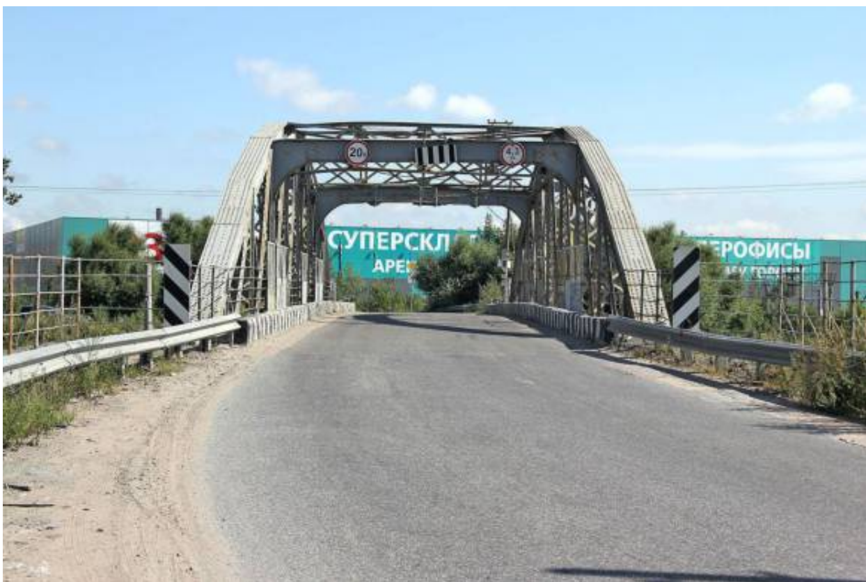
43. Обуховский путепровод. Вид на восток. Фотография 2011 г.
