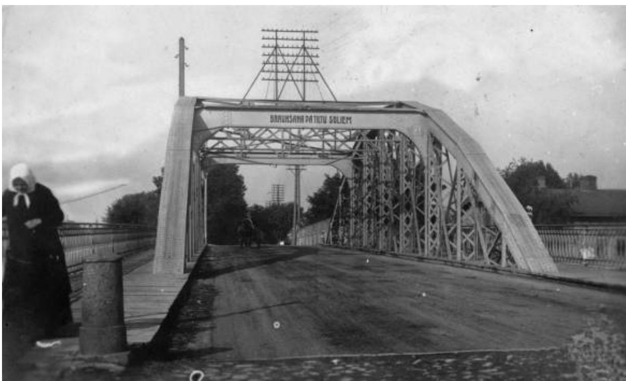
35. Двинск (ныне Даугавпилс, Латвия). Виадук (не сохранился). Фотография 1932 г. [Надпись на виадуке для гужевого транспорта: «Brauksana pa tiltu soliēm – Проезд по мосту шагами».] URL: https://avatars.dzeninfra.ru/get-zen_doc/1899873/pub_5feb859badb1796a08d6c85a_5feb8b44e08bb3522f7accc1/scale_2400 .
