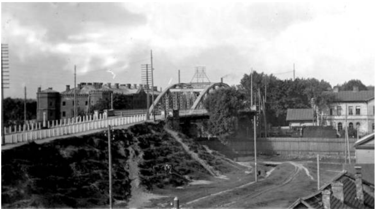
33. Двинск (ныне Даугавпилс, Латвия). Путепровод (не сохранился).
