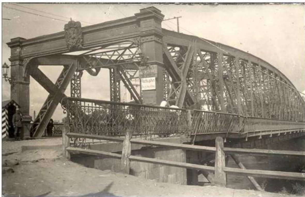
26. Вильнюс (Литва). Зелёный однопролетный мост в начале XX века (не сохранился). Дата постройки: 1893-1894 гг. Автор проекта: проф. Н. А. Белелюбский. Фотография из открытых источников.
