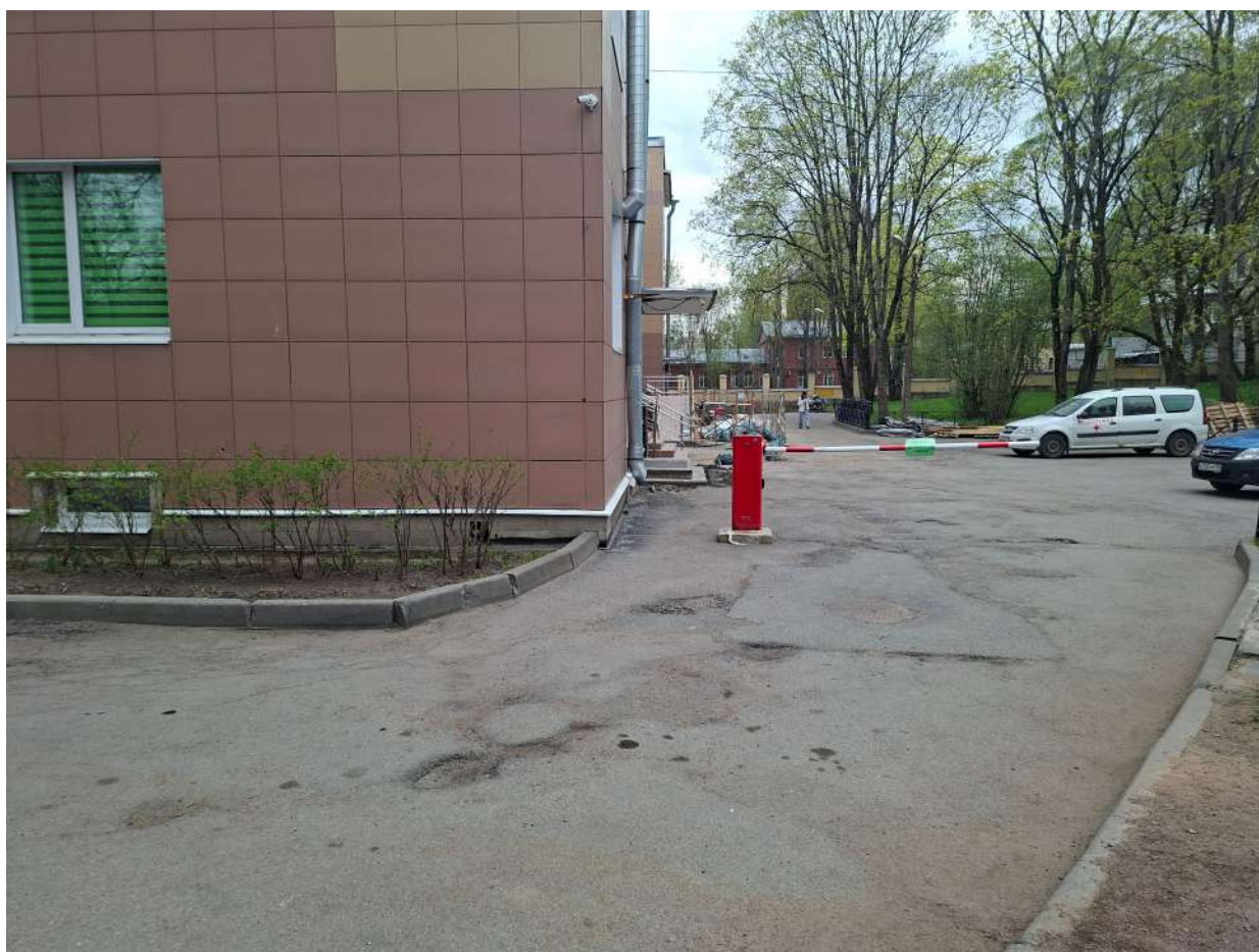
Точка фотофиксации 7. Общий вид на северо-восточную часть территории обследования с СВ.
