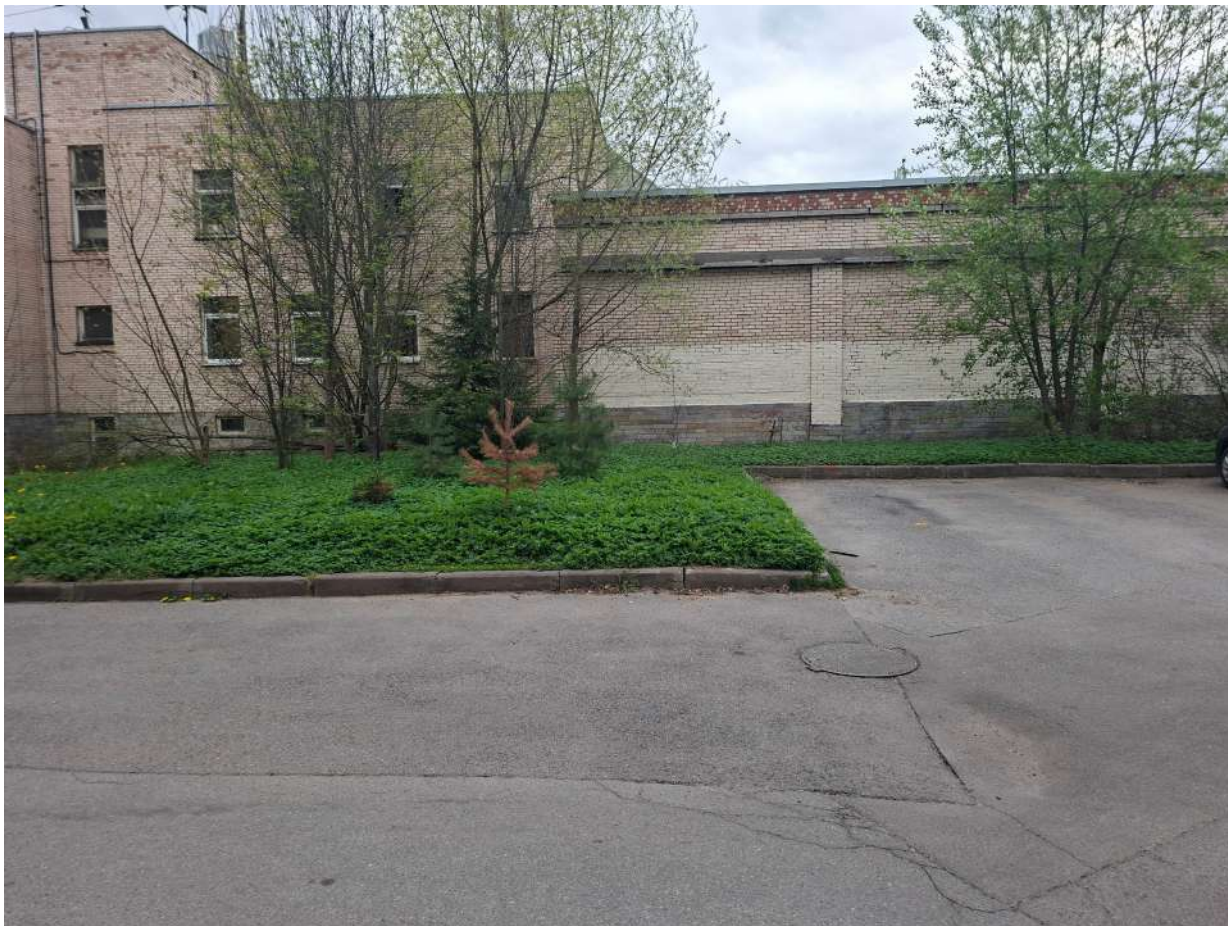
Точка фотофиксации 2. Общий вид на северо-восточную часть территории обследования с СВ.
