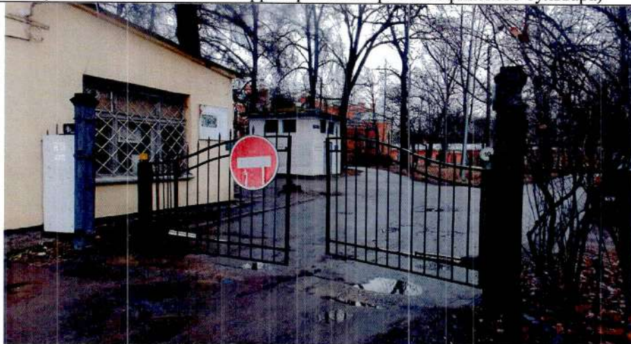
2. Фрагмент исторической ограды (в юго-западной части территории со стороны Московского переулка)
