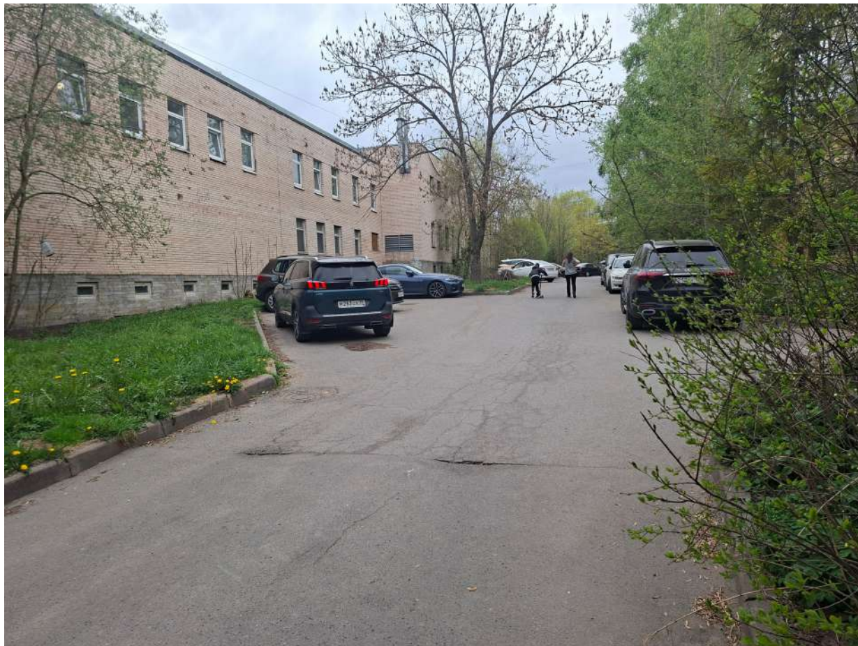
Точка фотофиксации 5. Общий вид на северо-восточную часть территории обследования с СВ.
