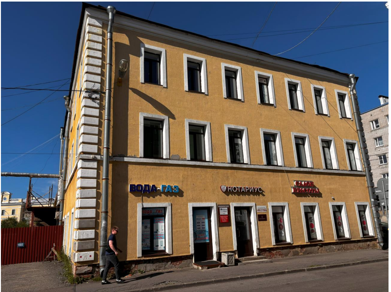
Фото 4. Южный фасад здания.
