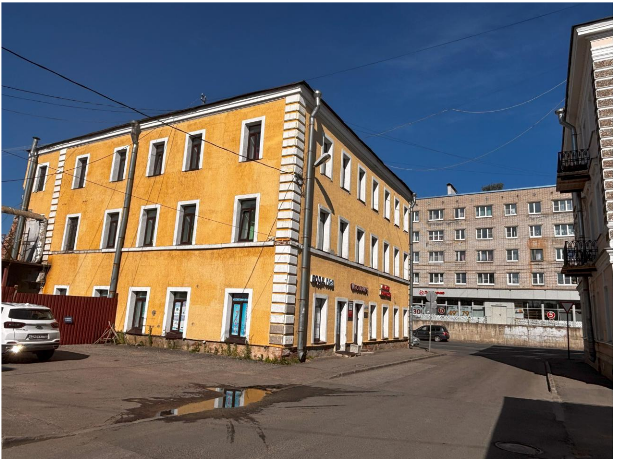
Фото 5. Общий вид с юго-запада.
