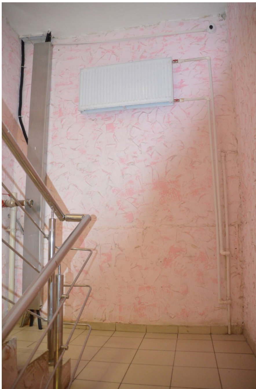
16. Выявленный объект культурного наследия «Жилой дом», расположенный по адресу: Санкт-Петербург, г. Ломоносов, Кронштадтская ул., 1, литера А. Лестничная площадка между 2-м и 3-м этажами.
