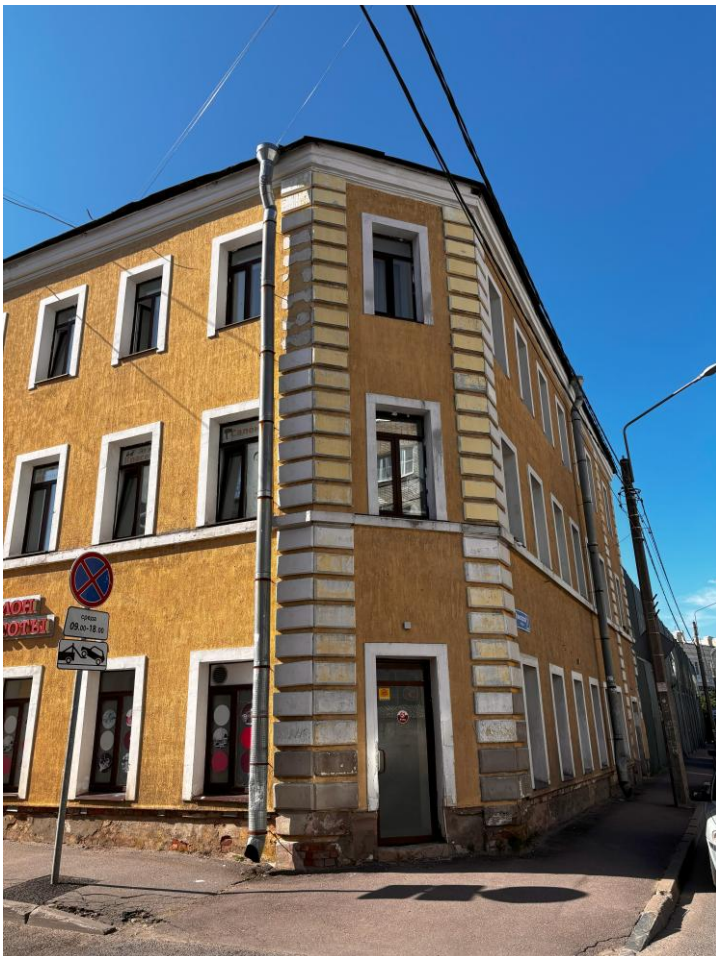
Фото 3. «Скошенный» угол здания.
