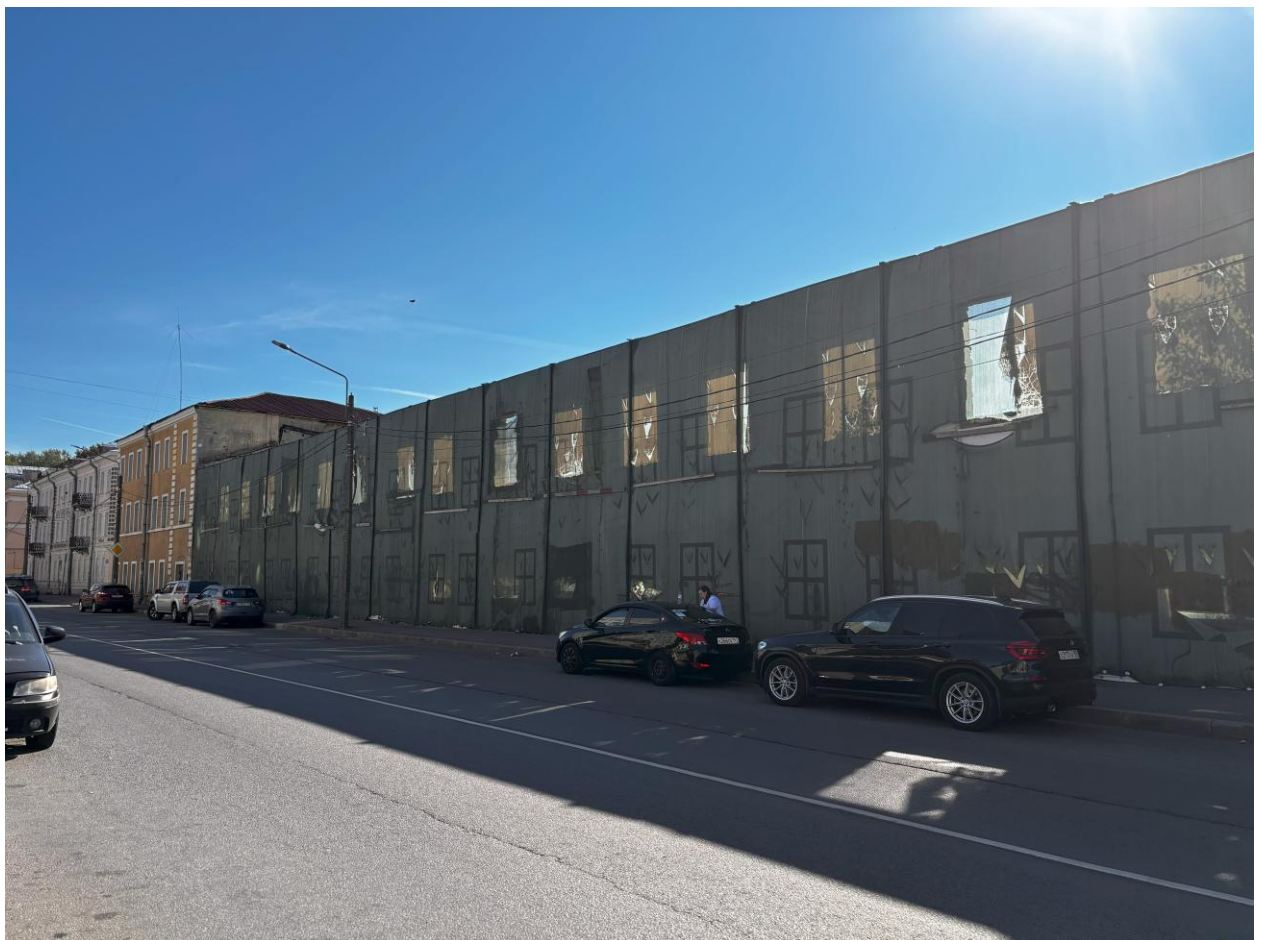
Фото 11. Вид на фрагмент здания по адресу: Ломоносов, ул. Кронштадтская, д. 1.
