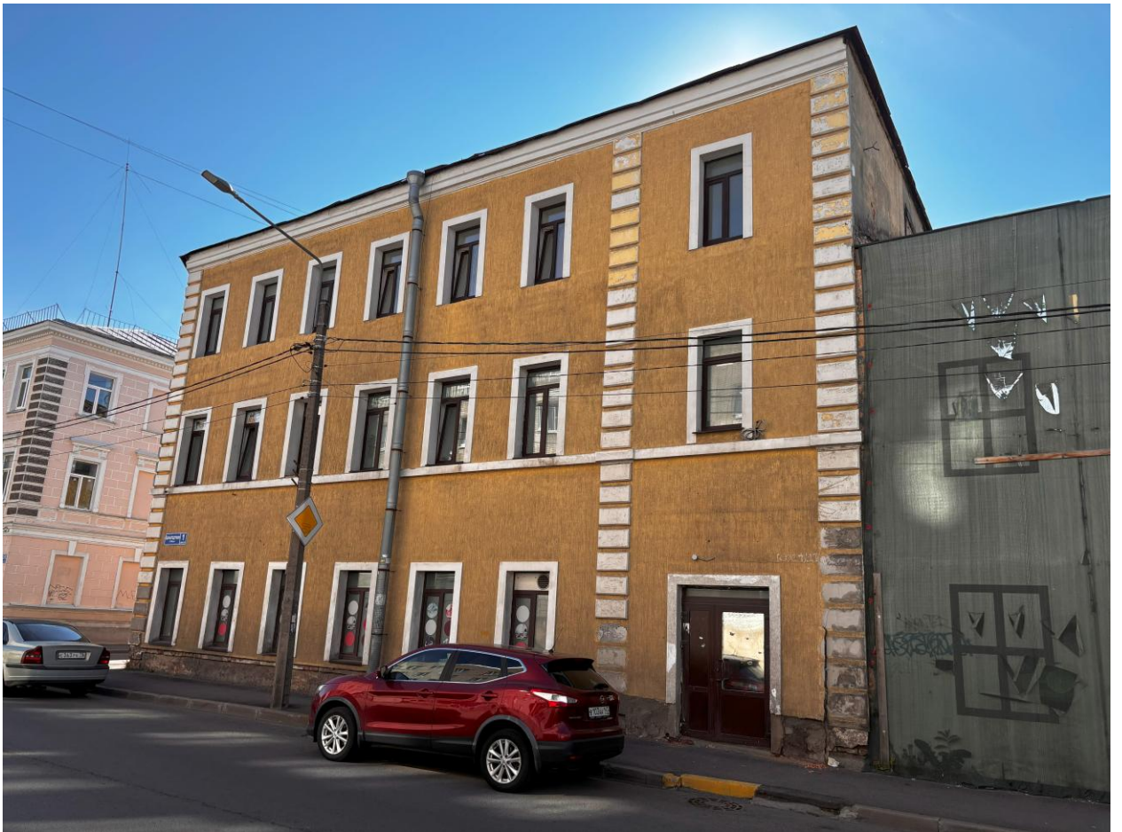
Фото 2. Восточный фасад здания.
