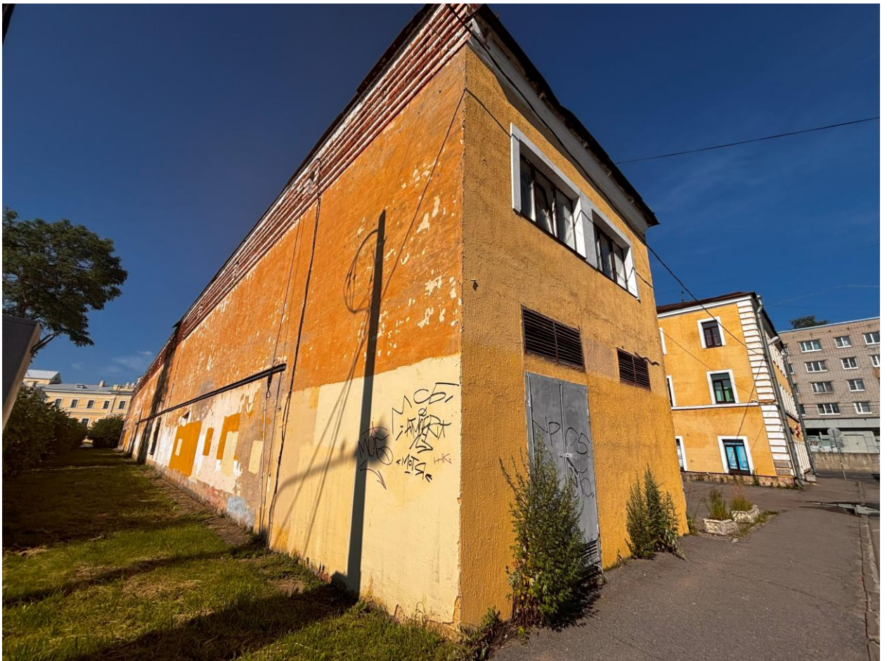
Фото 7. Вид на западную часть здания, не являющегося частью выявленного объекта культурного наследия.
