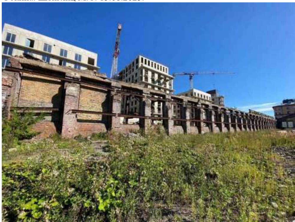
10. Чугунолитейный цех (Большой Сампсониевский пр., д. 30, корп. 2, лит. Б). Вид на внутреннюю часть корпуса. Штиглиц М.С. 15.08.2025.
