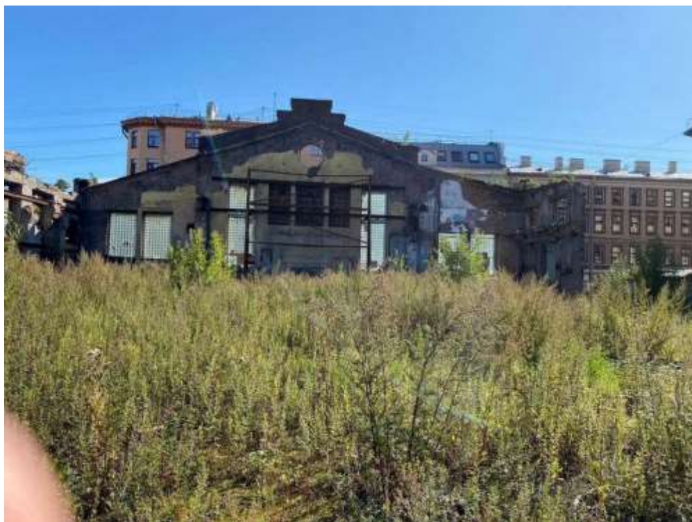
7. Чугунолитейный цех (Большой Сампсониевский пр., д. 30, корп. 2, лит. Б). Вид на внутреннюю часть корпуса. Штиглиц М.С. 15.08.2025.
