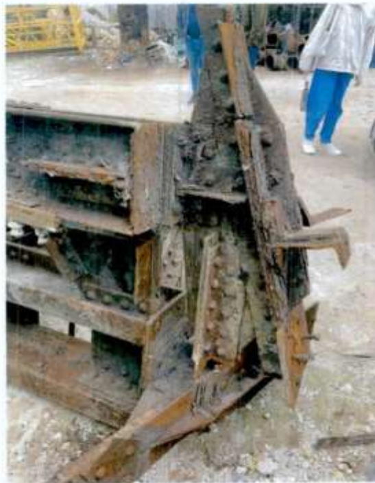
9. Фрагмент клепанной фермы, расположенной по адресу: Санкт-Петербург, Петергофское шоссе, дом 75, корпус 46 (фото от 26.09.2024)
