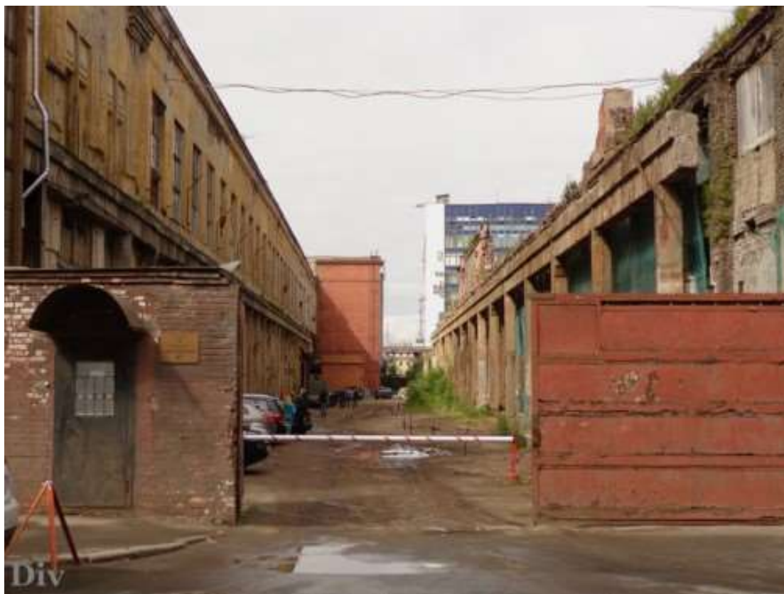
Илл. 16. Внутрив заводской проезд. Фото 2014 г. С сайта «hiddenside.ru».
