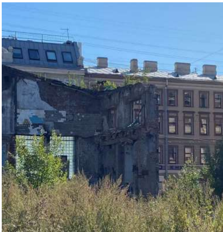
6. Чугунолитейный цех (Большой Сампсониевский пр., д. 30, корп. 2, лит. Б). Вид на внутреннюю часть корпуса. Фрагмент. Штиглиц М.С. 15.08.2025.
