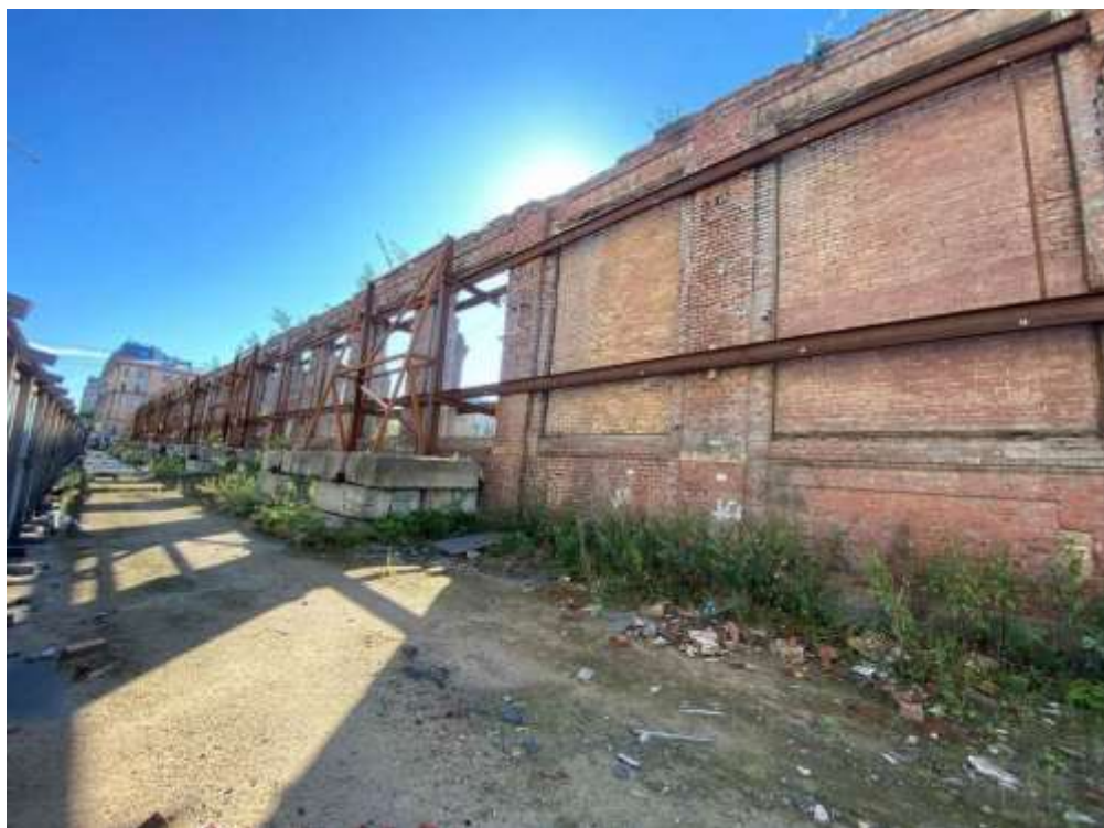
9. Чугунолитейный цех (Большой Сампсониевский пр., д. 30, корп. 2, лит. Б). Фасад по ул. Фокина. Штиглиц М.С. 15.08.2025.
