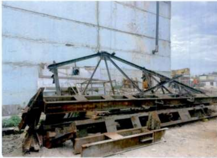
6. Фрагмент клепанной фермы, расположенной по адресу: Санкт-Петербург, Петергофское шоссе, дом 75, корпус 46 (фото от 26.09.2024)
