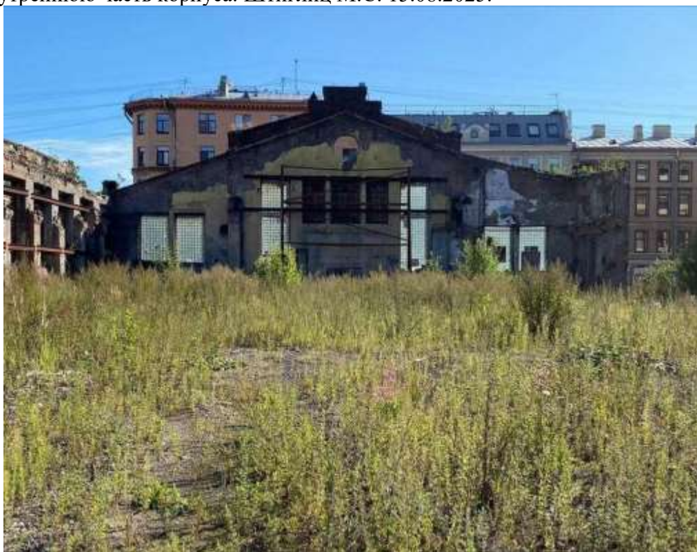
12. Чугунолитейный цех (Большой Сампсониевский пр., д. 30, корп. 2, лит. Б). Вид на внутреннюю часть корпуса. Фрагмент. Штиглиц М.С. 15.08.2025.
