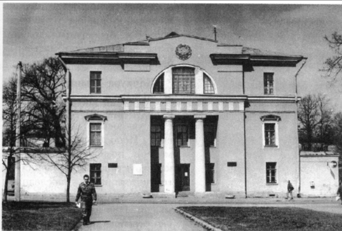
8. Здание б. Управления полицеймейстера города. 1997-1998//Царское Село – резиденция российских монархов. Архитектурный и военно-исторический очерк. С.Я. Ласточкин, Ю.Ф. Рубежанский. СПб, 1998
