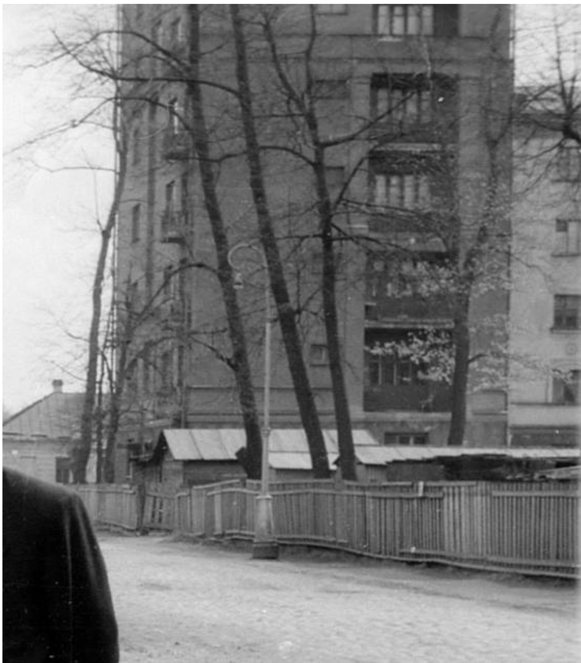
Илл. № 32. Фото 1956 г. Скан негатива из личного архива. Фрагмент. Интернет-ресурс https://pastvu.com . Вид на рассматриваемый семиэтажный объем с запада.
