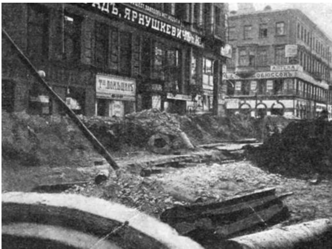
27. Ремонт на углу Гороховой и Морской улиц. Фотография 1912 г. Огонек. 1912. № 29.
