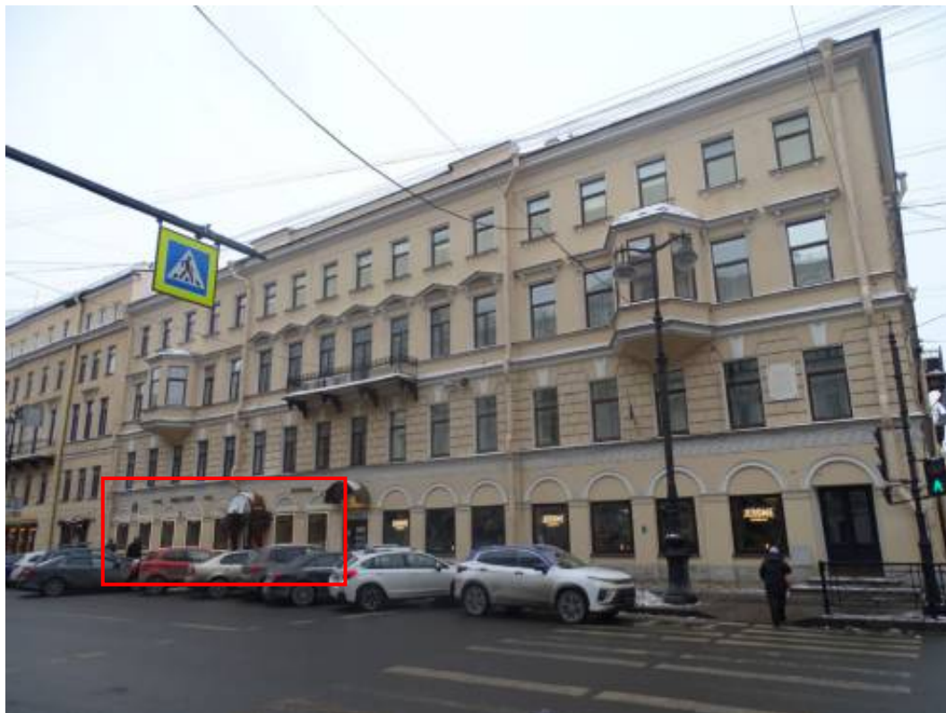
Илл. 01. Объект культурного наследия федерального значения «Дом, где в 1840 - 1841 гг. жил писатель и философ Герцен А.И.». Вид с пересечения Большой Морской ул. и Гороховой ул. Съемка 19.02.2026 г. Трушковский В.Э.
