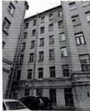
Фото 30. Южный фасад внутреннего двора. Фрагмент
