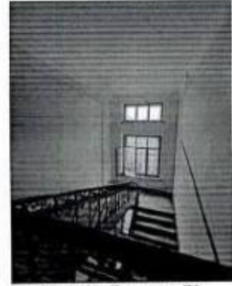
Фото 61. Лестница Л1. Фрагмент
