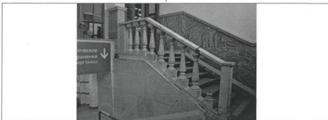
Фотография 10. Лестница Л 5
