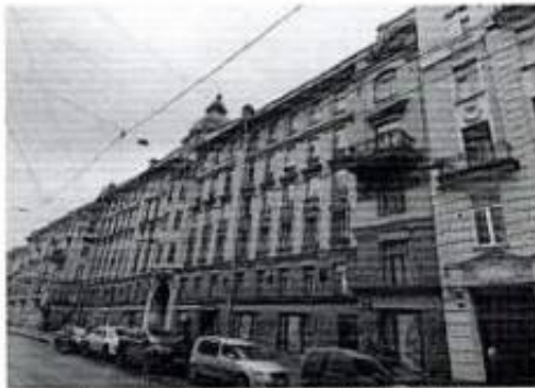
Фото 1. Лицевой фасад. Общий вид
