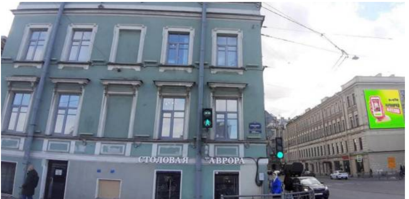
38. «Доходный дом» (в составе «Дома Н.Ф.Крупенникова») (Куйбышева ул., д. 33/8, лит. А) (угловой корпус). Лицевой фасад по Петроградской наб. (фрагмент). Фото мест установки оборудования и прокладки кабельных трасс. Штиглиц М.С. 22.04.2026 г.
