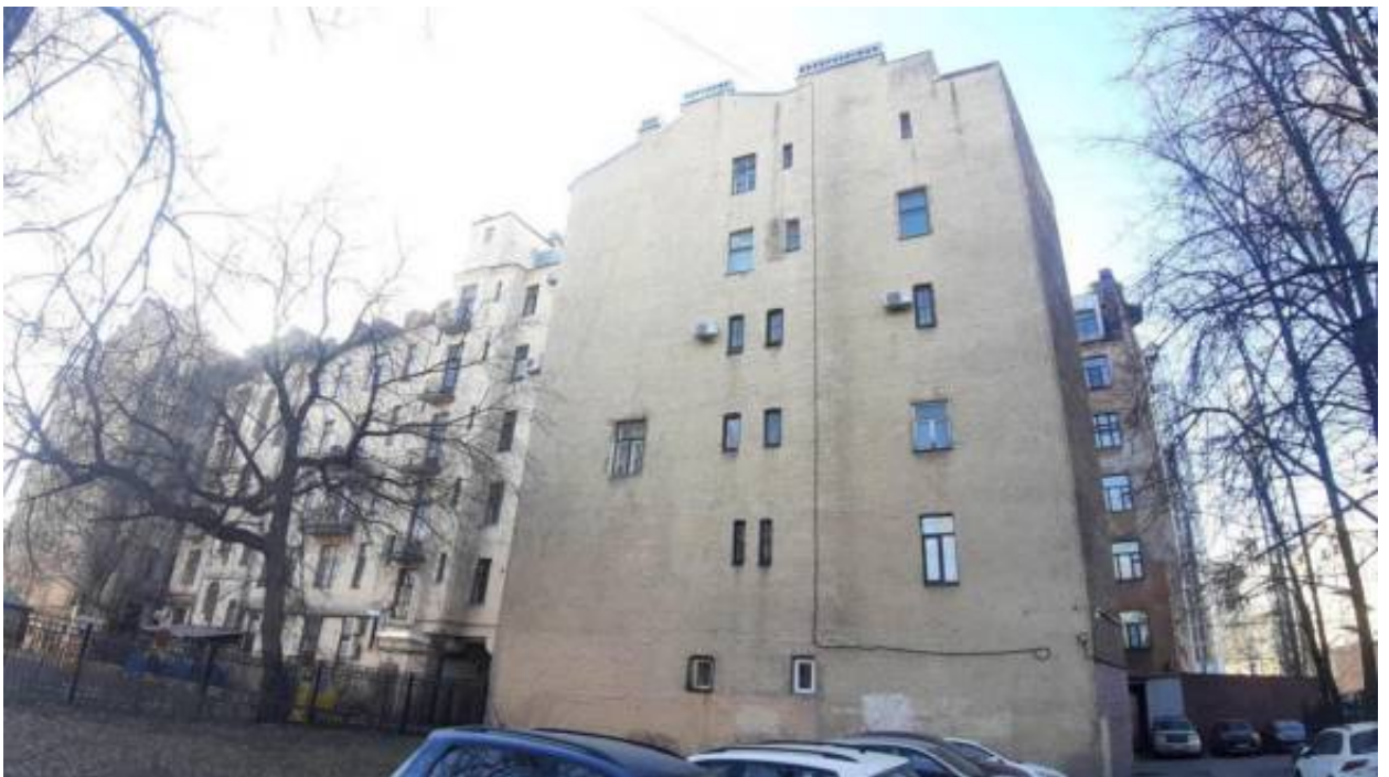
8. «Дом Второго Санкт-Петербургского товарищества для устройства постоянных квартир с курдонером» (в составе «Дом Второго Санкт-Петербургского товарищества для устройства постоянных квартир с курдонером, палисадником и оградой») (наб. реки Карповки, д. 19, лит. А). Фото мест установки оборудования и прокладки кабельных трасс. Штиглиц М.С. 22.04.2026 г.
