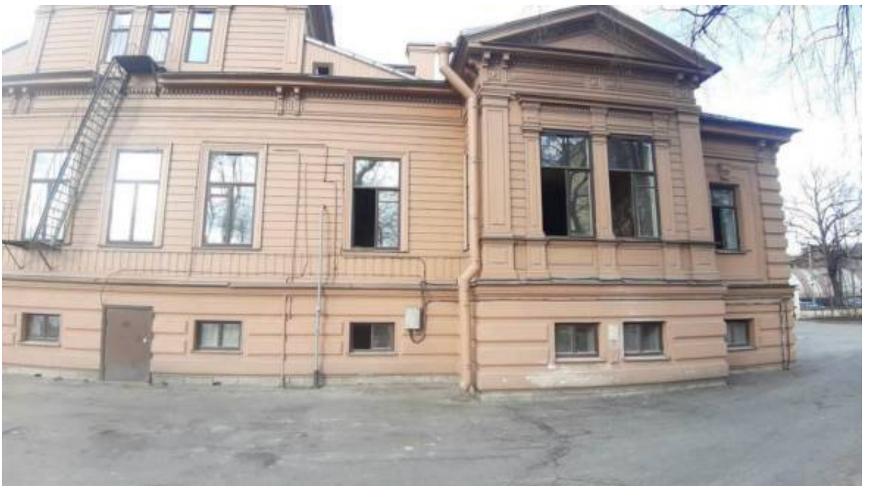
6. «Особняк В.И.Гота» (Петровский пр., д. 20, корп. 3, лит. А). Фото мест установки оборудования и прокладки кабельных трасс. Штиглиц М.С. 22.04.2026 г.
