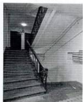
Фото 69. Лестница Л3. Фрагмент
