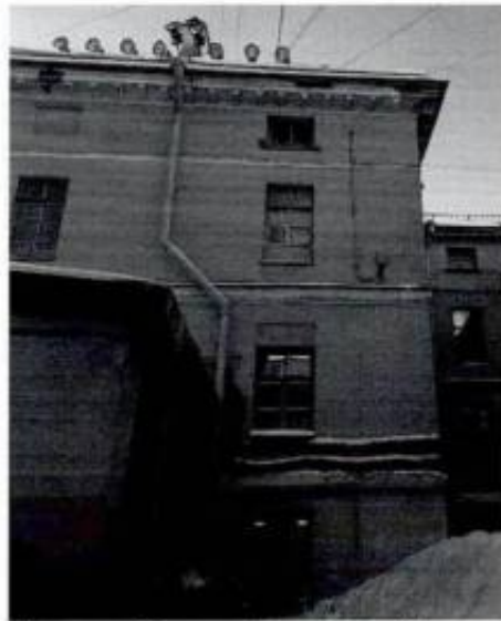
Фрагмент бокового (восточного) фасада
