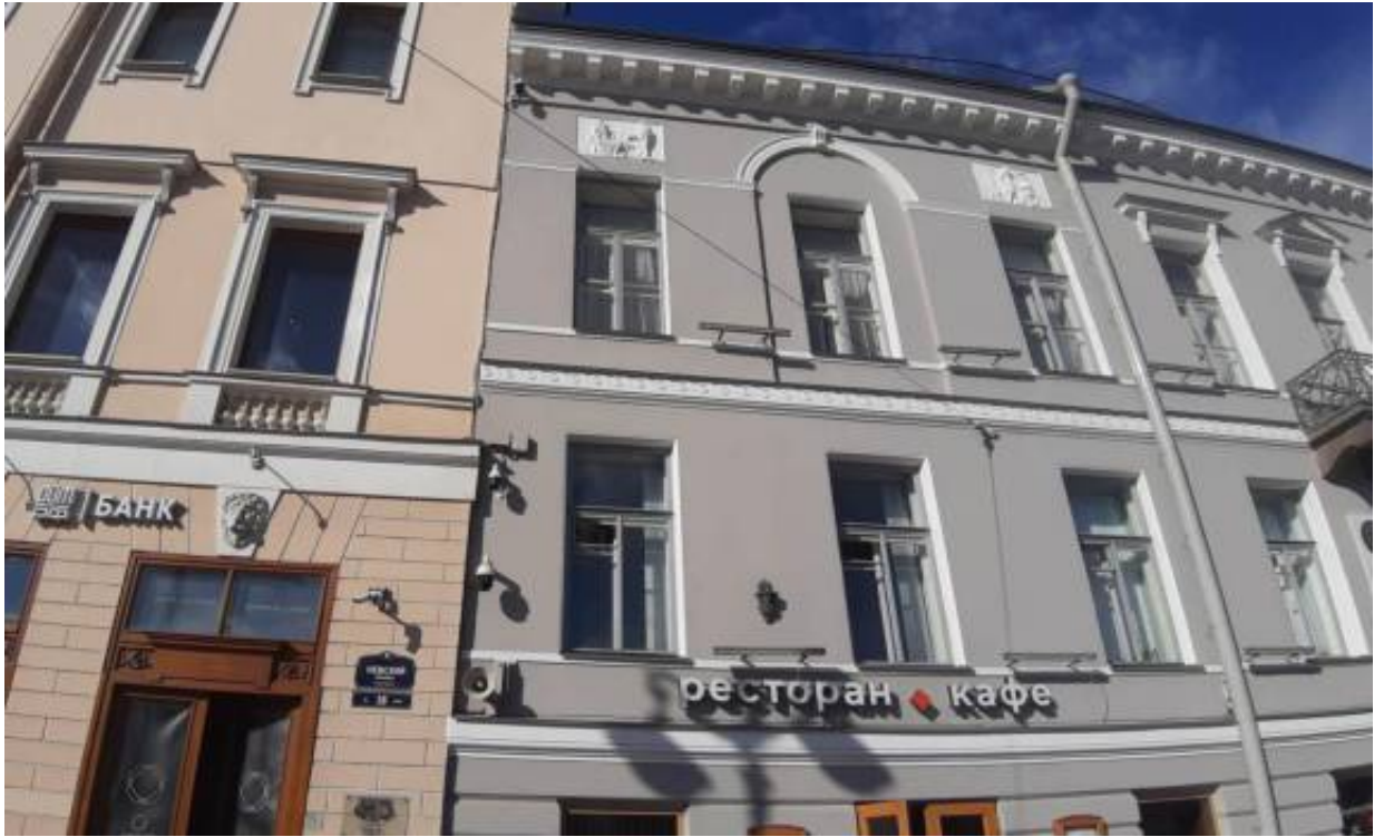
43. «Дом жилой» (в составе объекта культурного наследия федерального значения «Церковь армянская святой Екатерины») (Невский пр., д. 40-42, лит. А). Лицевой фасад (фрагмент). Фото мест установки оборудования и прокладки кабельных трасс. Штиглиц М.С. 22.04.2026 г.
