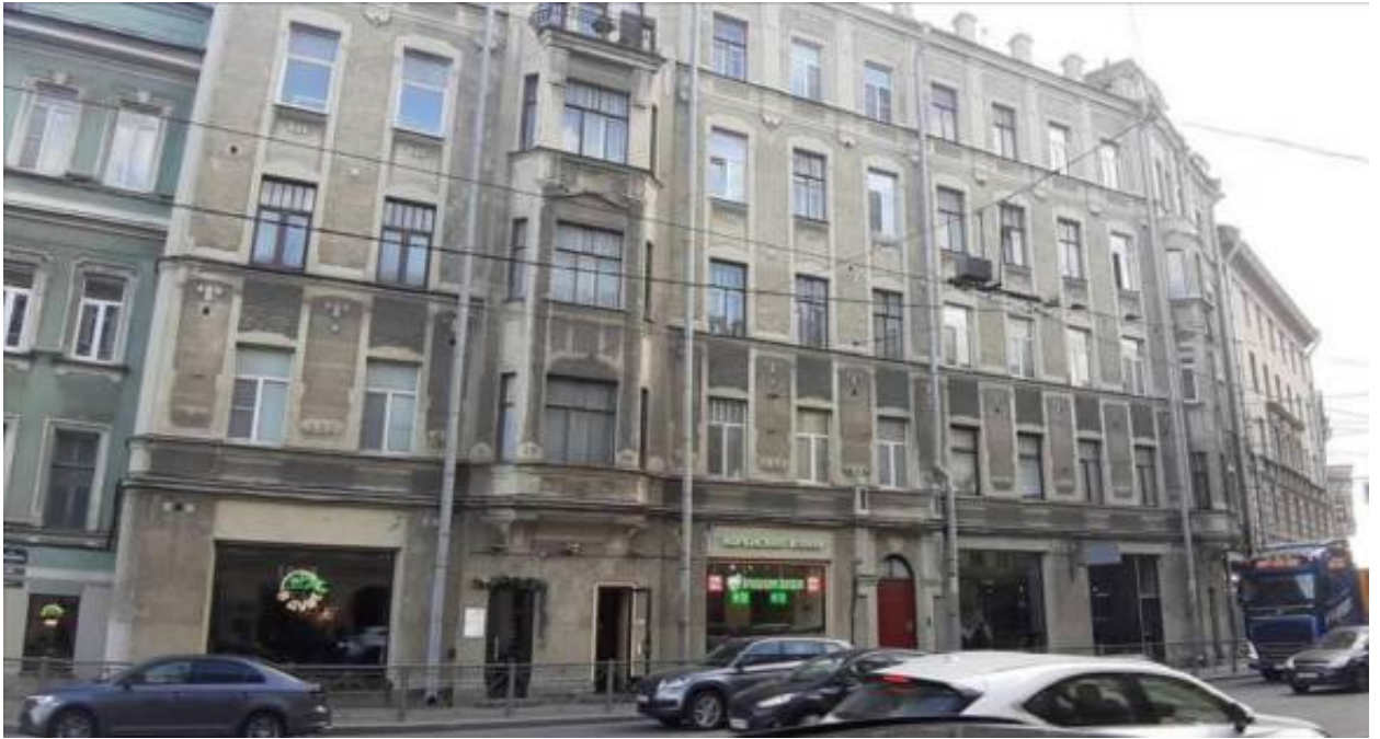
41. «Доходный дом» (в составе «Дома Н.Ф.Крупенникова») (Куйбышева ул., д. 33/8, лит. А) (корпус по улице). Лицевой фасад по Куйбышева ул. (фрагмент). Фото мест установки оборудования и прокладки кабельных трасс. Штиглиц М.С. 22.04.2026 г.
