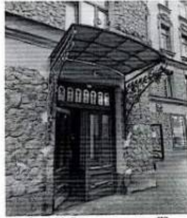
Фото 14. Вход на лестницу Л2 с историческим дверным заполнением и козырьком
