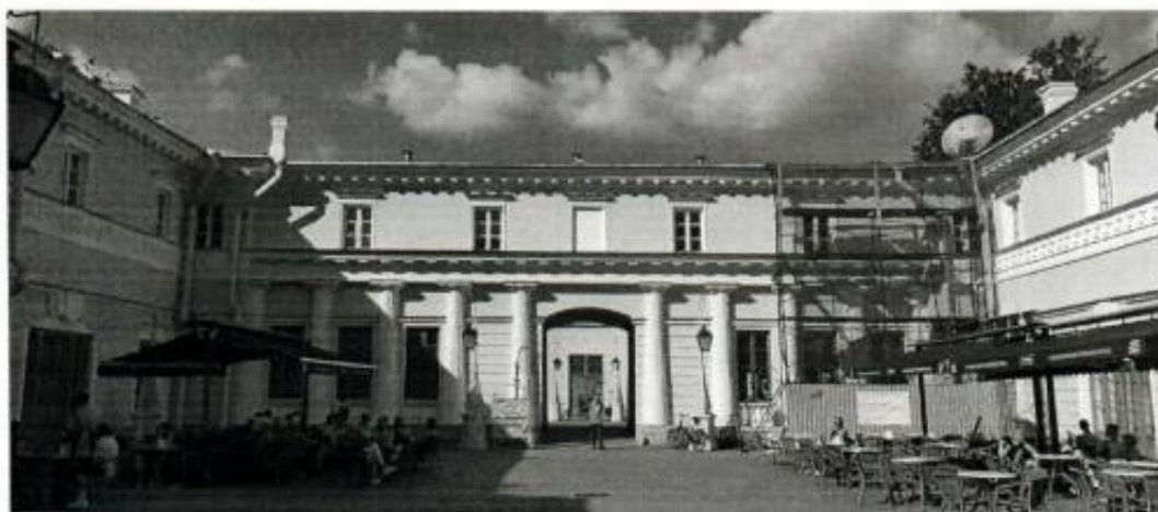
6. Северный фасад квадратного двора.
