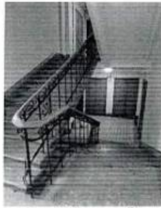
Фото 71. Лестница Л3. Фрагмент
