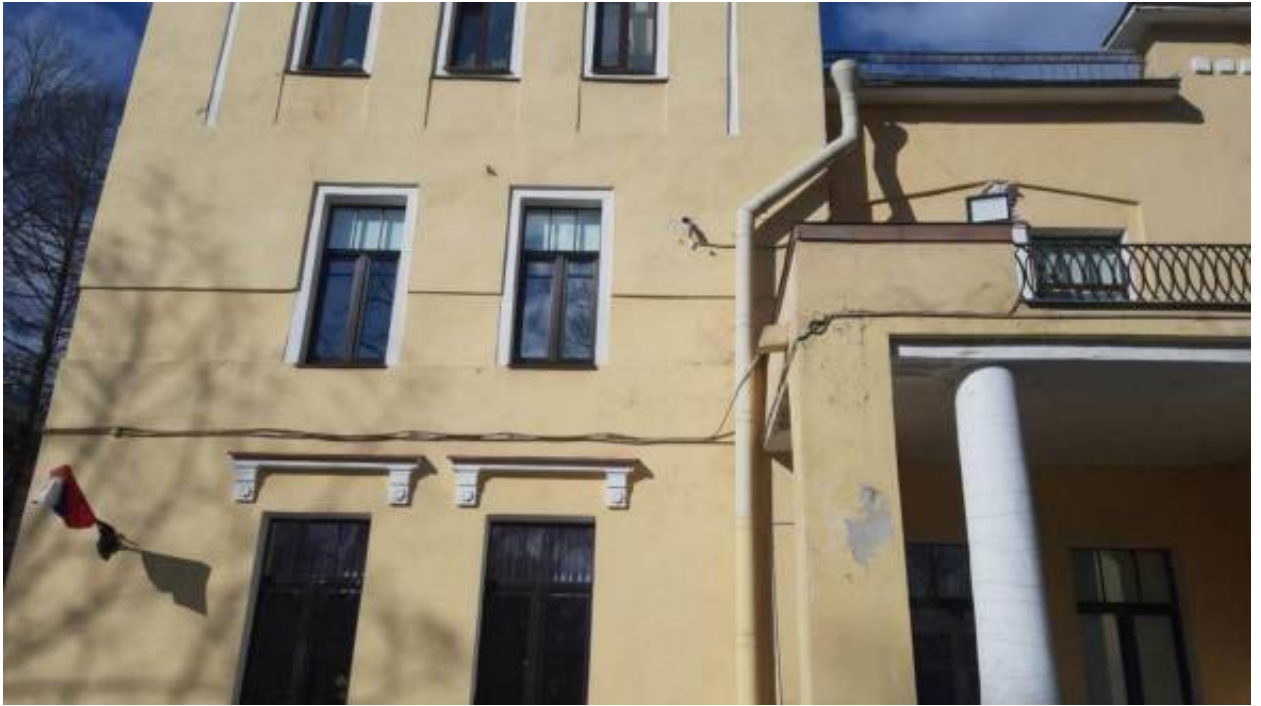
35. «Особняк Михина с участком парка и оградой» (1-я Берёзовая аллея, д. 5, лит. А). Лицевой фасад (фрагмент). Фото мест установки оборудования и прокладки кабельных трасс. Штиглиц М.С. 22.04.2026 г.
