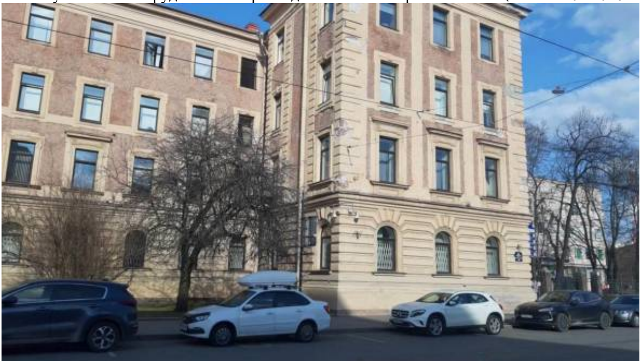
28. «Институт медицинский женский. Здесь преподавали Бехтерев В.В., Ланч Г.Ф., Орбели А.А., Павлов И.П., в 1917 г. состоялась VII (Апрельская) конференция РСДРП (б)» (Льва Толстого ул., 6-8, лит. А). Лицевой фасад (фрагмент). Фото мест установки оборудования и прокладки кабельных трасс. Фото мест установки оборудования и прокладки кабельных трасс. Штиглиц М.С. 22.04.2026 г.
