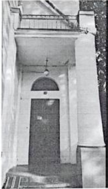
4. Южный фасад. Фрагмент.
