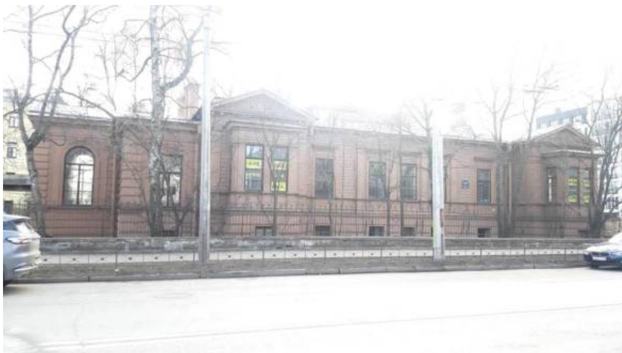
1. «Особняк В.И.Гота» (Петровский пр., д. 20, корп. 3, лит. А). Лицевой фасад. Штиглиц М.С. 22.04.2026 г.
