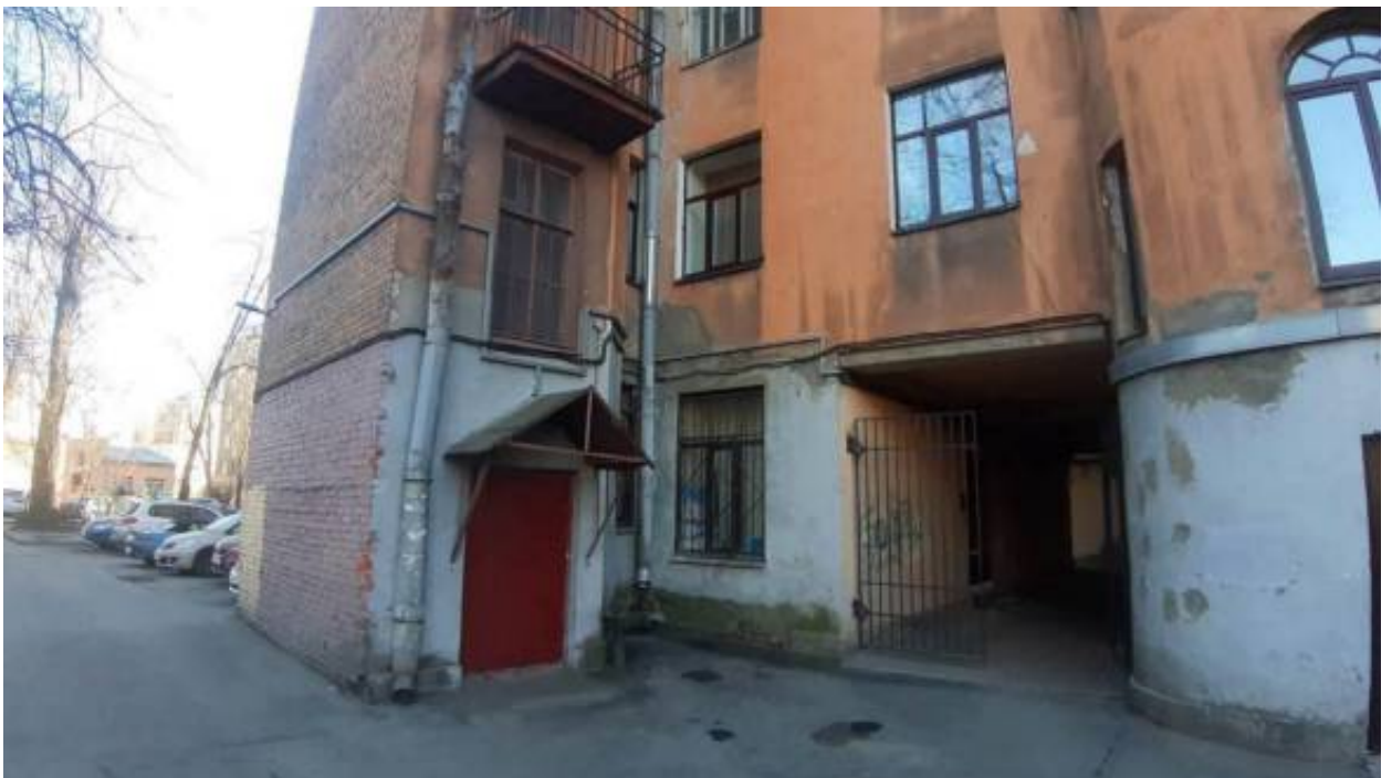
16. «Дом Второго Санкт-Петербургского товарищества для устройства постоянных квартир с курдонером» (в составе «Дом Второго Санкт-Петербургского товарищества для устройства постоянных квартир с курдонером, палисадником и оградой») (наб. реки Карповки, д. 19, лит. А). Фото мест установки оборудования и прокладки кабельных трасс. Штиглиц М.С. 22.04.2026 г.
