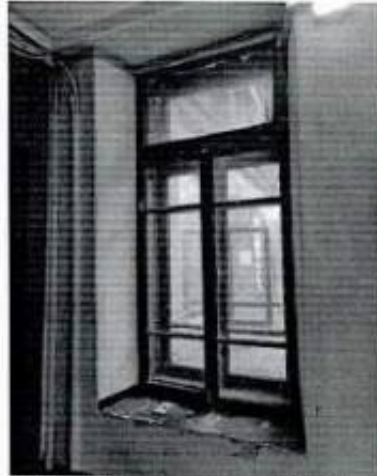
Фото 16. Тамбур лестницы Л2. Фрагмент
