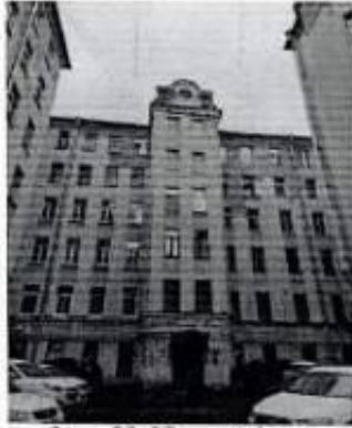
Фото 29. Южный фасад внутреннего двора. Фрагмент
