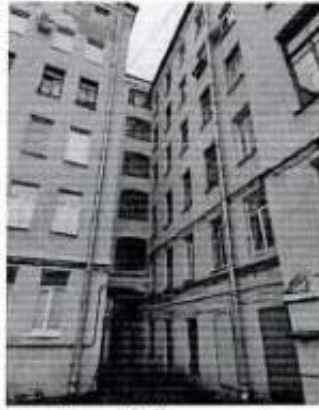
Фото 39. Восточный дворовой фасад. Фрагмент
