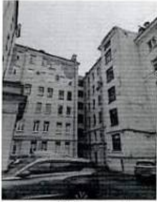
Фото 38. Восточный дворовой фасад. Фрагмент
