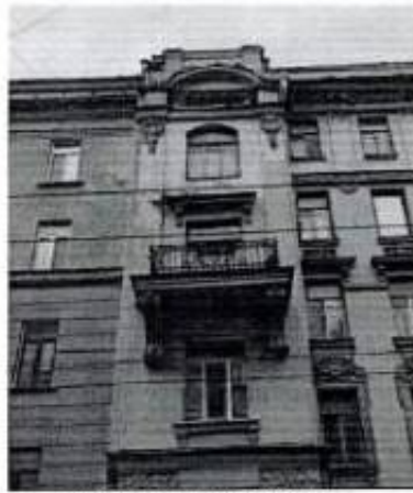
Фото 11. Лицевой фасад. Фрагмент
