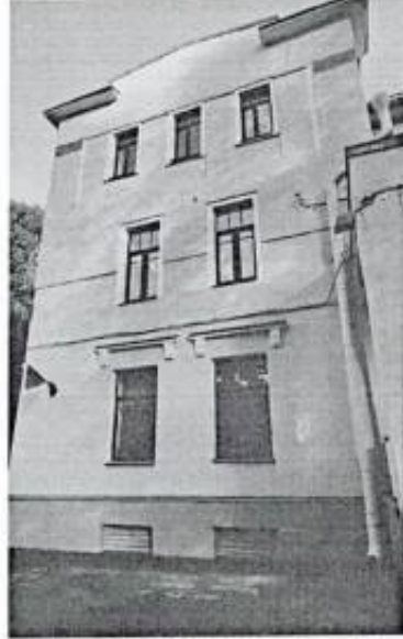
5. Южный фасад. Фрагмент.
