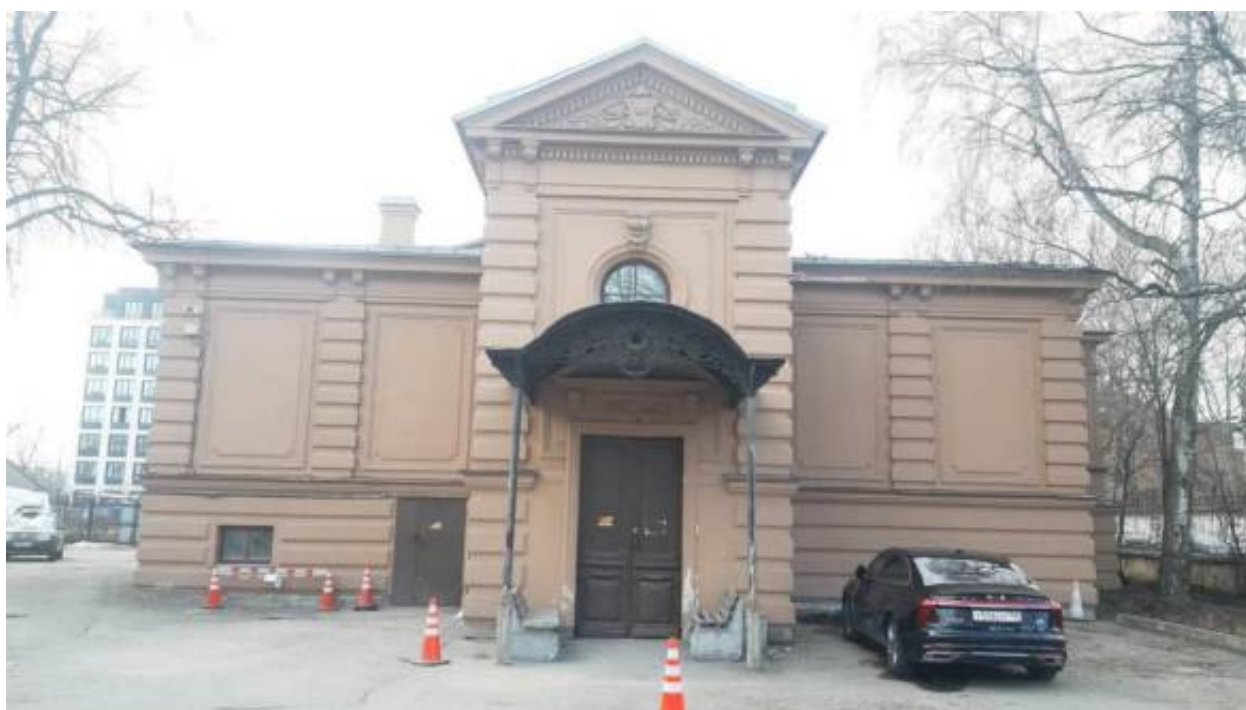
2. «Особняк В.И.Гота» (Петровский пр., д. 20, корп. 3, лит. А). Боковой фасад. Штиглиц М.С. 22.04.2026 г.
