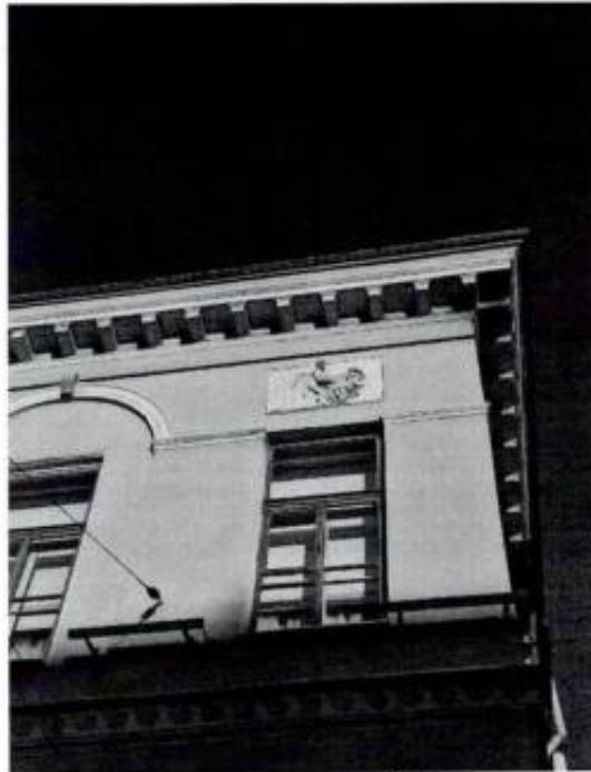
Фрагмент лицевого фасада
