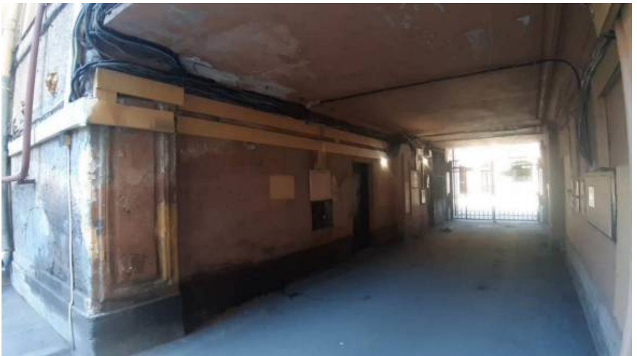
22. «Доходный дом В.Я. Рожкова» (Большая Монетная ул., д. 23, лит. А). Дворовый фасад фрагмент). Фото мест установки оборудования и прокладки кабельных трасс. Штиглиц М.С. 22.04.2026 г.
