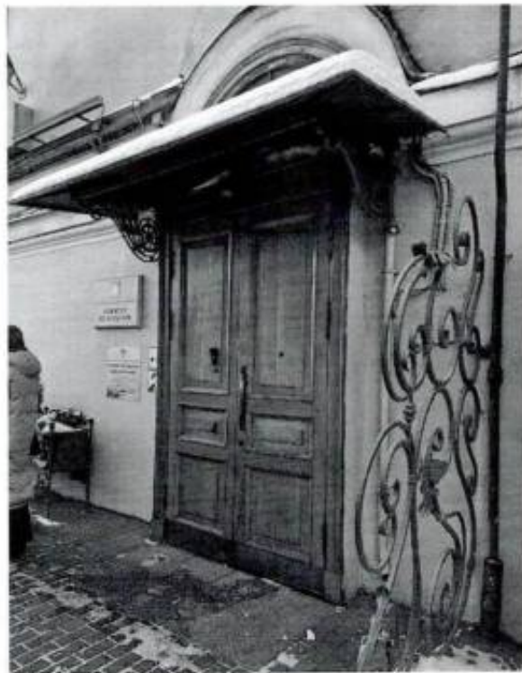
Фрагмент лицевого фасада дверной проем по 7-ой световой оси бокового (восточного) фасада
