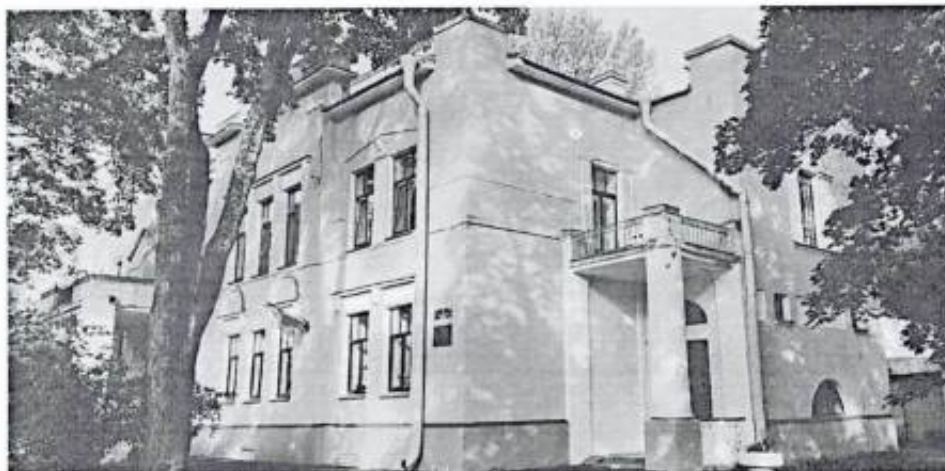
1. Вид на объект культурного наследия с южной и восточной стороны.
