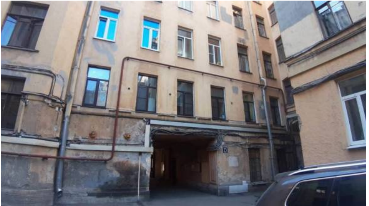
21. «Доходный дом В.Я. Рожкова» (Большая Монетная ул., д. 23, лит. А). Дворовый фасад фрагмент). Фото мест установки оборудования и прокладки кабельных трасс. Штиглиц М.С. 22.04.2026 г.
