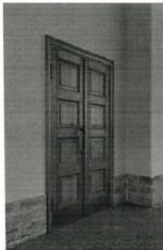
9. Дверное заполнение в воротном проезде
