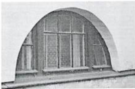
6. Восточный фасад. Фрагмент.
