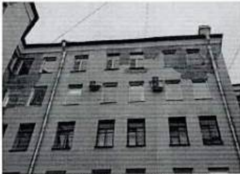
Фото 41. Восточный дворовой фасад. Дополнительное оборудование
