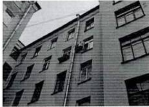
Фото 42. Восточный дворовой фасад. Дополнительное оборудование
