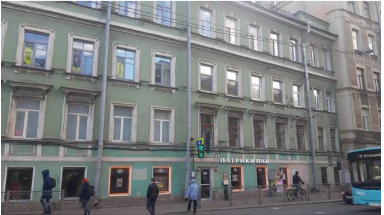
39. «Доходный дом» (в составе «Дома Н.Ф.Крупенникова») (Куйбышева ул., д. 33/8, лит. А) (угловой корпус). Лицевой фасад (фрагмент). Фото мест установки оборудования и прокладки кабельных трасс. Штиглиц М.С. 22.04.2026 г.
