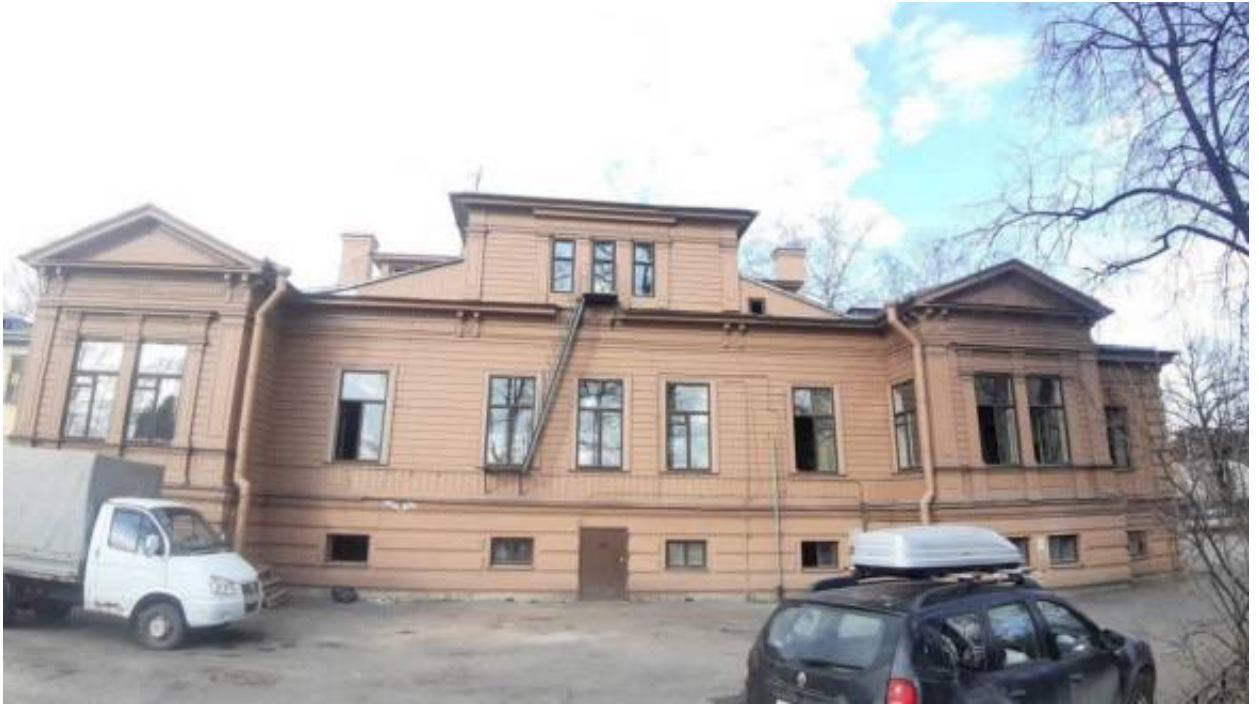
5. «Особняк В.И.Гота» (Петровский пр., д. 20, корп. 3, лит. А). Фасад со стороны двора. Штиглиц М.С. 22.04.2026 г.
