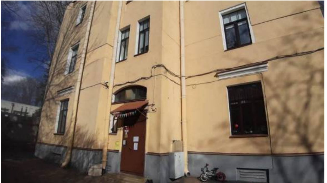
33. «Особняк Михина с участком парка и оградой» (1-я Берёзовая аллея, д. 5, лит.А). Боковой фасад (фрагмент). Фото мест установки оборудования и прокладки кабельных трасс. Штиглиц М.С. 22.04.2026 г.
