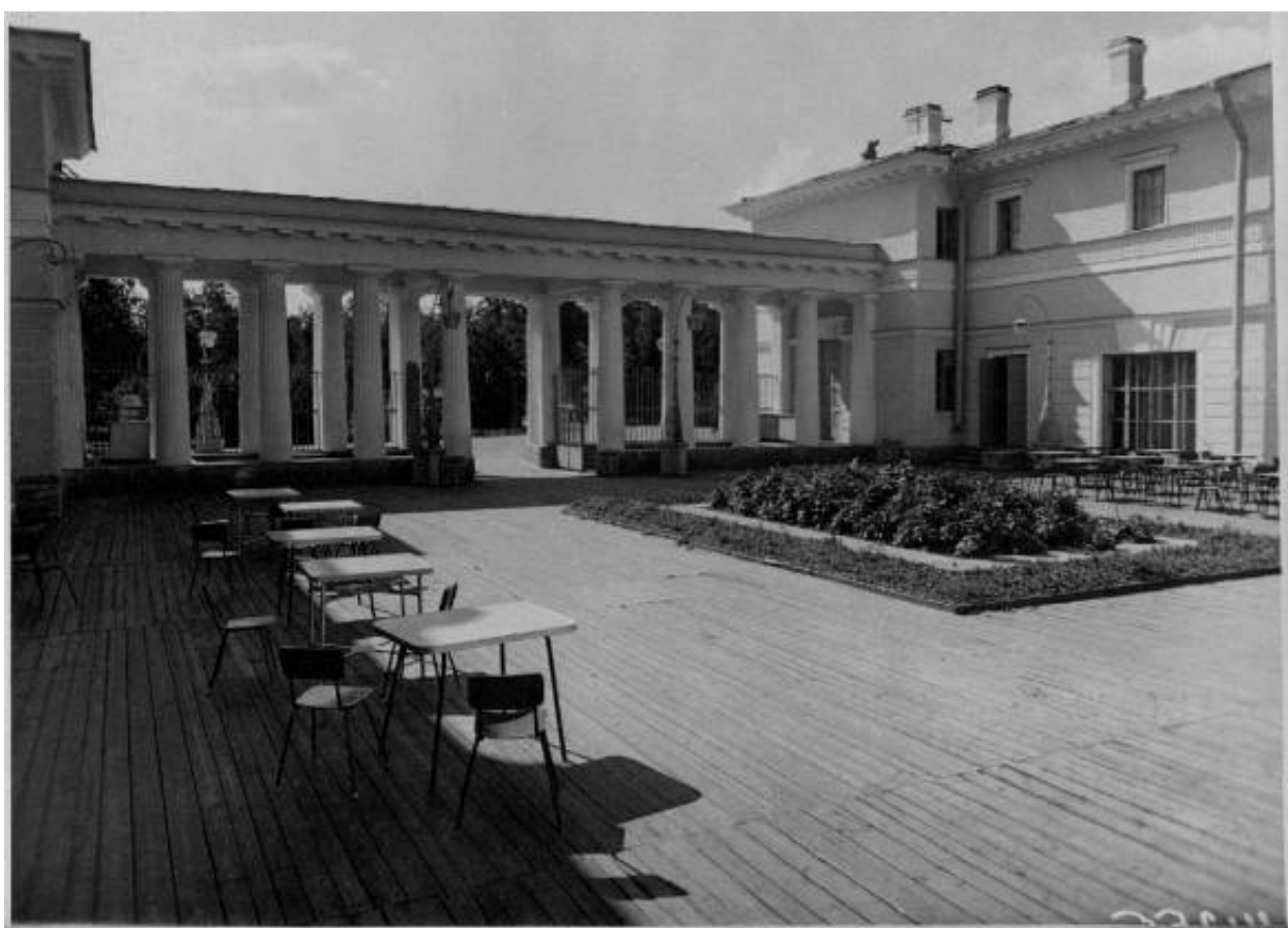
56. «Корпус конюшенный» (в составе «Ансамбль Елагина острова») (Елагин остров, д. 4, лит. Д). Вид на колоннаду лицевого фасада со стороны внутреннего двора. Фото 1968. Архив КГИОП. Паспорт 98-3_83 П. «Конюшенный корпус Елагина дворца».
