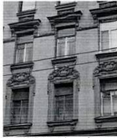
Фото 12. Лицевой фасад. Фрагмент
