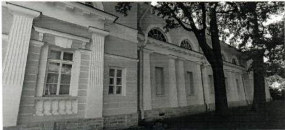
13. Восточный фасад. Фрагмент
