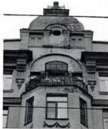
Фото 8. Лицевой фасад. Завершение центрального эркера в виде балкона, купол
