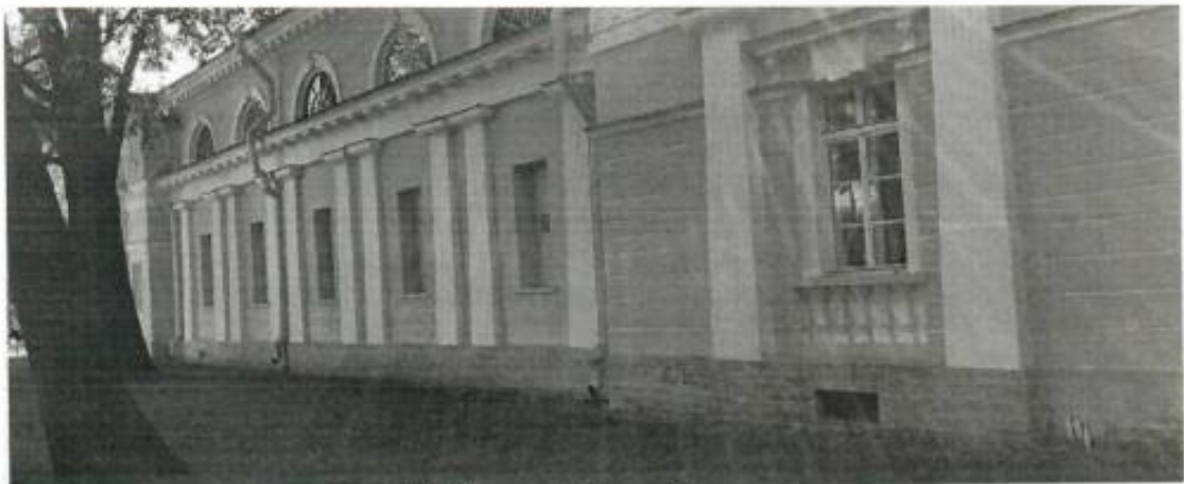
14. Восточный фасад. Фрагмент
