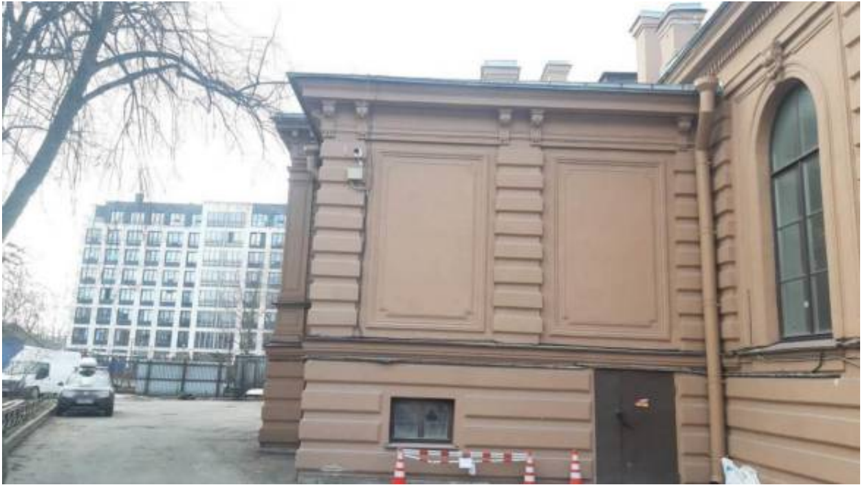
3. «Особняк В.И.Гота» (Петровский пр., д. 20, корп. 3, лит. А). Лицевой фасад (фрагмент). Фото мест установки оборудования и прокладки кабельных трасс. Штиглиц М.С. 22.04.2026 г.
