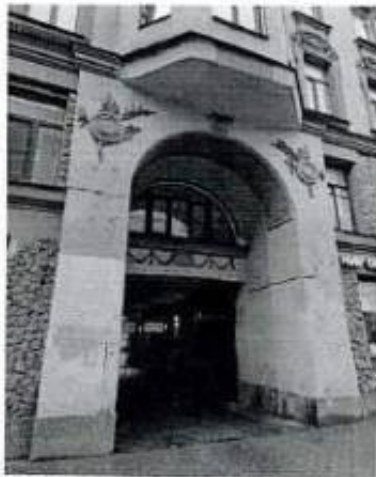
Фото 7. Лицевой фасад. Арка въездных ворот
