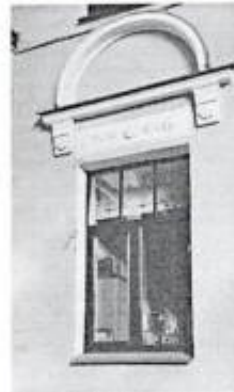
7. Южный фасад. Фрагмент.
