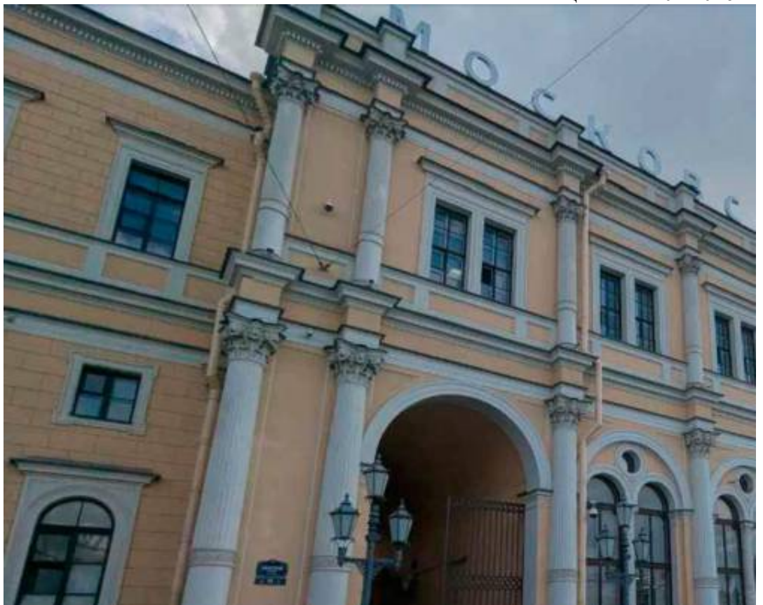
50. «Вокзал Николаевский (Московский)» (Невский пр., д. 85, лит. А). Лицевой фасад (фрагмент). Фото мест установки оборудования и прокладки кабельных трасс. Штиглиц М.С. 22.04.2026 г.
