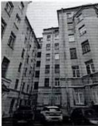
Фото 26. Западный фасад внутреннего двора. Фрагмент
