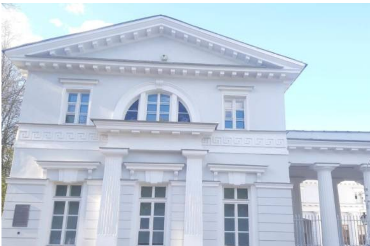
53. «Корпус конюшенный» (в составе «Ансамбль Елагина острова») (Елагин остров, д. 4, лит. Д). Лицевой фасад. Фото мест установки оборудования и прокладки кабельных трасс. Штиглиц М.С. 22.04.2025.
