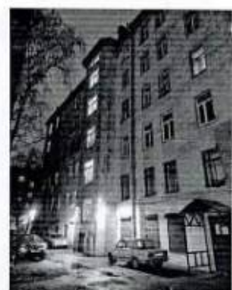
Фото 50. Южный дворовой фасад. Фрагмент
