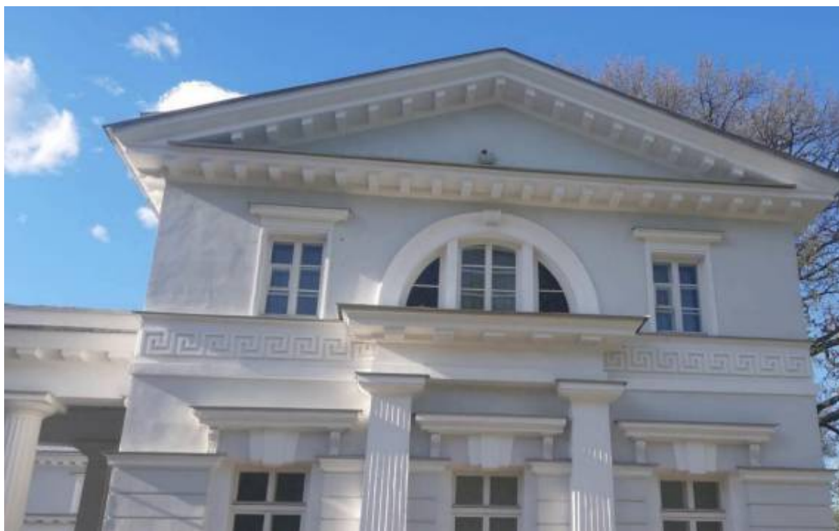
52. «Корпус конюшенный» (в составе «Ансамбль Елагина острова») (Елагин остров, д. 4, лит. Д). Лицевой фасад (фрагмент). Фото мест установки оборудования и прокладки кабельных трасс. Штиглиц М.С. 22.04.2025.
