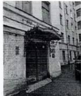
Фото 31. Южный фасад внутреннего двора. Фрагмент Вход на лестницу Л5
