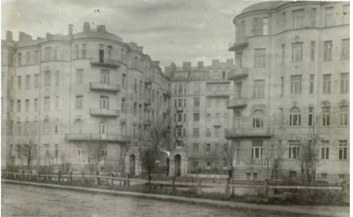
26. «Дом Второго Санкт-Петербургского товарищества для устройства постоянных квартир с курдонером» (в составе «Дом Второго Санкт-Петербургского товарищества для устройства постоянных квартир с курдонером, палисадником и оградой») (наб. реки Карповки, д. 19, лит. А). 1912 - 1913. Наб. реки Карповки, 19. pastvu.com .
