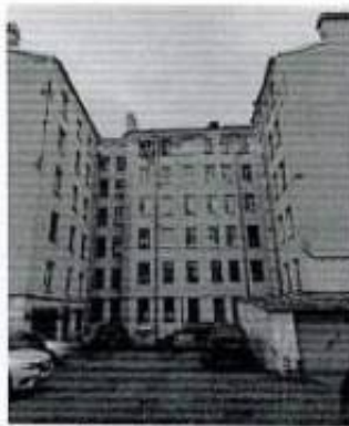
Фото 46. Восточный дворовой фасад. Фрагмент
