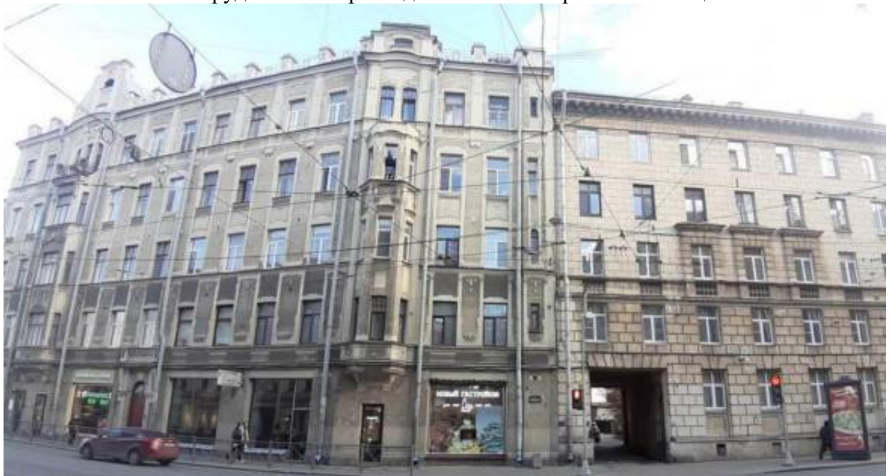
40. «Доходный дом» (в составе «Дома Н.Ф.Крупенникова») (Куйбышева ул., д. 33/8, лит. А) (корпус по улице). Лицевой фасад по Куйбышева ул. Штиглиц М.С. 22.04.2026 г.
