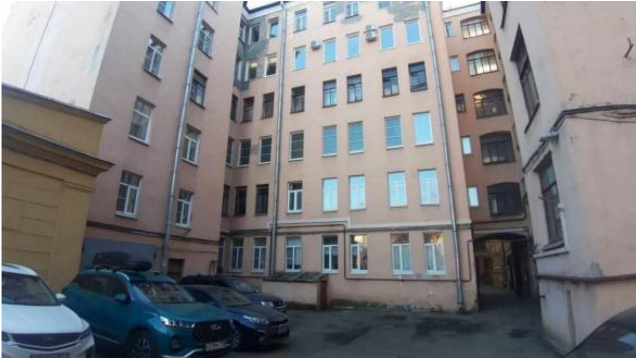
19. «Доходный дом В.Я. Рожкова» (Большая Монетная ул., д. 23, лит. А). Дворовый фасад фрагмент). Фото мест установки оборудования и прокладки кабельных трасс. Штиглиц М.С. 22.04.2026 г.
