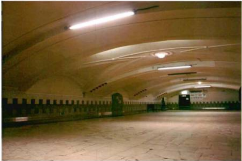
Фото №7. Цокольный этаж.
