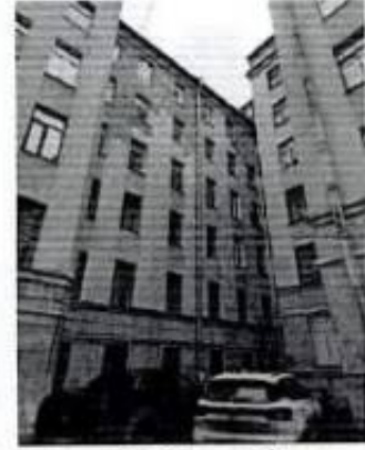
Фото 28. Южный фасад внутреннего двора. Фрагмент
