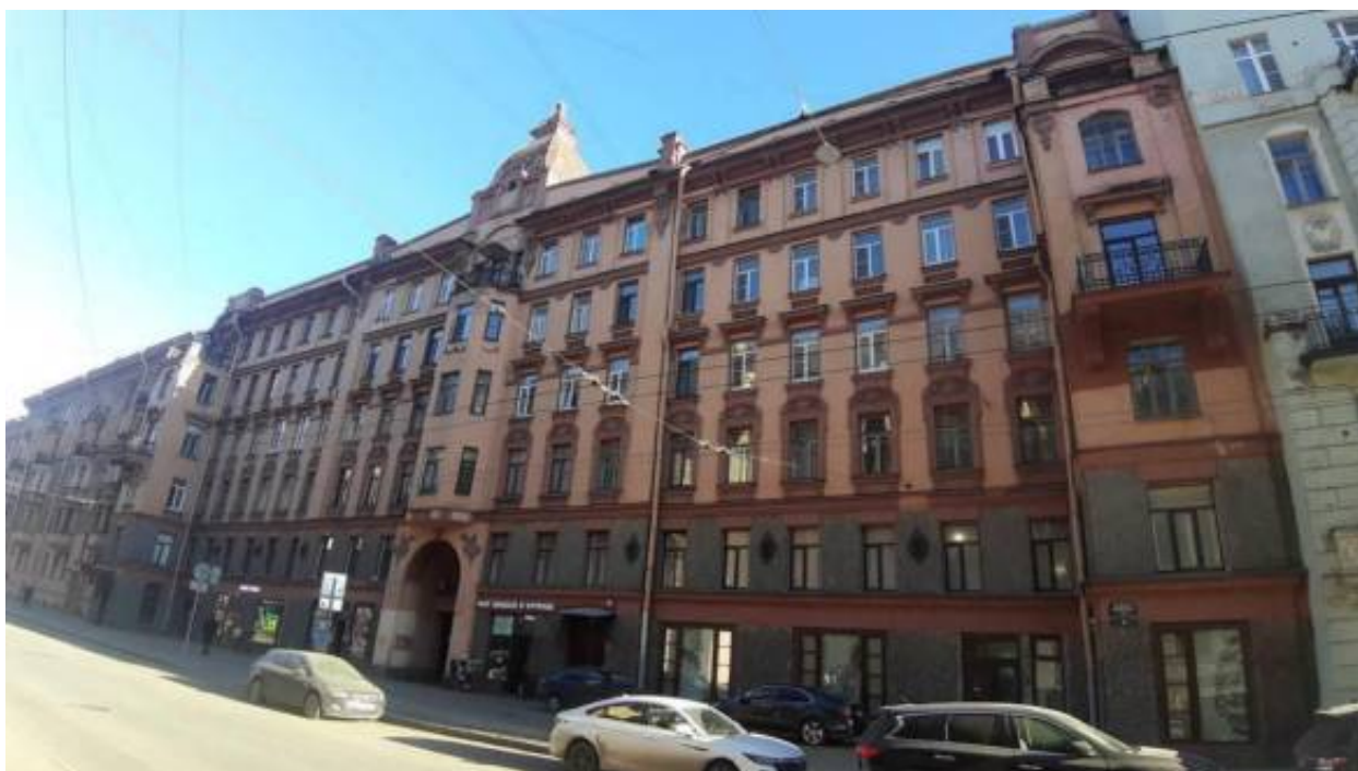
17. «Доходный дом В.Я. Рожкова» (Большая Монетная ул., д. 23, лит. А). Лицевой фасад. Штиглиц М.С. 22.04.2026 г.
