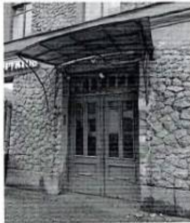
Фото 13. Вход на лестницу Л1 с историческим дверным заполнением
