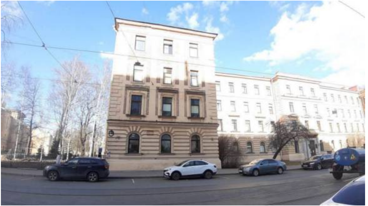
29. «Институт медицинский женский. Здесь преподавали Бехтерев В.В., Ланч Г.Ф., Орбели А.А., Павлов И.П., в 1917 г. состоялась VII (Апрельская) конференция РСДРП (б)» (Льва Толстого ул., 6-8, лит. А). Лицевой фасад (фрагмент). Фото мест установки оборудования и прокладки кабельных трасс. Штиглиц М.С. 22.04.2026 г.
