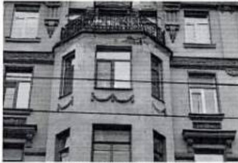
Фото 9. Лицевой фасад. Фрагмент центрального эркера
