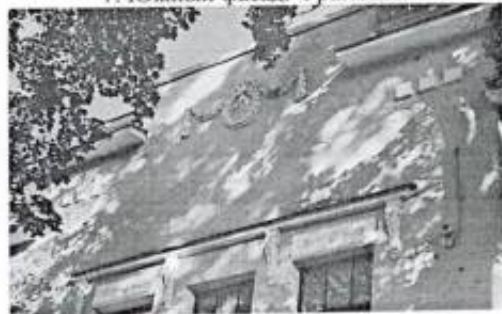
9. Южный фасад. Фрагмент.
