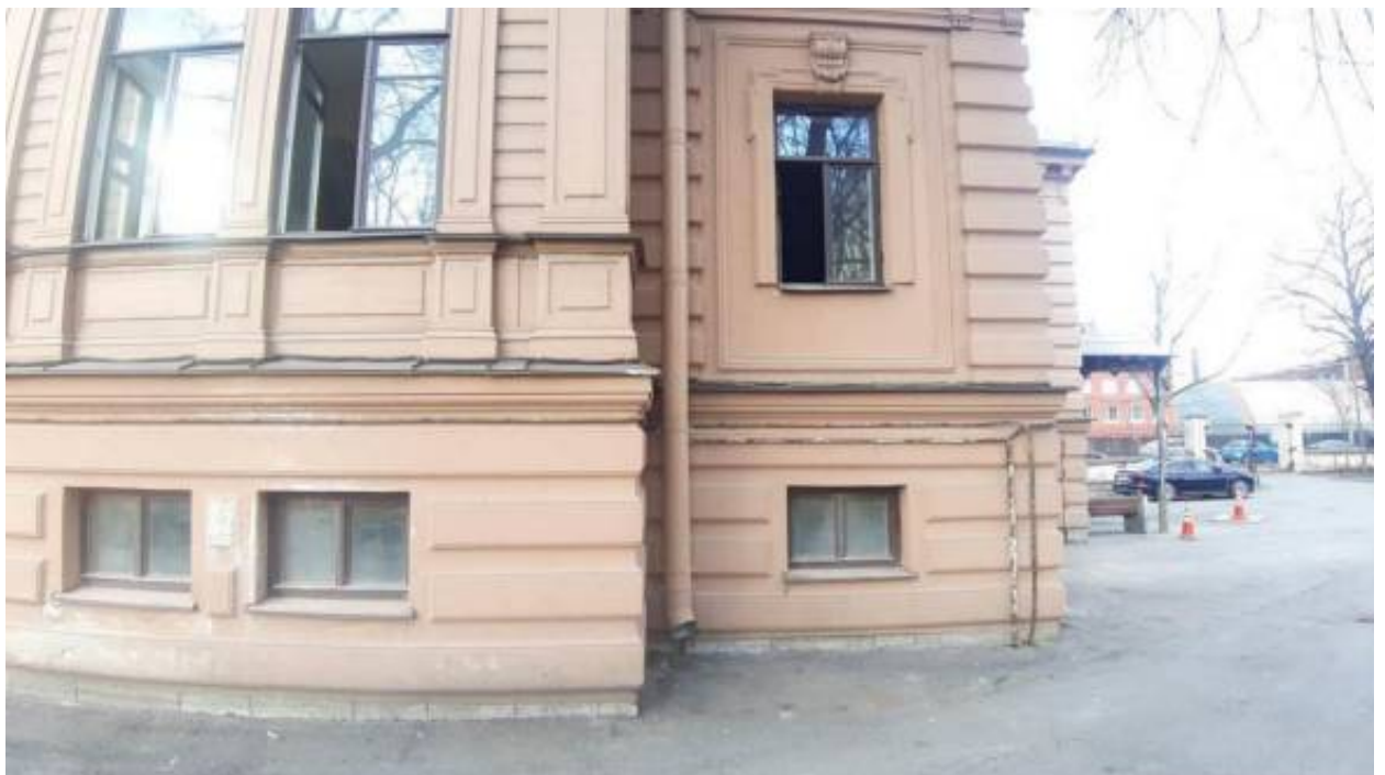
4. «Особняк В.И.Гота» (Петровский пр., д. 20, корп. 3, лит. А). Лицевой фасад (фрагмент). Фото мест установки оборудования и прокладки кабельных трасс. Штиглиц М.С. 22.04.2026 г.
