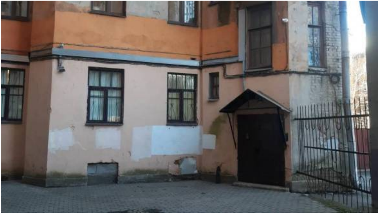
13. «Дом Второго Санкт-Петербургского товарищества для устройства постоянных квартир с курдонером» (в составе «Дом Второго Санкт-Петербургского товарищества для устройства постоянных квартир с курдонером, палисадником и оградой») (наб. реки Карповки, д. 19, лит. А). Фото мест установки оборудования и прокладки кабельных трасс. Штиглиц М.С. 22.04.2026 г.
