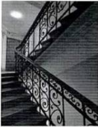
Фото 70. Лестница Л3. Фрагмент
