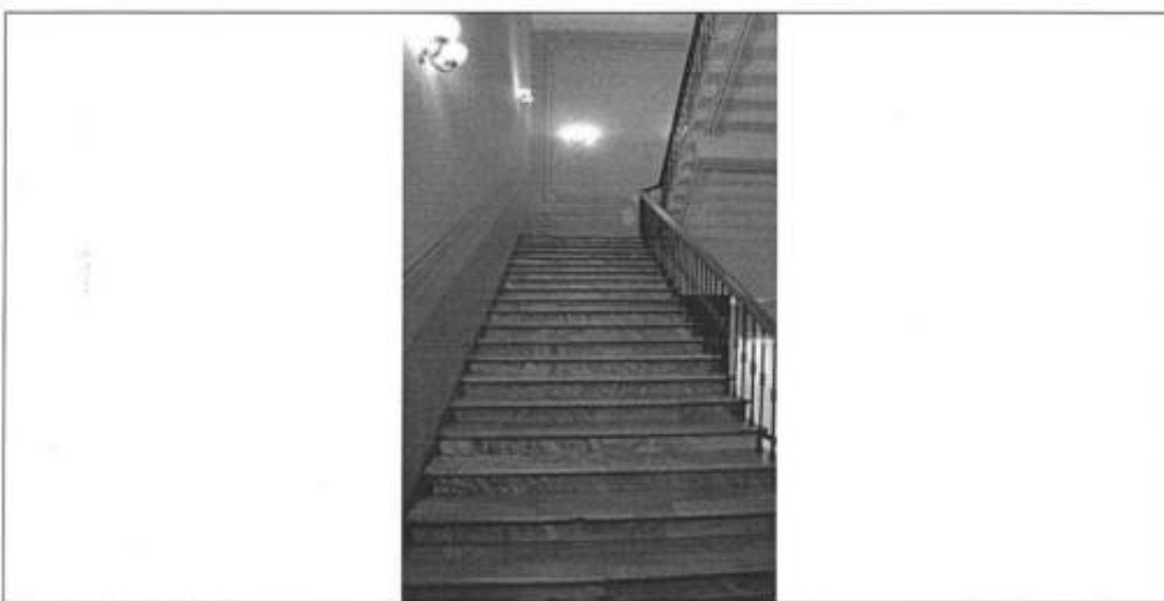
Фотография 11. Лестница Л-3
