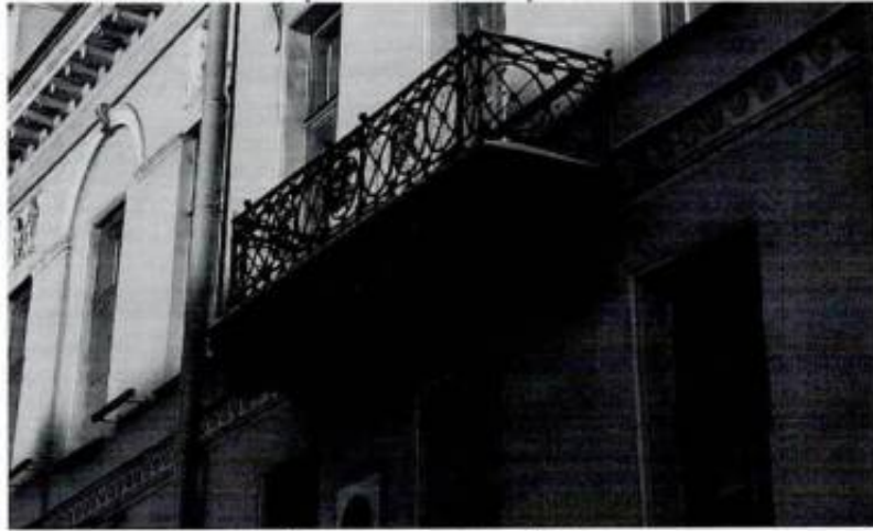
Фрагмент лицевого фасада
