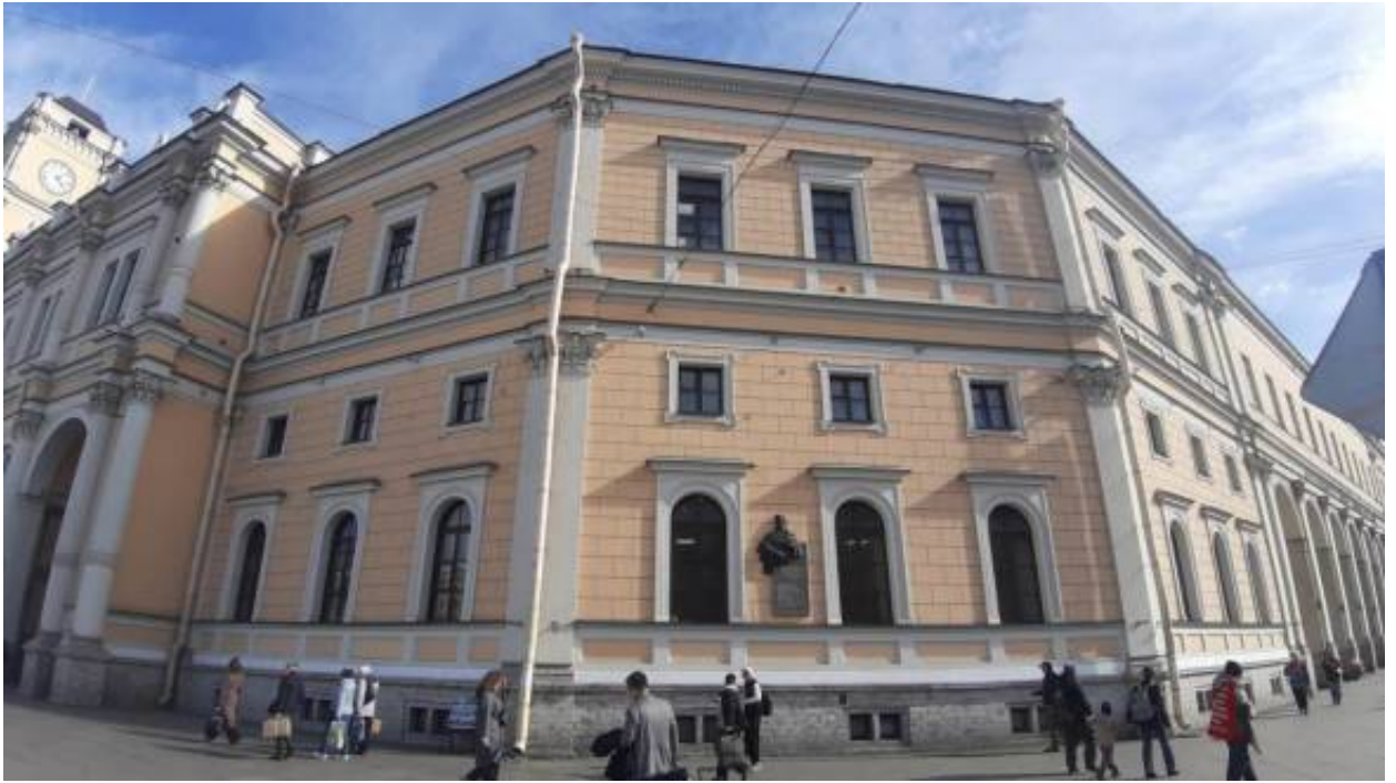
47. «Вокзал Николаевский (Московский)» (Невский пр., д. 85, лит. А). Лицевой фасад (фрагмент). Фото мест установки оборудования и прокладки кабельных трасс. Штиглиц М.С. 22.04.2026 г.
