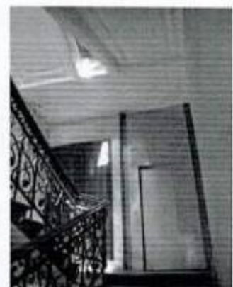
Фото 66. Лестница Л2. Фрагмент
