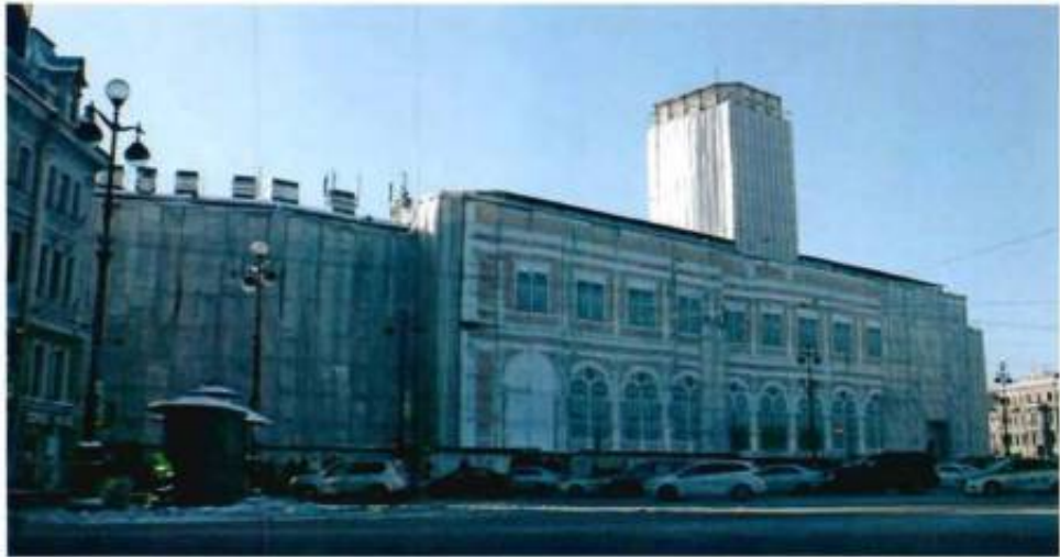
Фото №1. Вид на северный (парадный) фасад со стороны Невского проспекта.
