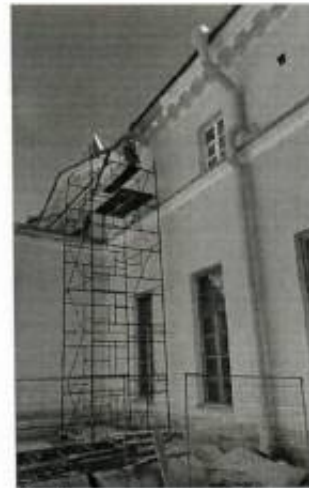
10. Фрагмент южного фасада полукруглого двора
