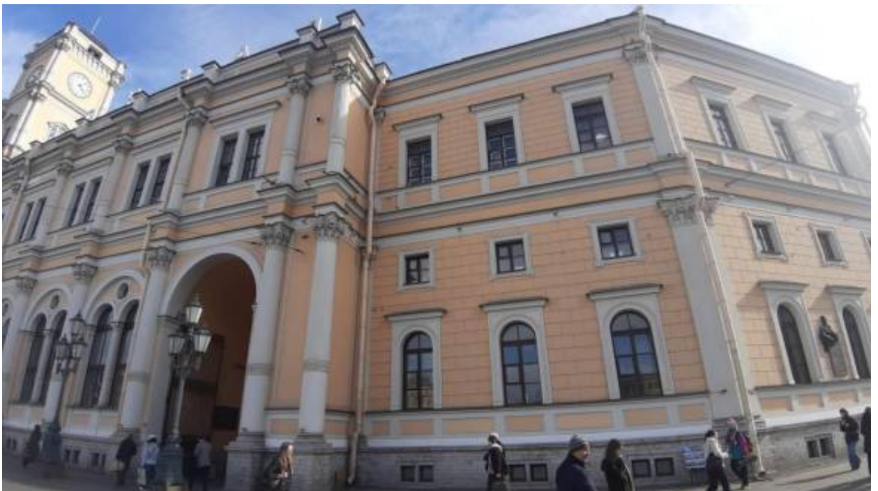
48. «Вокзал Николаевский (Московский)» (Невский пр., д. 85, лит. А). Лицевой фасад (фрагмент). Фото мест установки оборудования и прокладки кабельных трасс. Штиглиц М.С. 22.04.2026 г.
