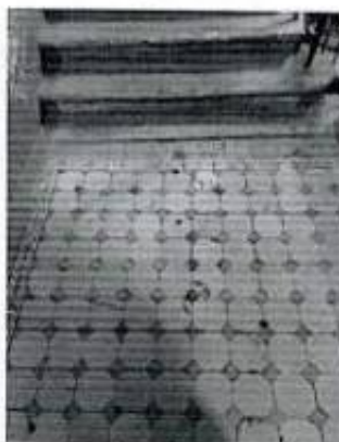
Фото 68. Лестница Л3. Фрагмент
