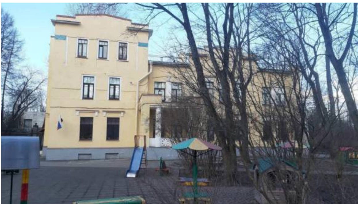
31. «Особняк Михина с участком парка и оградой» (1-я Берёзовая аллея, д. 5, лит.А). Лицевой фасад. Штиглиц М.С. 22.04.2026 г.
