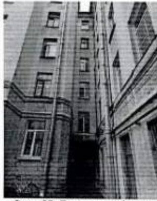
Фото 32. Восточный фасад внутреннего двора. Фрагмент
