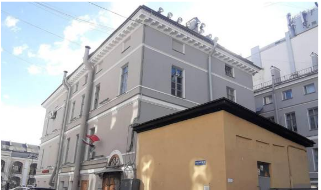
44. «Дом жилой» (в составе объекта культурного наследия федерального значения «Церковь армянская святой Екатерины») (Невский пр., д. 40-42, лит. А). Боковой и дворовый фасады. Фото мест установки оборудования и прокладки кабельных трасс. Штиглиц М.С. 22.04.2026 г.
