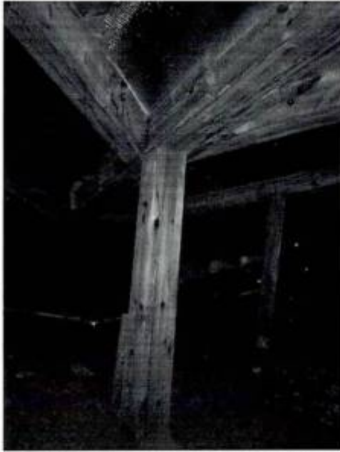
Фрагмент чердака: стропильная система
