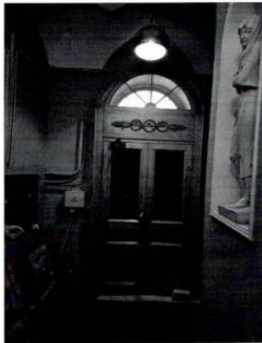
Фрагмент интерьеров: заполнение тамбура парадного входа
