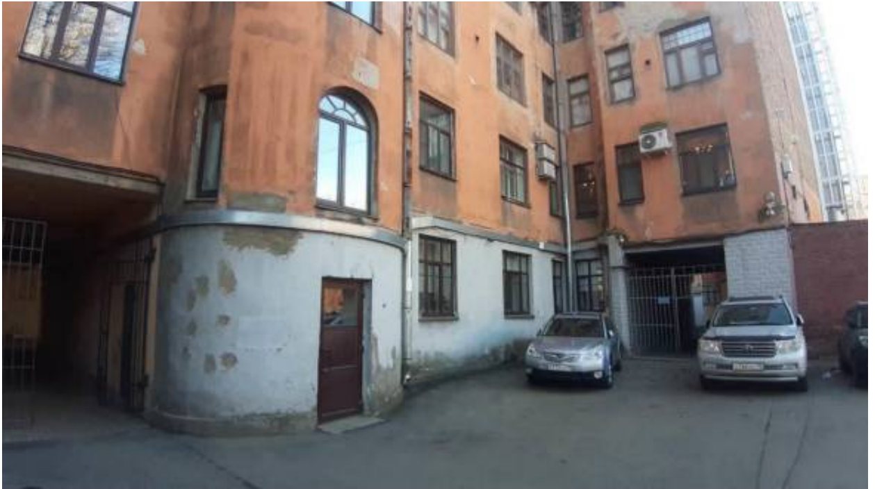
15. «Дом Второго Санкт-Петербургского товарищества для устройства постоянных квартир с курдонером» (в составе «Дом Второго Санкт-Петербургского товарищества для устройства постоянных квартир с курдонером, палисадником и оградой») (наб. реки Карповки, д. 19, лит. А). Фото мест установки оборудования и прокладки кабельных трасс. Штиглиц М.С. 22.04.2026 г.
