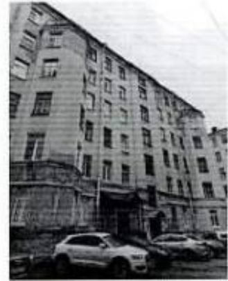
Фото 25. Западный фасад внутреннего двора. Фрагмент
