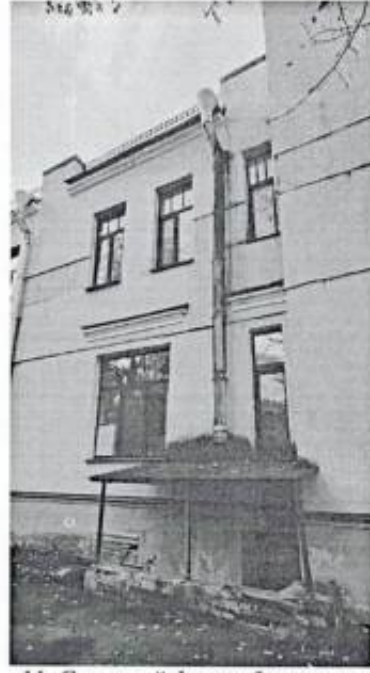
11. Северный фасад. Фрагмент.
