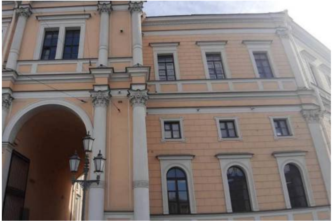
49. «Вокзал Николаевский (Московский)» (Невский пр., д. 85, лит. А). Лицевой фасад (фрагмент). Фото мест установки оборудования и прокладки кабельных трасс. Штиглиц М.С. 22.04.2026 г.
