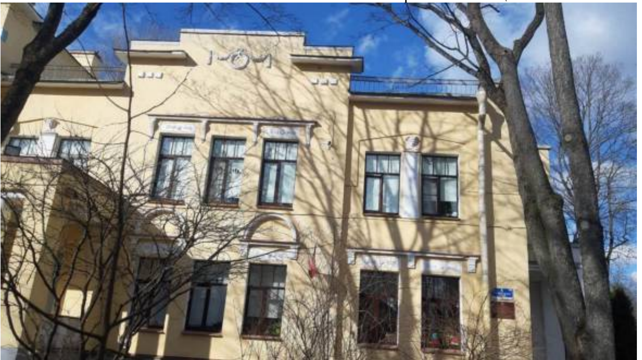
34. «Особняк Михина с участком парка и оградой» (1-я Берёзовая аллея, д. 5, лит.А). Лицевой фасад (фрагмент). Фото мест установки оборудования и прокладки кабельных трасс. Штиглиц М.С. 22.04.2026 г.
