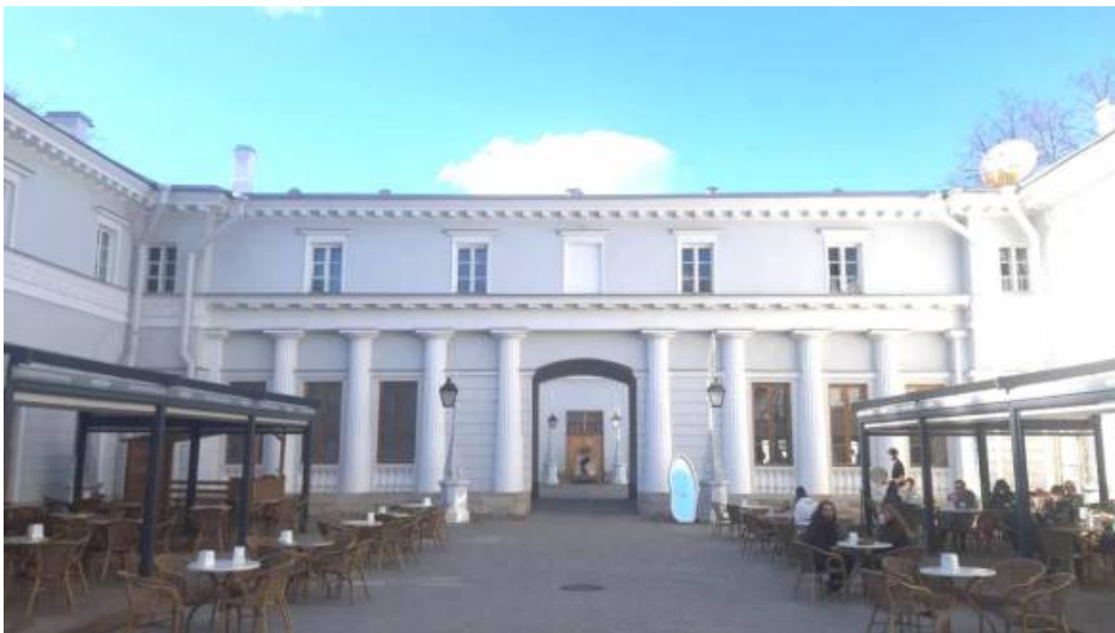
55. «Корпус конюшенный» (в составе «Ансамбль Елагина острова») (Елагин остров, д. 4, лит. Д). Внутренний двор. Штиглиц М.С. 22.04.2025.
