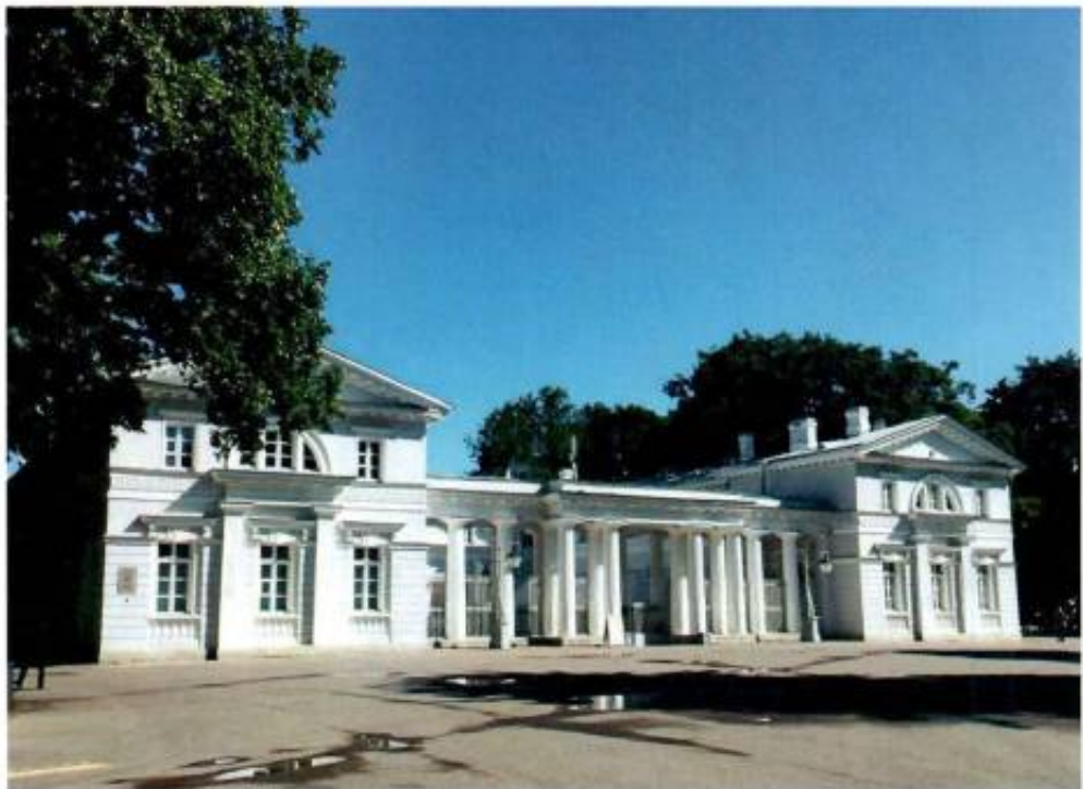
1. «корпус конюшенный». Вид с южной стороны.
