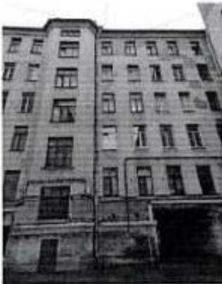
Фото 23. Северный фасад внутреннего двора
