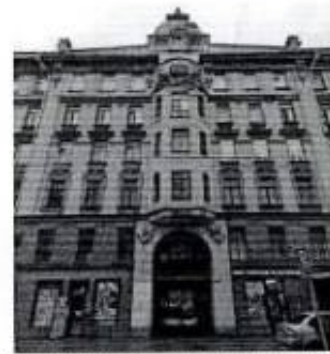
Фото 2. Лицевой фасад. Арка въездных ворот, эркер и купол по центральной оси фасада
