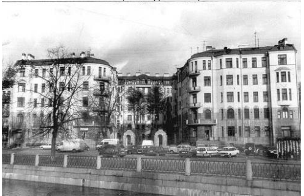
29. «Дом Второго Санкт-Петербургского товарищества для устройства постоянных квартир с курдонером» (в составе «Дом Второго Санкт-Петербургского товарищества для устройства постоянных квартир с курдонером, палисадником и оградой») (наб. реки Карповки, д. 19, лит. А). 1999 (25).
