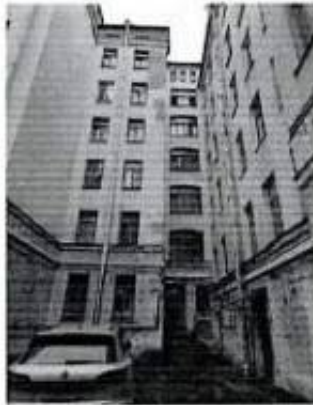
Фото 24. Западный фасад внутреннего двора. Фрагмент
