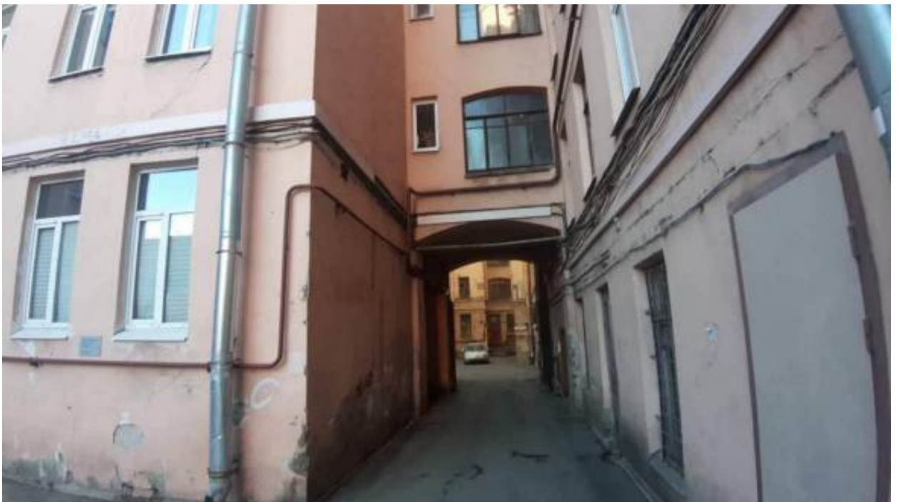
20. «Доходный дом В.Я. Рожкова» (Большая Монетная ул., д. 23, лит. А). Дворовый фасад фрагмент). Фото мест установки оборудования и прокладки кабельных трасс. Штиглиц М.С. 22.04.2026 г.
