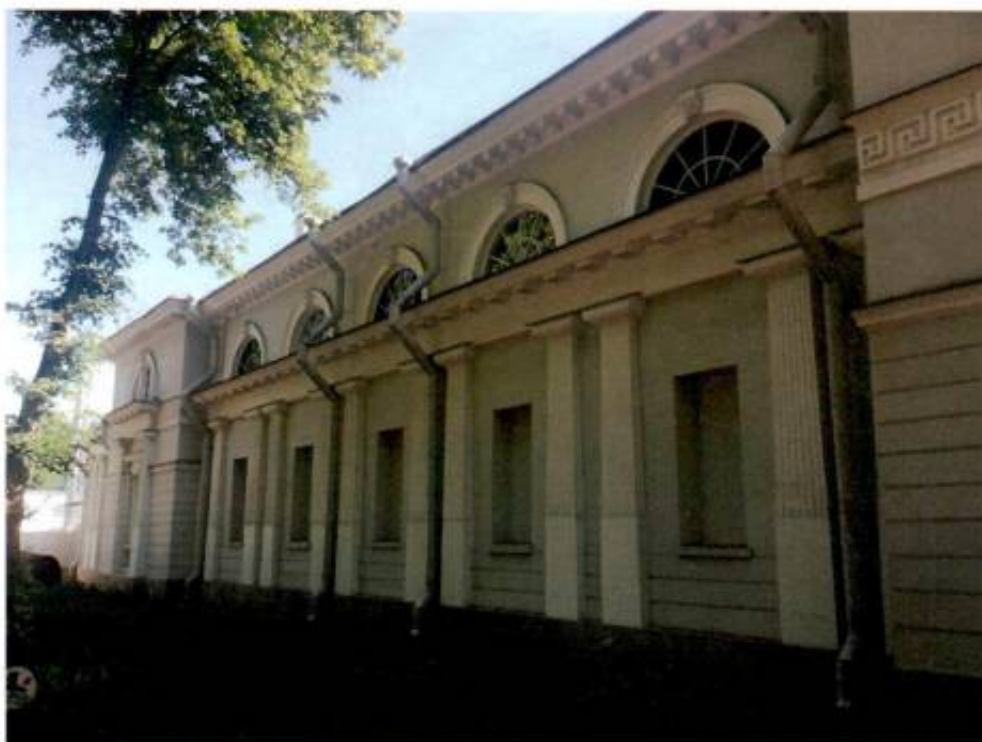
2. «корпус конюшенный». Вид с западной стороны.
