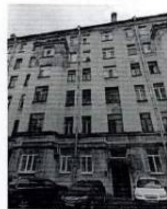
Фото 34. Восточный фасад внутреннего двора. Фрагмент
