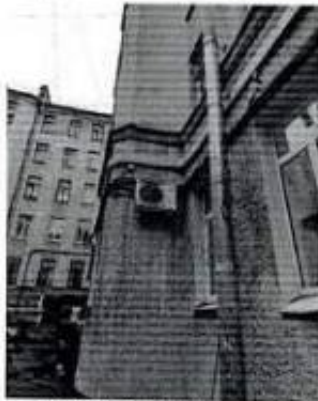
Фото 35. Восточный фасад внутреннего двора. Дополнительное оборудование
