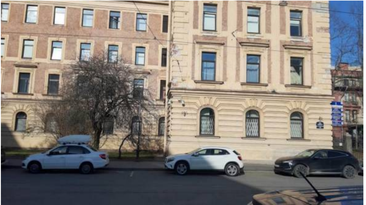
27. «Институт медицинский женский. Здесь преподавали Бехтерев В.В., Ланч Г.Ф., Орбели А.А., Павлов И.П., в 1917 г. состоялась VII (Апрельская) конференция РСДРП (б)» (Льва Толстого ул., 6-8, лит. А). Лицевой фасад (фрагмент). Фото мест установки оборудования и прокладки кабельных трасс. Штиглиц М.С. 22.04.2026 г.
