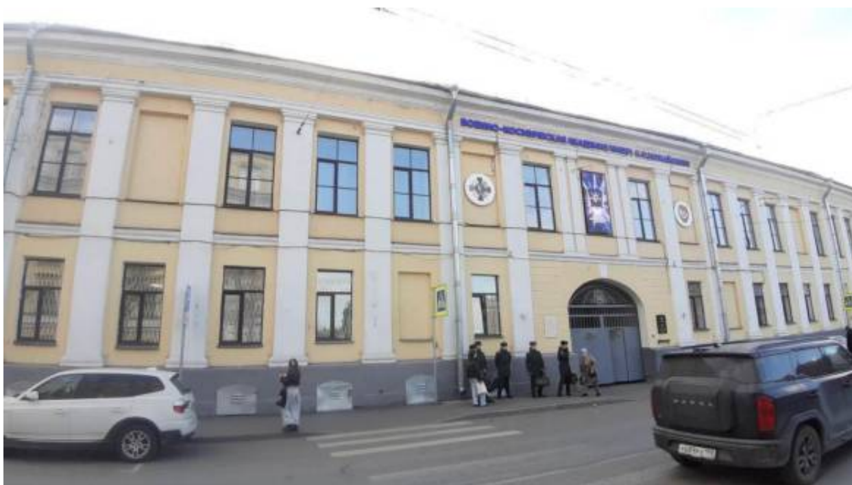
22. «Главное здание» (в составе «Корпус Кадетский Второй») (Ждановская ул., д. 13, лит. А). Лицевой фасад по Красного Курсанта ул. (фрагмент). Фото мест установки оборудования и прокладки кабельных трасс. Штиглиц М.С. 02.04.2026 г.
