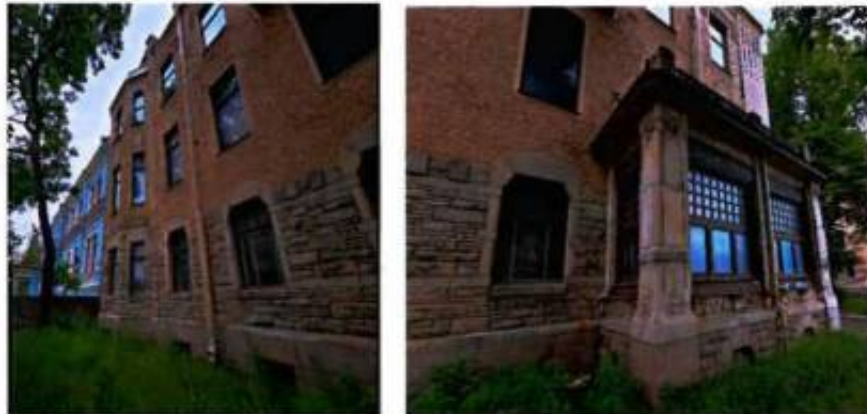
Фото 6, 7 Фрагмент объекта культурного наследия. Лицевой фасад западного корпуса курдонера. Фото выполнено 08.07.2025.
