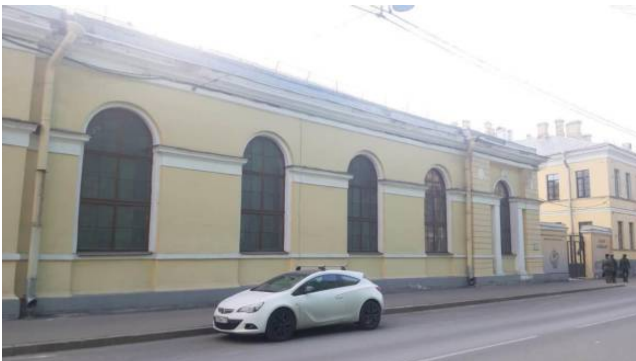
18. «Манеж» (в составе «Корпус Кадетский Второй») (Ждановская ул., д. 13, лит. А). Лицевой фасад по Красного Курсанта ул. (фрагмент). Фото мест установки оборудования и прокладки кабельных трасс. Штиглиц М.С. 02.04.2026 г.
