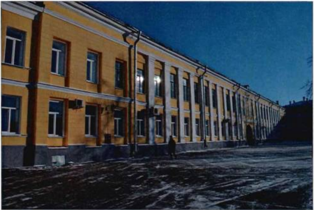
4. Общий вид лицевого корпуса дворового фасада с запада.
