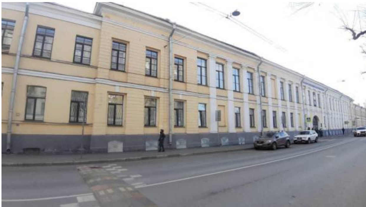
21. «Главное здание» (в составе «Корпус Кадетский Второй») (Ждановская ул., д. 13, лит. А). Лицевой фасад по Красного Курсанта ул. (фрагмент). Фото мест установки оборудования и прокладки кабельных трасс. Штиглиц М.С. 02.04.2026 г.
