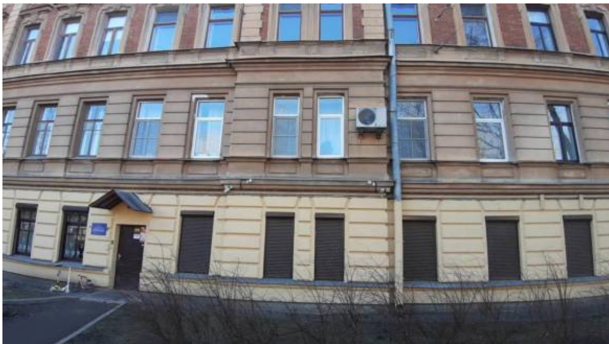
9. «Дом дешевых квартир Императорского человеколюбивого общества» (Большая Зеленина ул., д. 13, лит. А). Лицевой фасад из Ораниенбаумского сада (фрагмент). Фото мест установки оборудования и прокладки кабельных трасс. Штиглиц М.С. 02.04.2026 г.
