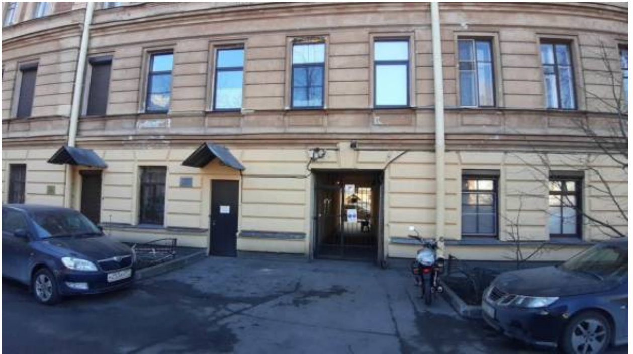
13. «Дом дешевых квартир Императорского человеколюбивого общества» (Большая Зеленина ул., д. 13, лит. А). Лицевой фасад. Фото мест установки оборудования и прокладки кабельных трасс. Штиглиц М.С. 02.04.2026 г.
