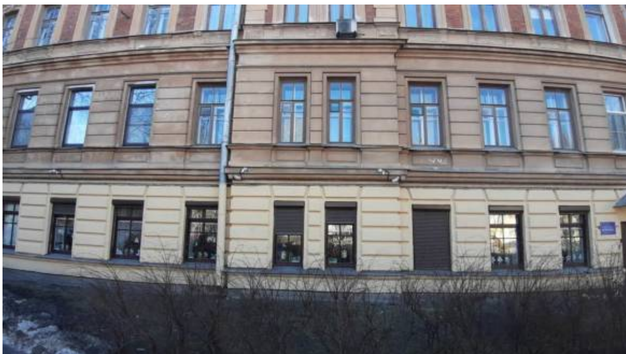
10. «Дом дешевых квартир Императорского человеколюбивого общества» (Большая Зеленина ул., д. 13, лит. А). Лицевой фасад из Ораниенбаумского сада (фрагмент). Фото мест установки оборудования и прокладки кабельных трасс. Штиглиц М.С. 02.04.2026 г.
