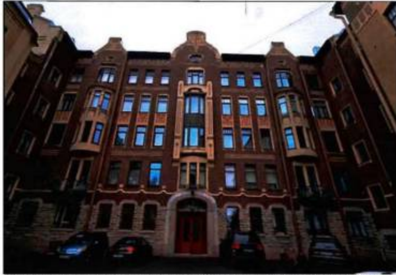
Фото 5 Общий вид на центральный корпус объекта культурного наследия со стороны курдонера. Фото выполнено 08.07.2025.
