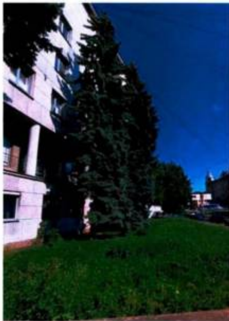
Фото 22. Фрагмент территории объекта культурного наследия. Вид с востока (дата съемки 22.07.2025).
