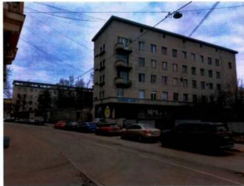
Фото 2. Общий вид на объект культурного наследия с северо-западной стороны (дата съемки 03.04.2025).
