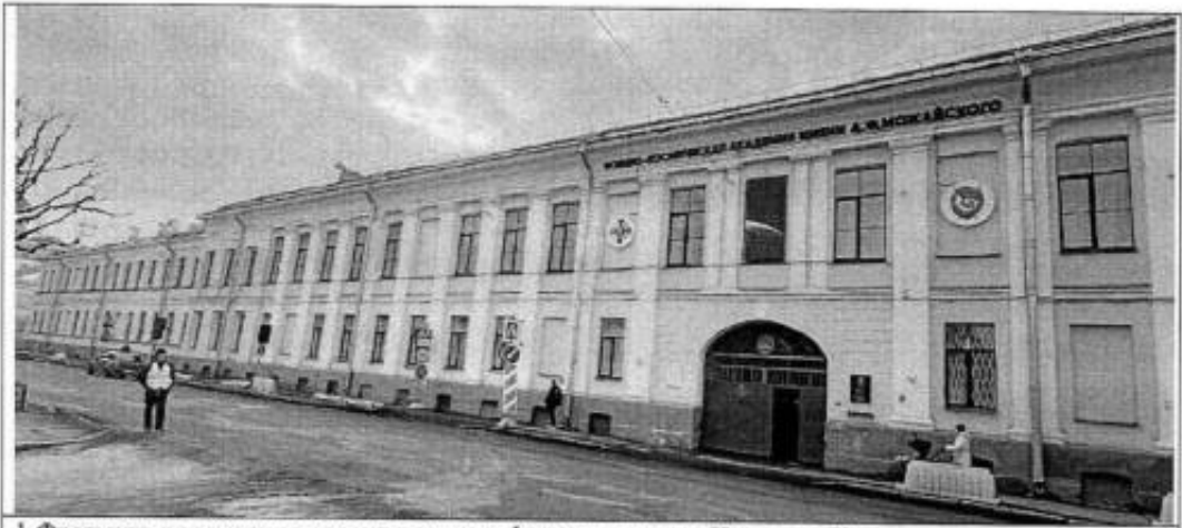
1. Фрагмент лицевого северо-восточного фасада по улице Красного Курсанта.
