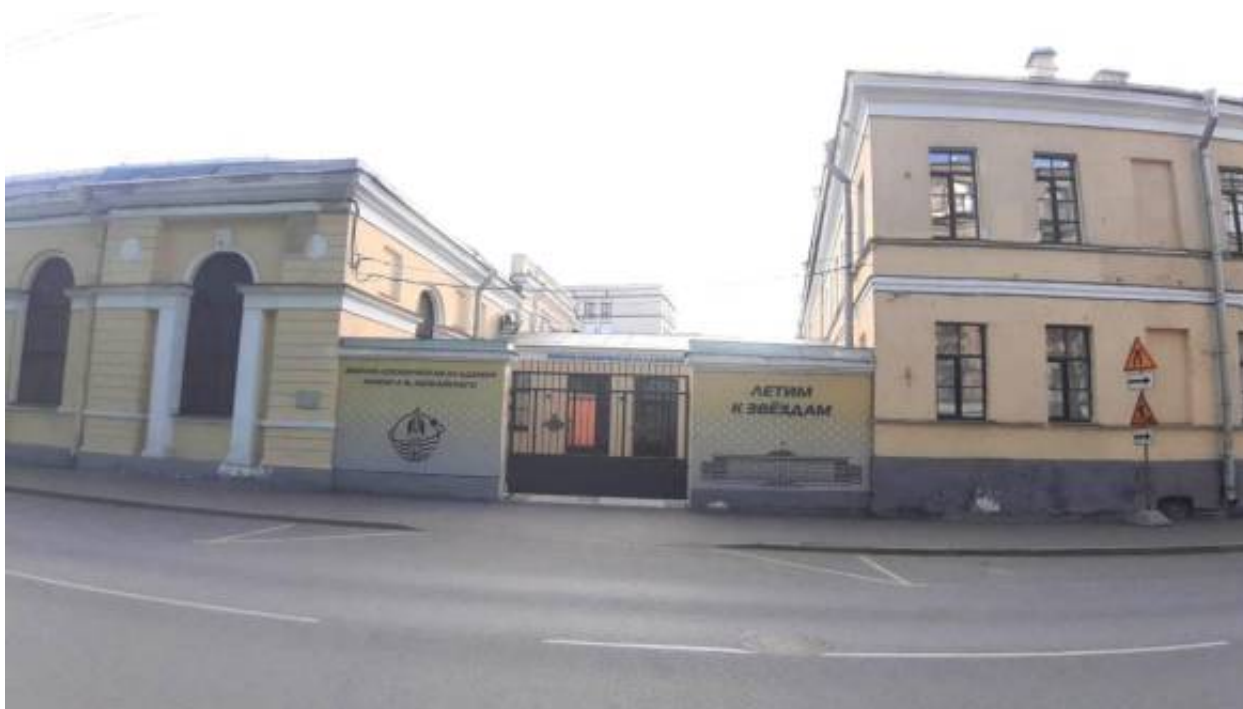
19. «Главное здание» и «Манеж» (в составе «Корпус Кадетский Второй») (Ждановская ул., д. 13, лит. А). Лицевой фасад по Красного Курсанта ул. (фрагмент). Фото мест установки оборудования и прокладки кабельных трасс. Штиглиц М.С. 02.04.2026 г.
