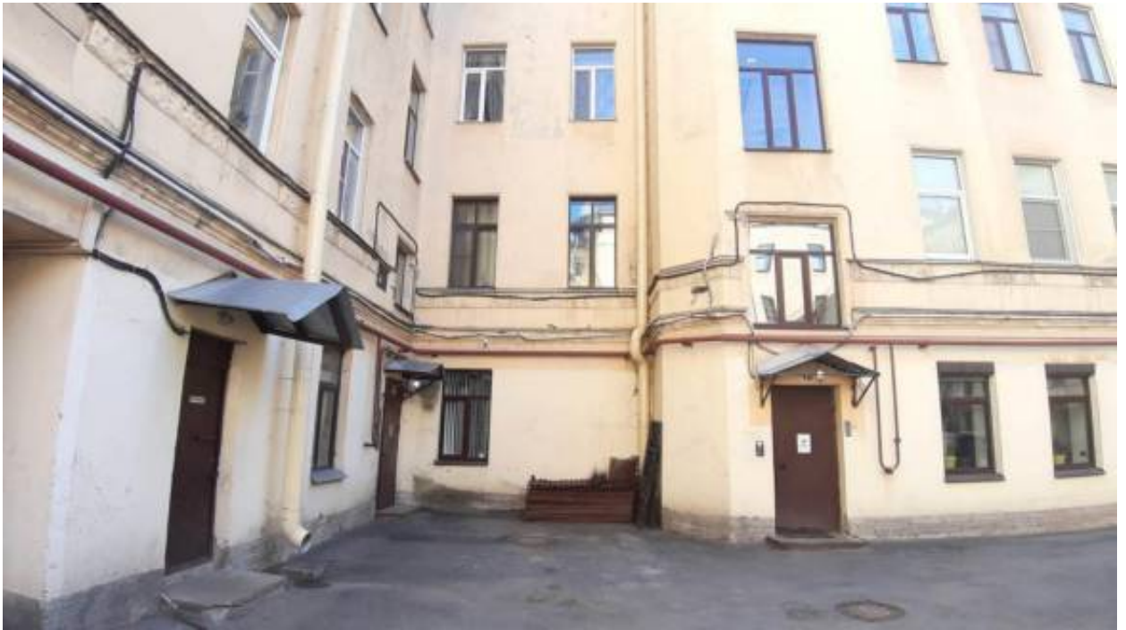
5. «Дом дешевых квартир Императорского человеколюбивого общества» (Большая Зеленина ул., д. 13, лит. А). Дворовый фасад. Фото мест установки оборудования и прокладки кабельных трасс. Штиглиц М.С. 02.04.2026 г.
