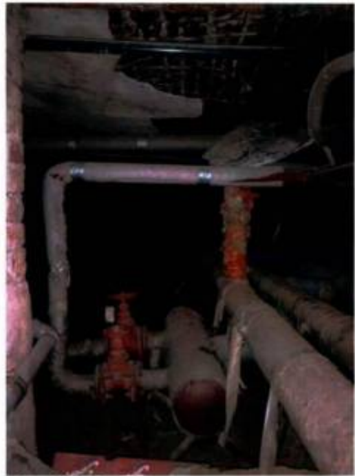
Фото 16. Общий вид подвального помещения 20-Н (ч.п. 2) объекта культурного наследия (дата съемки 02.04.2025).
