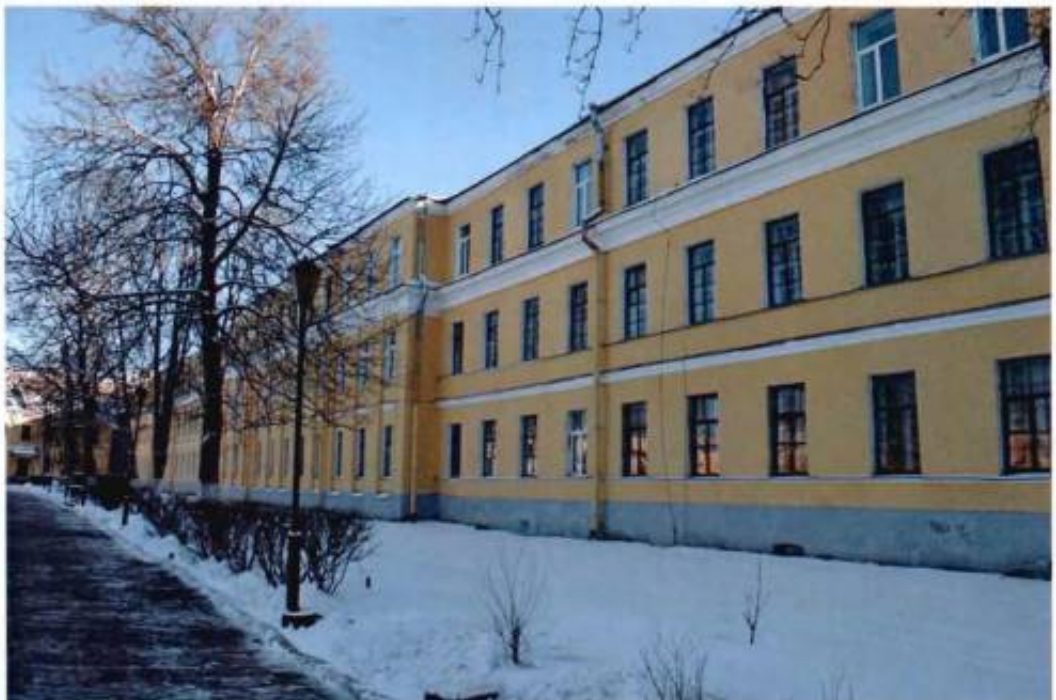
5. Общий вид западного бокового корпуса дворового фасада с востока.
