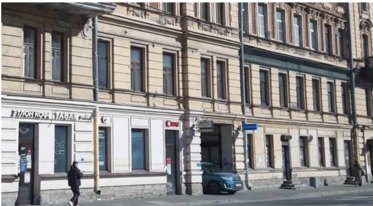
4. «Дом дешевых квартир Императорского человеколюбивого общества» (Большая Зеленина ул., д. 13, лит. А). Лицевой фасад по Большой Зеленина (фрагмент). Фото мест установки оборудования и прокладки кабельных трасс. Штиглиц М.С. 02.04.2026 г.
