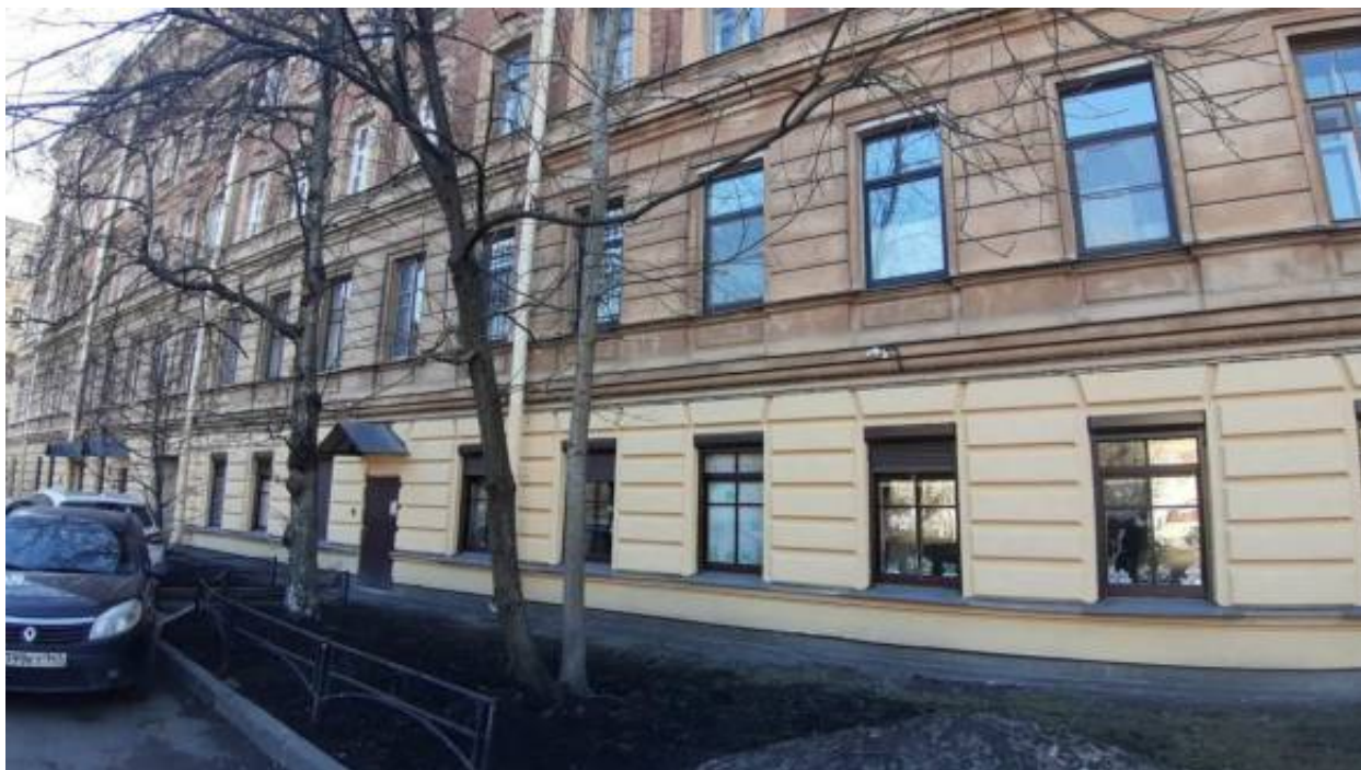
11. «Дом дешевых квартир Императорского человеколюбивого общества» (Большая Зеленина ул., д. 13, лит. А). Лицевой фасад из Ораниенбаумского сада (фрагмент). Фото мест установки оборудования и прокладки кабельных трасс. Штиглиц М.С. 02.04.2026 г.
