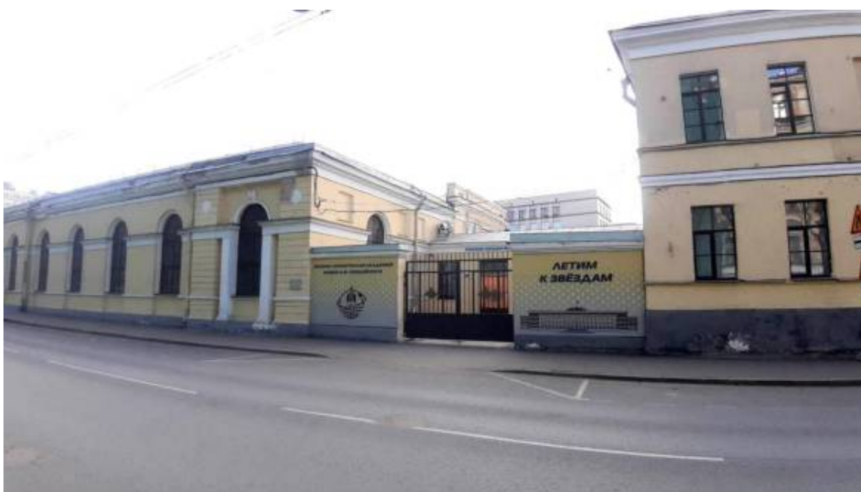
20. «Главное здание» и «Манеж» (в составе «Корпус Кадетский Второй») (Ждановская ул., д. 13, лит. А). Лицевой фасад по Красного Курсанта ул. (фрагмент). Фото мест установки оборудования и прокладки кабельных трасс. Штиглиц М.С. 02.04.2026 г.
