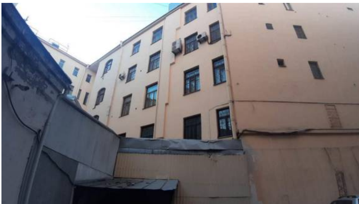
30. «Бывш. дом Лидваля» (Каменноостровский пр., д. 1-3, лит. А). Дворовый фасад. Фото мест установки оборудования и прокладки кабельных трасс. Штиглиц М.С. 02.04.2026 г.
