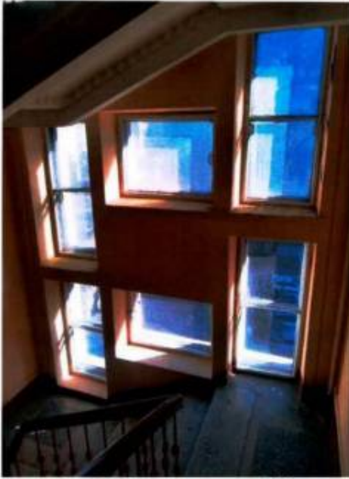
Фото 7. Лестничная клетка ЛК1 (дата съемки 02.04.2025).
