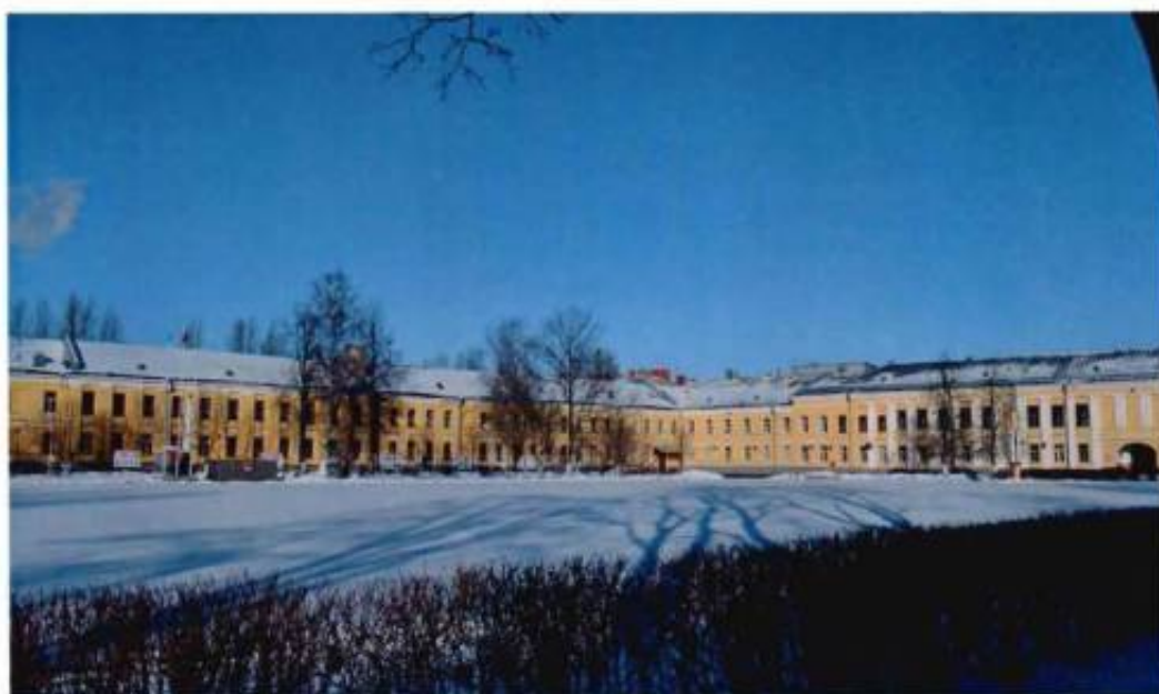
3. Общий вид дворовых фасадов с юга.
