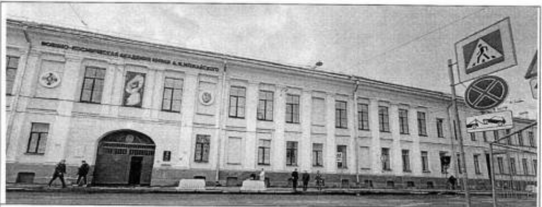
2. Фрагмент лицевого северо-восточного фасада по улице Красного Курсанта.
