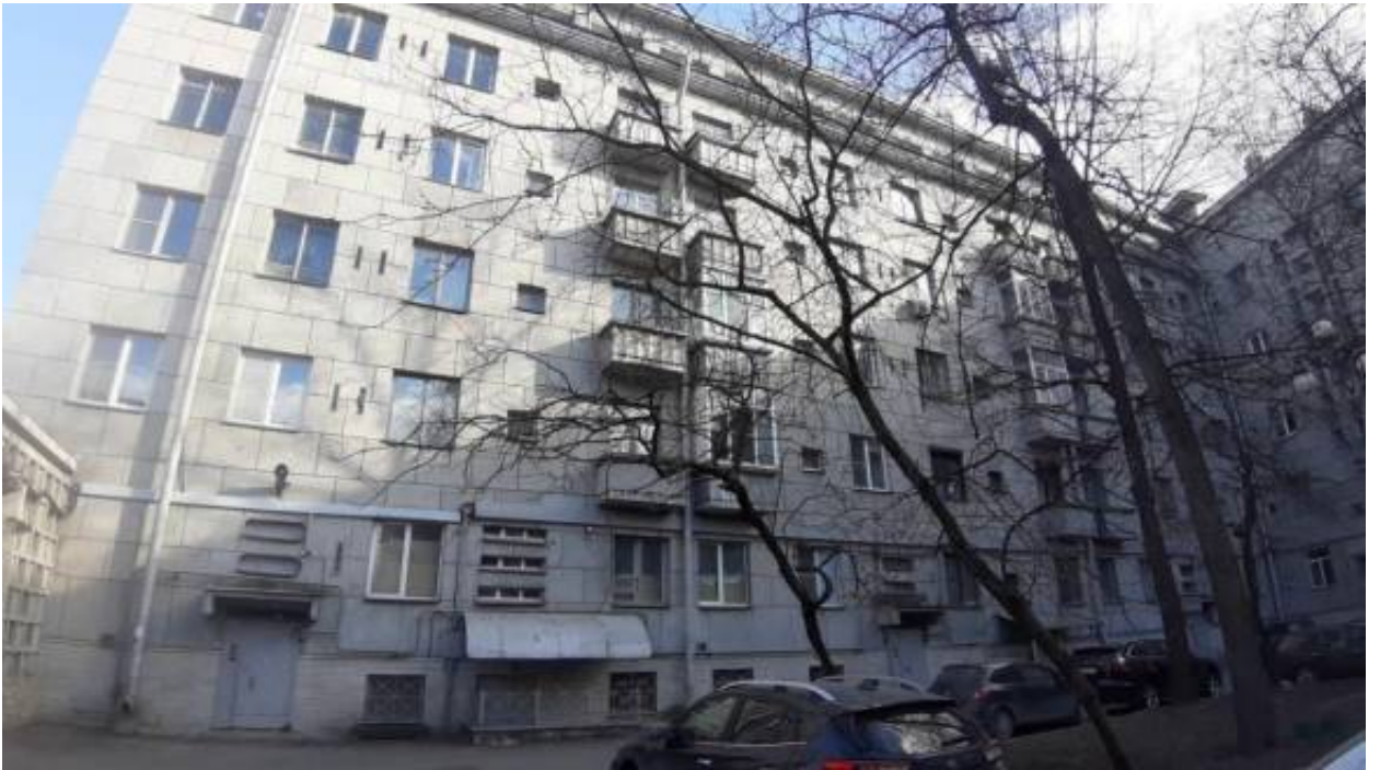
25. «Дом жилой Ленсовета Первый» (наб. реки Карповки, д. 13, лит. А). Дворовый фасад. Фото мест установки оборудования и прокладки кабельных трасс. Штиглиц М.С. 02.04.2026 г.
