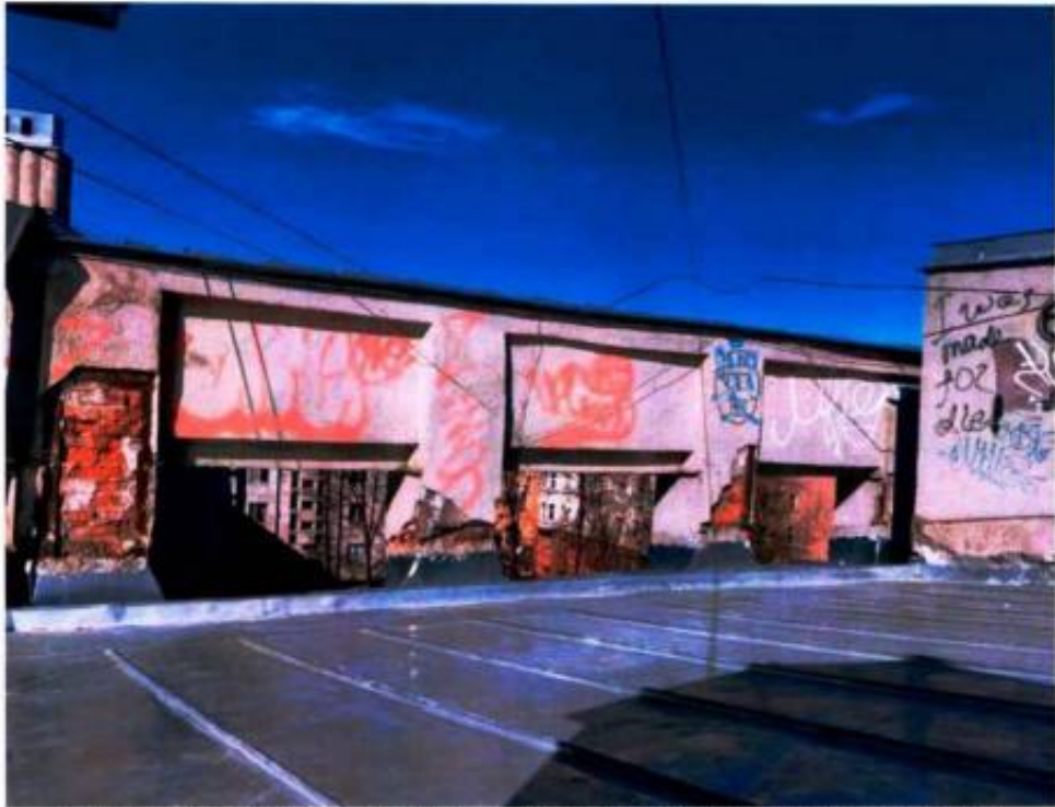
Фото 18. Вид на кровлю объекта культурного наследия (дата съемки 02.04.2025).
