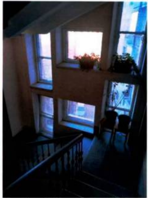
Фото 12. Лестничная клетка ЛК6 (дата съемки 02.04.2025).
