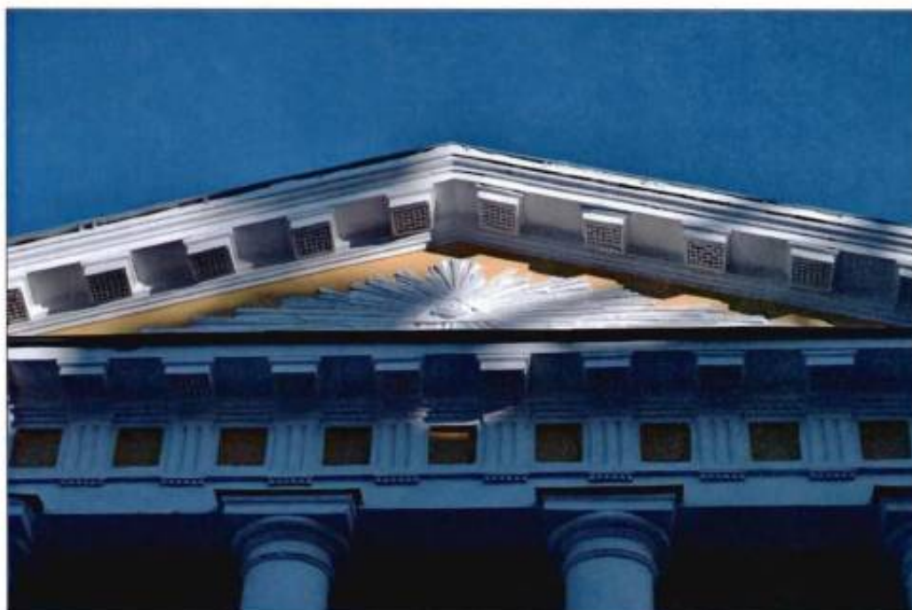
7. Лицевой фасад церковного корпуса. Фрагмент.
