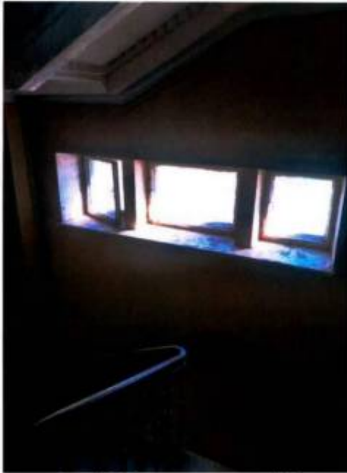
Фото 15. Лестничная клетка ЛК9 (дата съемки 02.04.2025).
