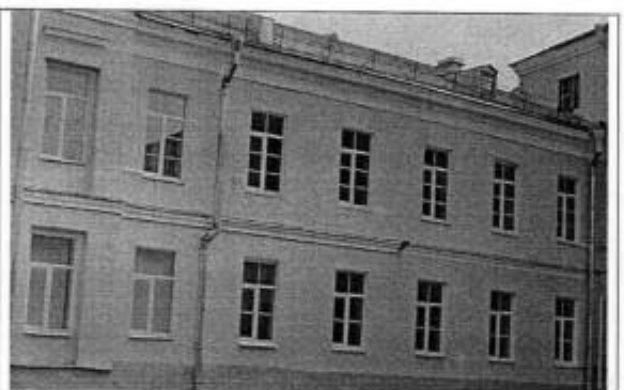
4. Фрагмент юго-западного фасада.
