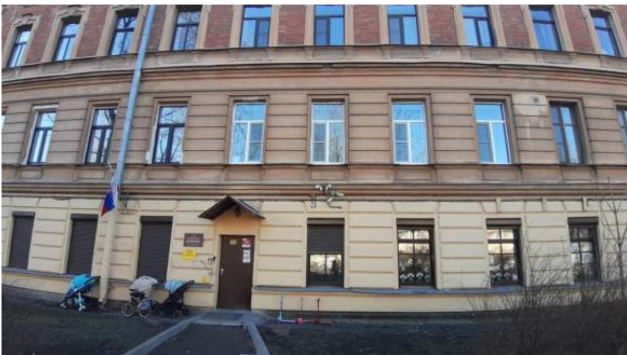
8. «Дом дешевых квартир Императорского человеколюбивого общества» (Большая Зеленина ул., д. 13, лит. А). Лицевой фасад из Ораниенбаумского сада (фрагмент). Фото мест установки оборудования и прокладки кабельных трасс. Штиглиц М.С. 02.04.2026 г.
