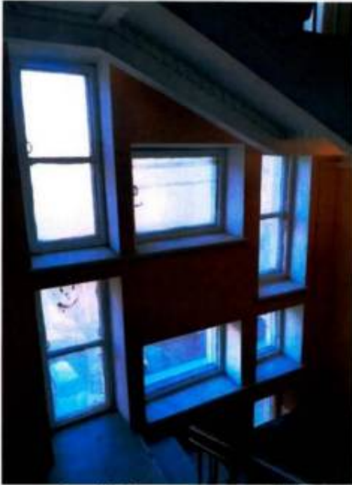
Фото 11. Лестничная клетка ЛК5 (дата съемки 02.04.2025).
