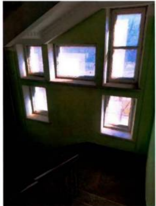
Фото 14. Лестничная клетка ЛК8 (дата съемки 02.04.2025).
