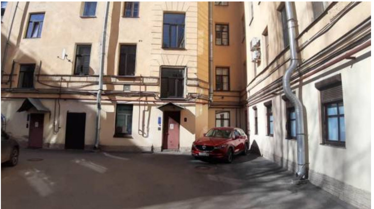
6. «Дом дешевых квартир Императорского человеколюбивого общества» (Большая Зеленина ул., д. 13, лит. А). Дворовый фасад. Фото мест установки оборудования и прокладки кабельных трасс. Штиглиц М.С. 02.04.2026 г.
