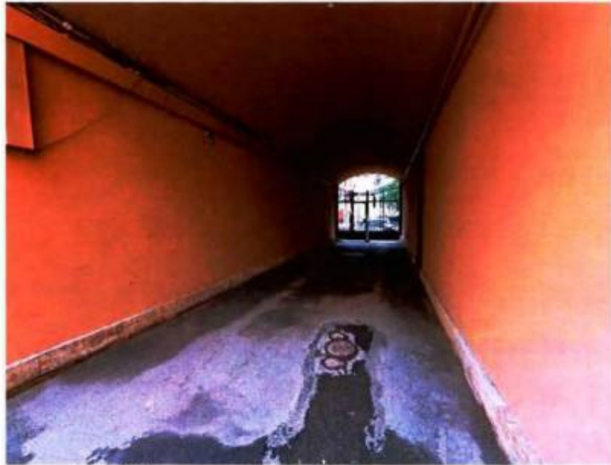
Фото 22 Фрагмент территории объекта культурного наследия. Воротный проезд, выходящий на Малую Посадскую улицу. Фото выполнено 08.07.2025.
