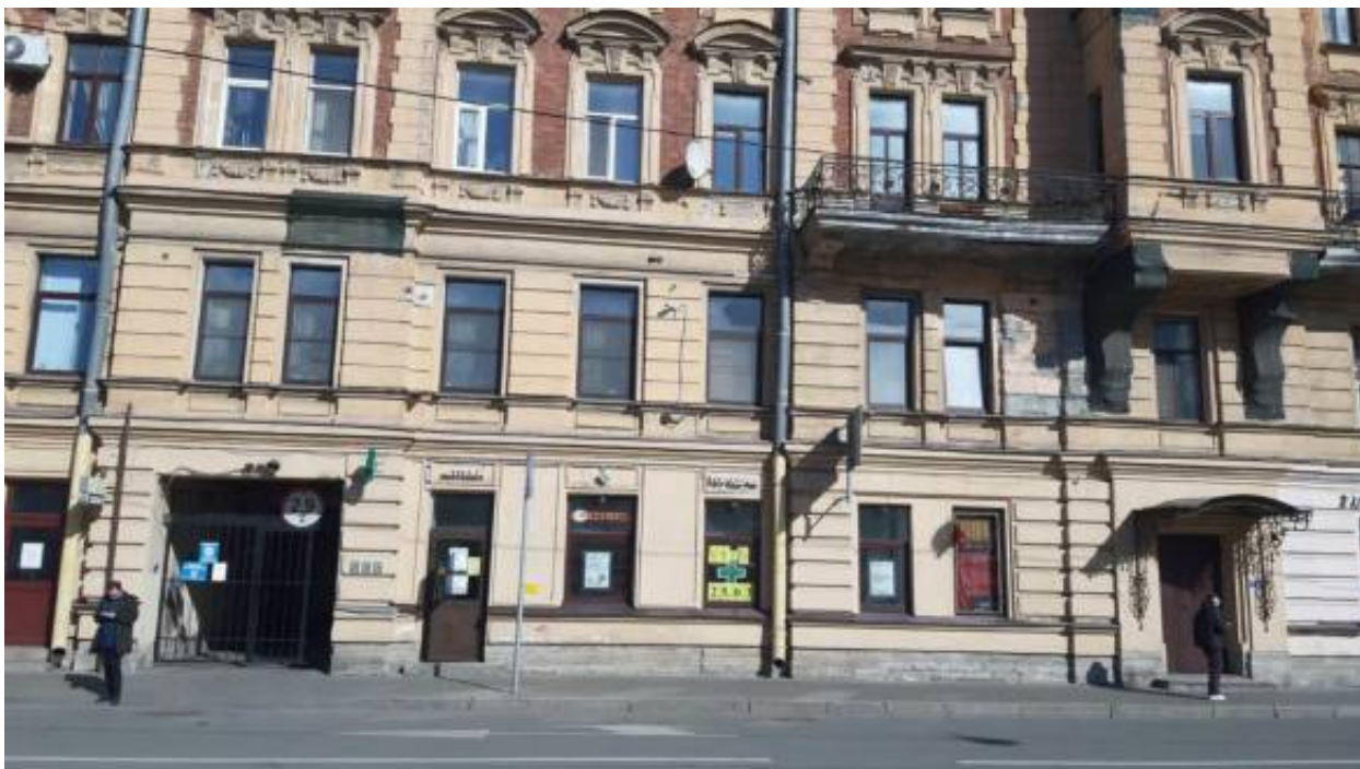
3. «Дом дешевых квартир Императорского человеколюбивого общества» (Большая Зеленина ул., д. 13, лит. А). Лицевой фасад по Большой Зеленина (фрагмент). Фото мест установки оборудования и прокладки кабельных трасс. Штиглиц М.С. 02.04.2026 г.
