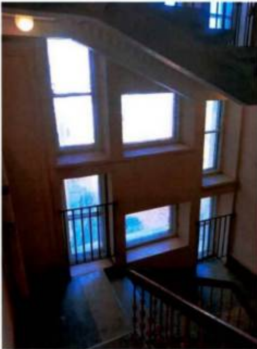
Фото 9. Лестничная клетка ЛК3 (дата съемки 02.04.2025).
