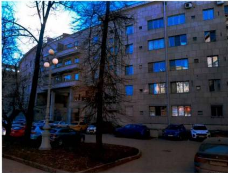
Фото 6. Северный дворовой фасад объекта культурного наследия (дата съемки 03.04.2025).
