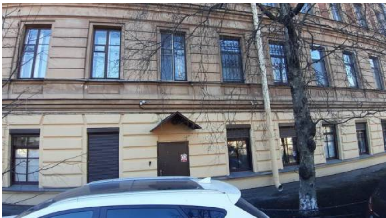
12. «Дом дешевых квартир Императорского человеколюбивого общества» (Большая Зеленина ул., д. 13, лит. А). Лицевой фасад из Ораниенбаумского сада (фрагмент). Фото мест установки оборудования и прокладки кабельных трасс. Штиглиц М.С. 02.04.2026 г.
