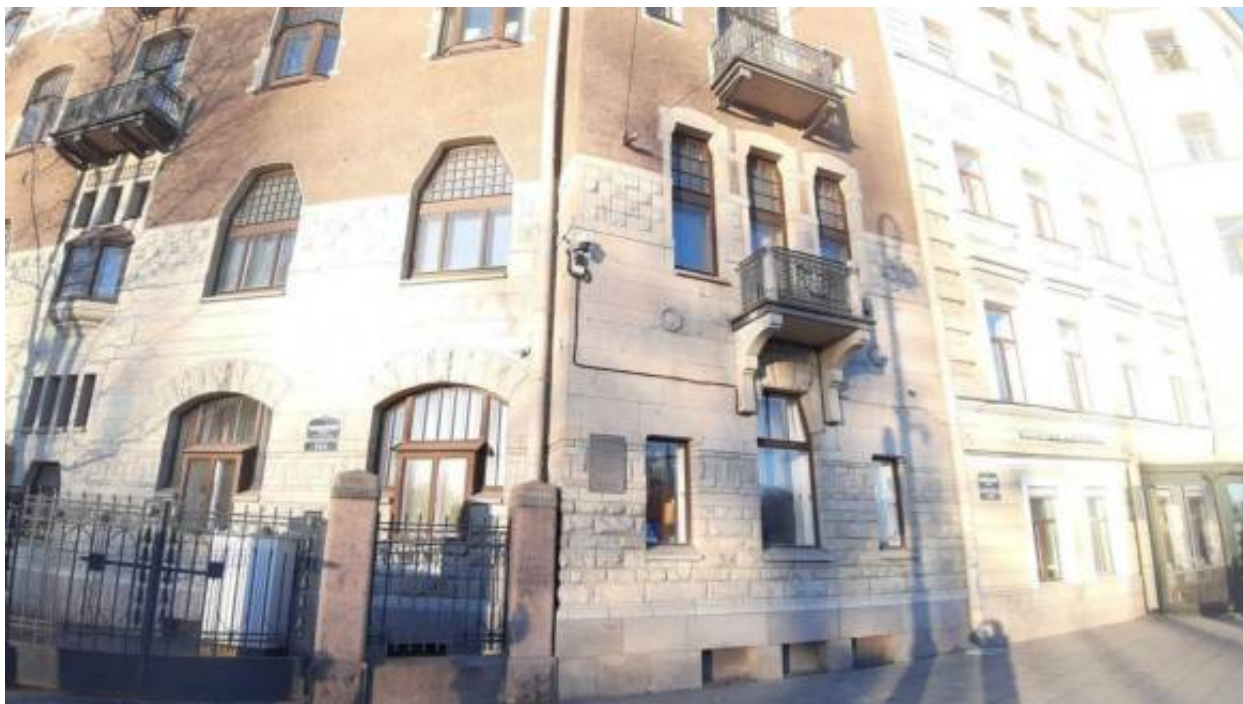
29. «Бывш. дом Лидваля» (Каменноостровский пр., д. 1-3, лит. А). Лицевой фасад (фрагмент). Фото мест установки оборудования и прокладки кабельных трасс. Штиглиц М.С. 02.04.2026 г.
