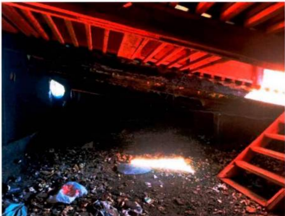
Фото 17. Конструкция крыши (дата съемки 02.04.2025).
