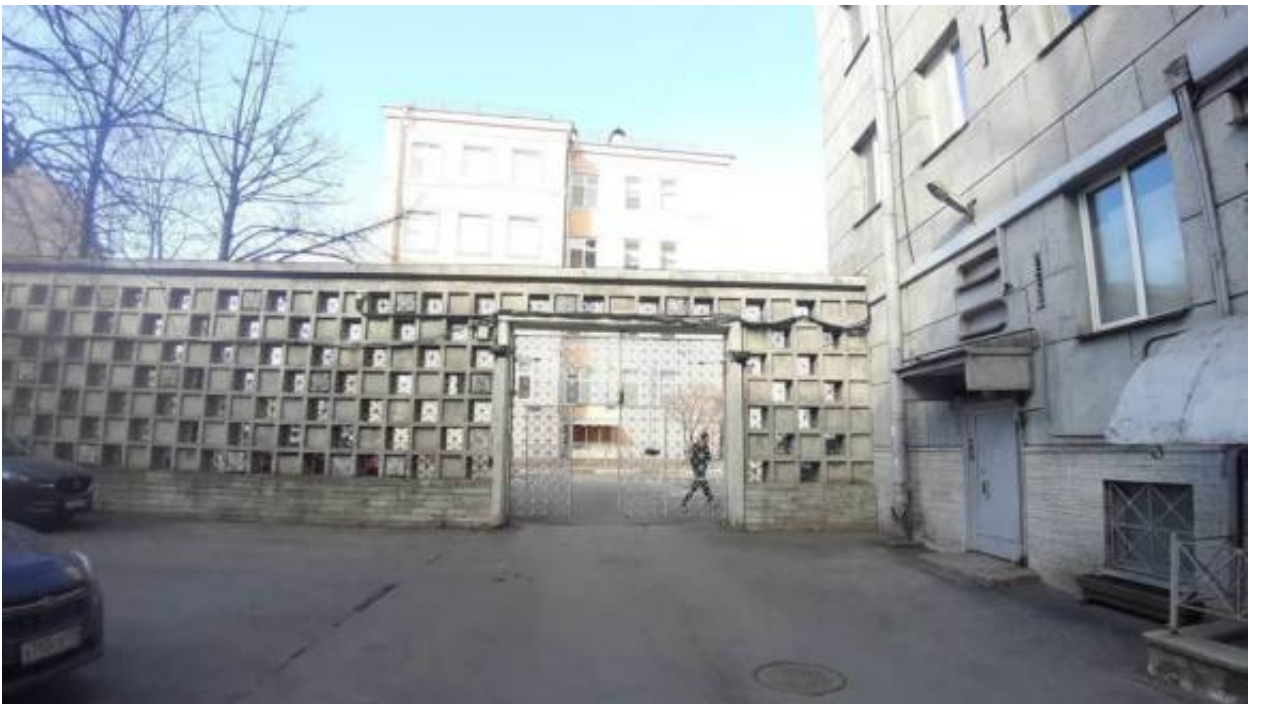
26. «Дом жилой Ленсовета Первый» (наб. реки Карповки, д. 13, лит. А). Дворовый фасад. Фото мест установки оборудования и прокладки кабельных трасс. Штиглиц М.С. 02.04.2026 г.
