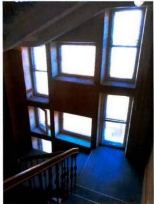
Фото 10. Лестничная клетка ЛК4 (дата съемки 02.04.2025).
