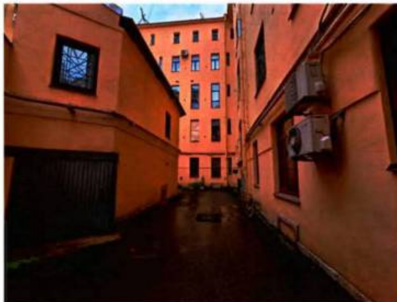
Фото 13 Фрагмент территории объекта культурного наследия. Южный двор. Дворовые фасады. Фото выполнено 08.07.2025.
