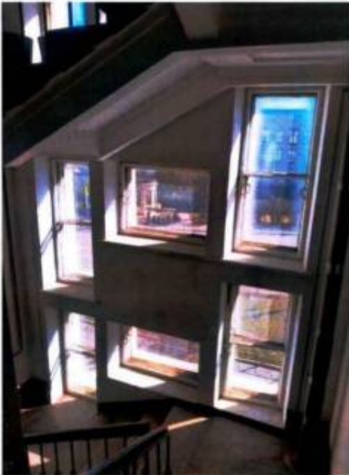
Фото 13. Лестничная клетка ЛК7 (дата съемки 02.04.2025).
