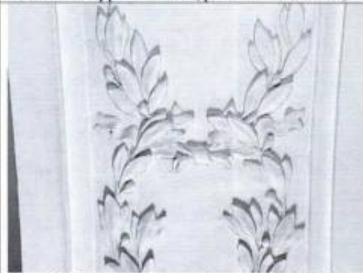
Фото 33. Перронный зал (фото от 12.05.2022).
