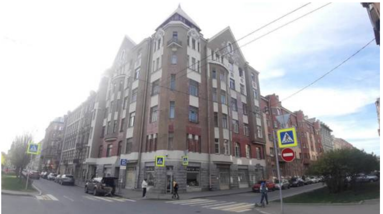
10. «Дом Захаровых» (Бронницкая ул., д. 16, лит. А). Общий вид. Штиглиц М.С. 06.05.2026 г.
