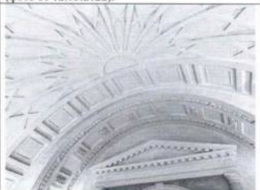
Фото 52. Помещение эскалаторного зала (пом. 2-Н (31) (фото от 12.05.2022).
