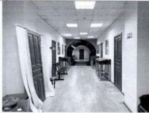
Фото 71. Помещение 3 этажа (пом. 8-Н (1)) (фото от 12.05.2022).
