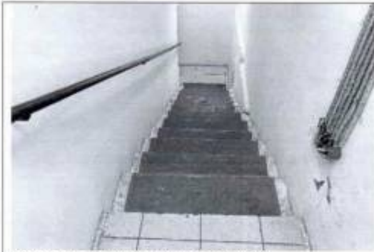
Фото 19. Лестница (пом. 2-Н (50)) (фото от 12.05.2022).
