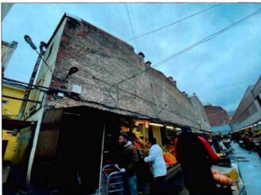
15. Северо-восточный фасад части объекта культурного наследия.
