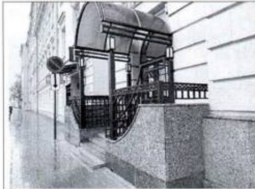
Фото 7. Крыльцо со стороны северо-восточного фасада (фото от 12.05.2022).
