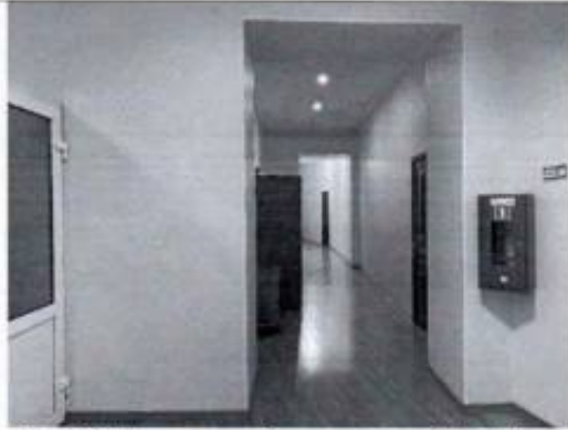
Фото 61. Помещение 2 этажа (пом. 7-Н (18) (фото от 12.05.2022).
