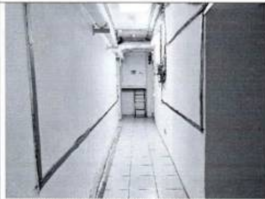
Фото 45. Помещение подвала (2-Н (76)) (фото от 05.09.2022).
