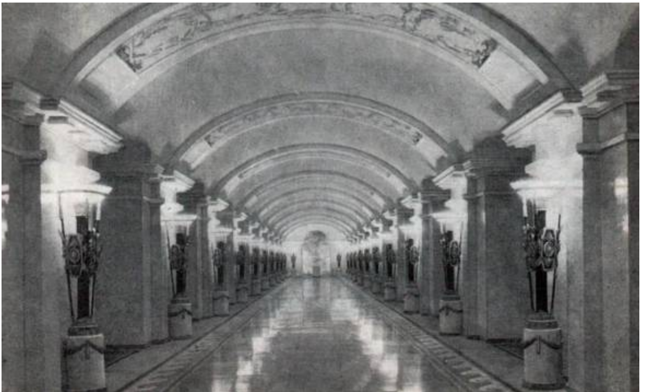
24. «Станция метро «Пушкинская» (с перронным залом)» (Загородный пр., д. 52а, лит. А). Центральный зал. Фото 1957 г. (29).
