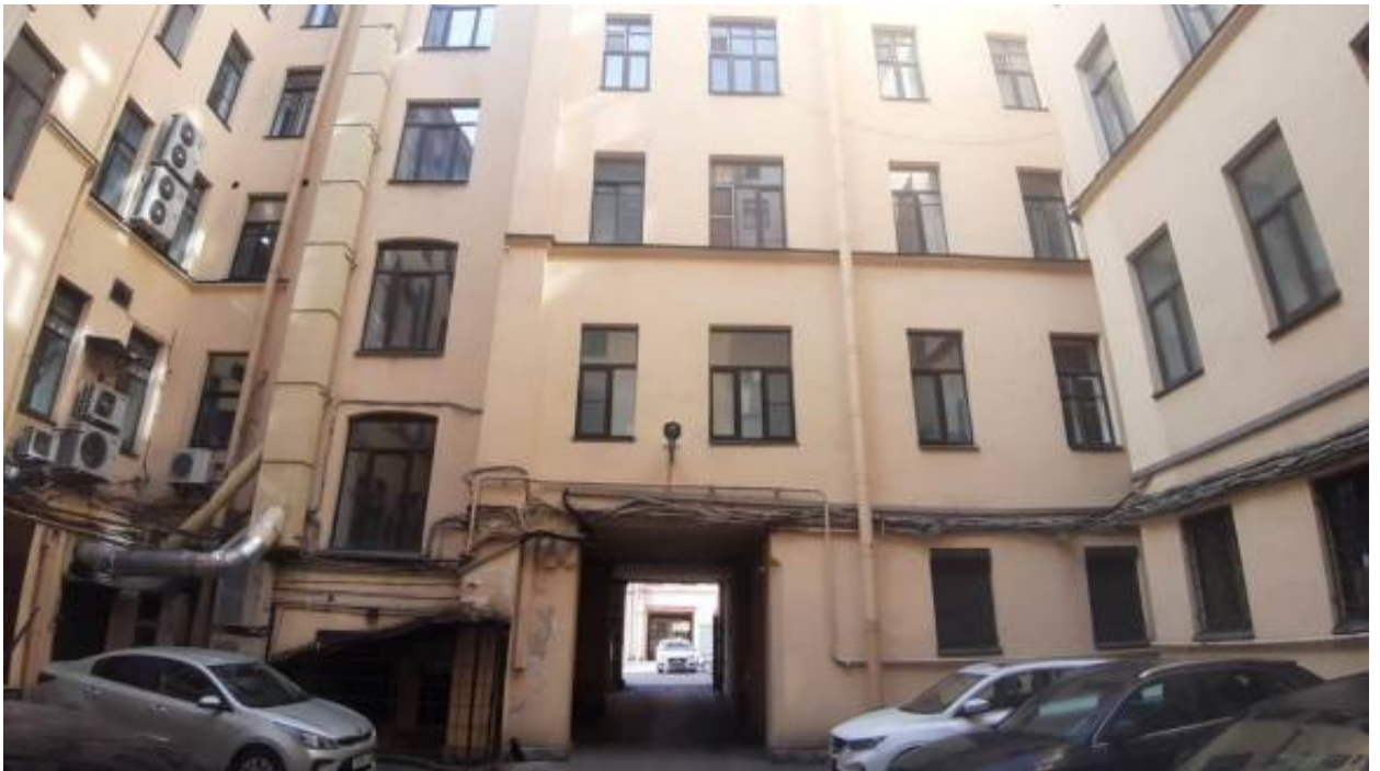
28. «Дома М.В.Вяземской (2 здания)» (Московский пр., д. 6, лит. А). Дворовый фасад. Фото мест установки оборудования и прокладки кабельных трасс. Штиглиц М.С. 06.05.2026 г.
