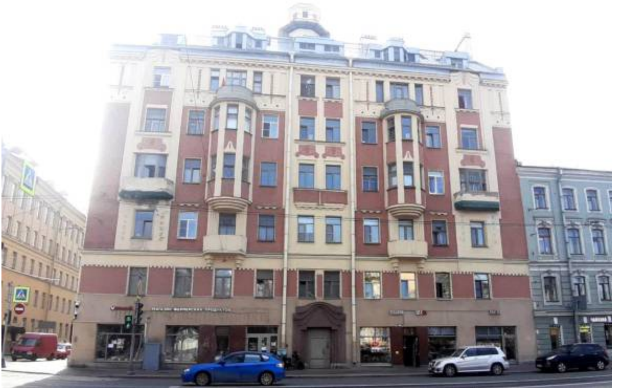
29. «Дом Г.Г. Цолликофера» (12-я Красноармейская ул., д. 1/21, лит. А). Лицевой фасад по Измайловскому пр. Штиглиц М.С. 06.05.2026 г.
