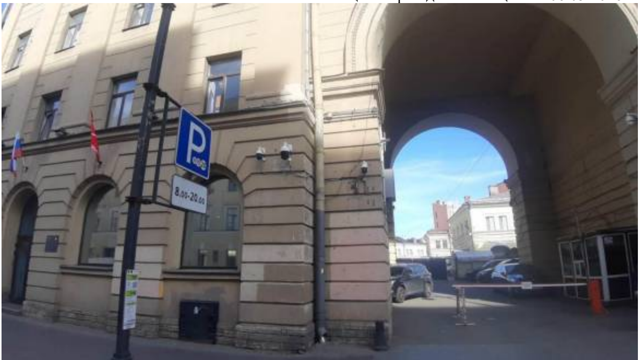
6. «Здания Общества торговцев рыбного рынка» (Московский пр., д. 10-12, лит. А). Лицевой фасад (фрагмент). Фото мест установки оборудования и прокладки кабельных трасс. Штиглиц М.С. 06.05.2026 г.
