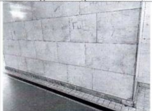
Фото 42. Перронный зал (фото от 12.05.2022).
