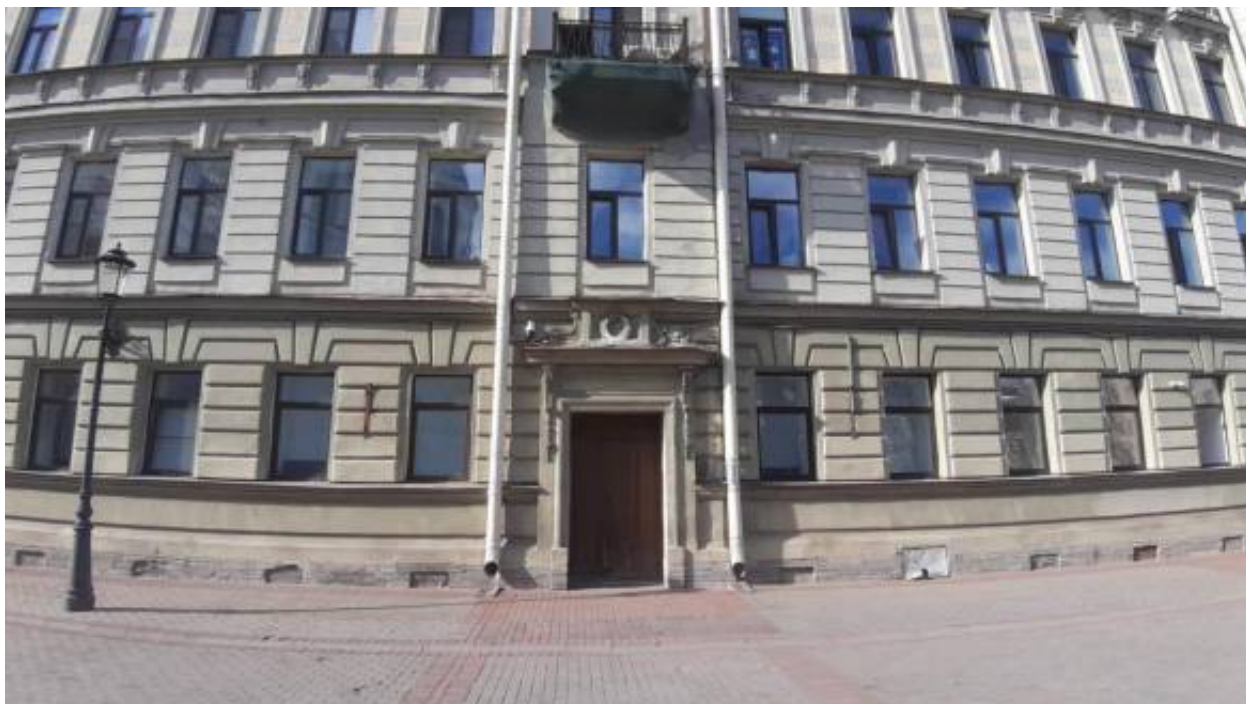
17. «Дом Н. Шпейфера (доходный дом страхового общества "Саламандра")» (Измайловский пр., д. 7, лит. А). Лицевой фасад на Троицкую пл. (фрагмент). Фото мест установки оборудования и прокладки кабельных трасс. Штиглиц М.С. 06.05.2026 г.
