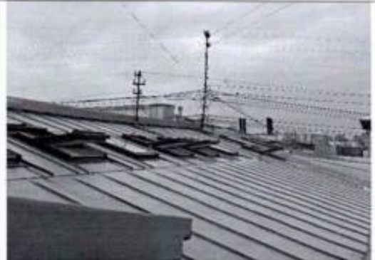
Фото 16. Фрагмент кровли (фото от 12.05.2022).
