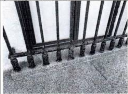
Фото 10. Фрагмент северо-западного фасада (фото от 12.05.2022).
