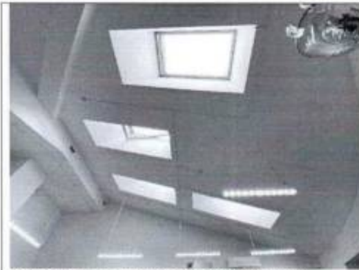
Фото 79. Помещение мансардного этажа (фото от 12.05.2022).
