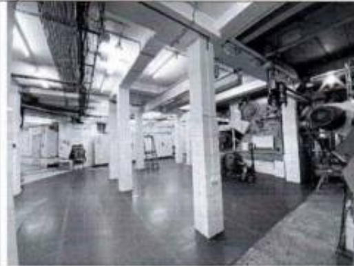
Фото 29. Помещение подвала (2-Н (21) (фото от 12.05.2022).
