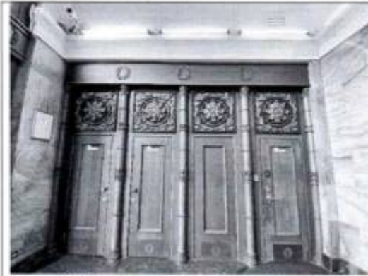
Фото 49. Помещение вестибюля (пом. 2-Н (1) (фото от 12.05.2022).
