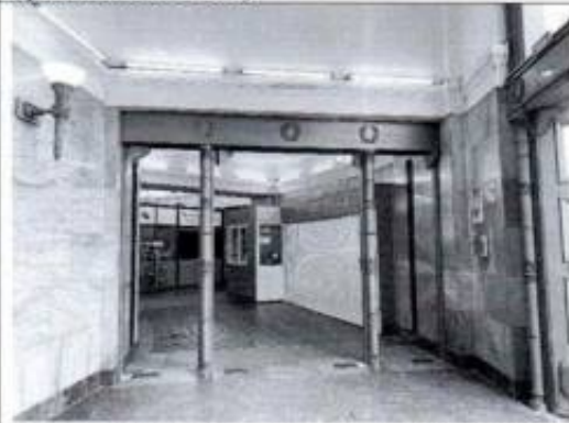
Фото 47. Помещение вестибюля (пом. 2-Н (1)) (фото от 12.05.2022).
