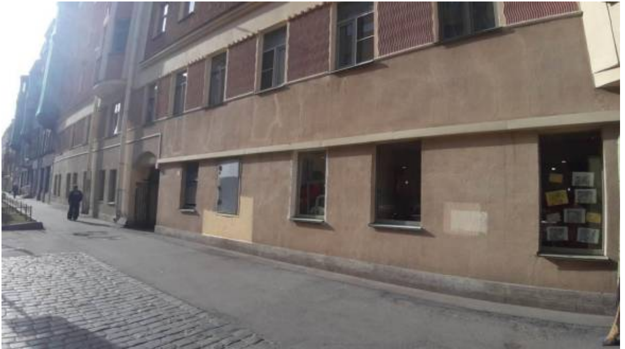
33. «Дом Г.Г. Цолликофера» (12-я Красноармейская ул., д. 1/21, лит. А). Лицевой фасад по 12-ой Красноармейской ул. (фрагмент). Фото мест установки оборудования и прокладки кабельных трасс. Штиглиц М.С. 06.05.2026 г.
