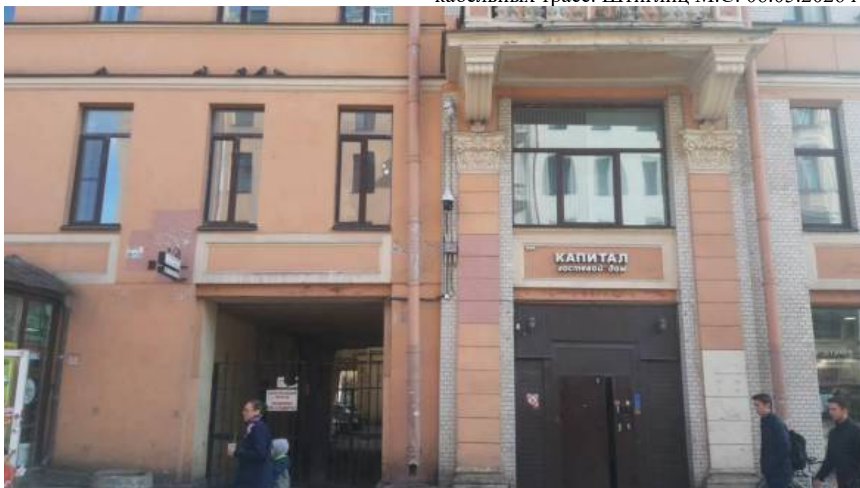
24. «Дома М.В.Вяземской (2 здания)» (Московский пр., д. 6, лит. А). Лицевой фасад(фрагмент). Фото мест установки оборудования и прокладки кабельных трасс. Штиглиц М.С. 06.05.2026 г.
