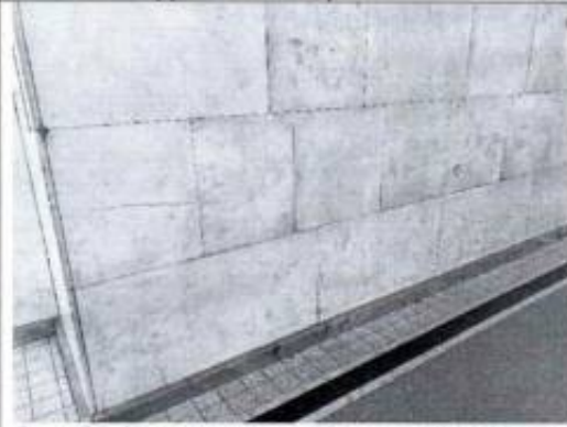
Фото 35. Перронный зал (фото от 12.05.2022).
