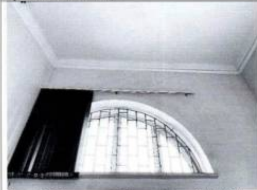
Фото 57. Помещение 1 этажа (пом. 2-Н (45)) (фото от 12.05.2022).
