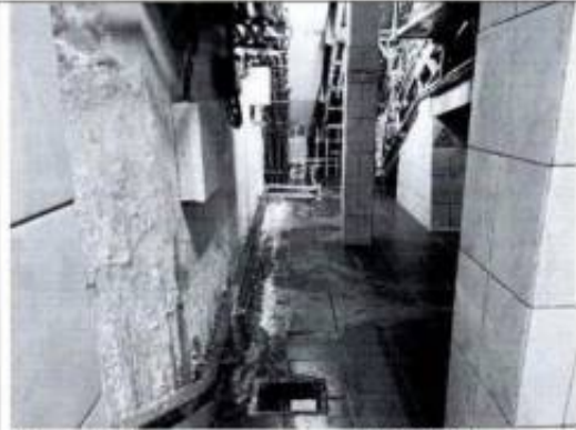
Фото 44. Помещение подвала (2-Н (21)) (фото от 05.09.2022).
