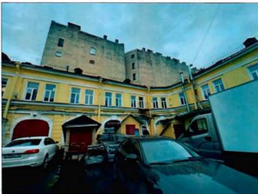
9. Фрагмент юго-восточного фасада части объекта культурного наследия.
