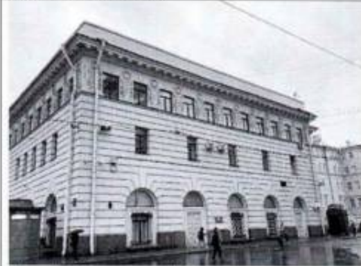
Фото 3. Юго-западный фасад (фото от 12.05.2022).
