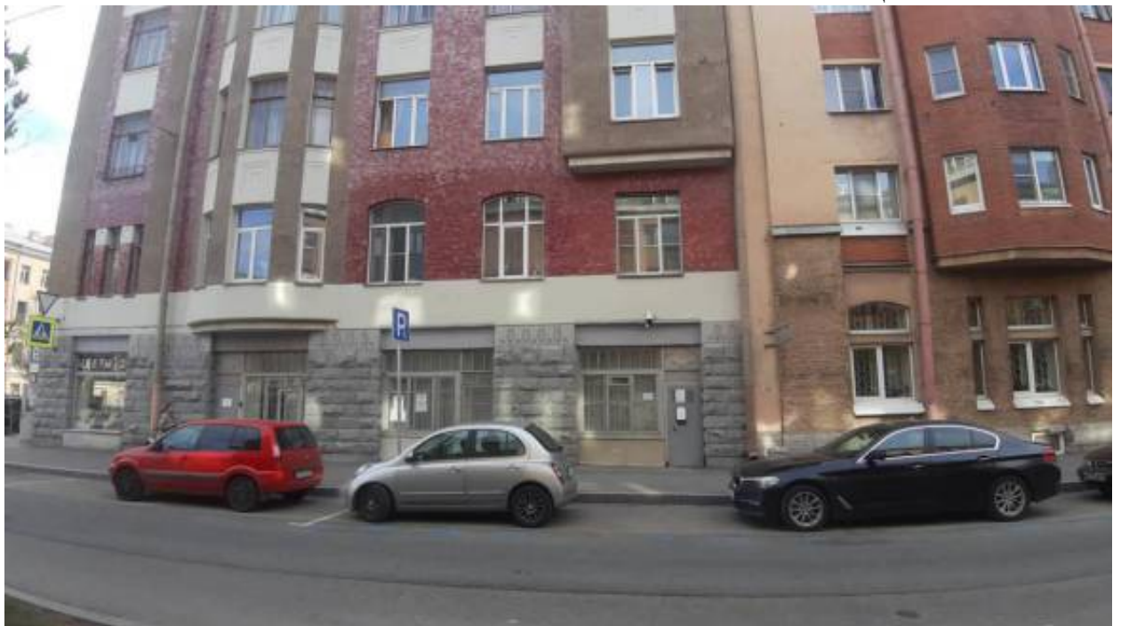
14. «Дом Захаровых» (Бронницкая ул., д. 16, лит. А). Лицевой фасад по Серпуховской ул. (фрагмент). Фото мест установки оборудования и прокладки кабельных трасс. Штиглиц М.С. 06.05.2026 г.
