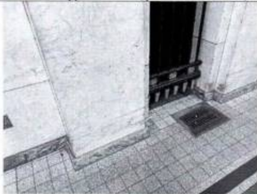
Фото 41. Перронный зал (фото от 12.05.2022).
