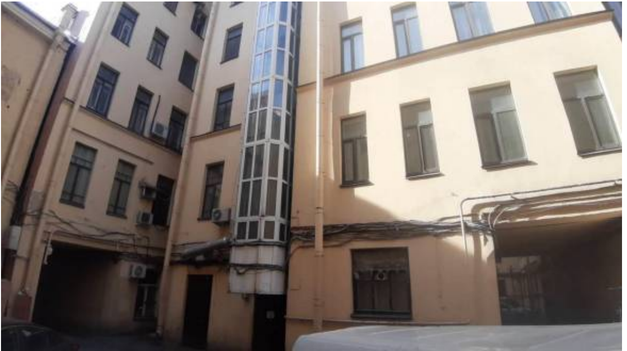
25. «Дома М.В.Вяземской (2 здания)» (Московский пр., д. 6, лит. А). Дворовый фасад. Фото мест установки оборудования и прокладки кабельных трасс. Штиглиц М.С. 06.05.2026 г.
