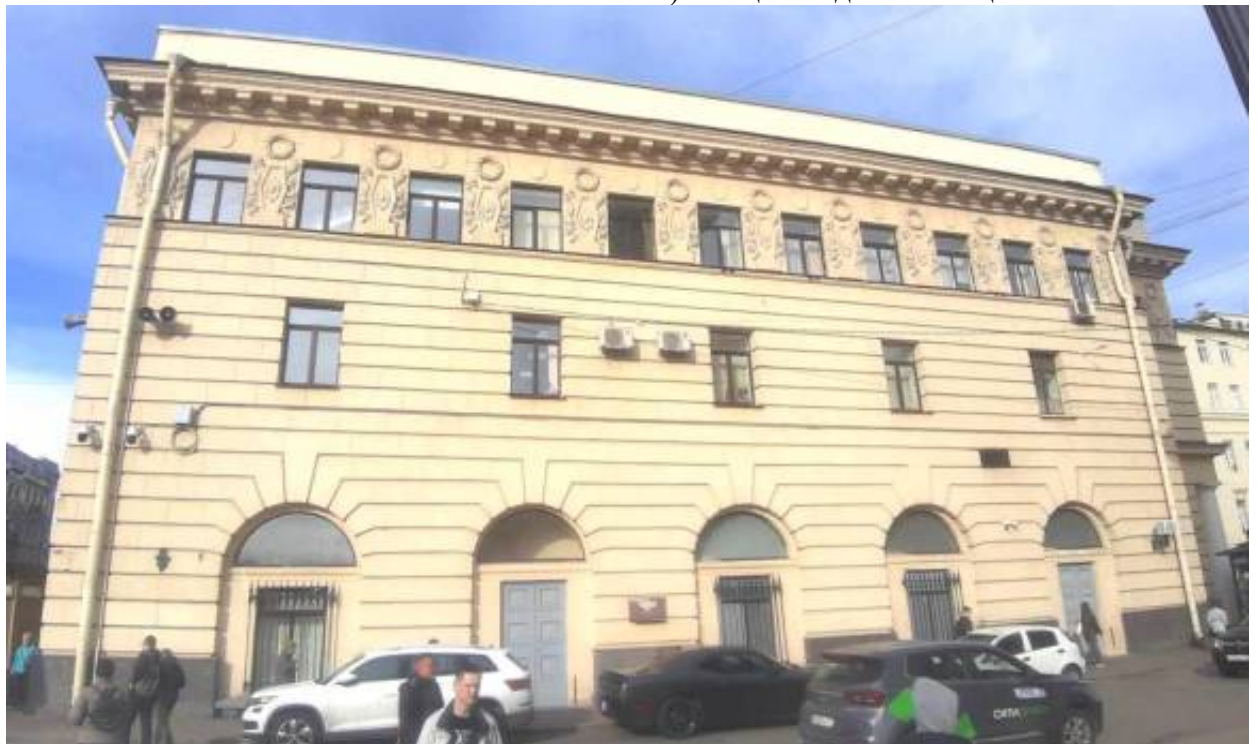
2. «Станция метро «Пушкинская» (с перронным залом)» (Загородный пр., д. 52а, лит. А). Лицевой фасад по Винокурцевскому проезду. Штиглиц М.С. 06.05.2026 г.
