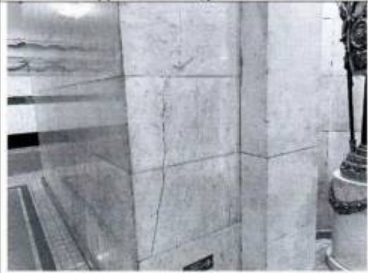
Фото 36. Перронный зал (фото от 12.05.2022).
