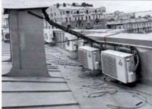
Фото 15. Фрагмент кровли (фото от 12.05.2022).
