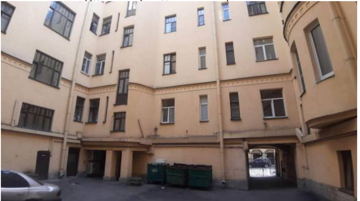
34. «Дом Г.Г. Цолликофера» (12-я Красноармейская ул., д. 1/21, лит. А). Дворовый фасад. Фото мест установки оборудования и прокладки кабельных трасс. Штиглиц М.С. 06.05.2026 г.
