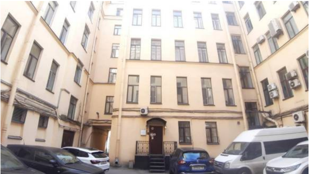
26. «Дома М.В.Вяземской (2 здания)» (Московский пр., д. 6, лит. А). Дворовый фасад. Фото мест установки оборудования и прокладки кабельных трасс. Штиглиц М.С. 06.05.2026 г.
