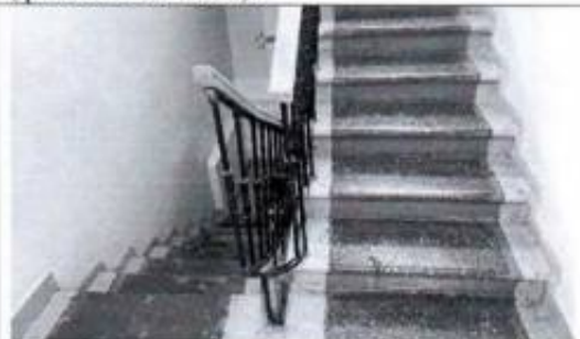
Фото 18. Лестница (пом. 2-Н (25) (фото от 12.05.2022).
