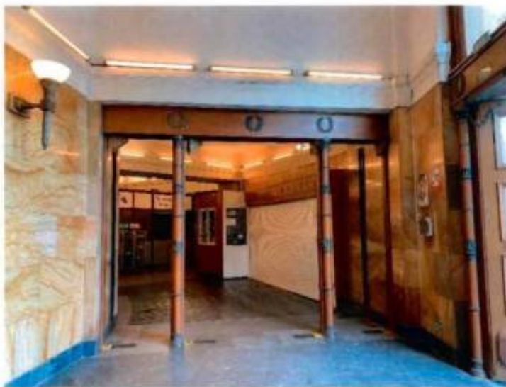
7. Помещение вестибюля объекта культурного наследия. Фото от 12.05.2022.
