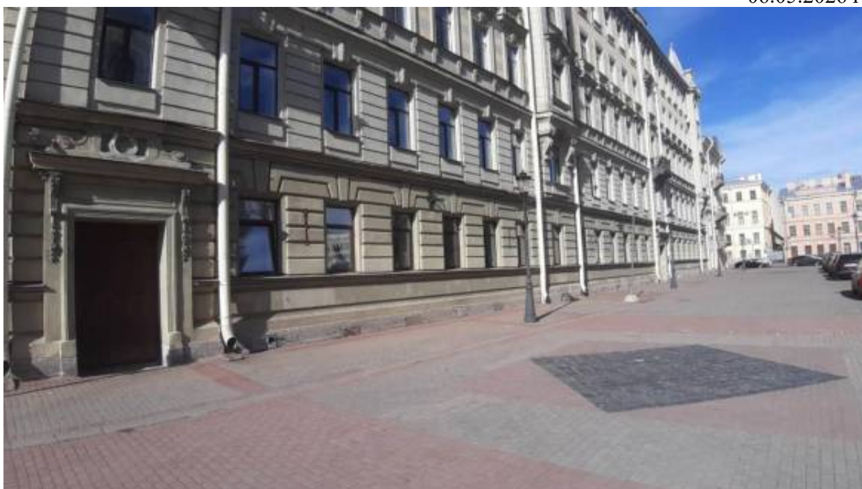
20. «Дом Н. Шпейфера (доходный дом страхового общества "Саламандра")» (Измайловский пр., д. 7, лит. А). Лицевой фасад на Троицкую пл. (фрагмент). Фото мест установки оборудования и прокладки кабельных трасс. Штиглиц М.С. 06.05.2026 г.
