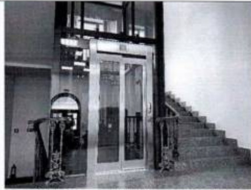
Фото 25. Лестница (2ЛК) (фото от 12.05.2022).
