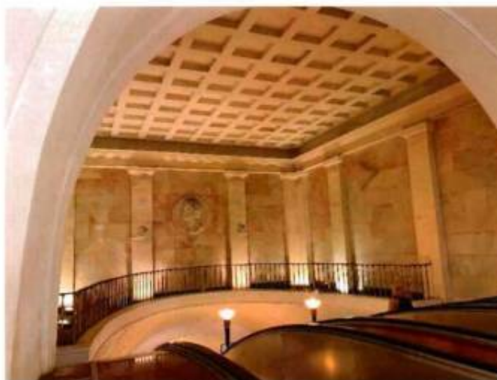
6. Помещение эскалаторного зала объекта культурного наследия. Фото от 12.05.2022.
