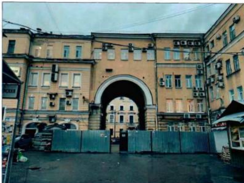
2. Восточный дворовой фасад части объекта культурного наследия.
