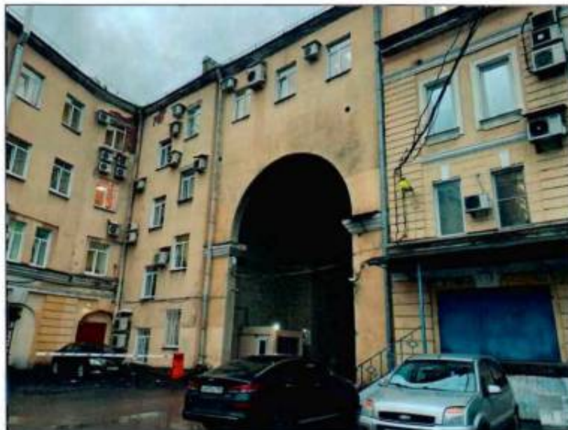
7. Восточный дворовой фасад части объекта культурного наследия.
