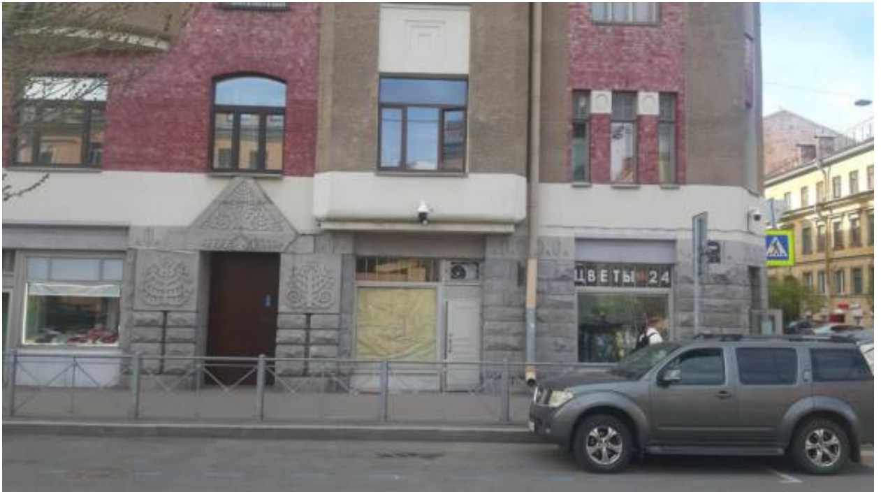
13. «Дом Захаровых» (Бронницкая ул., д. 16, лит. А). Лицевой фасад по Клиньскому пр. (фрагмент). Фото мест установки оборудования и прокладки кабельных трасс. Штиглиц М.С. 06.05.2026 г.
