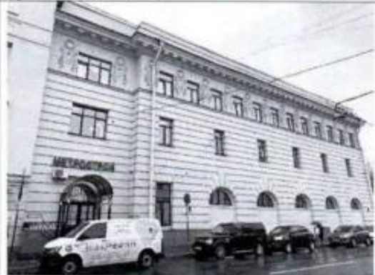
Фото 4. Северо-восточный фасад (фото от 12.05.2022).
