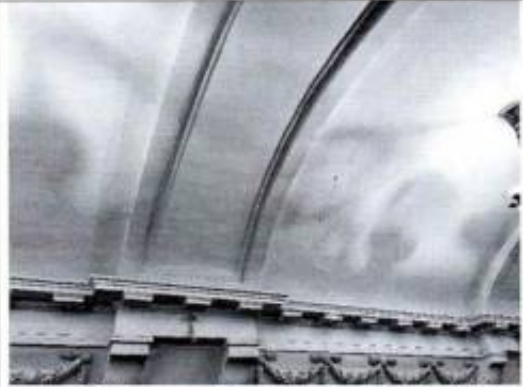
Фото 32. Перронный зал (фото от 12.05.2022).
