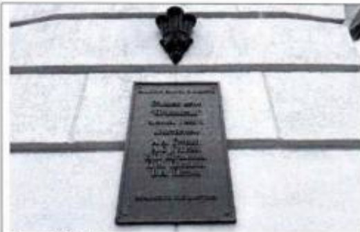
Фото 13. Информационная надпись установленная на северо-западном фасаде (фото от 12.05.2022).
