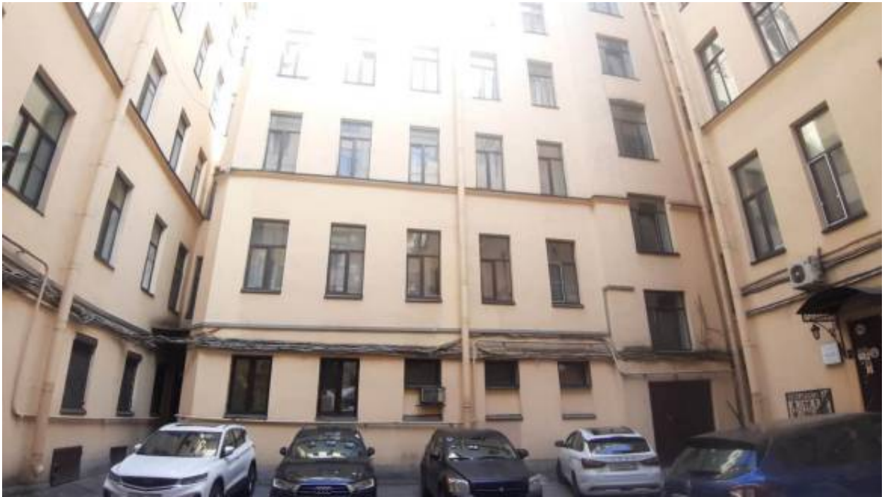
27. «Дома М.В.Вяземской (2 здания)» (Московский пр., д. 6, лит. А). Дворовый фасад. Фото мест установки оборудования и прокладки кабельных трасс. Штиглиц М.С. 06.05.2026 г.
