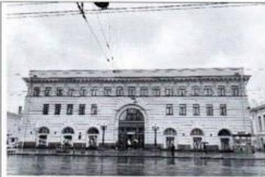
Фото 1. Северо-западный фасад (фото от 12.05.2022).
