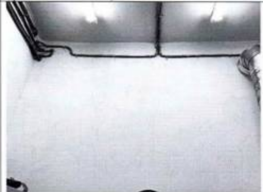
Фото 30. Помещение подвала (2-Н (65) (фото от 12.05.2022).
