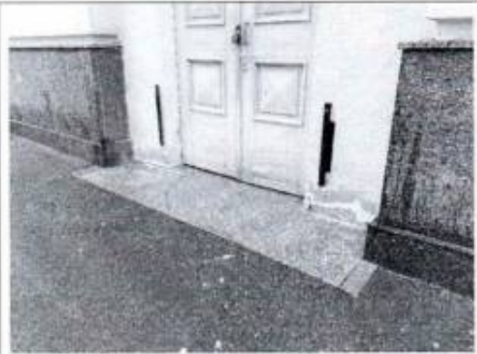
Фото 8. Крыльцо со стороны юго-западного фасада (фото от 12.05.2022).
