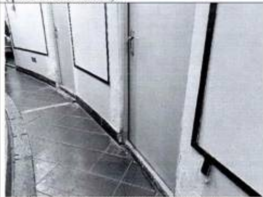
Фото 46. Помещение подвала (2-Н (64)) (фото от 05.09.2022).
