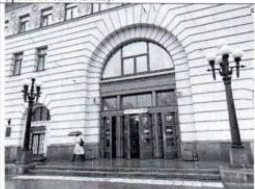
Фото 6. Крыльцо со стороны северо-западного фасада (фото от 12.05.2022).
