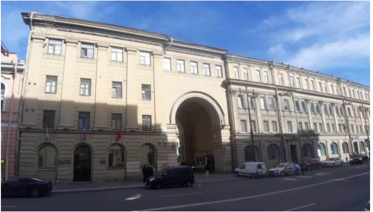
5. «Здания Общества торговцев рыбного рынка» (Московский пр., д. 10-12, лит. А). Лицевой фасад. Штиглиц М.С. 06.05.2026 г.
