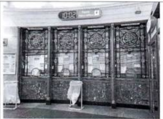
Фото 50. Помещение вестибюля (пом. 2-Н (8) (фото от 12.05.2022).
