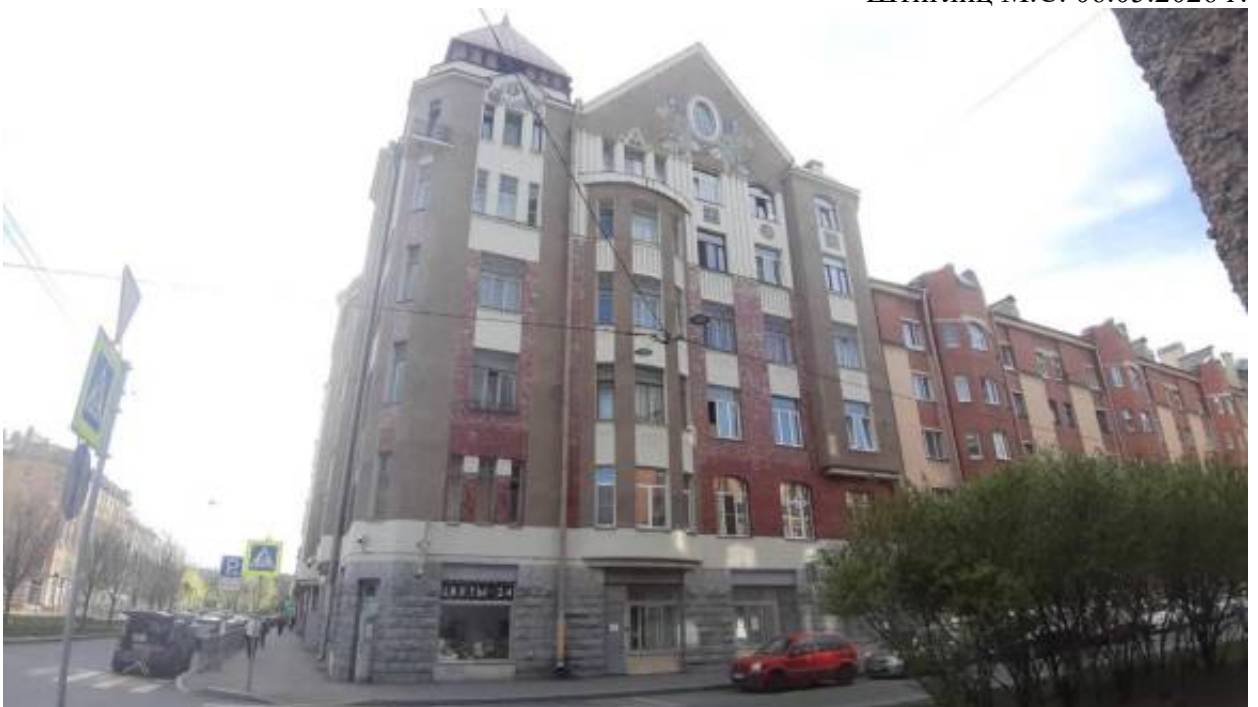
12. «Дом Захаровых» (Бронницкая ул., д. 16, лит. А). Лицевой фасад по Серпуховской ул. Штиглиц М.С. 06.05.2026 г.
