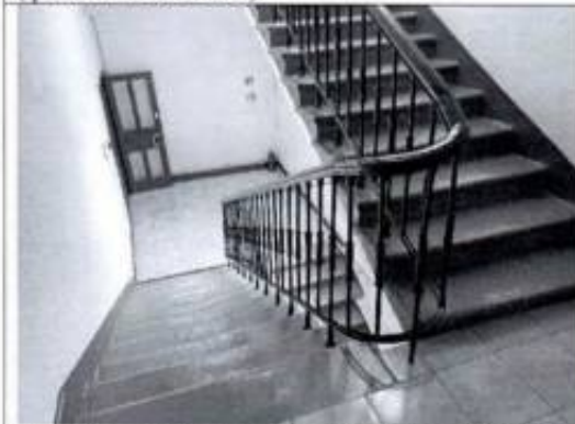
Фото 21. Лестница (1ЛК) (фото от 12.05.2022).
