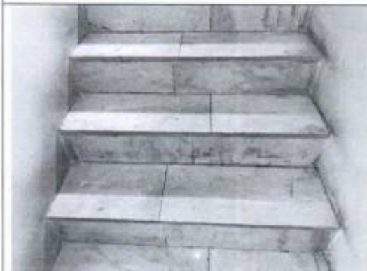
Фото 23. Лестница (пом. 3-Н (1)) (фото от 12.05.2022).
