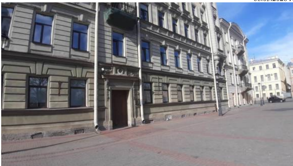
18. «Дом Н. Шпейфера (доходный дом страхового общества "Саламандра")» (Измайловский пр., д. 7, лит. А). Лицевой фасад на Троицкую пл. (фрагмент). Фото мест установки оборудования и прокладки кабельных трасс. Штиглиц М.С. 06.05.2026 г.
