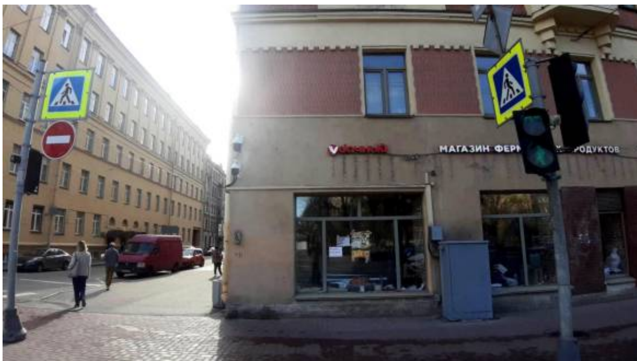
31. «Дом Г.Г. Цолликофера» (12-я Красноармейская ул., д. 1/21, лит. А). Лицевой фасад по Измайловскому пр. (фрагмент). Фото мест установки оборудования и прокладки кабельных трасс. Штиглиц М.С. 06.05.2026 г.
