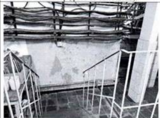
Фото 28. Помещение подвала (2-Н (21) (фото от 05.09.2022).
