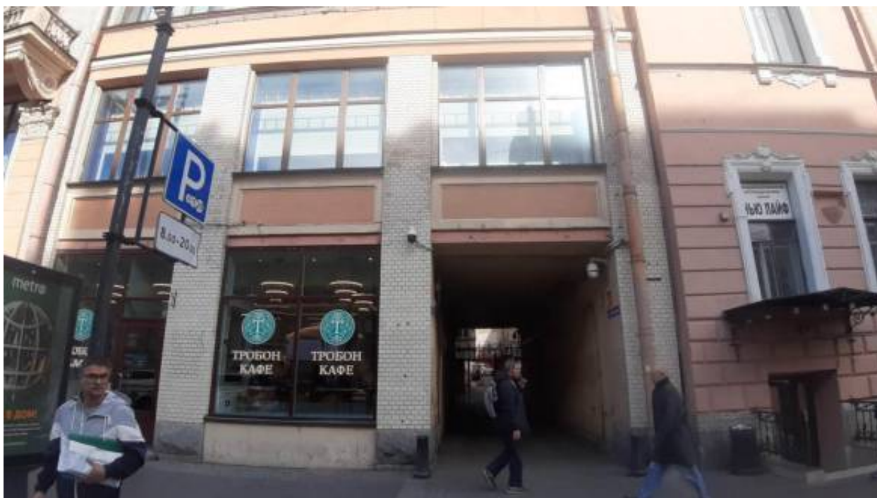
23. «Дома М.В.Вяземской (2 здания)» (Московский пр., д. 6, лит. А). Лицевой фасад по Московскому пр.(фрагмент). Фото мест установки оборудования и прокладки кабельных трасс. Штиглиц М.С. 06.05.2026 г.
