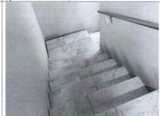
Фото 22. Лестница (пом. 3-Н (1)) (фото от 12.05.2022).
