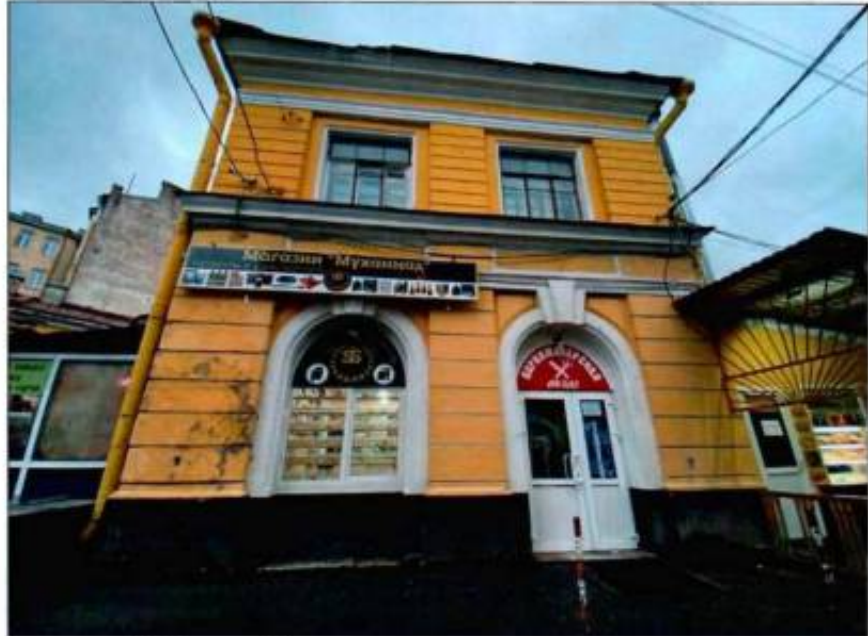
12. Северный фасад части объекта культурного наследия.
