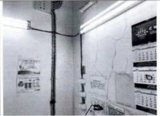
Фото 56. Помещение 1 этажа (пом. 2-Н (5)) (фото от 12.05.2022).
