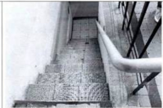
Фото 20. Лестница (пом. 2-Н (30)) (фото от 12.05.2022).
