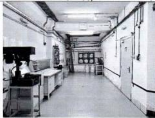
Фото 27. Помещение подвала (2-Н (61) (фото от 05.09.2022).
