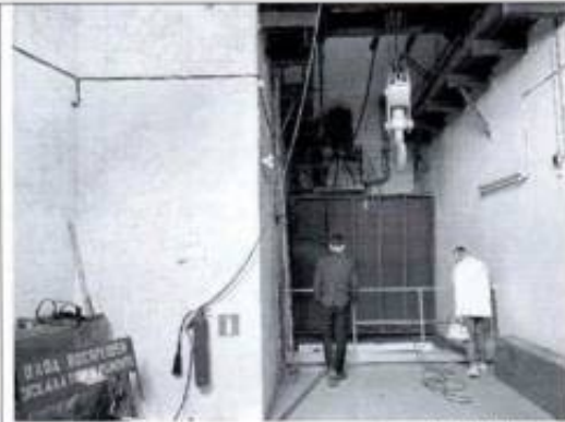
Фото 55. Помещение 1 этажа (пом. 2-Н (10)) (фото от 12.05.2022).
