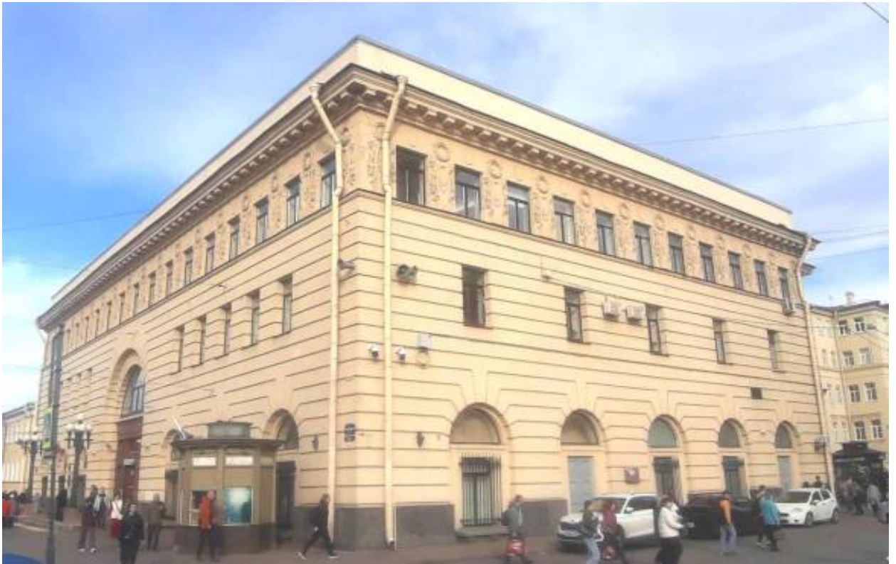
1. «Станция метро «Пушкинская» (с перронным залом)» (Загородный пр., д. 52а, лит. А). Общий вид. Штиглиц М.С. 06.05.2026 г.
