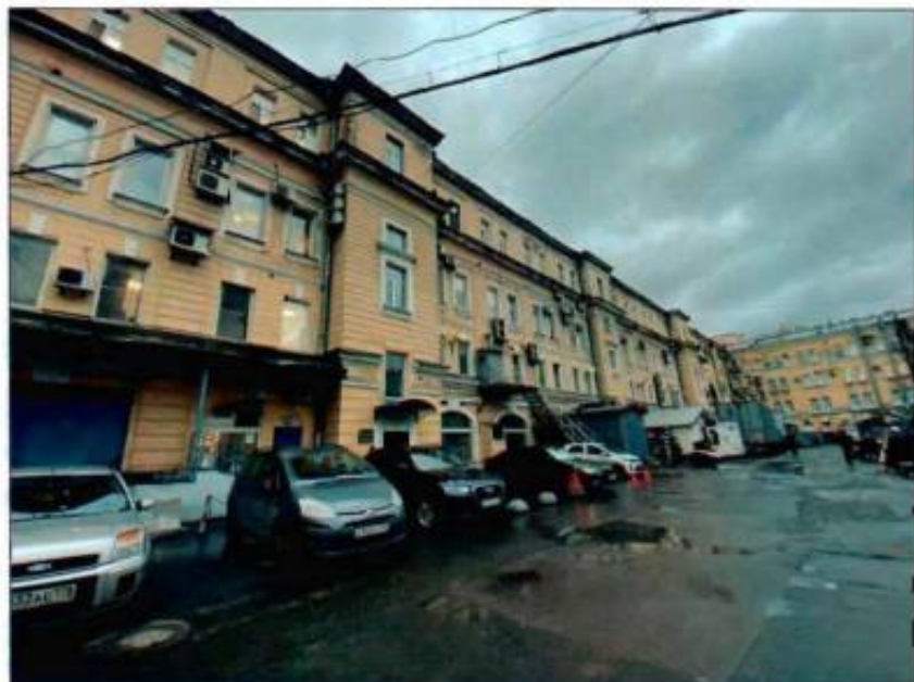
5. Фрагмент восточного дворового фасада части объекта культурного наследия.
