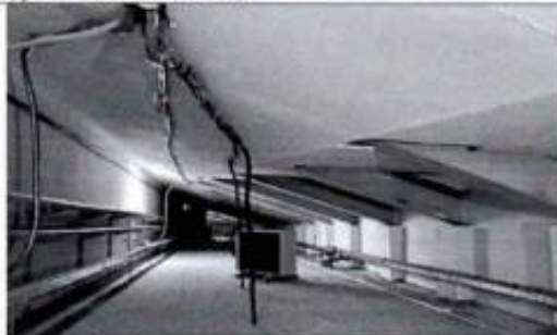
Фото 17. Фрагмент конструкции крыши (фото от 12.05.2022).
