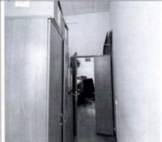
Фото 60. Помещение 2 этажа (пом. 7-Н (5)) (фото от 12.05.2022).
