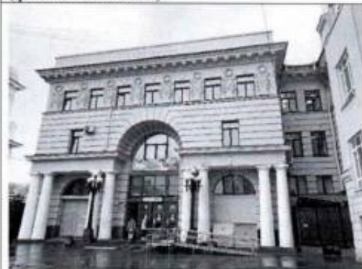
Фото 5. Юго-восточный фасад (фото от 12.05.2022).
