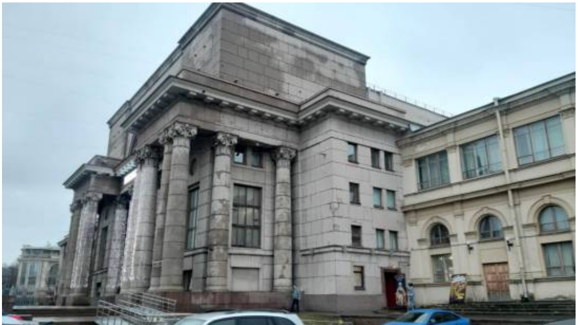
6. «Здание Театра им. Ленинского комсомола» (Александровский парк, д. 4, лит. Т). Фото мест установки оборудования и прокладки кабельных трасс. Штиглиц М.С. 17.12.2025.
