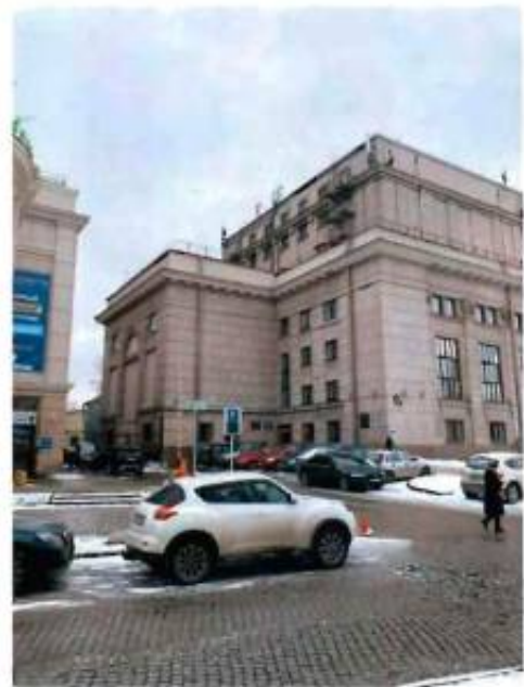
5. Фрагмент восточного фасада объекта культурного наследия.
