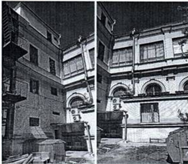
Фото 11, 12. Дворовой фасад объекта культурного наследия
