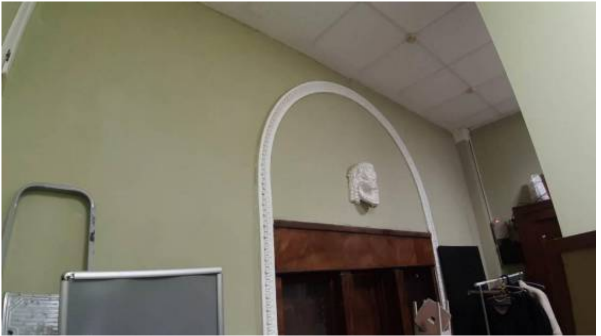
21. «Здание Театра им. Ленинского комсомола» (Александровский парк, д. 4, лит. Т). Интерьер. 1-й этаж. Фото мест установки оборудования и прокладки кабельных трасс. Штиглиц М.С. 17.12.2025.
