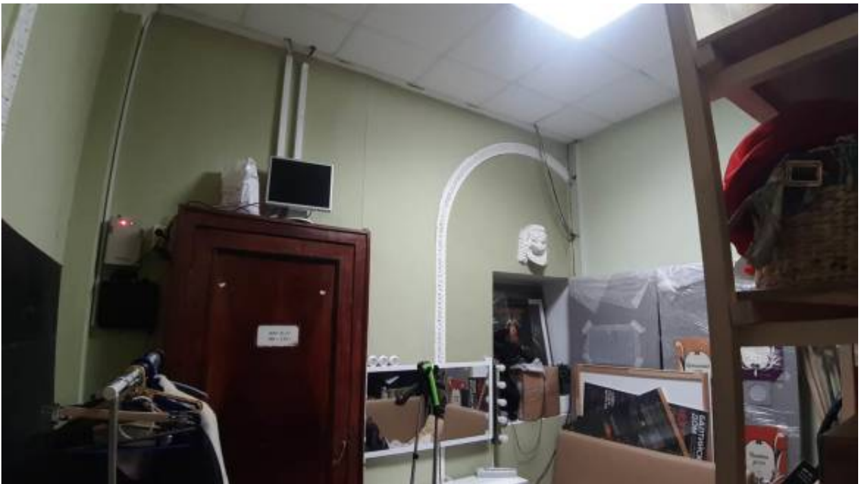
20. «Здание Театра им. Ленинского комсомола» (Александровский парк, д. 4, лит. Т). Интерьер. 1-й этаж. Фото мест установки оборудования и прокладки кабельных трасс. Штиглиц М.С. 17.12.2025.
