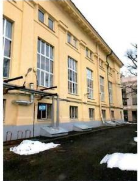
7. Фрагмент южного фасада объекта объекта культурного наследия.
