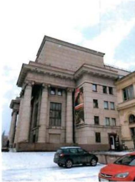
2. Западный фасад объекта культурного наследия.
