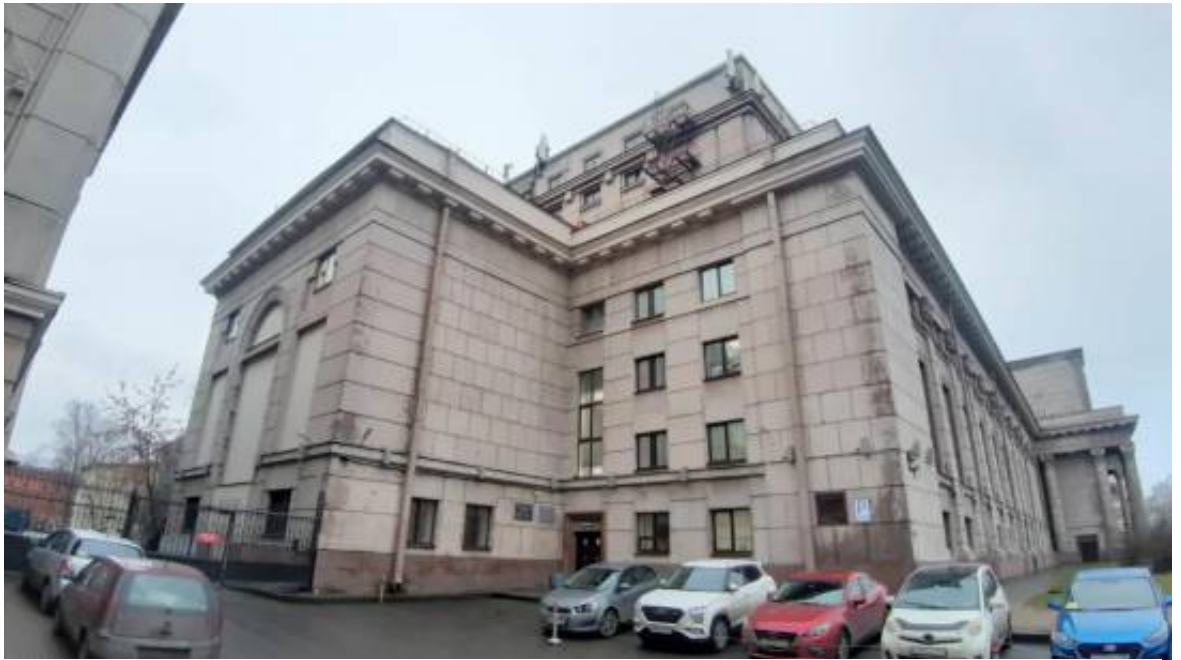
9. «Здание Театра им. Ленинского комсомола» (Александровский парк, д. 4, лит. Т). Фото мест установки оборудования и прокладки кабельных трасс. Штиглиц М.С. 17.12.2025.
