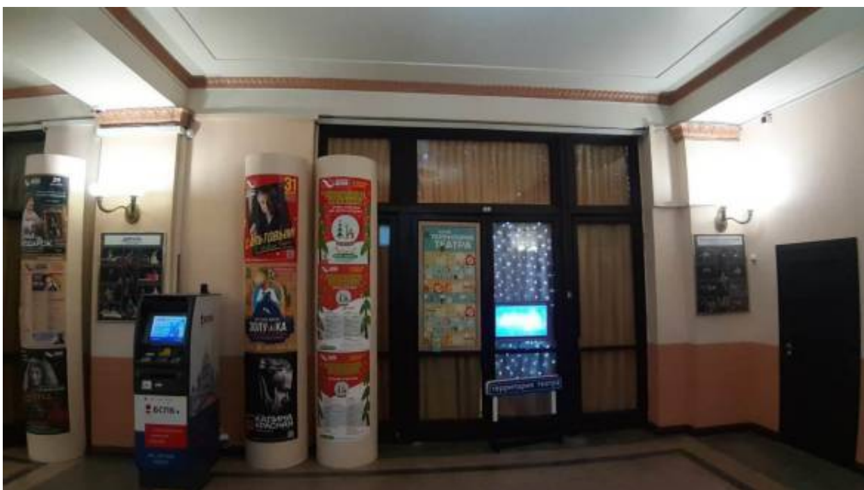
24. «Здание Театра им. Ленинского комсомола» (Александровский парк, д. 4, лит. Т). Интерьер. 1-й этаж. Фото мест установки оборудования и прокладки кабельных трасс. Штиглиц М.С. 17.12.2025.
