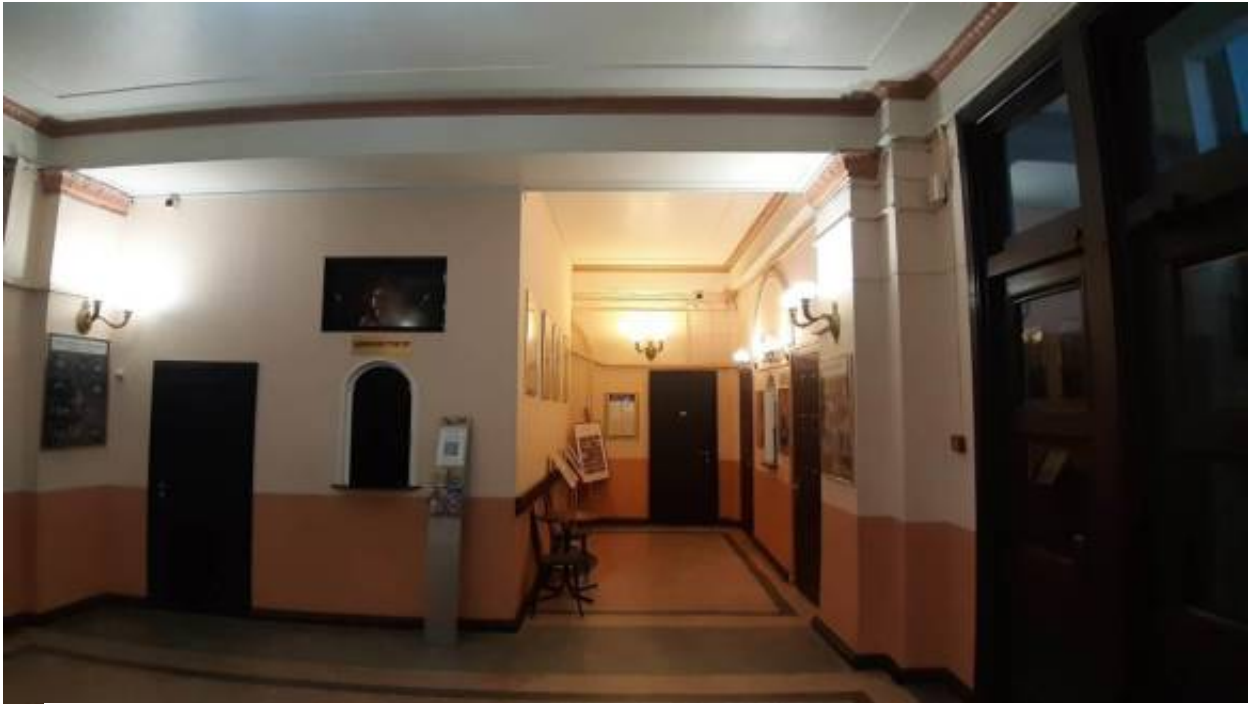
19. «Здание Театра им. Ленинского комсомола» (Александровский парк, д. 4, лит. Т). Интерьер. 1-й этаж. Фото мест установки оборудования и прокладки кабельных трасс. Штиглиц М.С. 17.12.2025.
