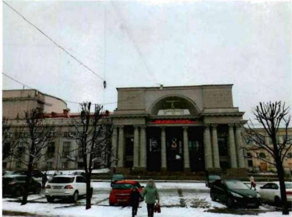
1. Фрагмент северного фасада объекта культурного наследия.
