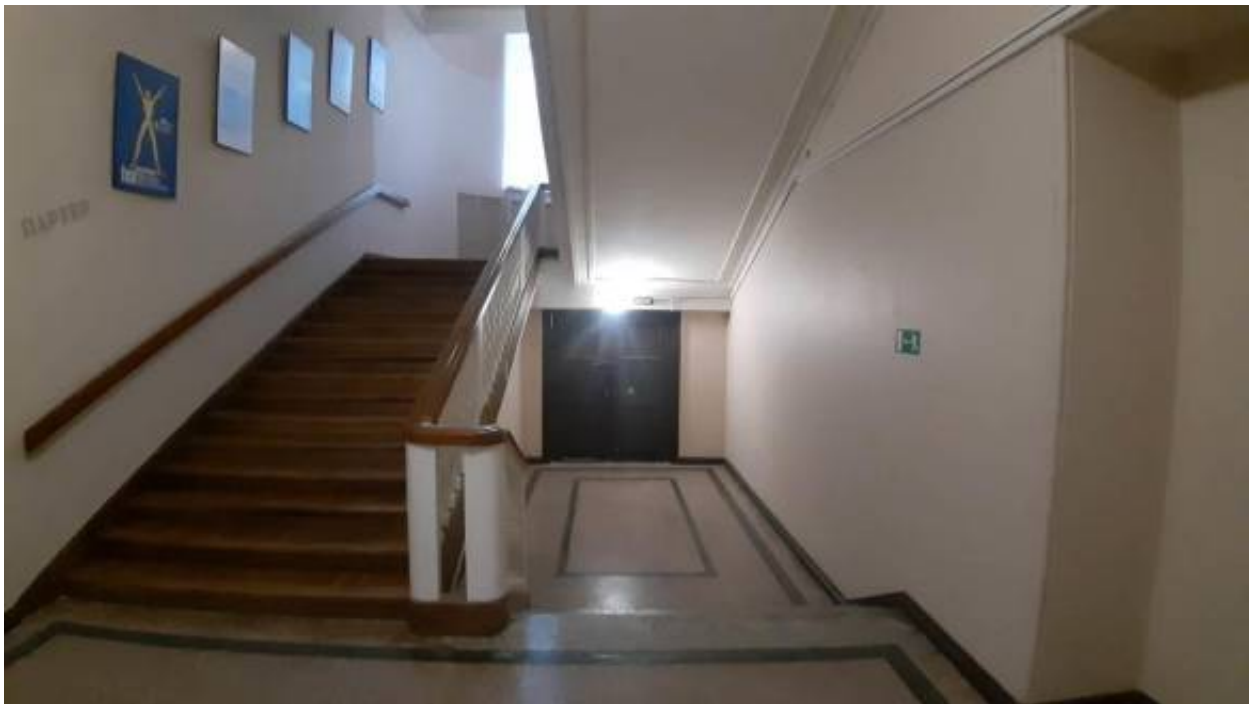
14. «Здание Театра им. Ленинского комсомола» (Александровский парк, д. 4, лит. Т). Интерьер. 1-й этаж. Фото мест установки оборудования и прокладки кабельных трасс. Штиглиц М.С. 17.12.2025.
