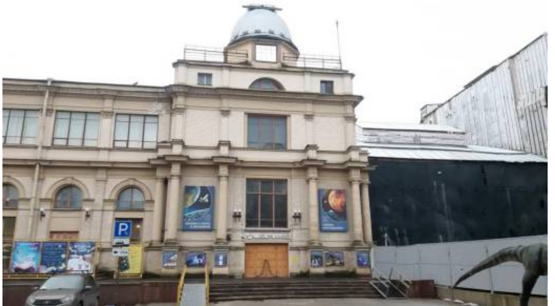
2. «Железный зал» (в составе «Комплекса зданий Народного дома императора Николая II» (Александровский парк, д. 4, лит. Т). Фото мест установки оборудования и прокладки кабельных трасс. Штиглиц М.С. 17.12.2025.
