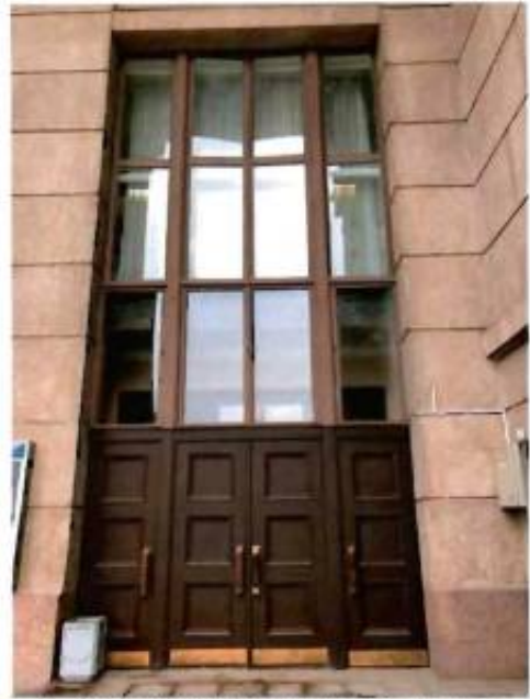
3. Фрагмент северного фасада объекта культурного наследия. Парадный вход западного ризалита.
