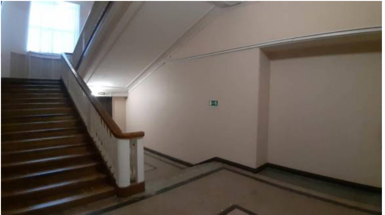
13. «Здание Театра им. Ленинского комсомола» (Александровский парк, д. 4, лит. Т). Интерьер. 1-й этаж. Фото мест установки оборудования и прокладки кабельных трасс. Штиглиц М.С. 17.12.2025.
