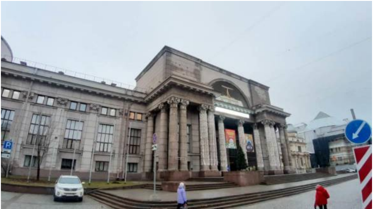
7. «Здание Театра им. Ленинского комсомола» (Александровский парк, д. 4, лит. Т). Фото мест установки оборудования и прокладки кабельных трасс. Штиглиц М.С. 17.12.2025.
