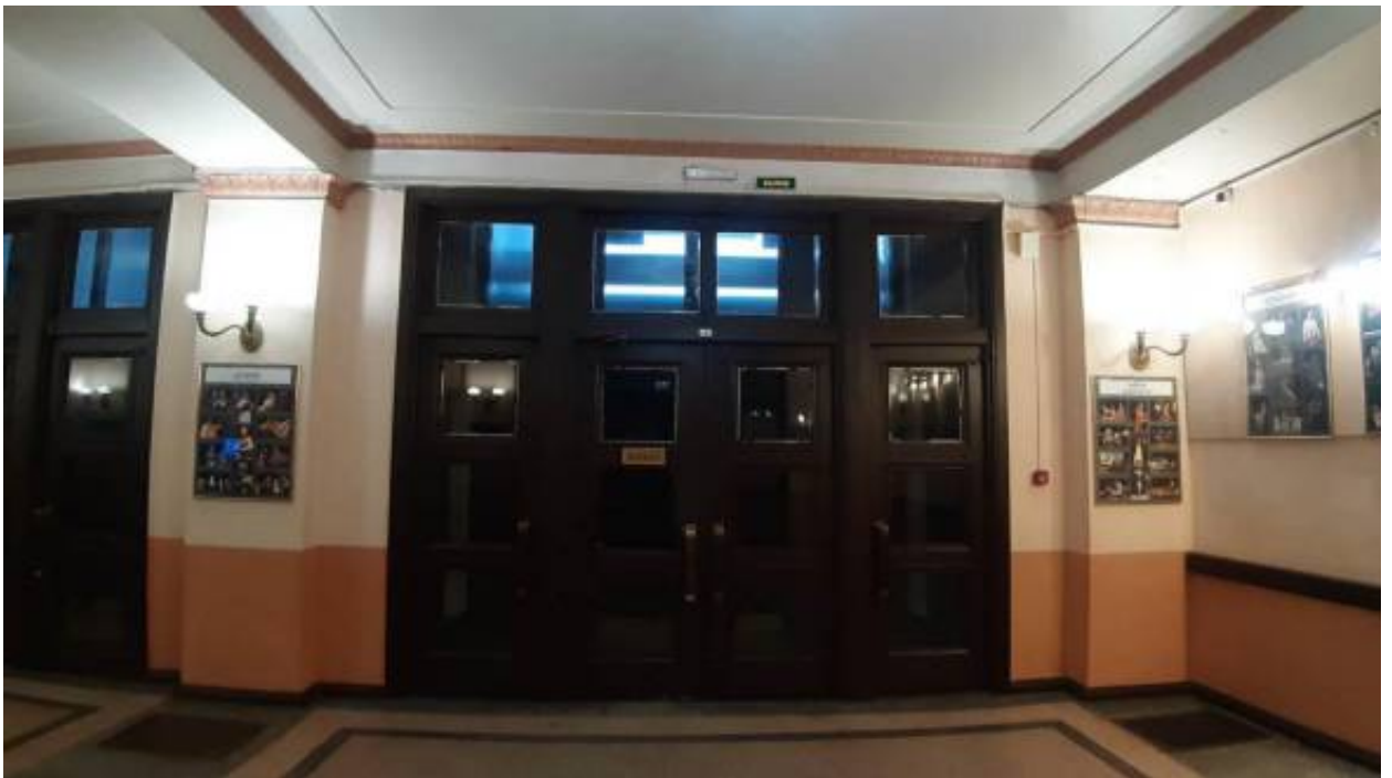
18. «Здание Театра им. Ленинского комсомола» (Александровский парк, д. 4, лит. Т). Интерьер. 1-й этаж. Фото мест установки оборудования и прокладки кабельных трасс. Штиглиц М.С. 17.12.2025.
