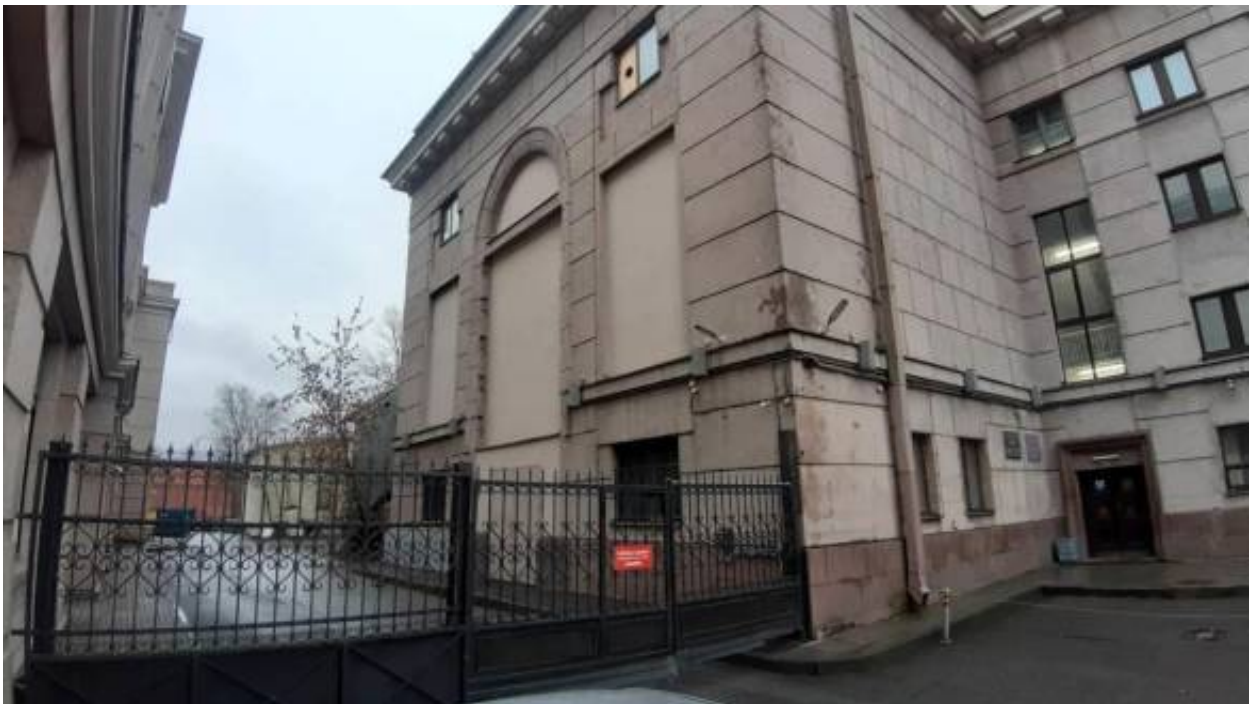
8. «Здание Театра им. Ленинского комсомола» (Александровский парк, д. 4, лит. Т). Фото мест установки оборудования и прокладки кабельных трасс. Штиглиц М.С. 17.12.2025.
