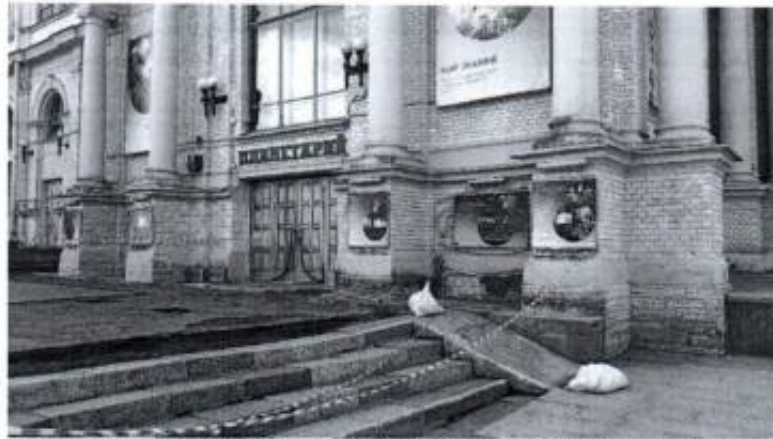
Фото 3. Стилобат и лестница на входе со стороны ризалита северного фасада объекта культурного наследия
