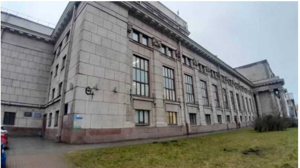
12. «Здание Театра им. Ленинского комсомола» (Александровский парк, д. 4, лит. Т). Фото мест установки оборудования и прокладки кабельных трасс. Штиглиц М.С. 17.12.2025.
