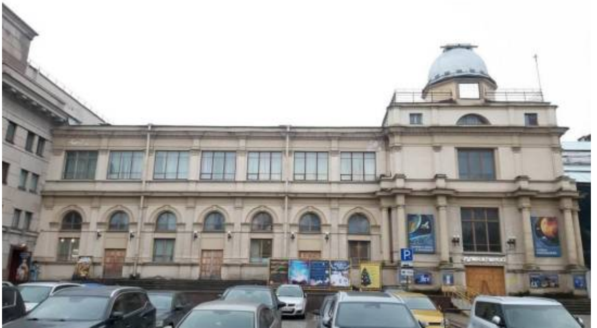
1. «Железный зал» (в составе «Комплекса зданий Народного дома императора Николая II» (Александровский парк, д. 4, лит. Т). Общий вид. Штиглиц М.С. 17.12.2025.
