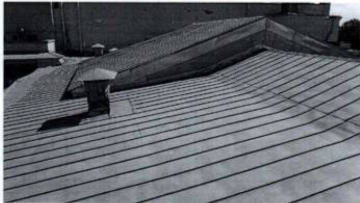
Фото 8. Крыша объекта культурного наследия
