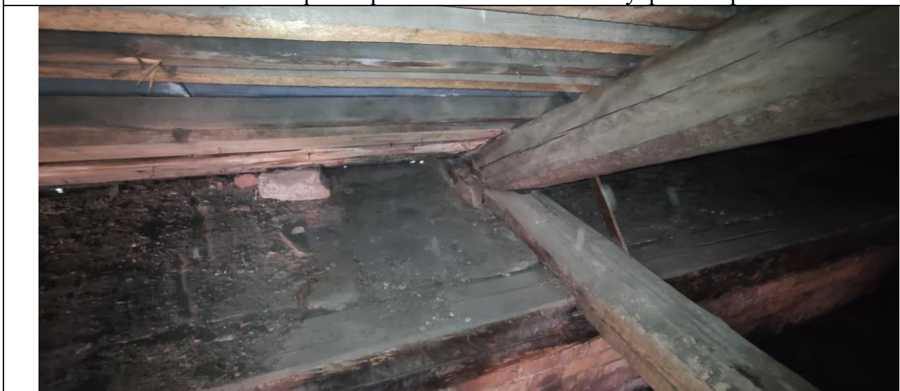
15.Анатомический театр». Стропильная система. Мауэрлат. Фрагмент.
