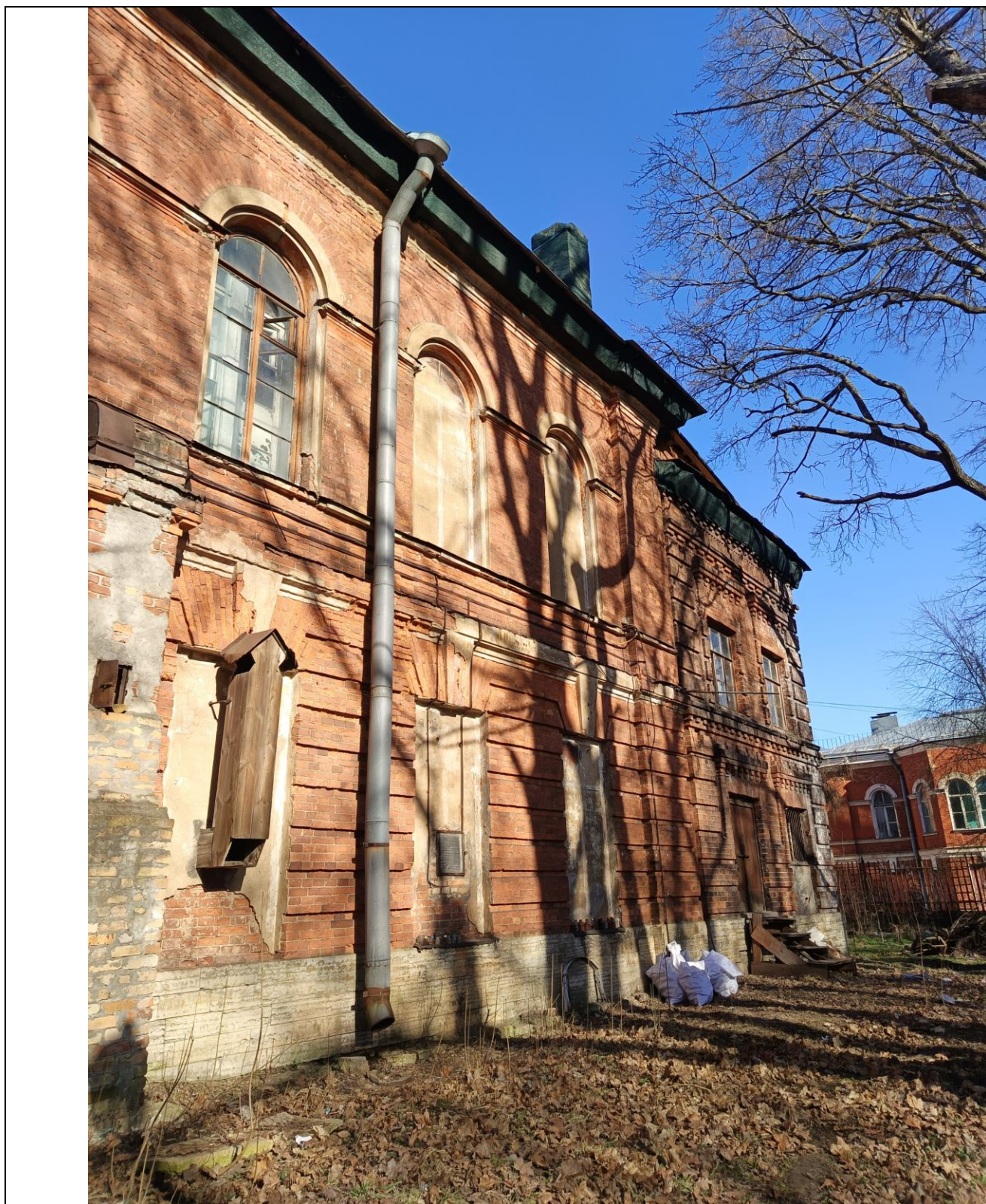
6. «Анатомический театр». Восточный (дворовый) фасад. Двухэтажная пристройка.
