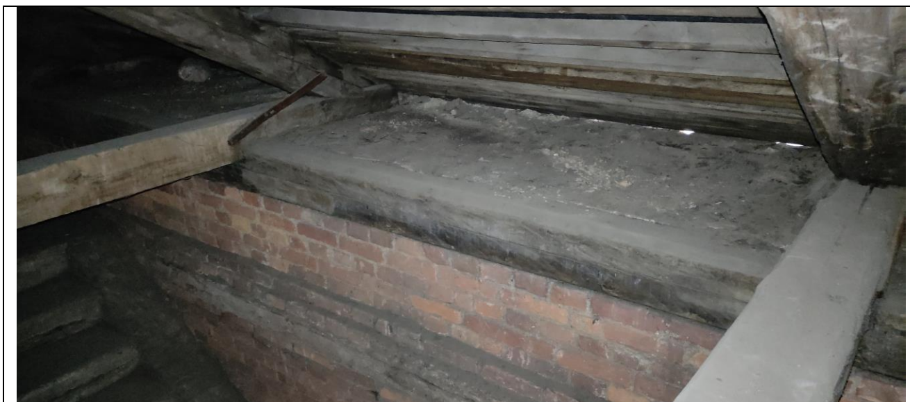
14.Анатомический театр». Стропильная система. Мауэрлат. Фрагмент.
