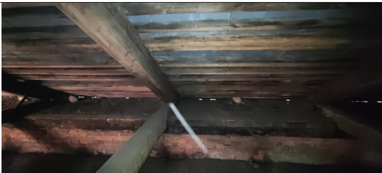
12. «Анатомический театр». Стропильная система. Фрагмент.
