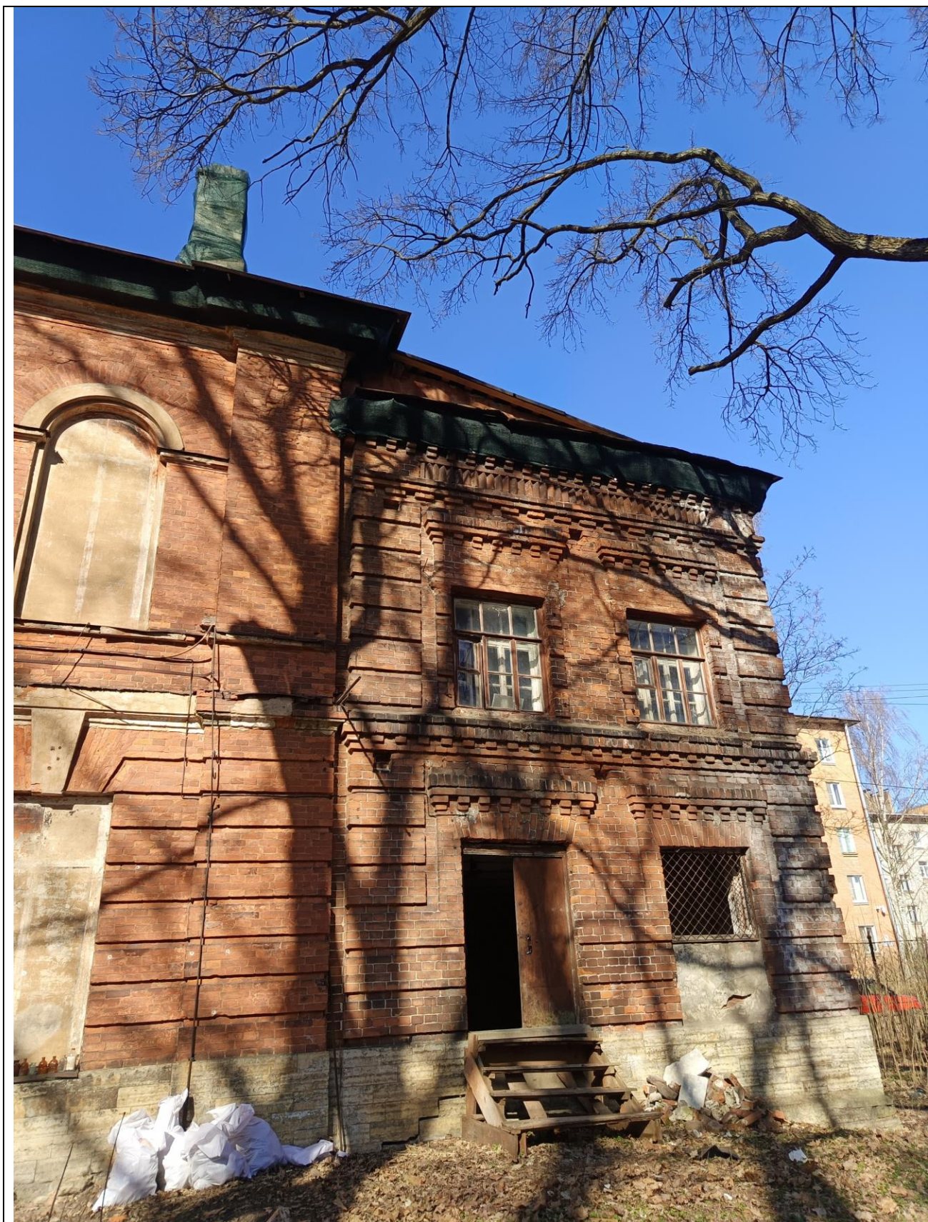
8. «Анатомический театр». Восточный (дворовый) фасад. Двухэтажная пристройка.
