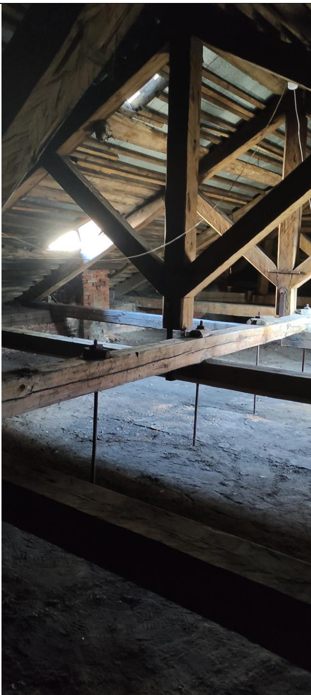
13.Анатомический театр». Стропильная система. Фрагмент.
