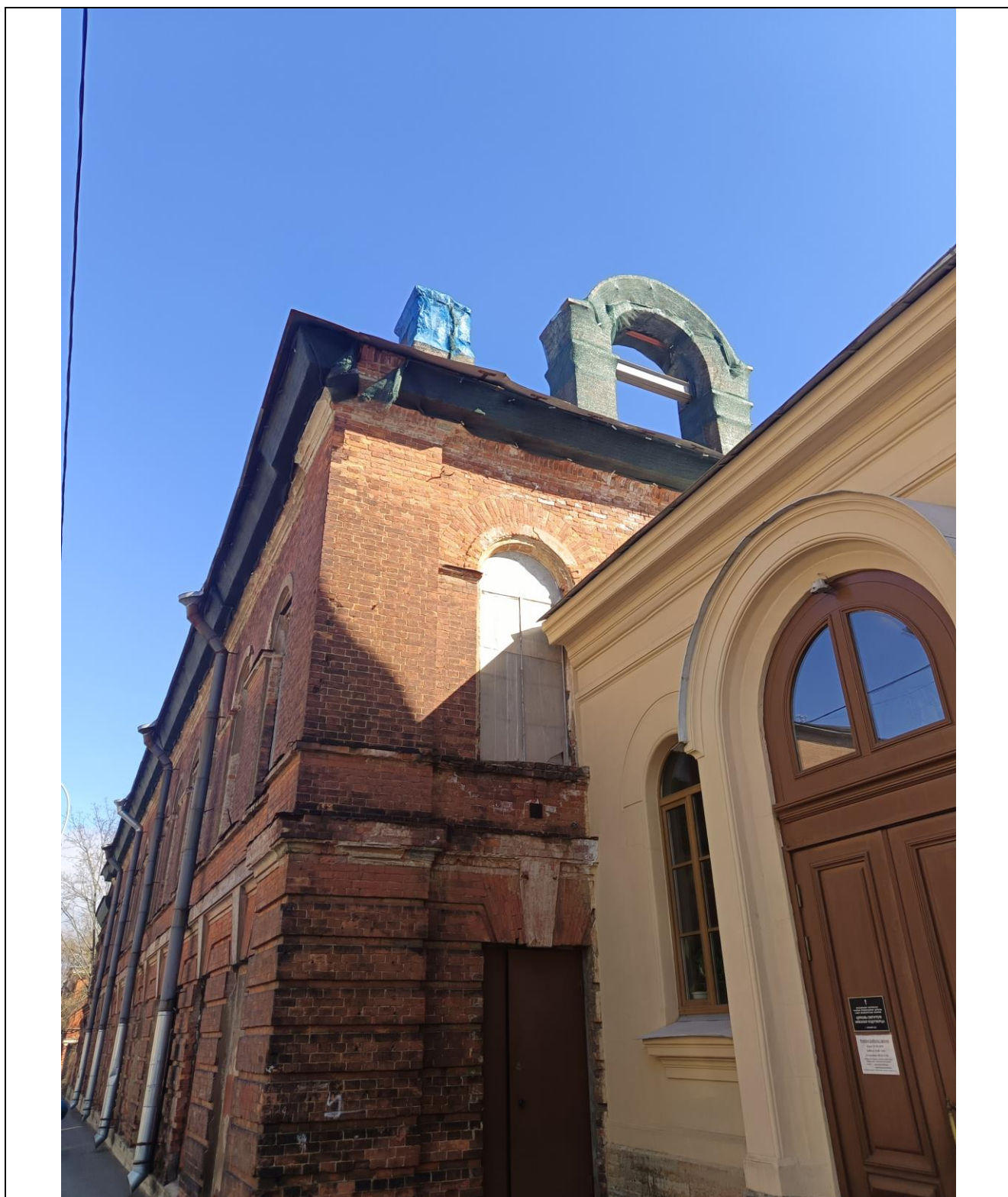
3. «Анатомический театр». Фасад по ул. Мануильского и часть южного фасада в месте примыкания часовни.
