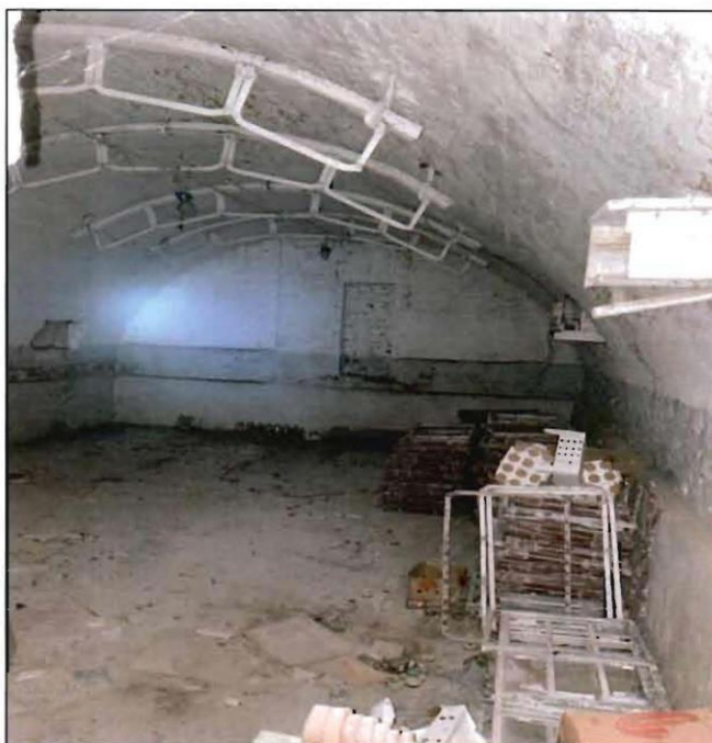
7. Фрагмент подвального помещения.
