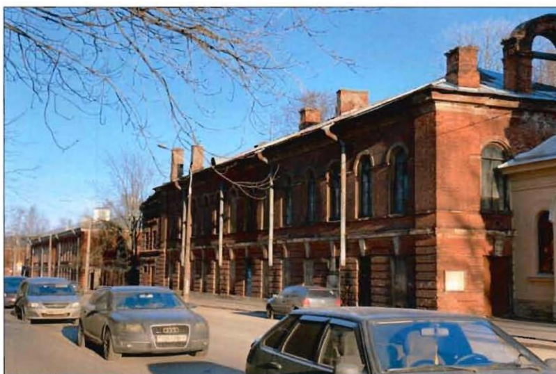
1. Общий вид на лицевой фасад со стороны улицы Мануильского.
