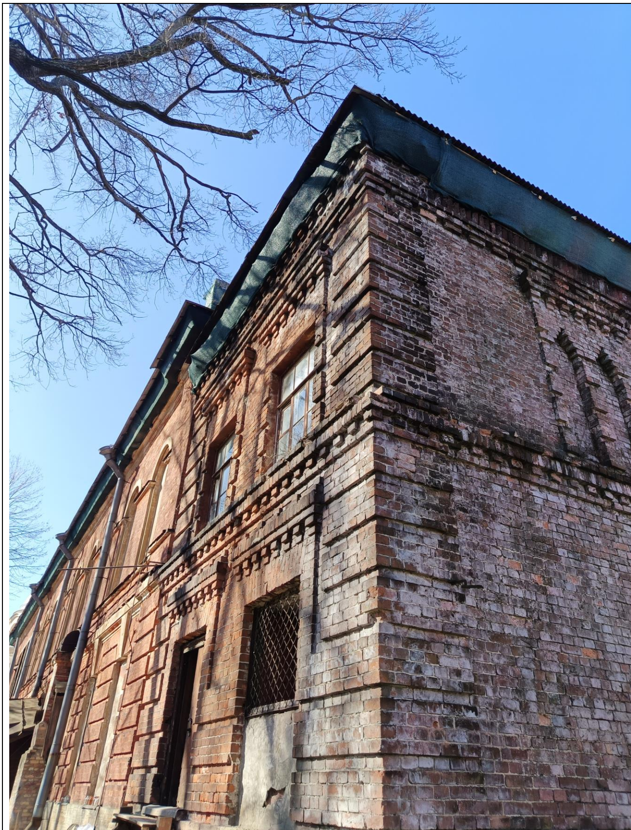
10. «Анатомический театр». Восточный и северный фасад кирпичной пристройки.
