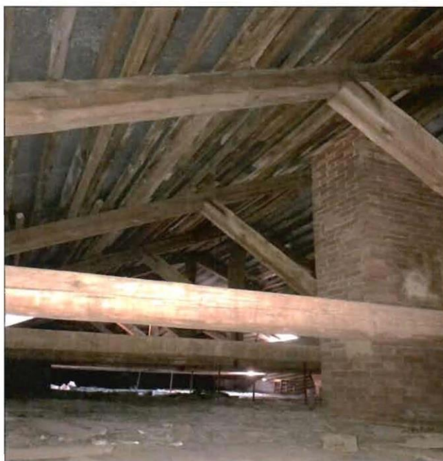
8. Фрагмент стропильной системы.
