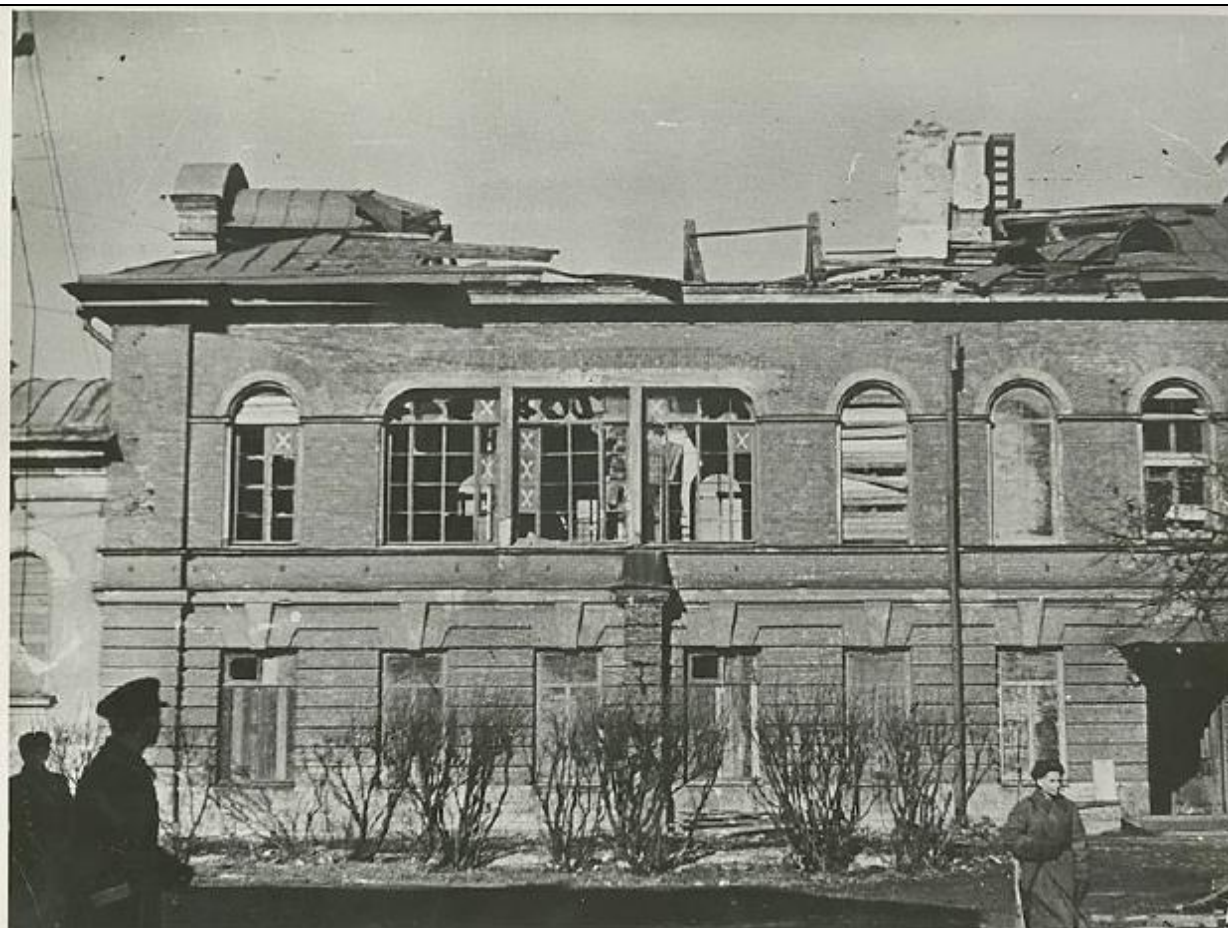
18. Корпус Морского госпиталя, поврежденный в результате обстрела. Апрель 1942 г. ЦГАКФФД СПб Ар 46628
