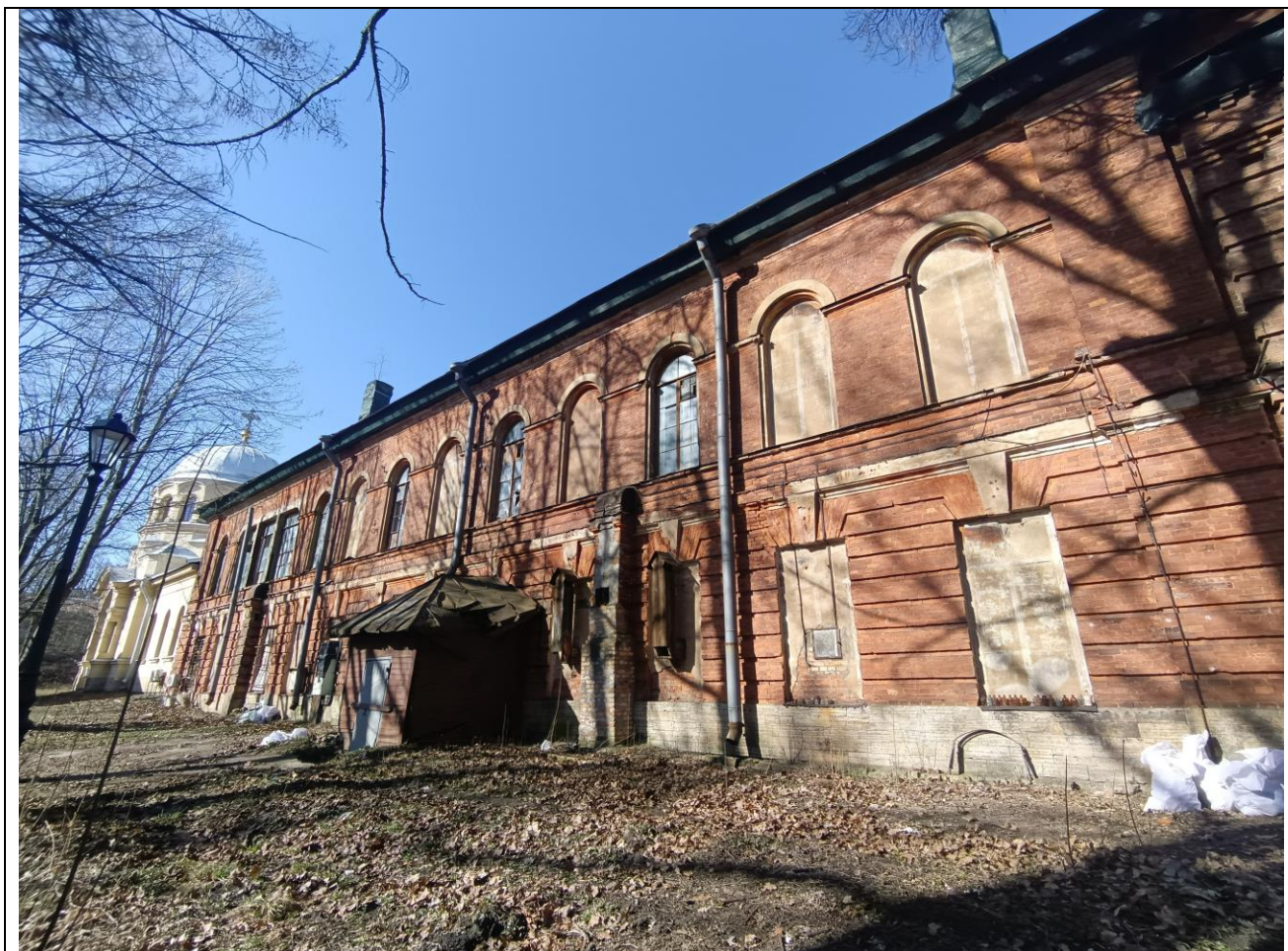
5. «Анатомический театр». Восточный (дворовый) фасад. Общий вид.
