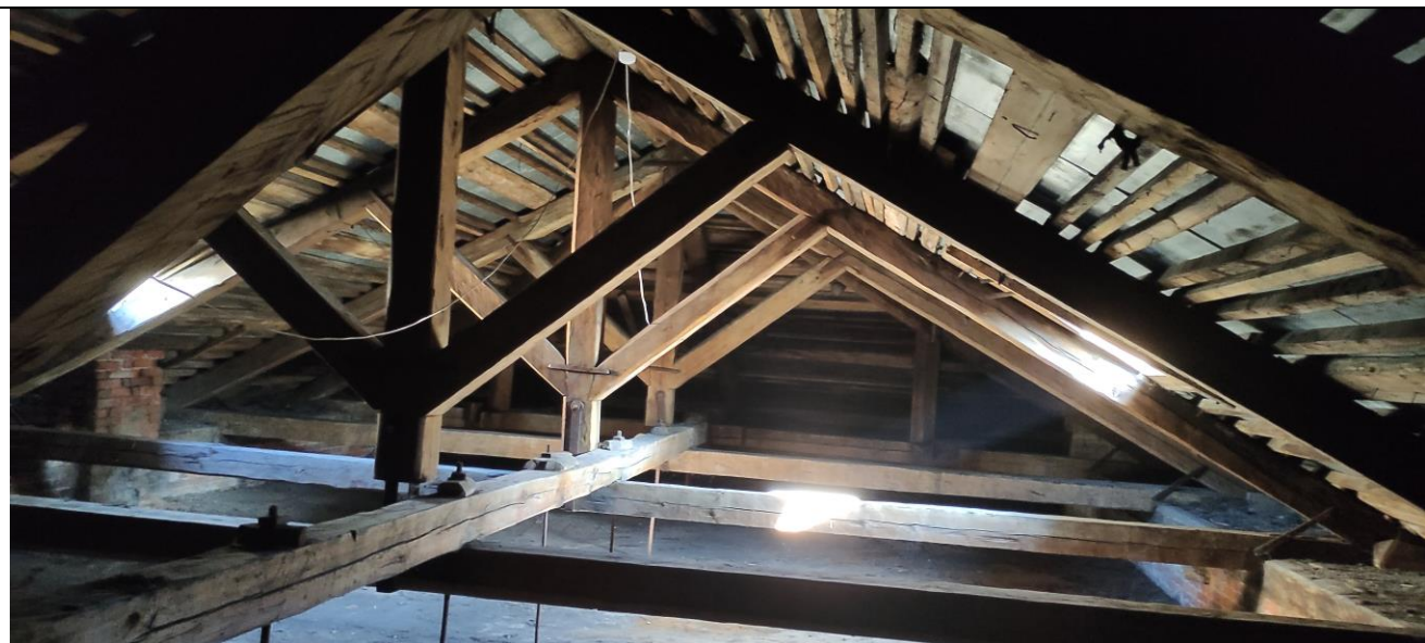
11. «Анатомический театр». Стропильная система. Общий вид.
