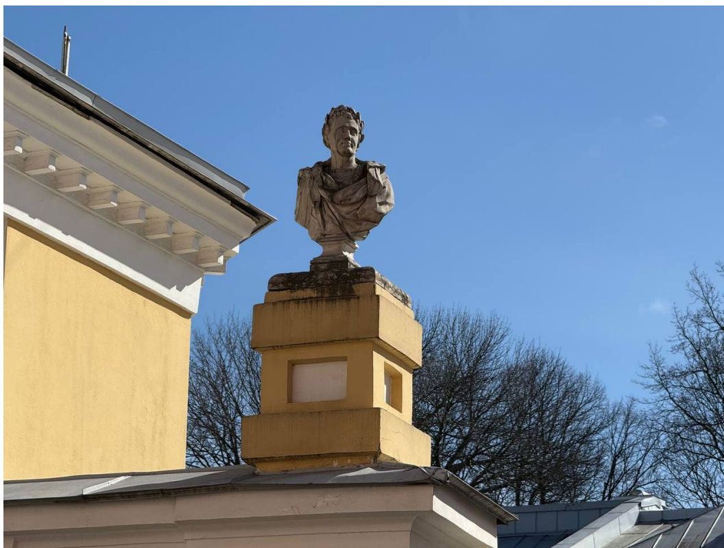
Фотография 19 Объекта культурного наследия федерального значения «Ограда с воротами». Дата съёмки 06.04.2026
