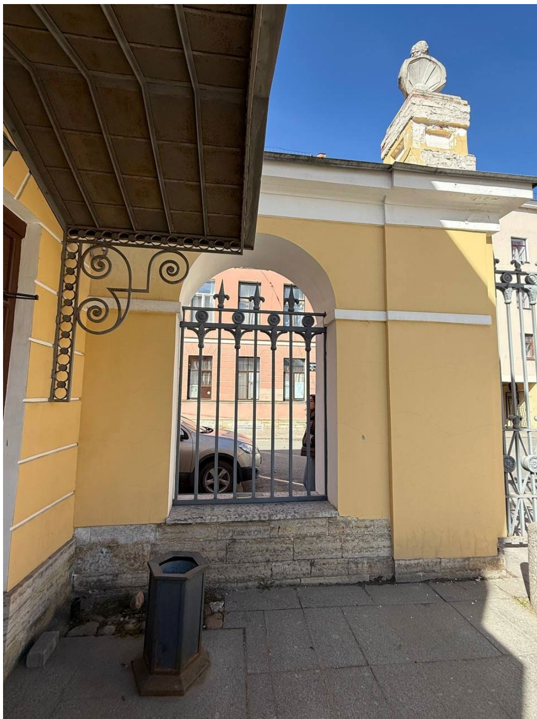
Фотография 14 Объекта культурного наследия федерального значения «Ограда с воротами». Дата съёмки 06.04.2026
