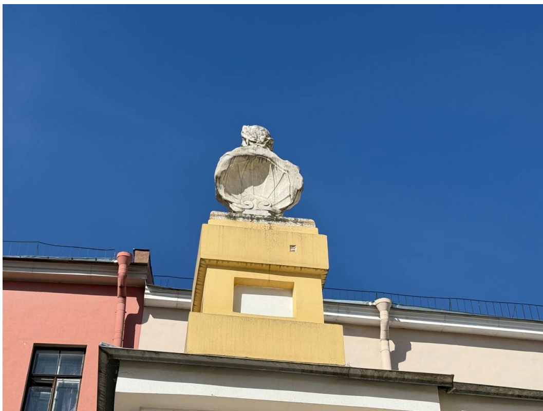
Фотография 11 Объекта культурного наследия федерального значения «Ограда с воротами». Дата съёмки 06.04.2026
