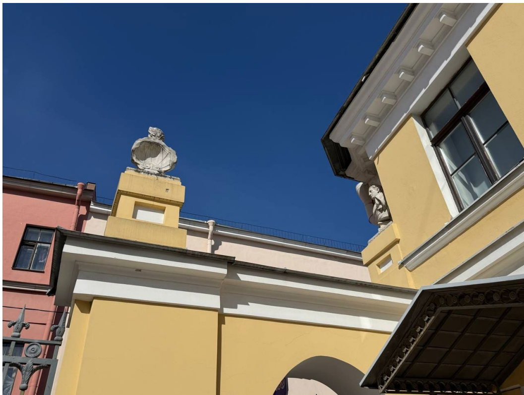
Фотография 10 Объекта культурного наследия федерального значения «Ограда с воротами». Дата съёмки 06.04.2026
