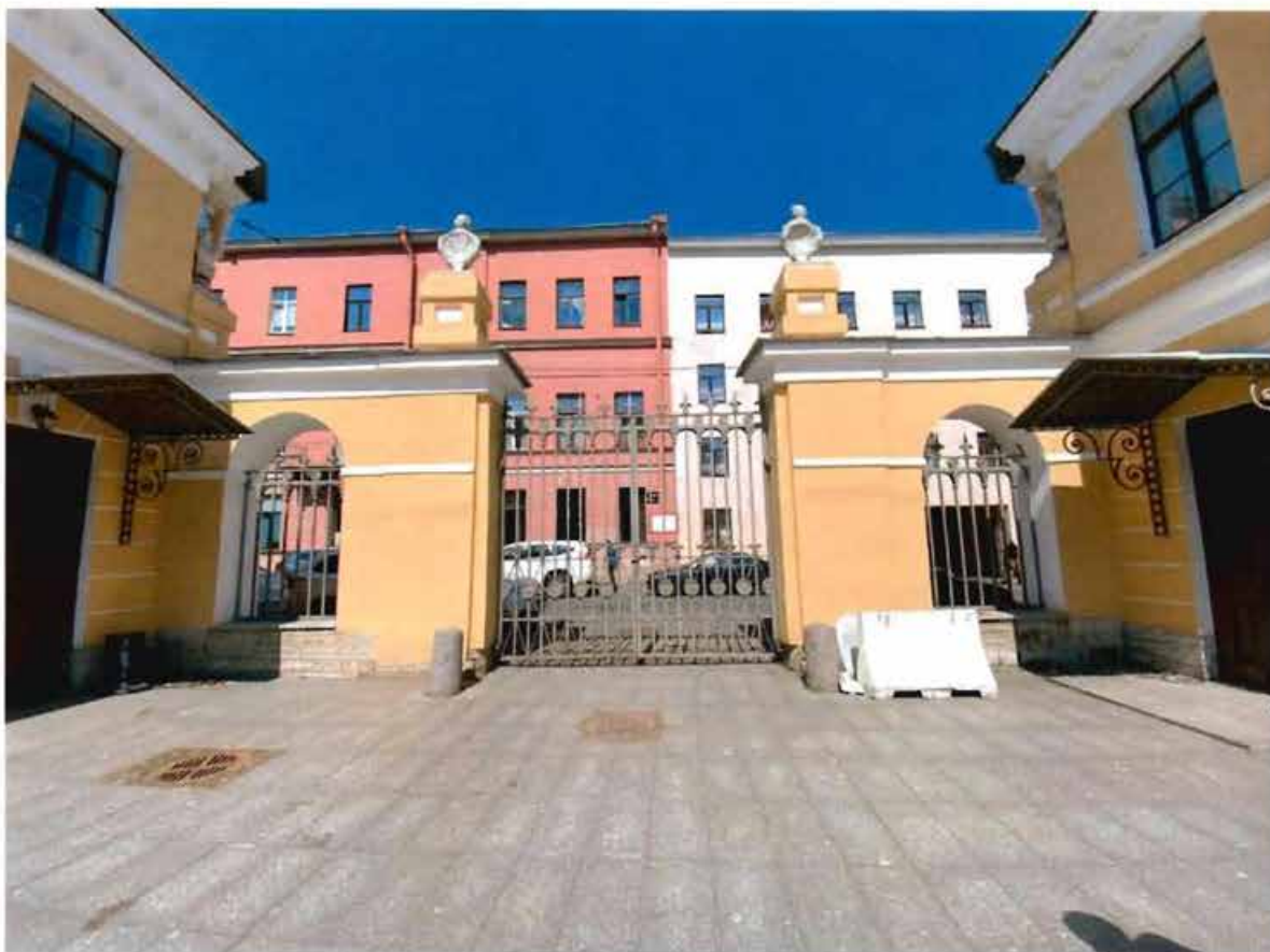
2. Южный фасад объекта культурного наследия.
