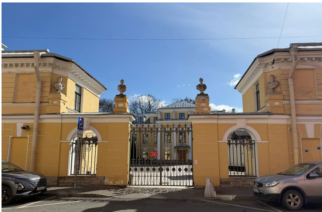
Фотография 13 Объекта культурного наследия федерального значения «Ограда с воротами». Дата съёмки 06.04.2026
