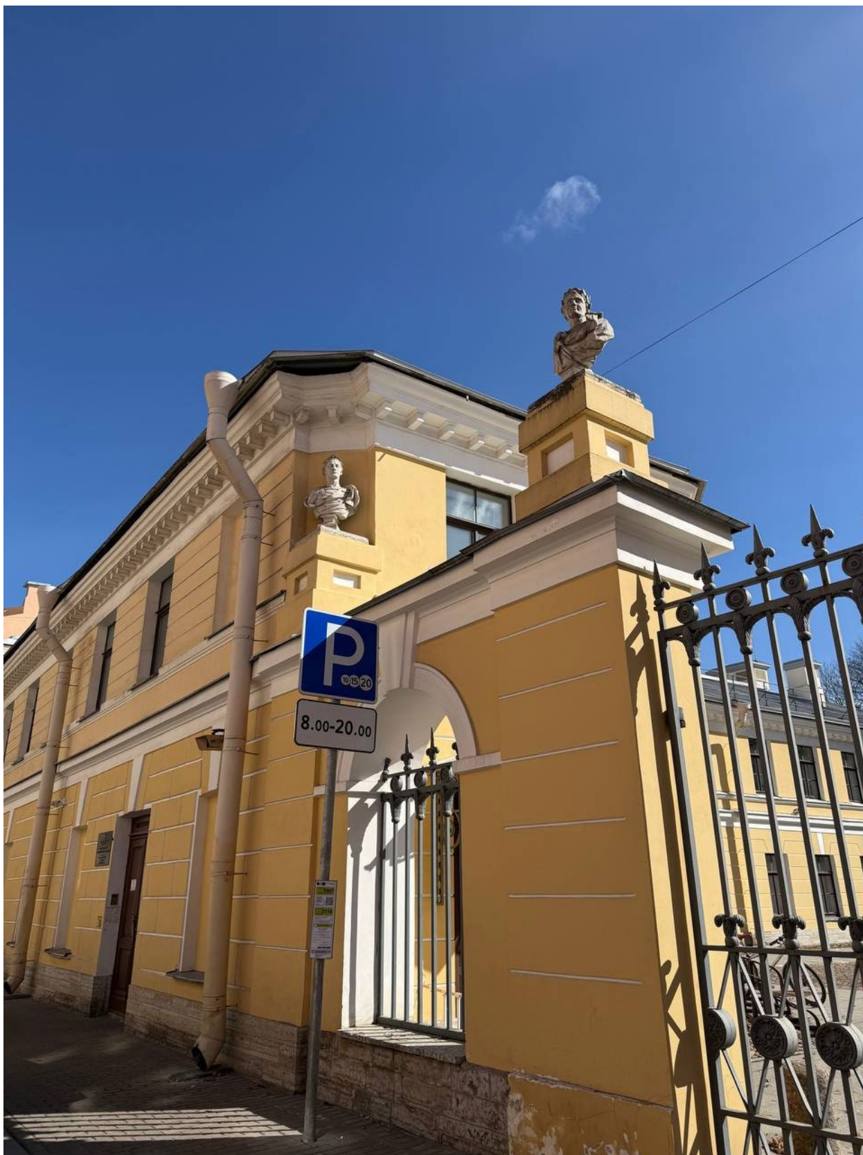
Фотография 6 Объекта культурного наследия федерального значения «Ограда с воротами». Дата съёмки 06.04.2026
