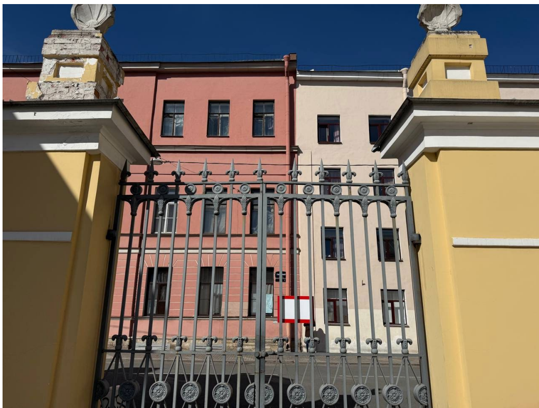
Фотография 18 Объекта культурного наследия федерального значения «Ограда с воротами». Дата съёмки 06.04.2026
