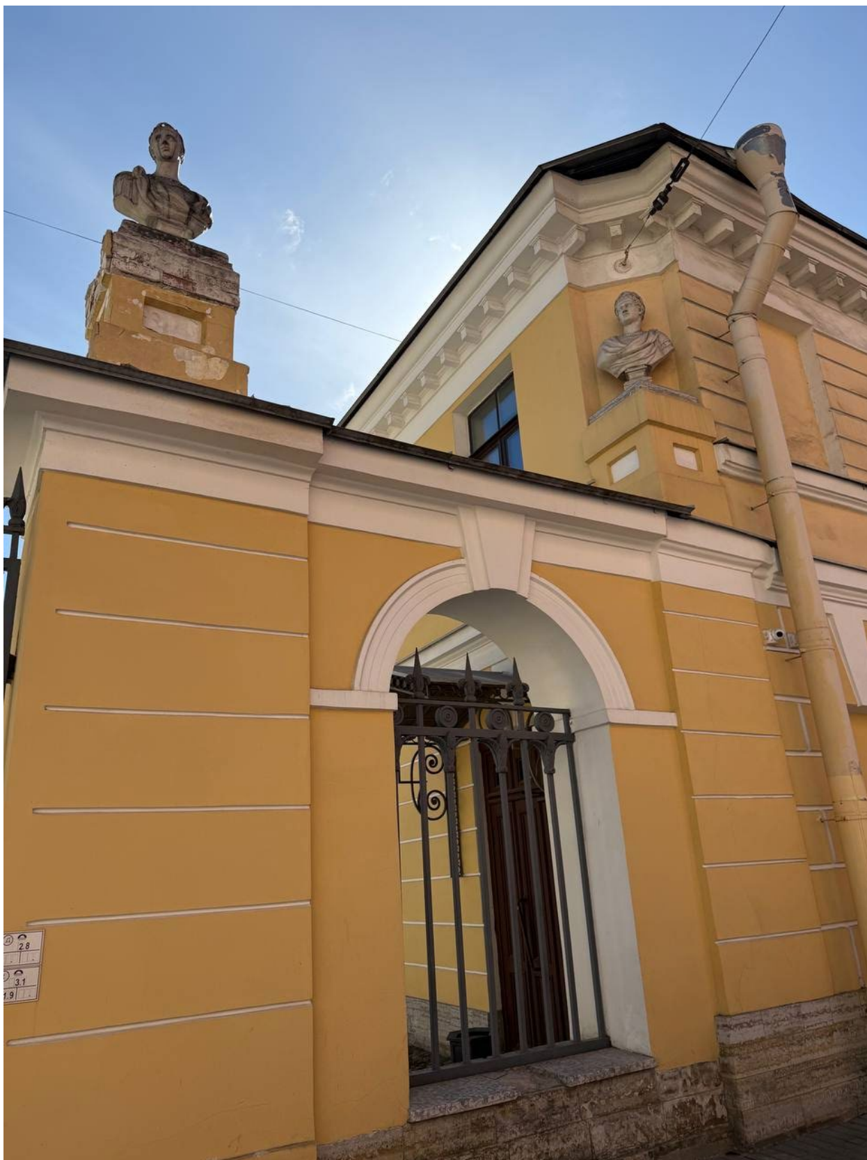
Фотография 5 Объекта культурного наследия федерального значения «Ограда с воротами». Дата съёмки 06.04.2026
