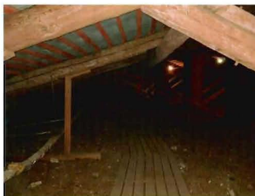
5. Стропильная система.
