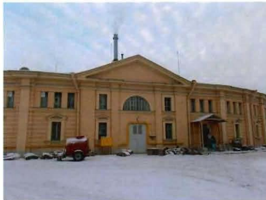
3. Фрагмент дворового фасада.
