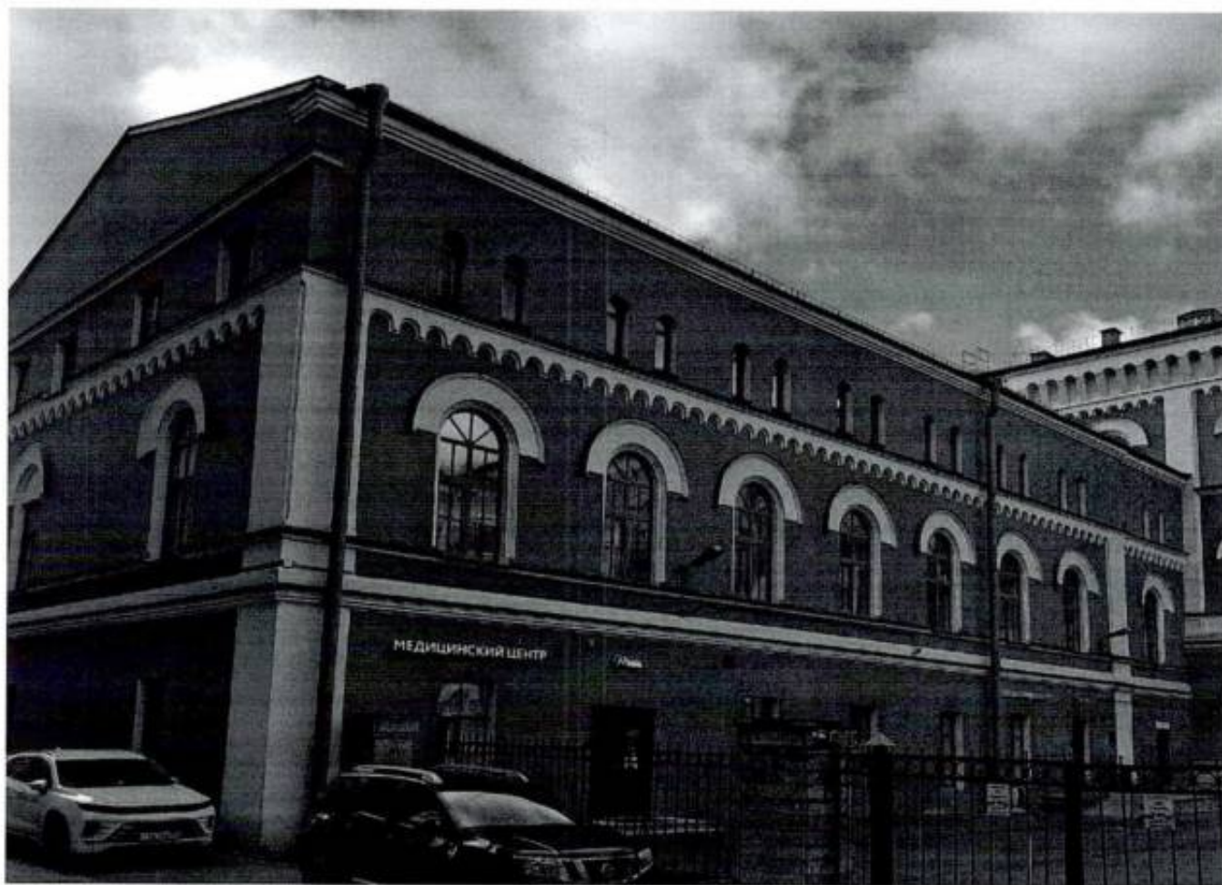
Фото 11. Лицевой фасад (фрагмент)
