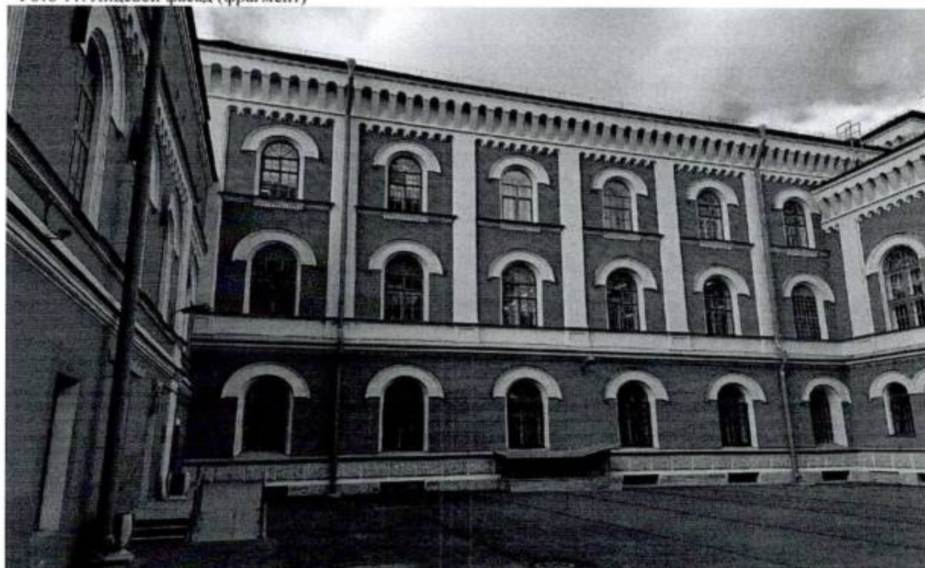
Фото 12. Лицевой фасад (фрагмент)
