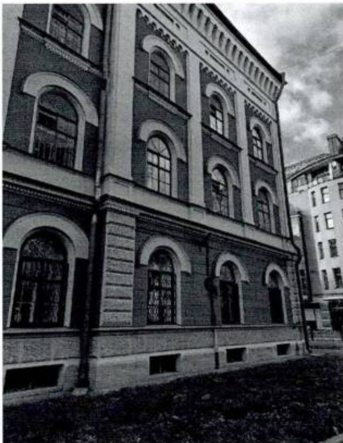
Фото 20. Лицевой фасад (фрагмент)
