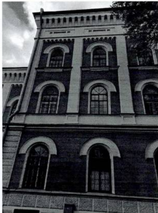
Фото 15. Лицевой фасад (фрагмент)
