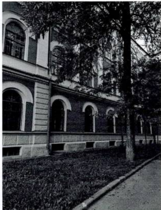
Фото 21. Лицевой фасад (фрагмент)
