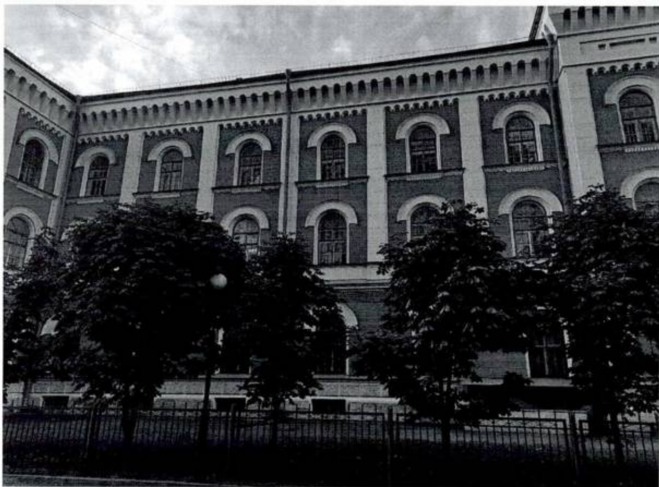
Фото 3. Лицевой фасад (общий вид)
