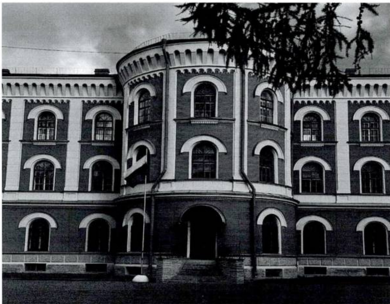
Фото 5. Лицевой фасад (общий вид)
