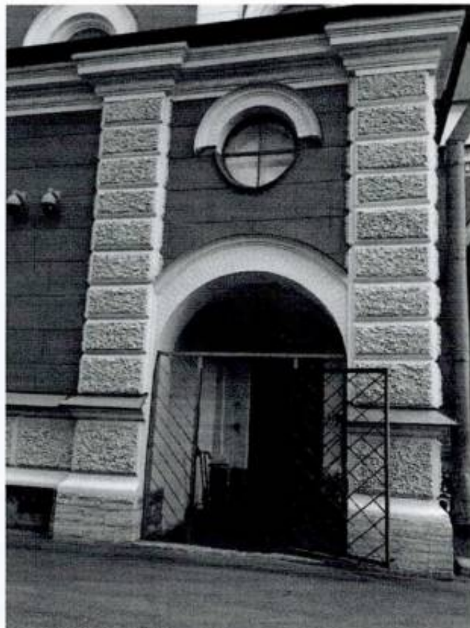
Фото 29. Лицевой фасад (фрагмент)
