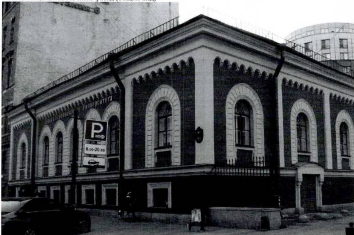
Фото 3. Лицевые фасады (общий вид)
