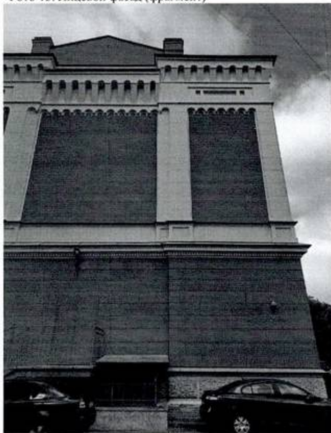
Фото 14. Лицевой фасад (фрагмент)
