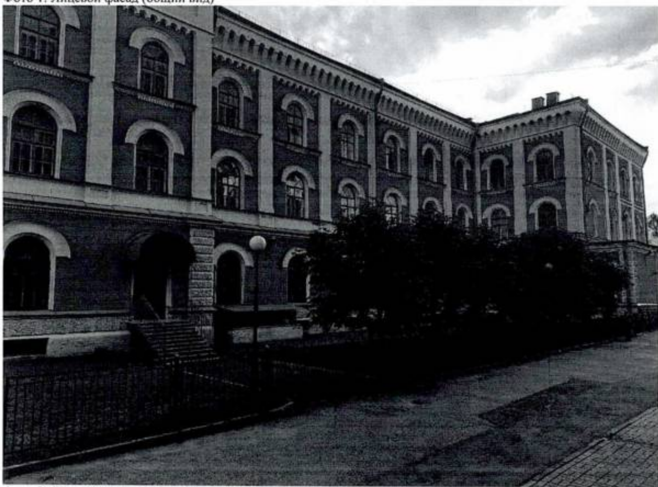
Фото 2. Лицевой фасад (общий вид)
