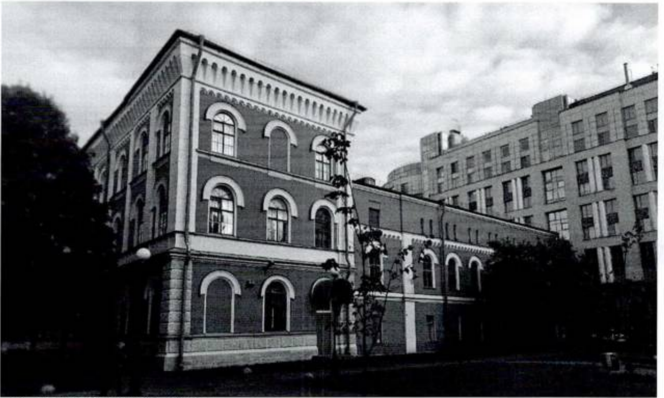
Фото 7. Лицевой фасад (общий вид)
