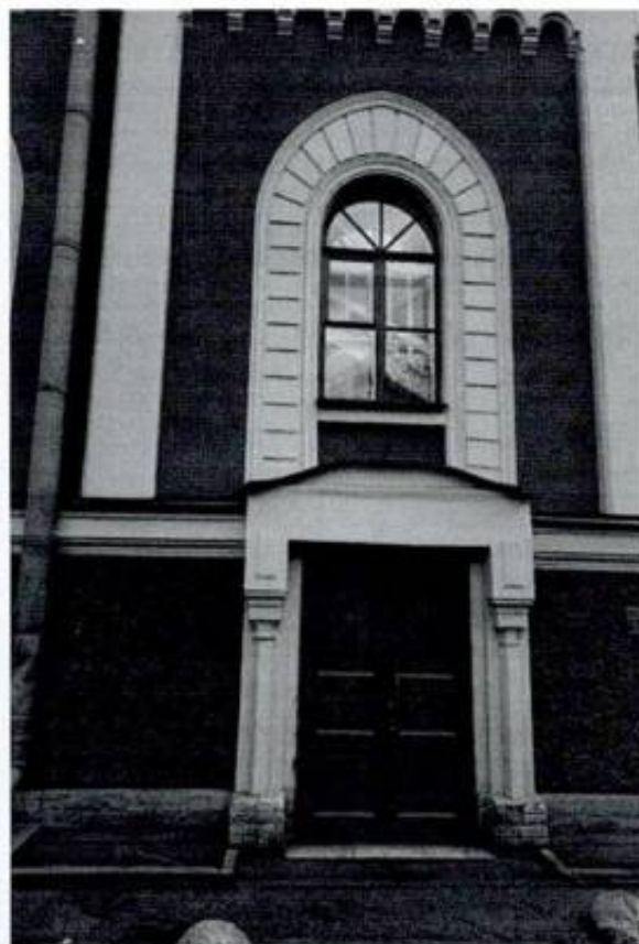
Фото 6. Лицевой фасад (фрагмент)
