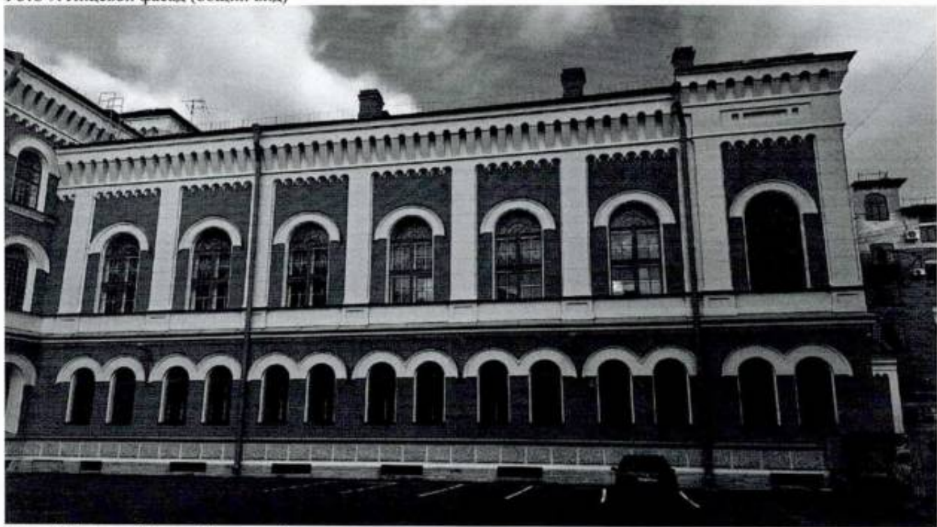
Фото 10. Лицевой фасад (фрагмент)
