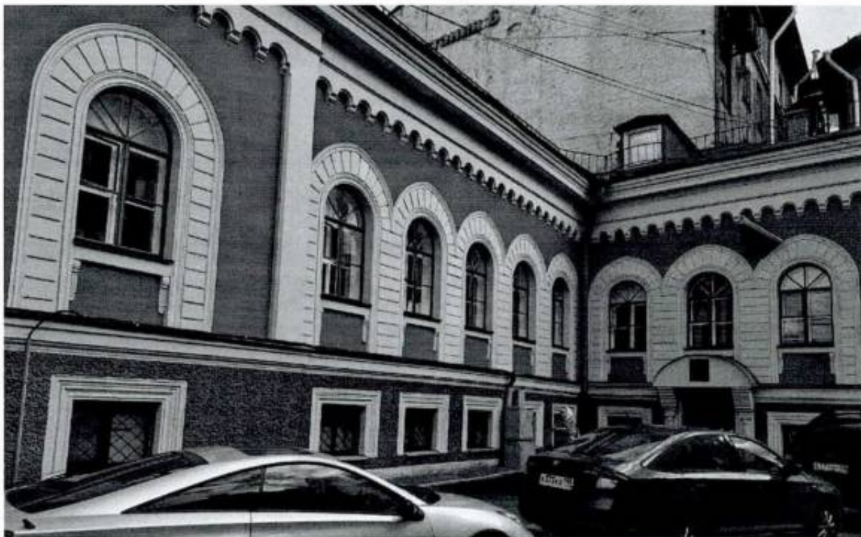
Фото 4. Лицевой западный фасад (общий вид)
