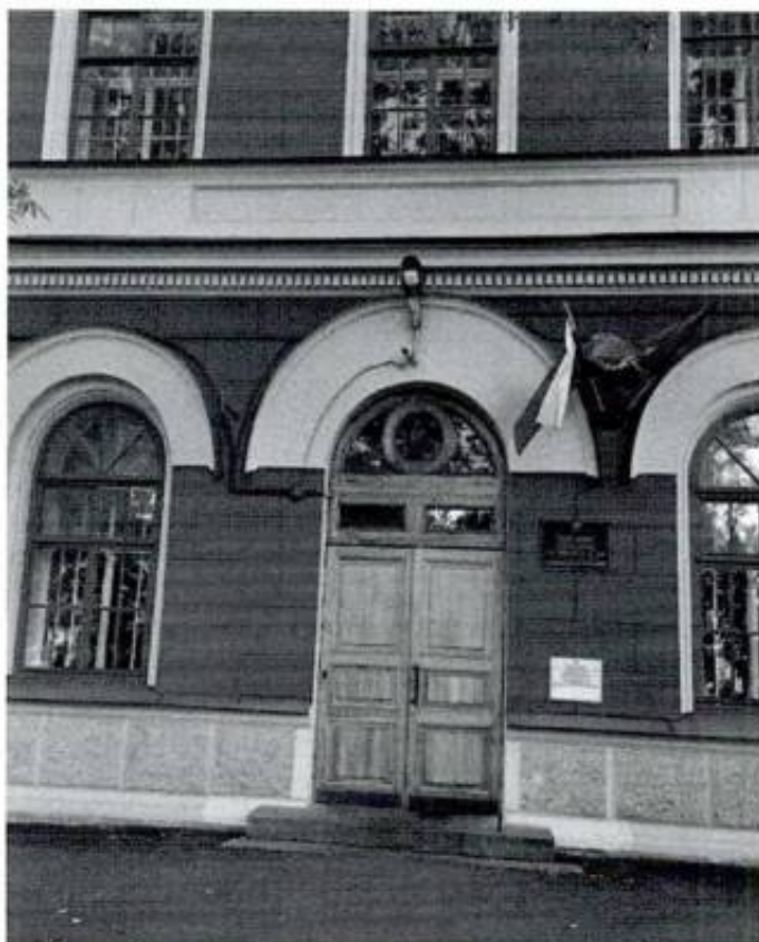
Фото 16. Лицевой фасад (фрагмент)
