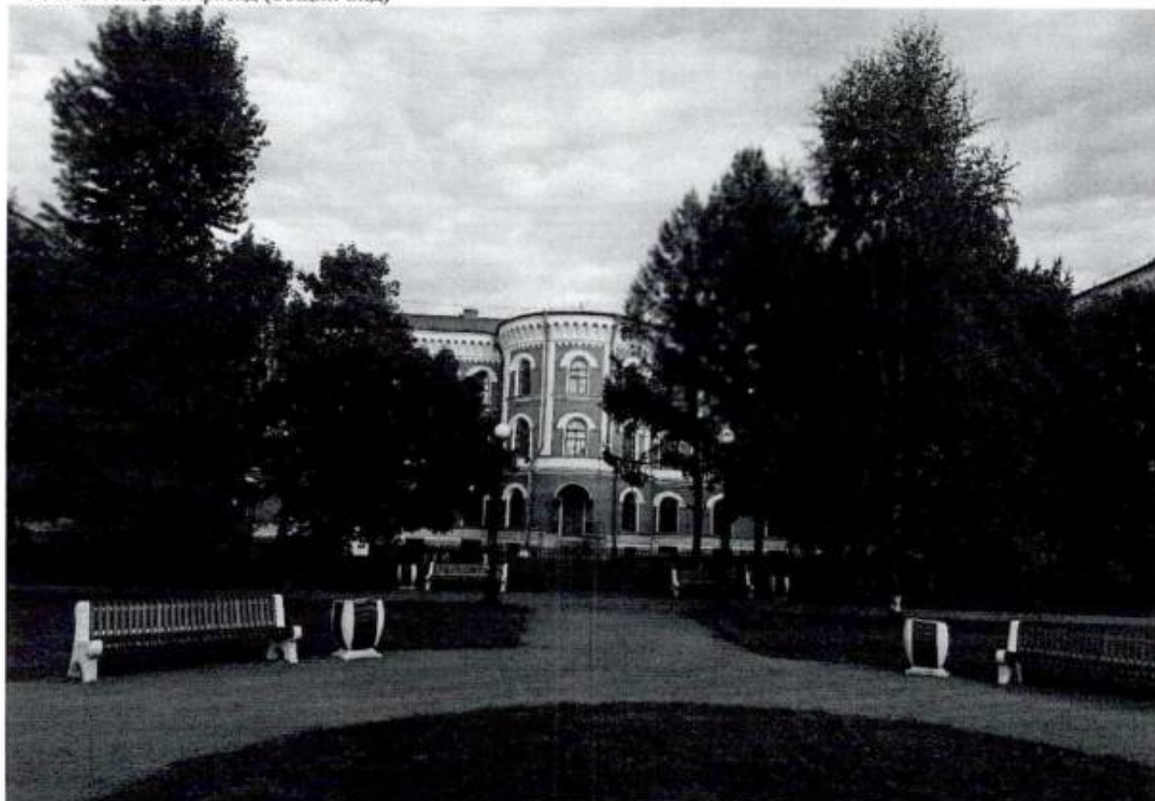
Фото 4. Лицевой фасад (общий вид)
