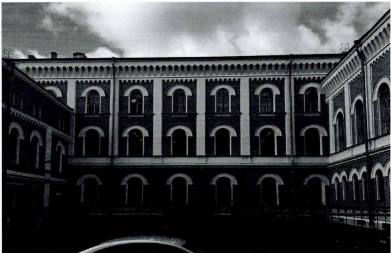
Фото 9. Лицевой фасад (общий вид)
