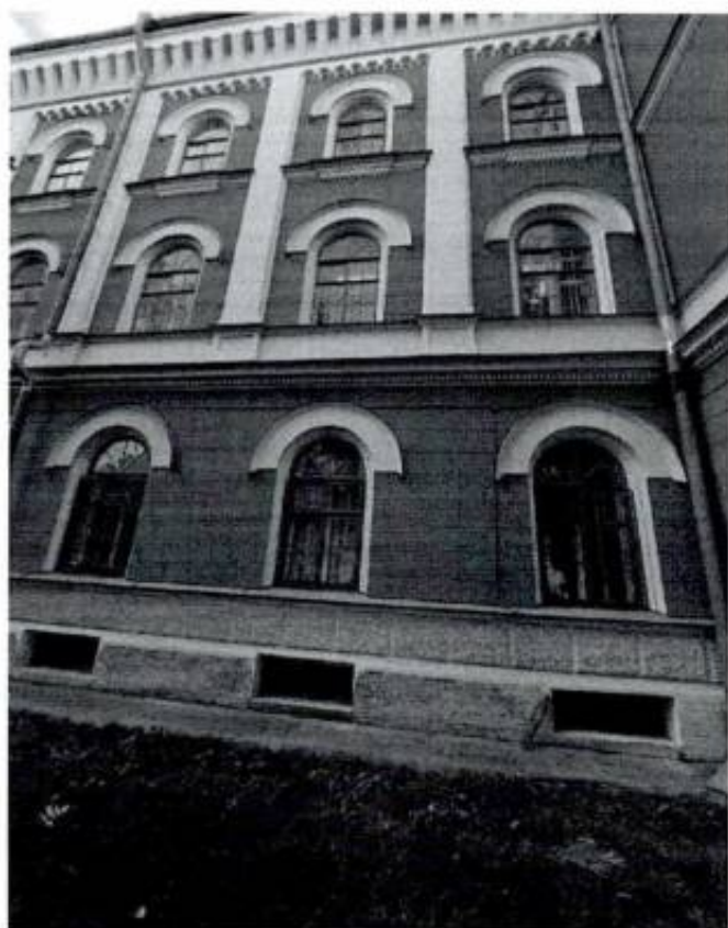
Фото 17. Лицевой фасад (фрагмент)
