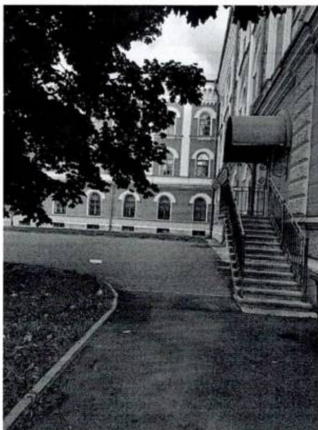
Фото 25. Лицевой фасад (фрагмент)
