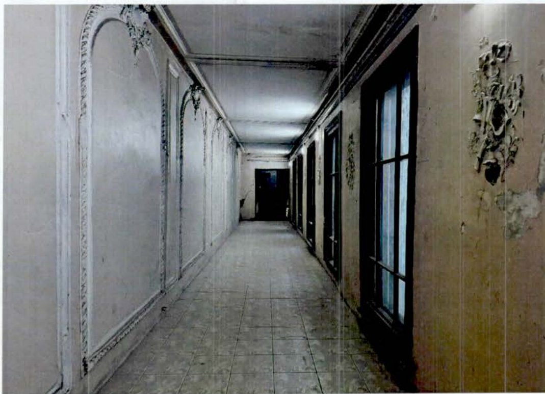
7. Помещение 2ЛК. Крытая галерея в уровне 2 этажа.
