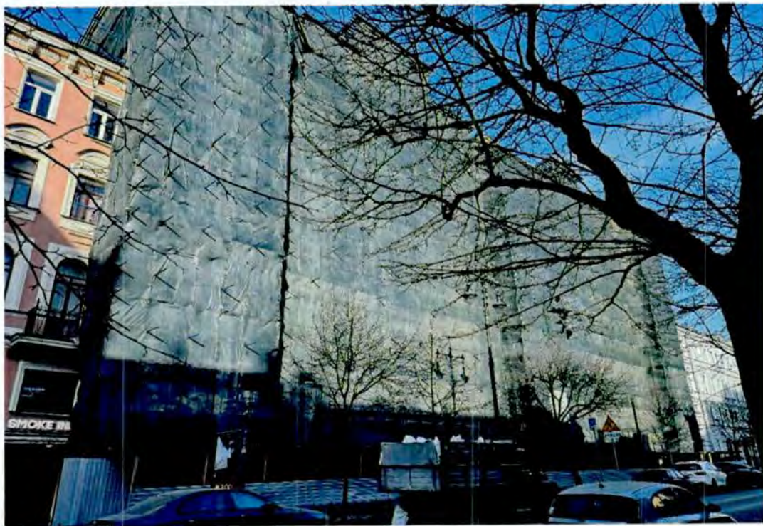
1. Общий вид на объект культурного наследия.
