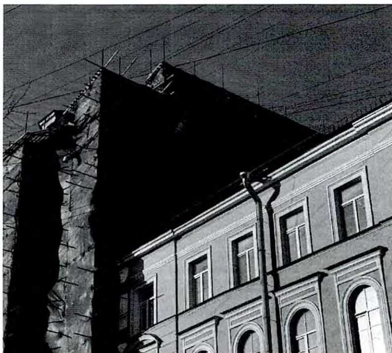
Общий вид фасада.
