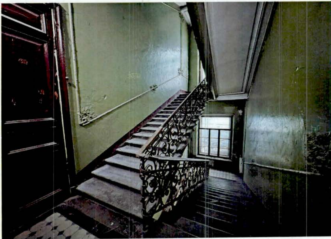
8. Межэтажная лестница 6ЛК.
