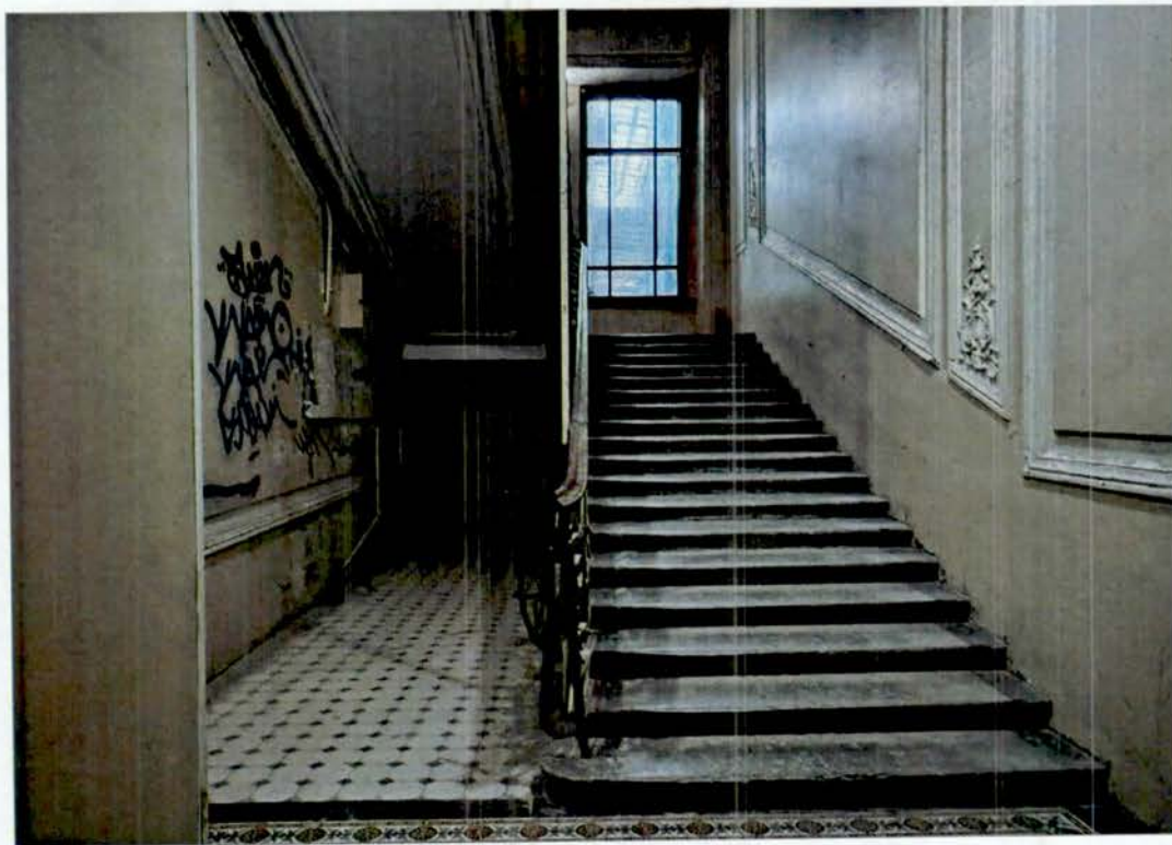
6. Межэтажная лестница 2ЛК.
