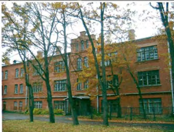
Фото 47. Восточный фасад. Общий вид.
