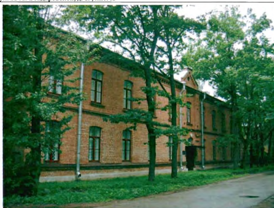
Фото 39. Восточный фасад. Общий вид.
