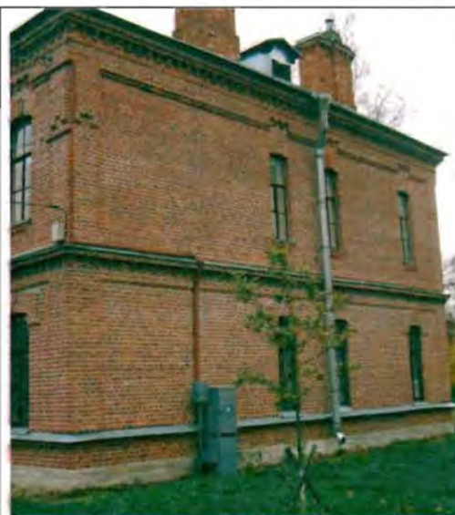
Фото 134. Южный фасад. Общий вид.
