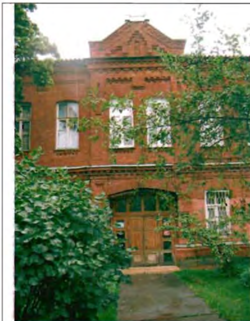
Фото 90. Восточный фасад. Центральная часть. Общий вид.
