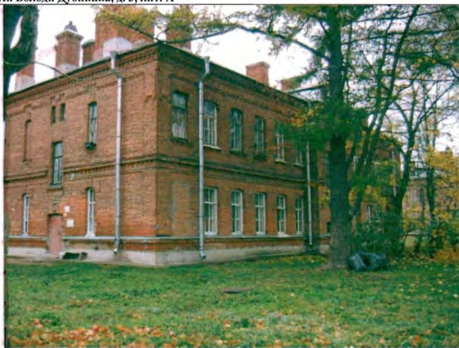
Фото 145. Восточный фасад. Общий вид.
