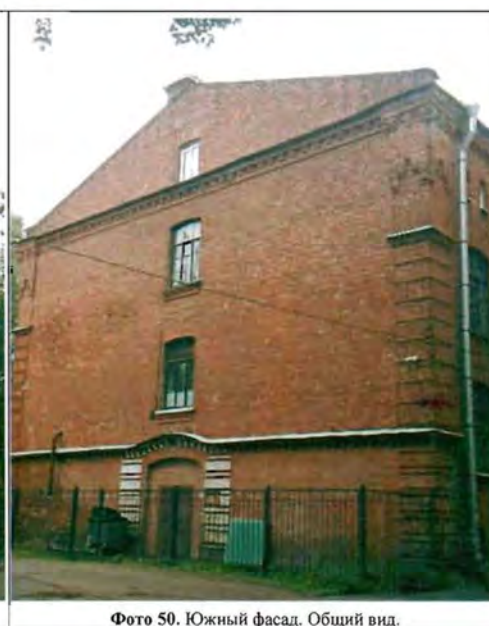
Фото 50. Южный фасад. Общий вид.
