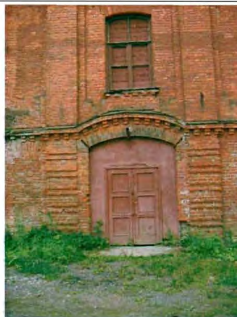
Фото 4. Западный фасад. Фрагмент центральной части фасада.
