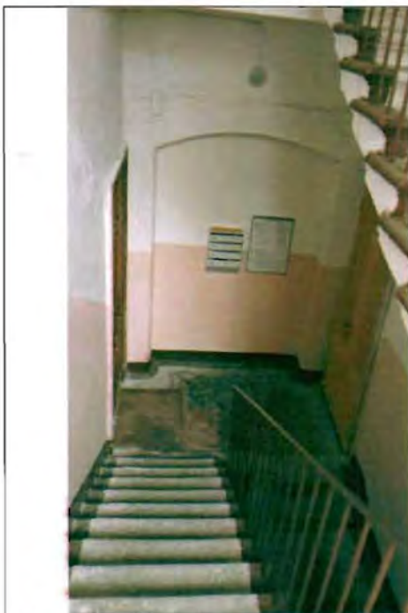
Фото 130. Лестница № 1 в южной части здания. Общий вид.
