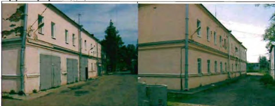
Фото 110. Восточный фасад. Общий вид.
