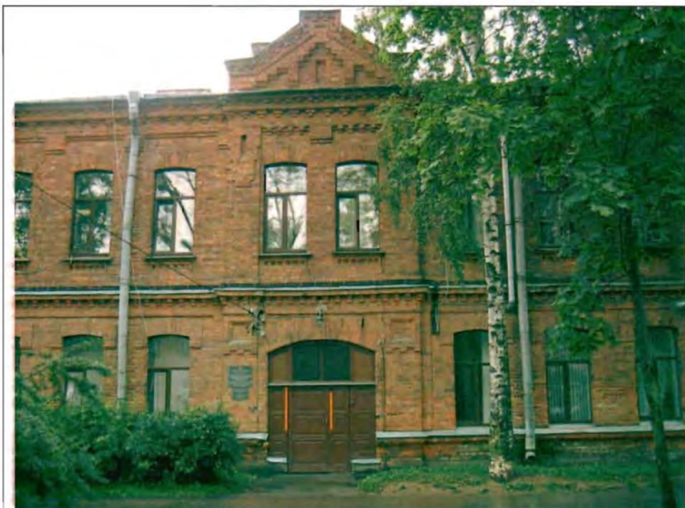
Фото 164. Восточный фасад. Фрагмент центральной части фасада.
