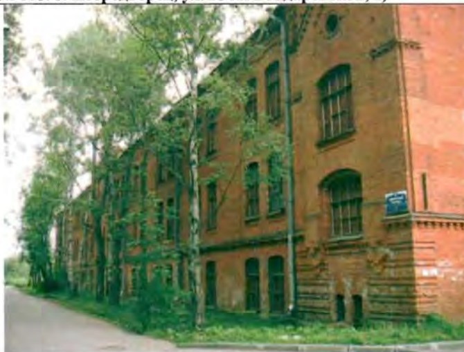
Фото 1. Западный фасад. Общий вид.
