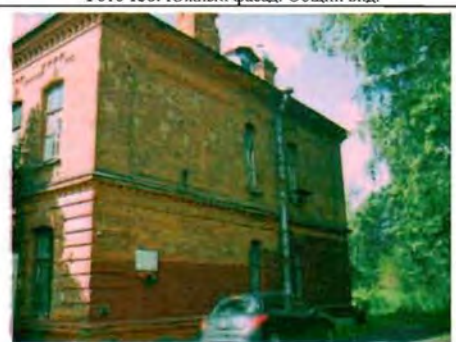
Фото 140. Северный фасад. Общий вид.
