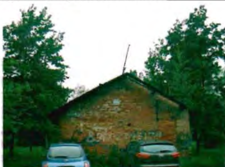
Фото 94. Восточный фасад. Общий вид.
