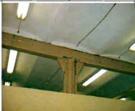
Фото 23. Интерьер. Металлические клепанные колонны и балки. Фрагмент.
