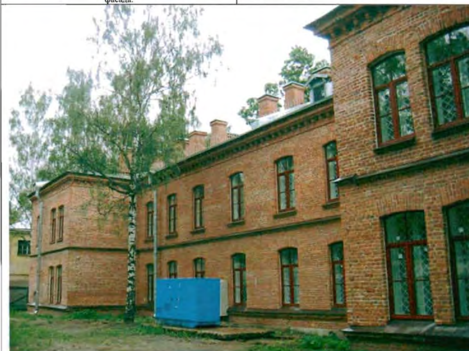
Фото 42. Западный фасад. Общий вид.
