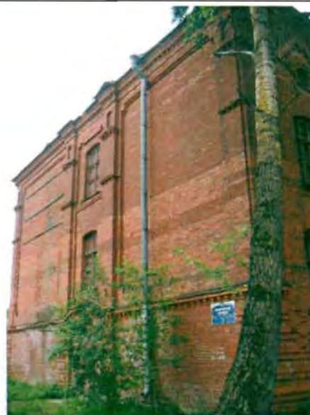
Фото 6. Северный фасад. Общий вид.
