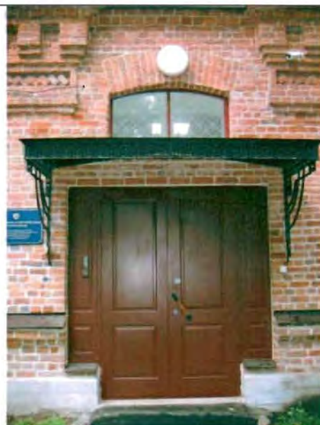
Фото 41. Дверной проем восточного фасада. Общий вид.
