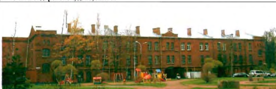
Фото 28. Восточный фасад. Общий вид.
