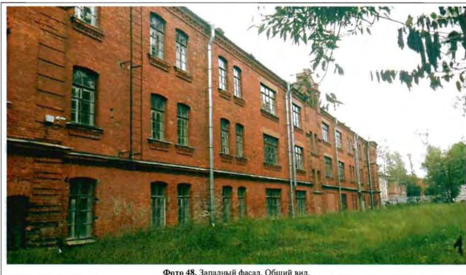
Фото 48. Западный фасад. Общий вид.
