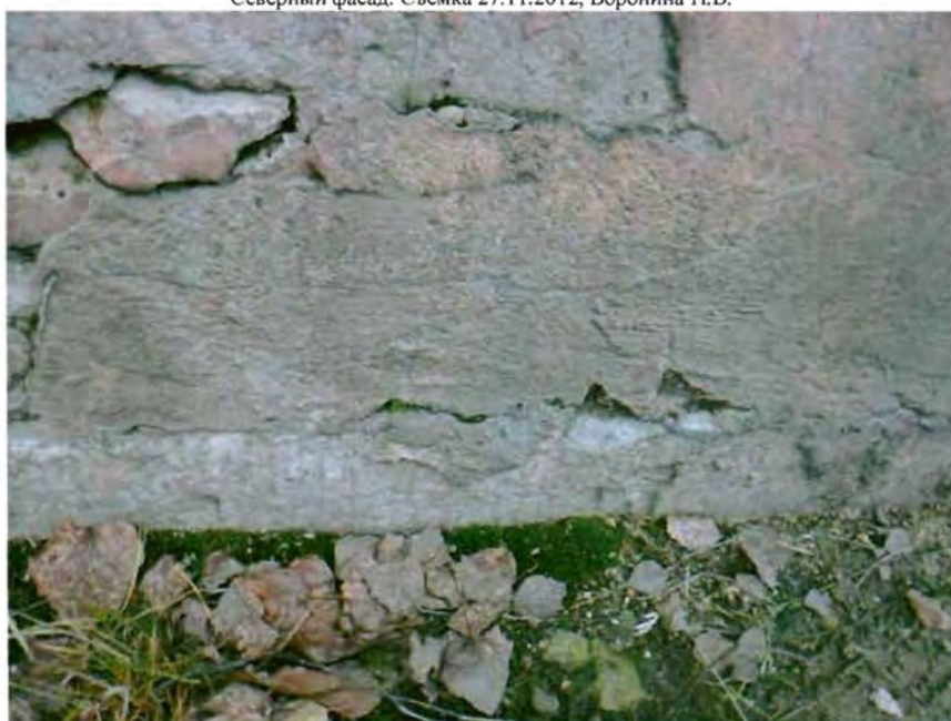
Цоколь, облицованный известняковой скобой. Съемка 27.11.2012, Воронина Н.В.
