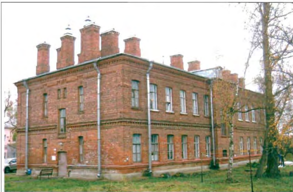
Фото 129. Западный, северный фасады. Общий вид.
