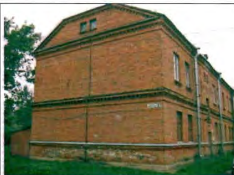
Фото 85. Восточный фасад. Общий вид.
