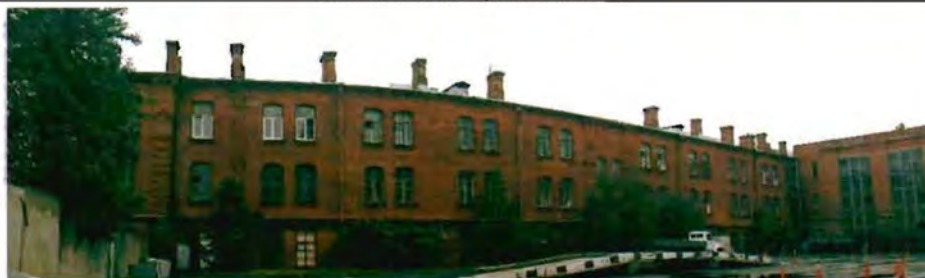
Фото 29. Западный фасад. Общий вид.
