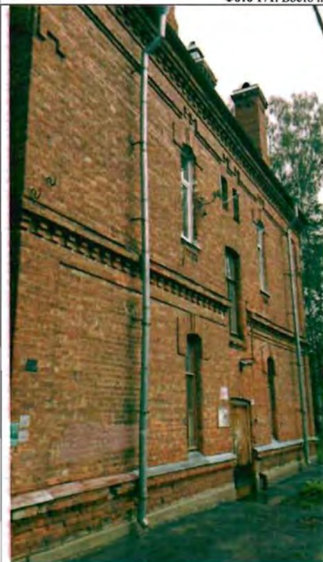
Фото 172. Южный фасад. Общий вид.
