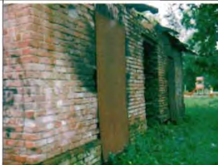
Фото 95. Северный фасад. Общий вид.
