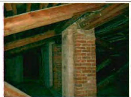
Фото 142. Конструкции крыши. Фрагмент.
