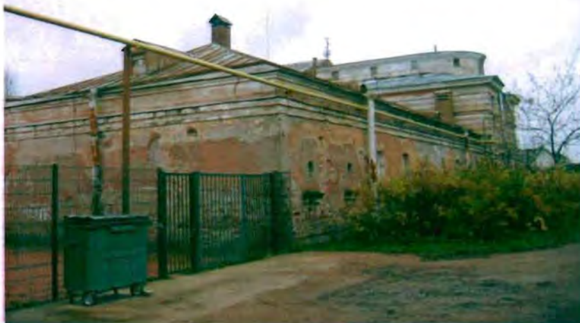
Фото 24. Западный, северный фасады. Общий вид.
