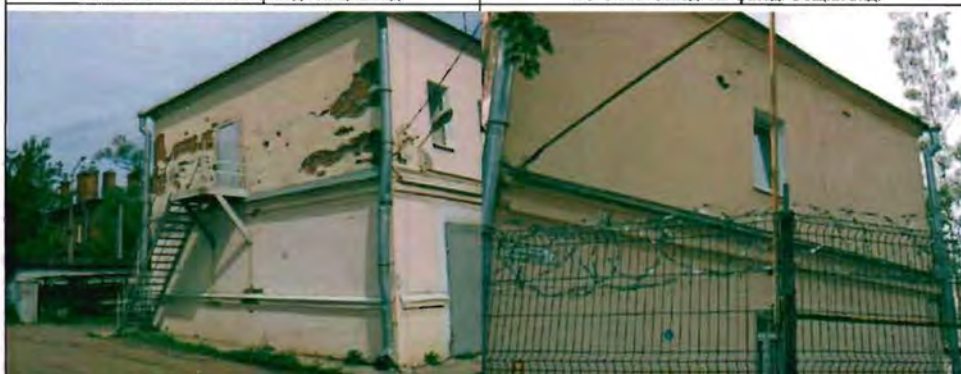
Фото 112. Южный фасад. Общий вид.
