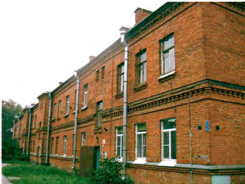
Фото 83. Северный фасад. Общий вид.
