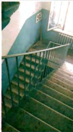
Фото 144. Лестница № 2 в южной части здания. Общий вид.
