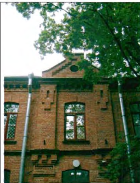
Фото 40. Восточный фасад. Фрагмент центральной части фасада.
