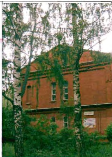
Фото 91. Северный фасад. Общий вид.
