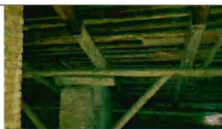
Фото 38. Конструкции крыши. Фрагмент.
