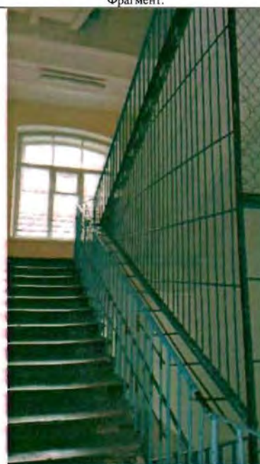
Фото 61. Интерьер. Лестница в южной части здания. Фрагмент.
