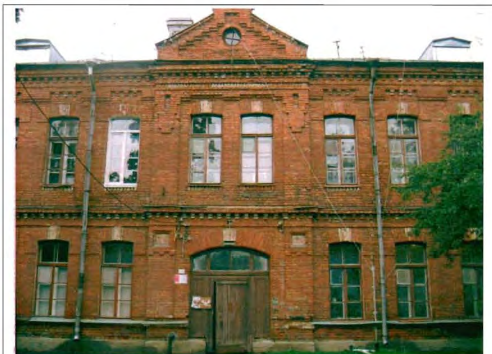
Фото 104. Восточный фасад. Центральная часть. Общий вид.
