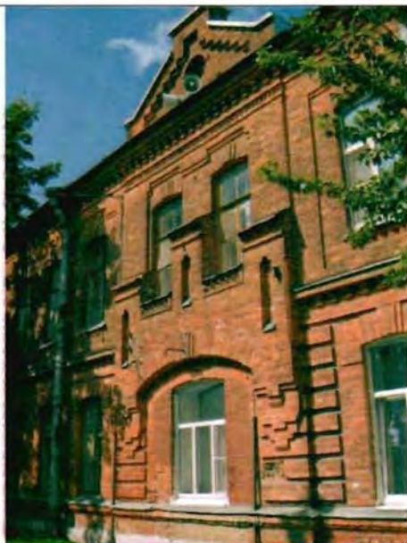
Фото 137. Восточный фасад. Фрагмент.
