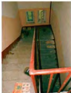
Фото 124. Лестница в южной части здания. Общий вид.
