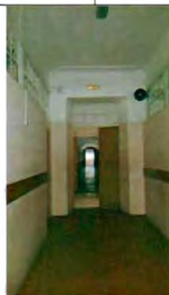
Фото 54. Интерьер. Коридор в уровне 2-го этажа. Общий вид.
