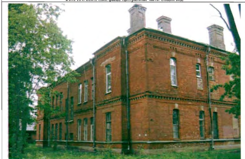
Фото 105. Западный, южный фасады. Общий вид.
