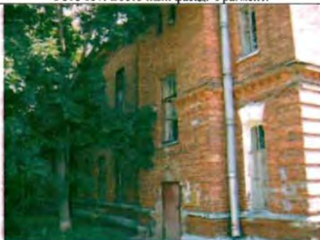
Фото 139. Западный фасад. Фрагмент.
