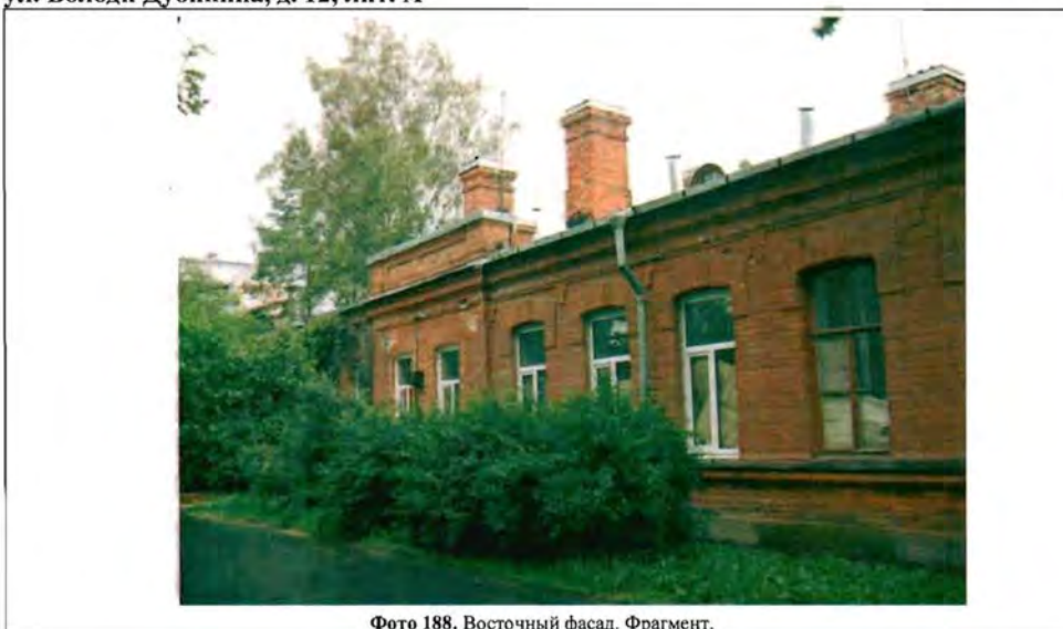
Фото 188. Восточный фасад. Фрагмент.
