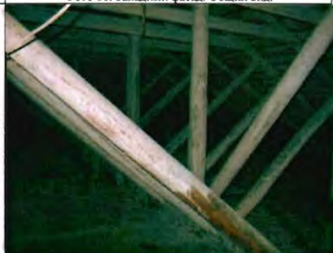
Фото 88. Конструкции крыши. Общий вид.
