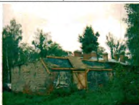
Фото 186. Западный, северный фасады. Общий вид.
