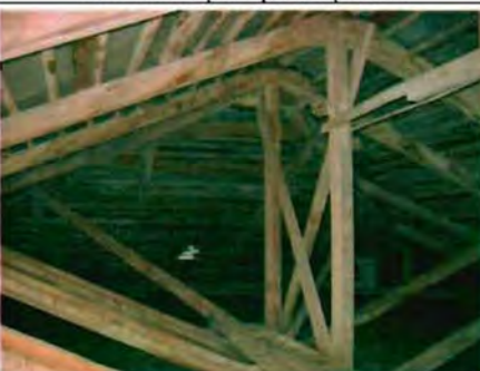
Фото 82. Конструкции крыши. Общий вид.
