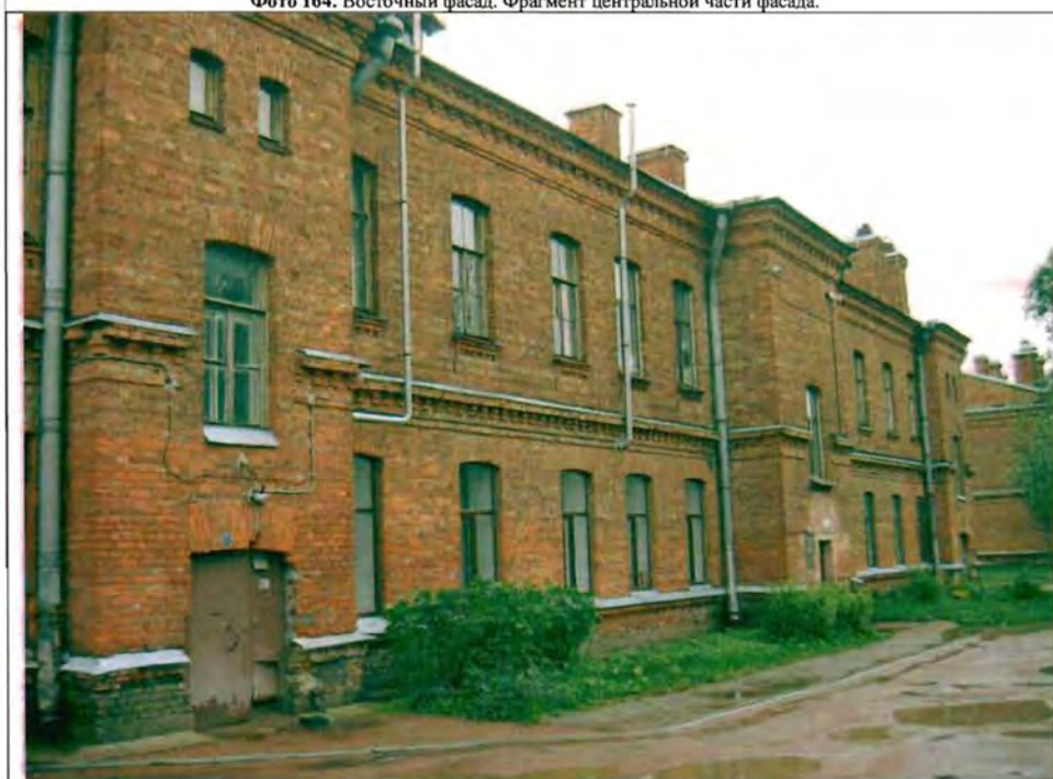
Фото 165. Западный фасад. Общий вид.
