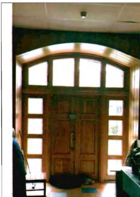
Фото 92. Помещение в уровне 1-го этажа.
