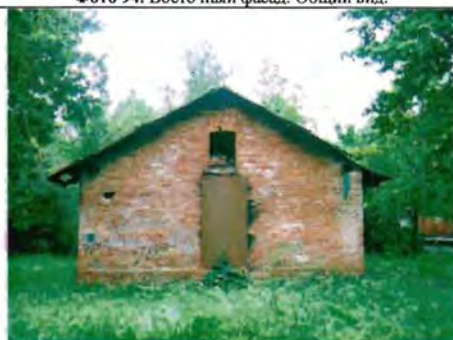
Фото 96. Западный фасад. Общий вид.
