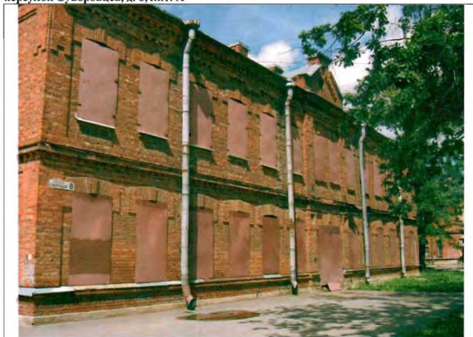
Фото 116. Восточный фасад. Общий вид.
