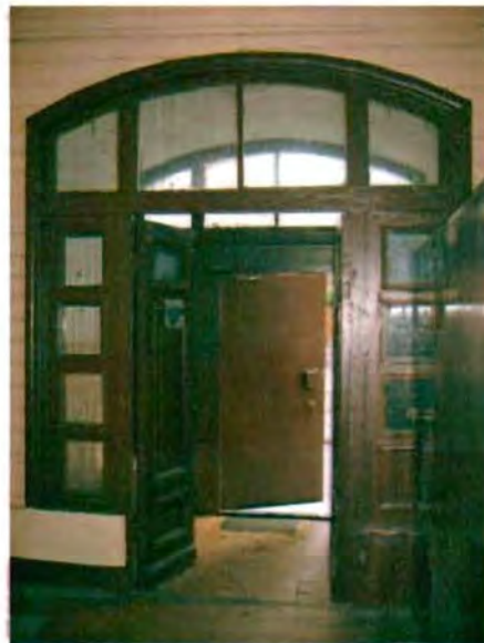
Фото 107. Дверной проем тамбура. Общий вид.
