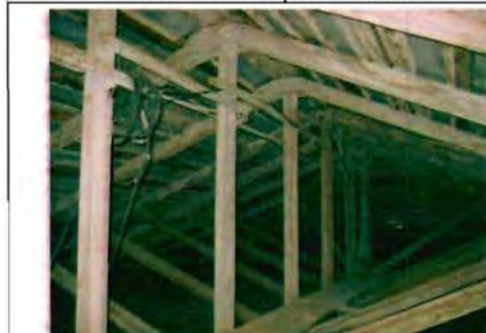
Фото 81. Конструкции крыши. Общий вид.
