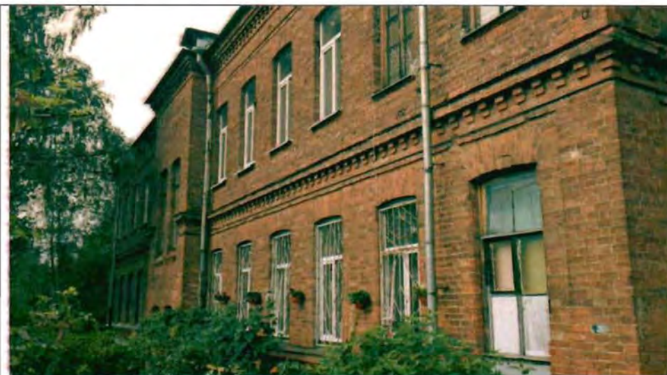
Фото 171. Восточный фасад. Общий вид.
