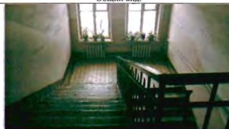
Фото 34. Интерьер. Лестница. Общий вид.
