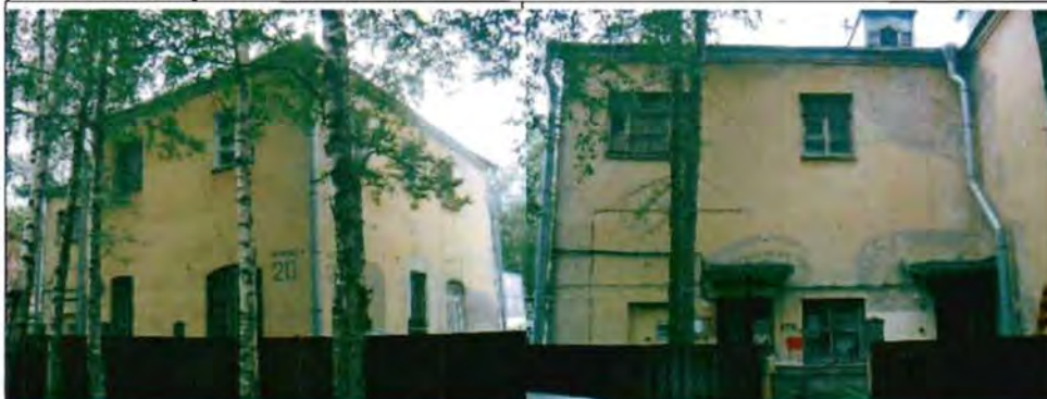
Фото 43. Северный, восточный фасады. Общий вид.
