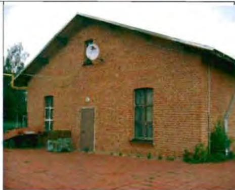
Фото 21. Южный фасад. Общий вид.
