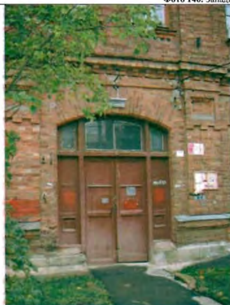
Фото 147. Дверной проем западного фасада. Общий вид.
