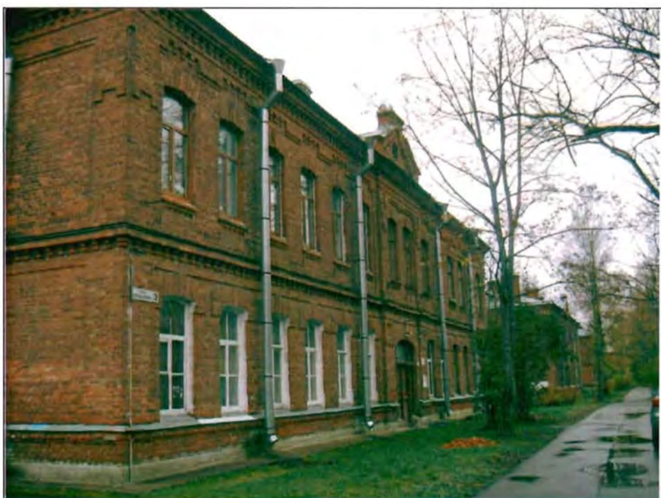
Фото 146. Западный фасад. Общий вид.
