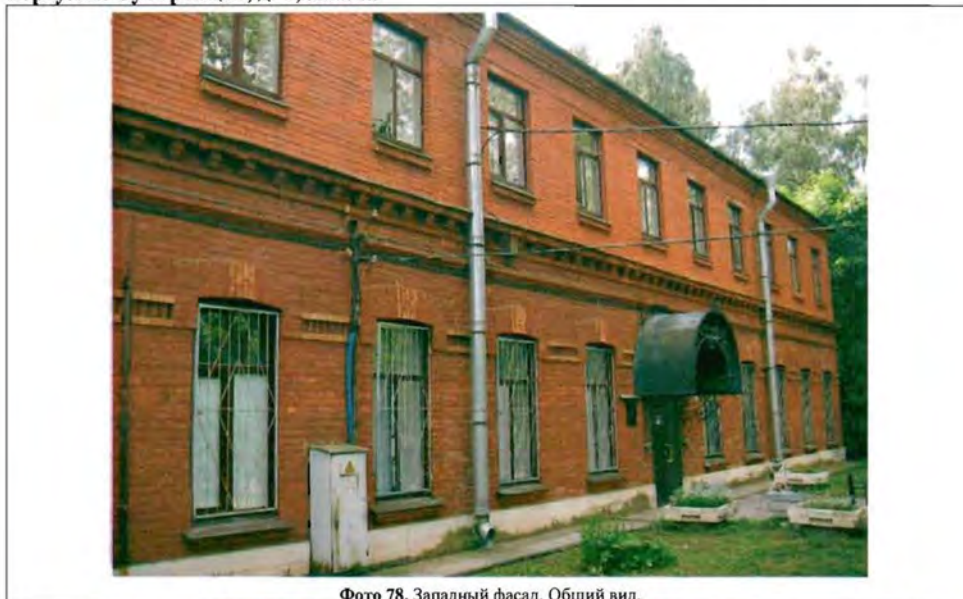
Фото 78. Западный фасад. Общий вид.
