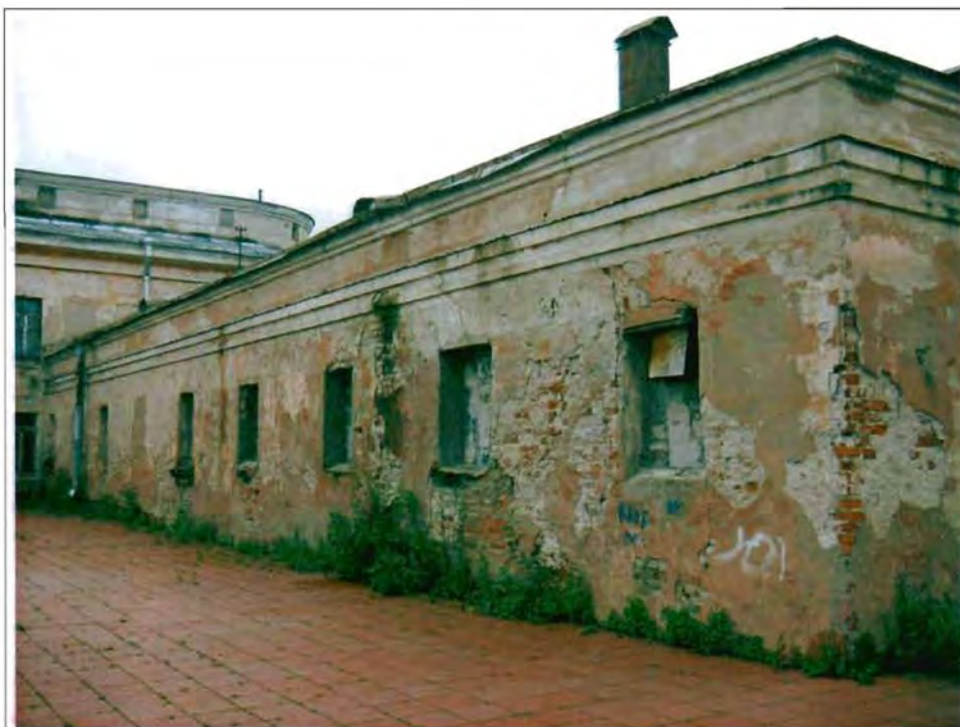
Фото 25. Восточный фасад. Общий вид.
