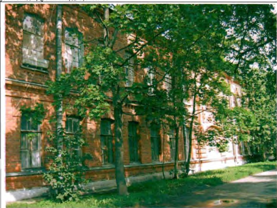
Фото 136. Восточный фасад. Общий вид.
