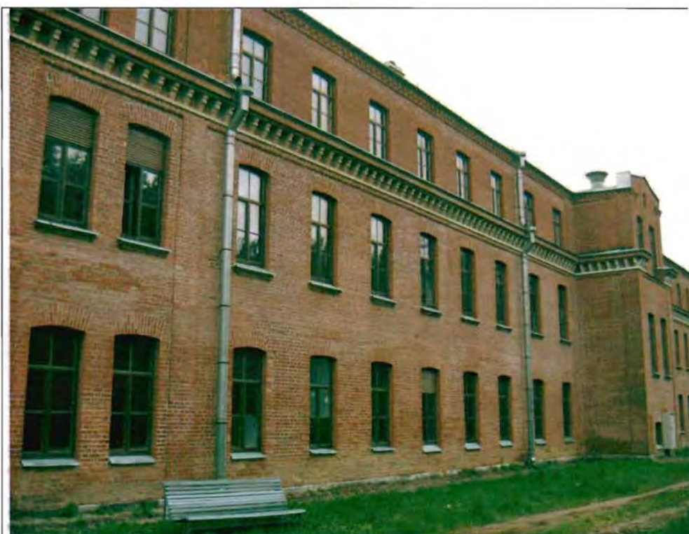
Фото 66. Южный фасад. Общий вид. 05.07.2016.
