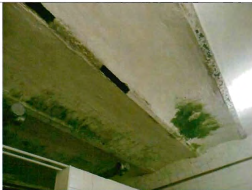
Своды по металлическим балкам. Съёмка 27.11.2012, Воронина Н.В.
