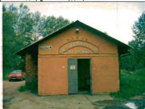
Фото 153. Восточный фасад. Общий вид.
