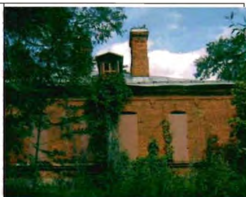
Фото 100. Южный фасад. Фрагмент.
