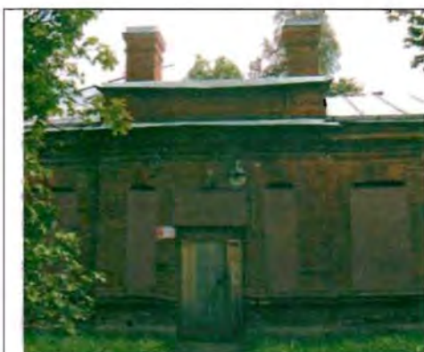
Фото 99. Западный фасад. Центральная часть. Общий вид.
