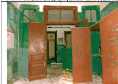
Фото 101. Дверной проем тамбура. Общий вид.
