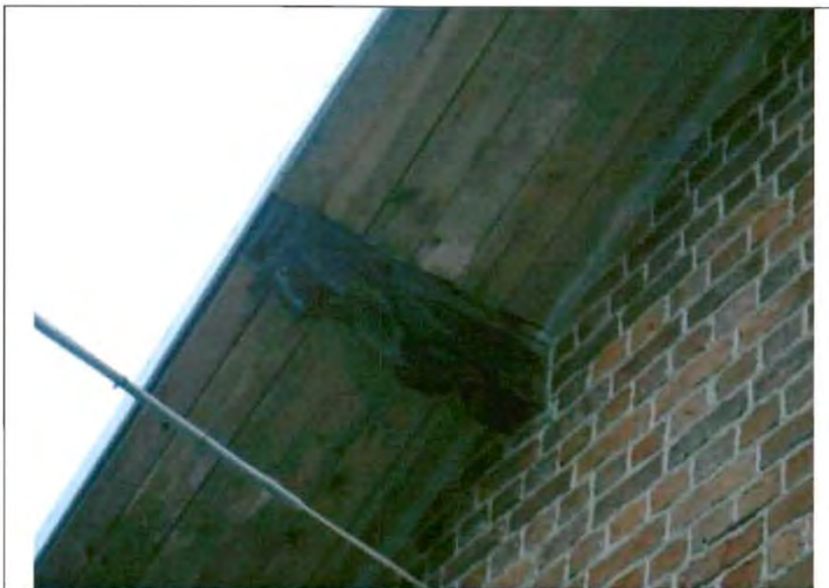
Деревянные кобылки. Съёмка 20.11.2012, Воронина Н.В.
