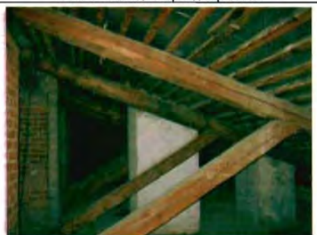
Фото 141. Конструкции крыши. Фрагмент.
