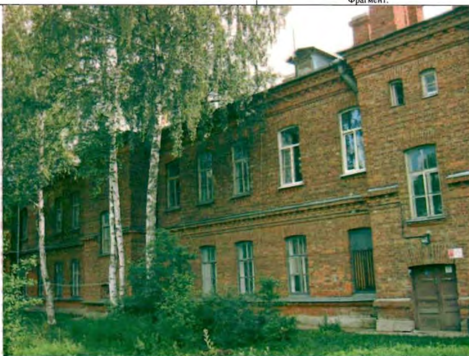
Фото 179. Западный фасад. Общий вид.
