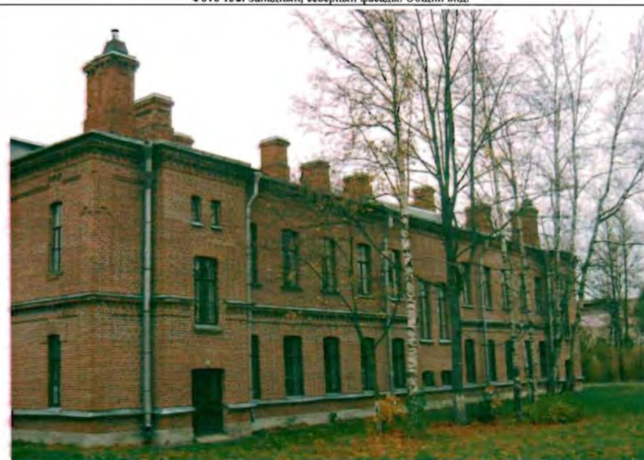
Фото 133. Восточный фасад. Общий вид.
