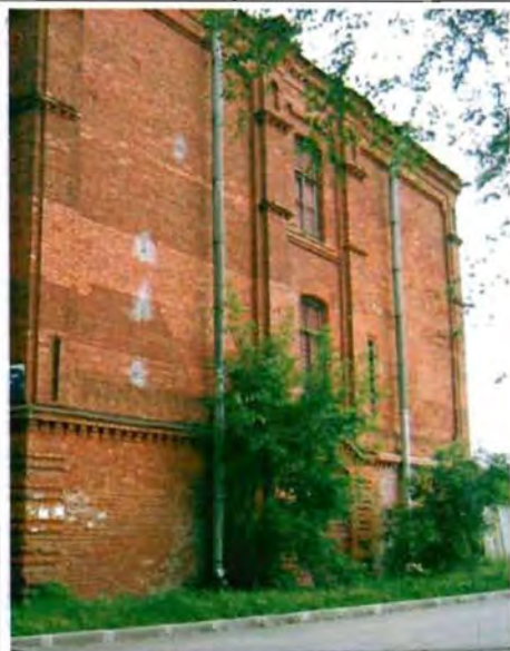
Фото 5. Южный фасад. Общий вид.
