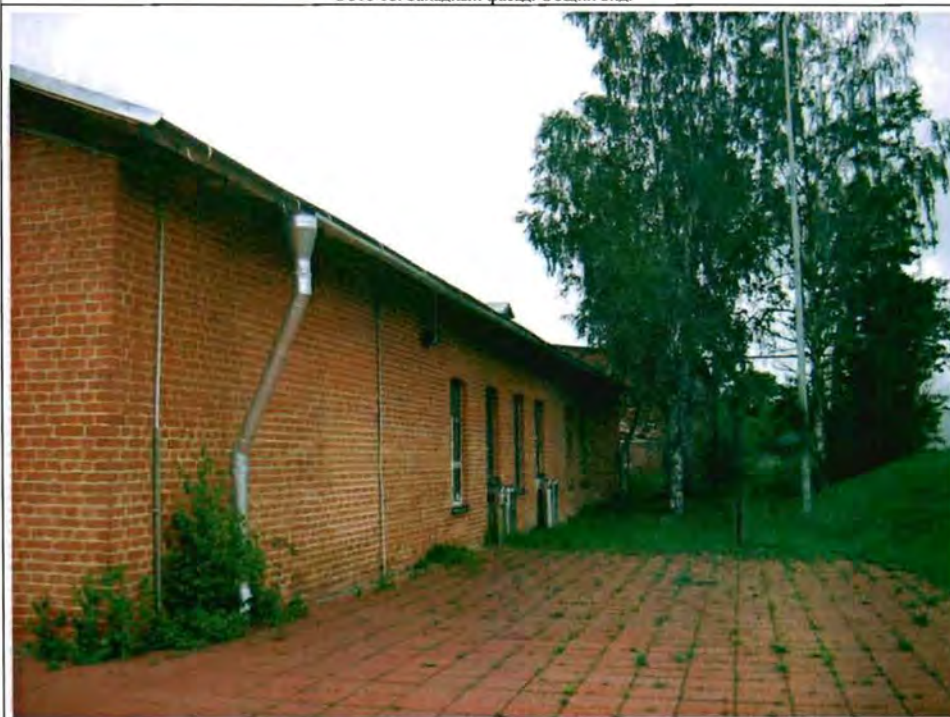
Фото 19. Восточный фасад. Общий вид.
