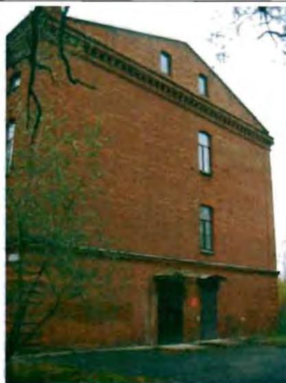
Фото 16. Южный фасад. Общий вид.
