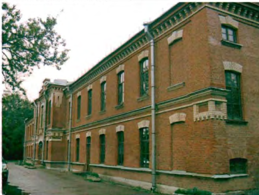
Фото 64. Северный фасад. Общий вид.
