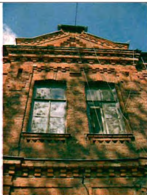
Фото 177. Восточный фасад. Центральная часть. Фрагмент.
