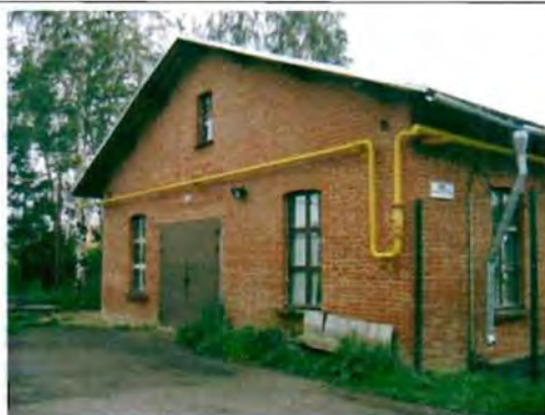
Фото 20. Северный фасад. Общий вид.
