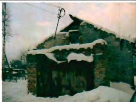
Фото 184. Восточный фасад. Общий вид. 14.01.2015.
