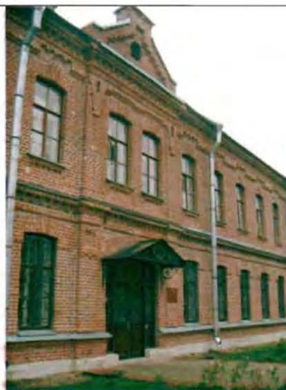
Фото 135. Западный фасад. Фрагмент центральной части фасада.
