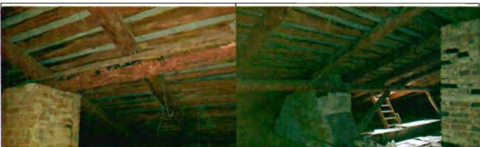
Фото 62. Конструкции крыши. Общий вид.
