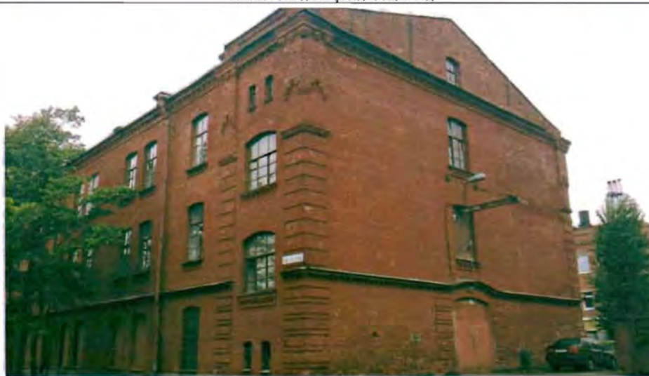
Фото 30. Северный фасад. Общий вид.
