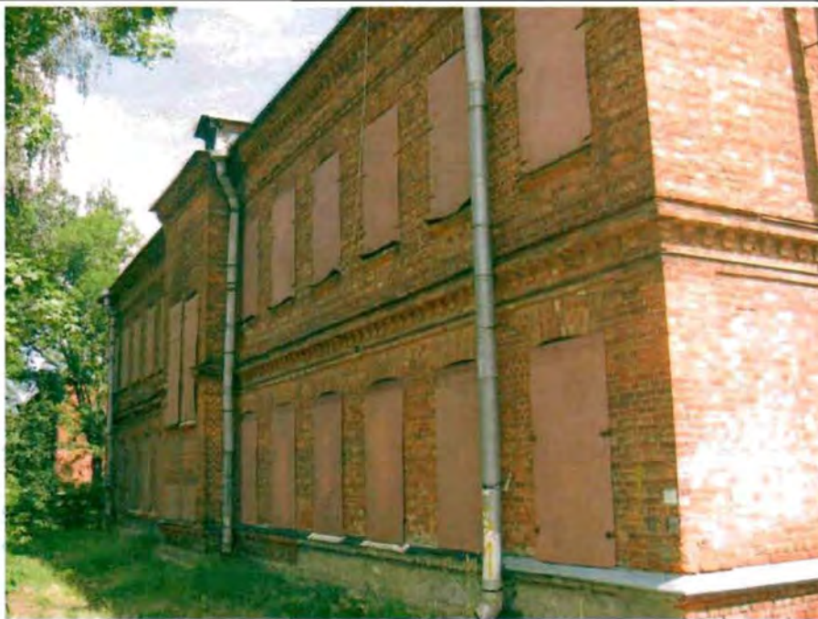
Фото 119. Западный фасад. Общий вид.
