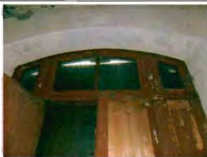
Фото 126. Дверное заполнение центральной части лестницы. Фрагмент.
