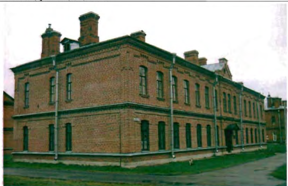
Фото 132. Западный, северный фасады. Общий вид.
