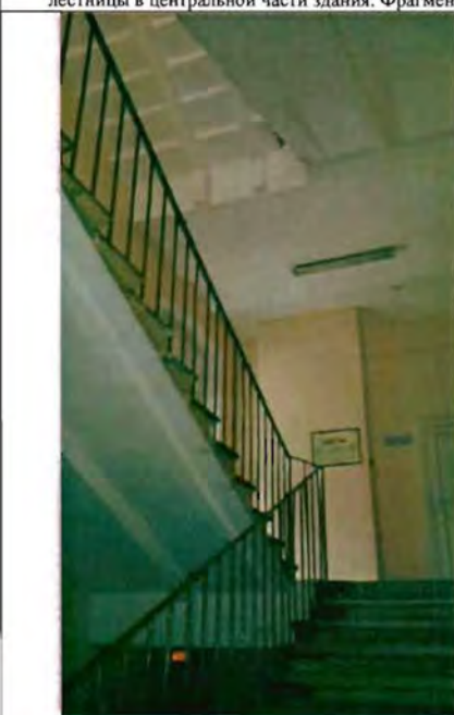
Фото 60. Интерьер. Лестница в южной части здания. Фрагмент.
