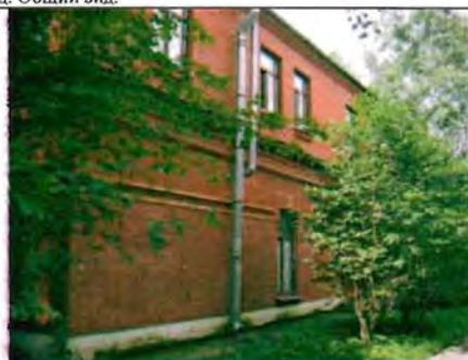
Фото 80. Северный фасад. Фрагмент.
