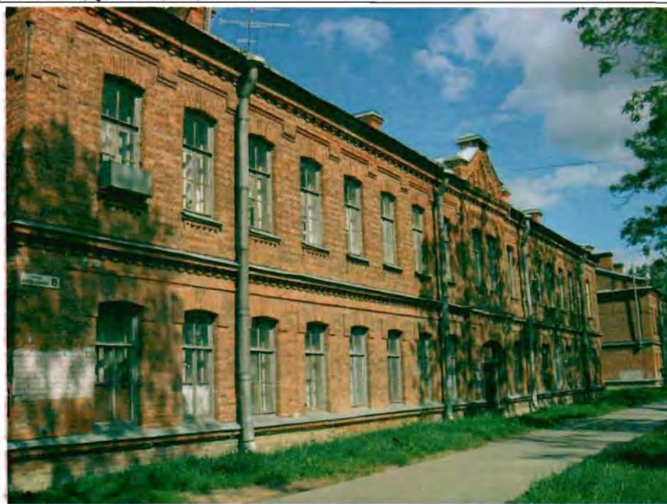
Фото 176. Восточный фасад. Общий вид.
