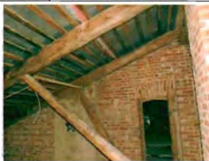
Фото 127. Конструкции крыши. Общий вид.
