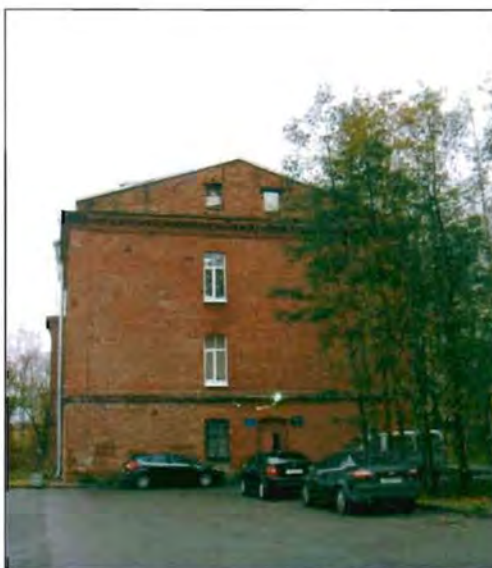
Фото 15. Северный фасад. Общий вид.
