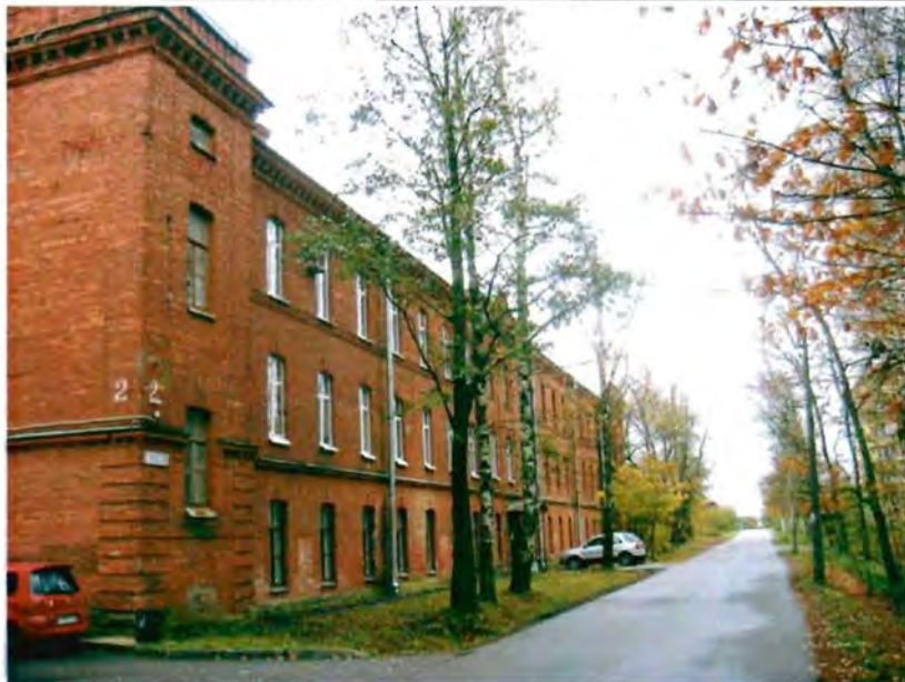
Фото 13. Западный фасад. Общий вид.
