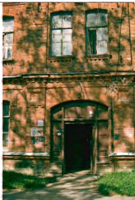
Фото 178. Восточный фасад. Центральная часть. Фрагмент.
