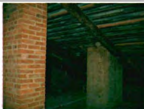
Фото 152. Конструкции крыши. Фрагмент.
