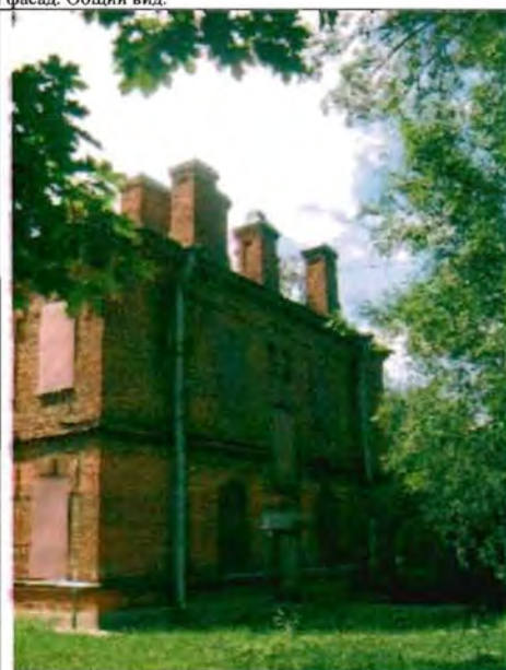
Фото 118. Северный фасад. Общий вид.
