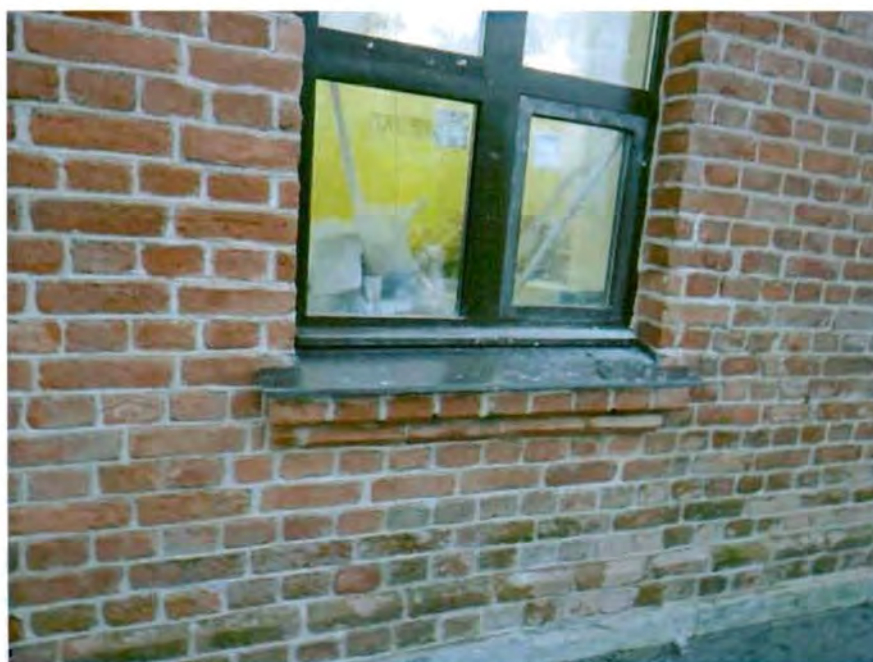
Ступенчатые подоконные доски. Съемка 20.11.2012, Воронина Н.В.
