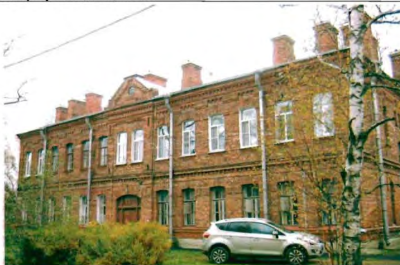
Фото 128. Восточный фасад. Общий вид.
