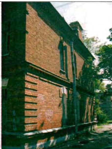
Фото 138. Южный фасад. Общий вид.
