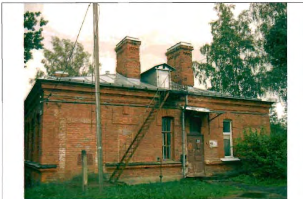
Фото189. Северный фасад. Общий вид.
