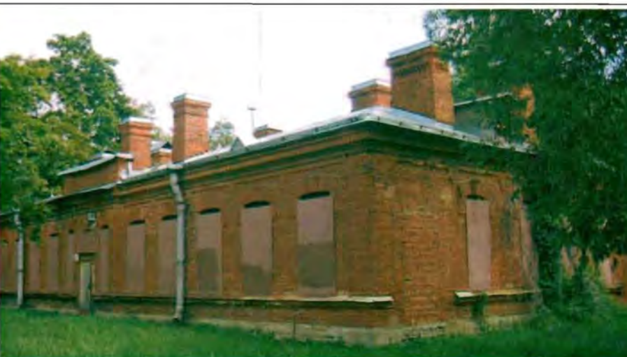
Фото 98. Западный фасад. Общий вид.
