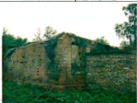
Фото 187. Северный фасад. Общий вид.
