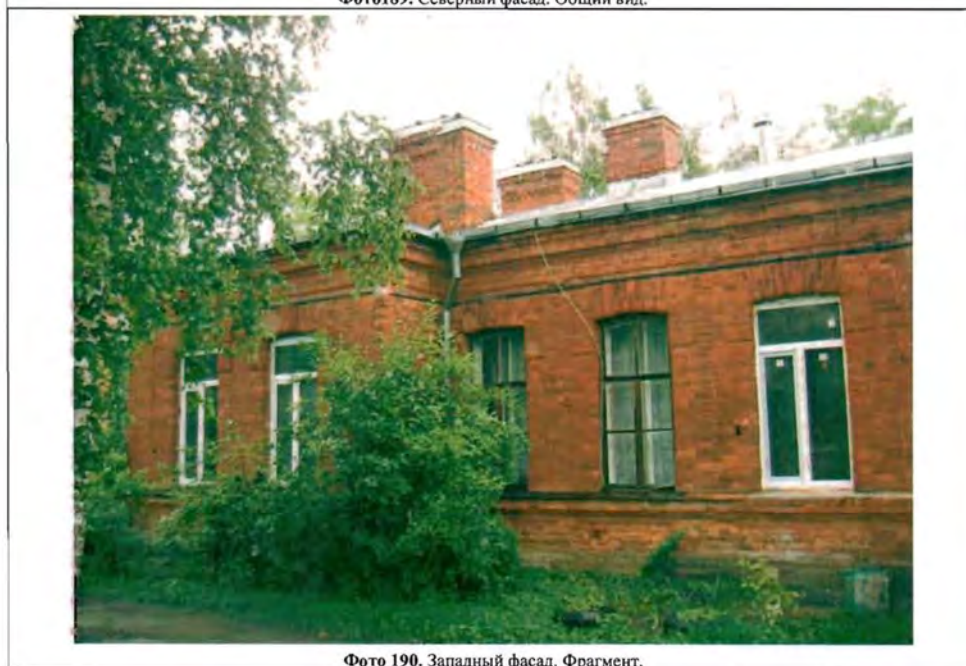
Фото 190. Западный фасад. Фрагмент.
