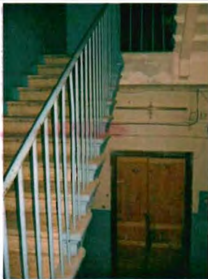
Фото 143. Лестница № 1 в северной части здания. Общий вид.
