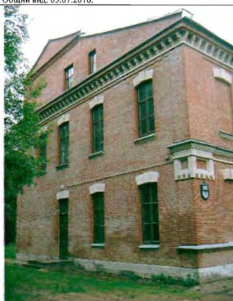
Фото 68. Восточный фасад. Общий вид.
