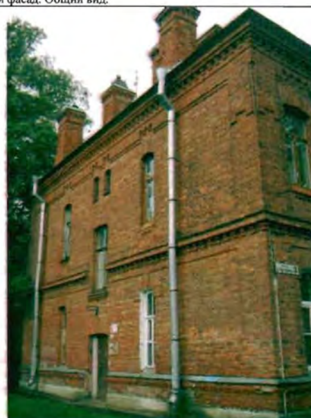
Фото 148. Северный фасад. Общий вид.
