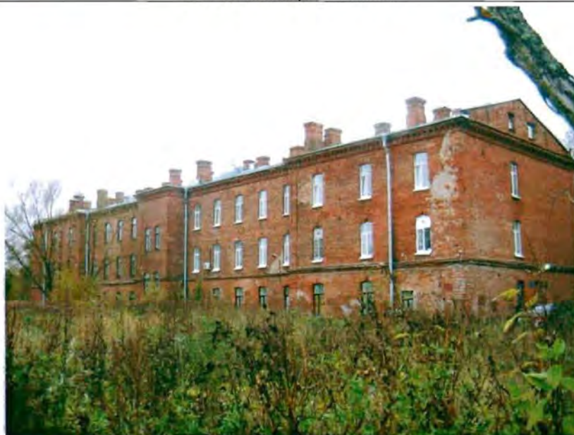
Фото 14. Восточный фасад. Общий вид.
