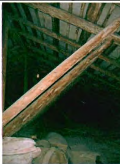
Фото 27. Конструкции крыши. Фрагмент.
