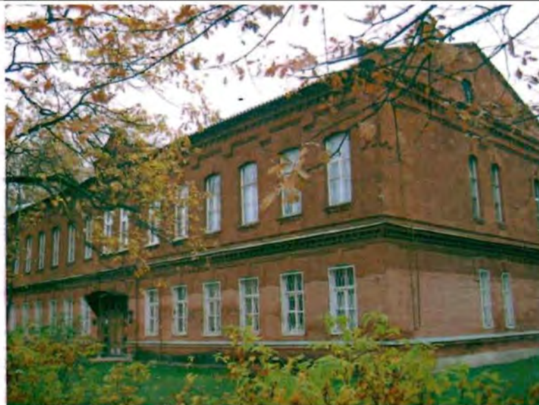
Фото 89. Западный, южный фасады. Общий вид.
