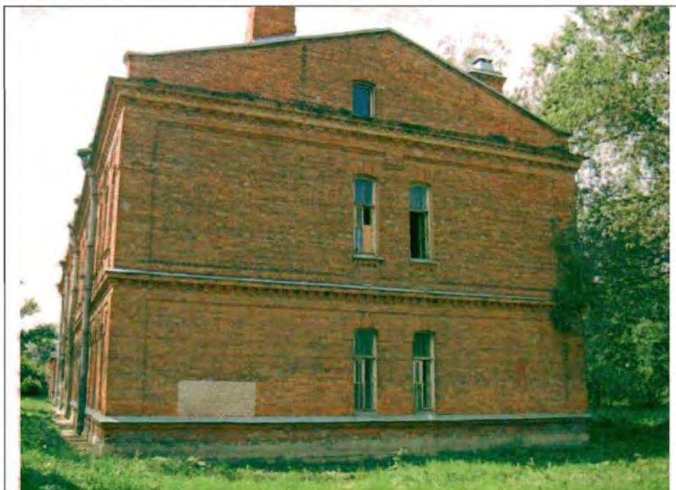
Фото 180. Северный фасад. Общий вид.
