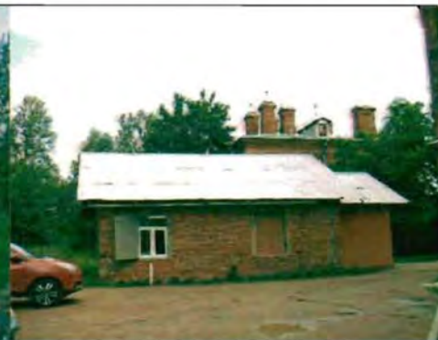
Фото 154. Южный фасад. Общий вид.
