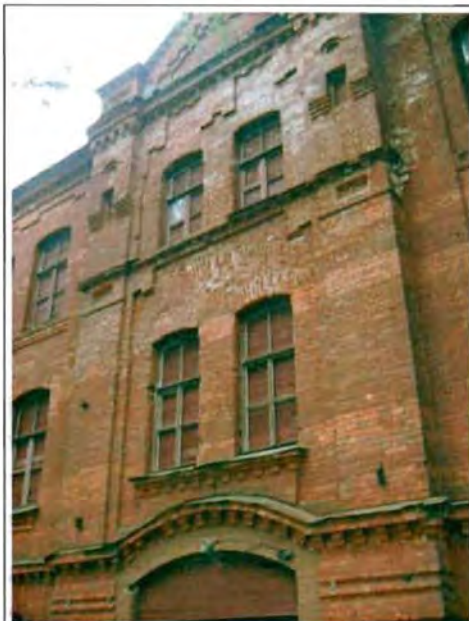
Фото 3. Западный фасад. Фрагмент центральной части фасада.
