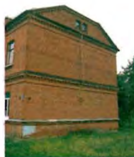
Фото 86. Западный фасад. Общий вид.
