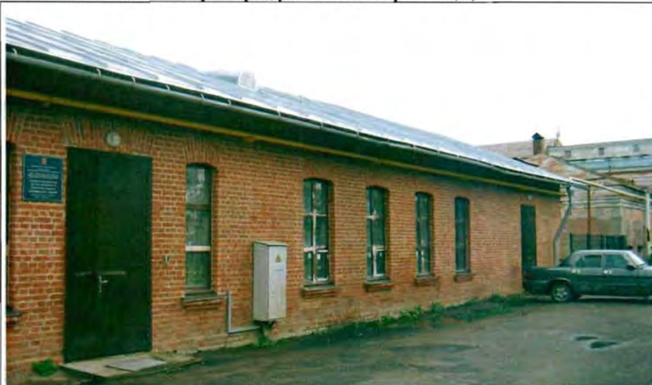
Фото 18. Западный фасад. Общий вид.
