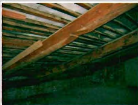
Фото 151. Конструкции крыши. Фрагмент.
