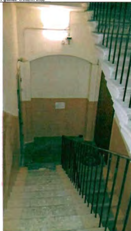
Фото 173. Лестница № 1 в северной части здания. Фрагмент.
