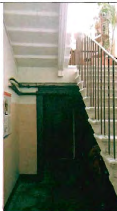
Фото 131. Лестница № 2 в северной части здания. Общий вид.
