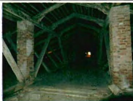
Фото 12. Конструкции крыши. Общий вид. 29.12.2015.
